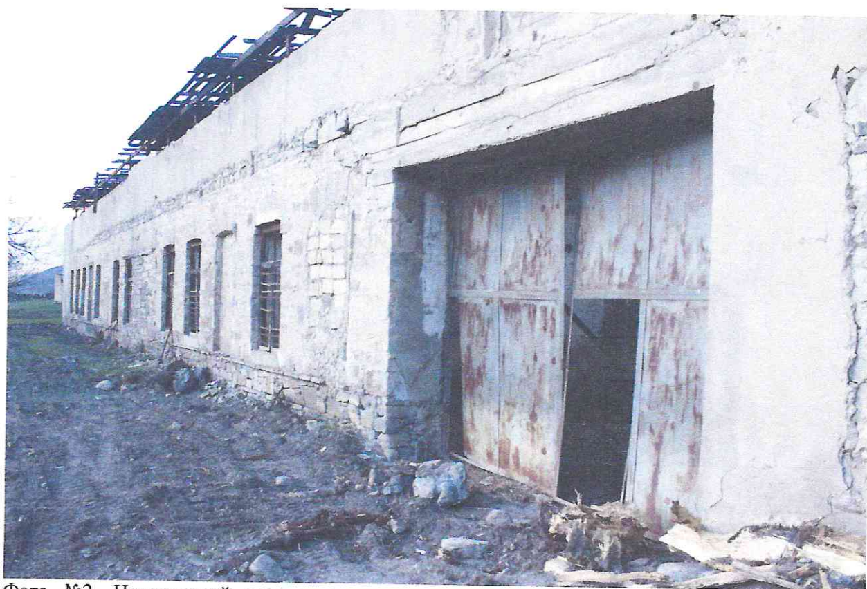
Фото №2. Центральный вход в одноэтажную казарму, в северной части крепости (на схематическом плане крепости обозначена №4).
