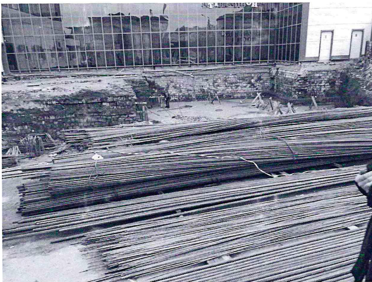
Фото 1. Не согласованные строительные работы на земельном участке по адресу: г.Дербент ул. Гагарина, 12
