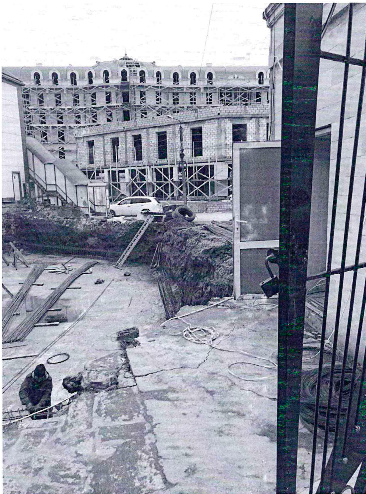
Фото 3. Не согласованные строительные работы на земельном участке по адресу: г.Дербент ул. Гагарина, 12.
