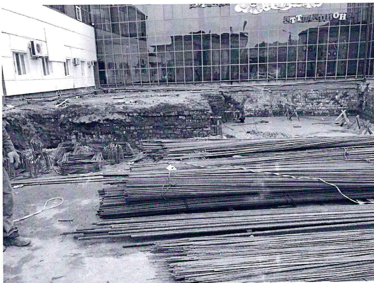
Фото 2. Не согласованные строительные работы на земельном участке по адресу: г.Дербент ул. Гагарина, 12.
