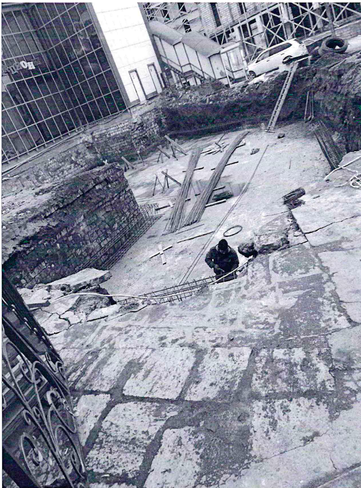
Фото 4. Не согласованные строительные работы на земельном участке по адресу: г.Дербент ул. Гагарина, 12.
