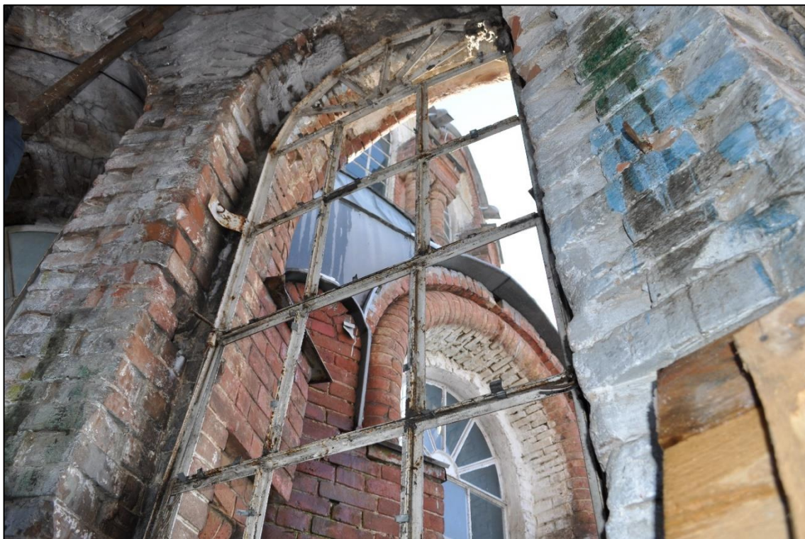
Фото 34. Общий вид интерьера объекта, оконные проемы. (Фото выполнены 30.03.2023 г.)
