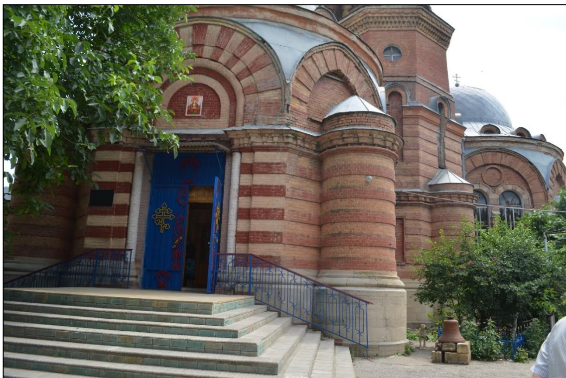
Фото 3. Общий вид здания, западный фасад. (Фото выполнены 30.03.2023 г.)
