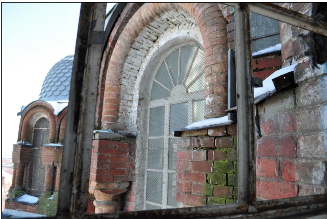
Фото 35. Общий вид интерьера объекта, оконные проемы. (Фото выполнены 30.03.2023 г.)
