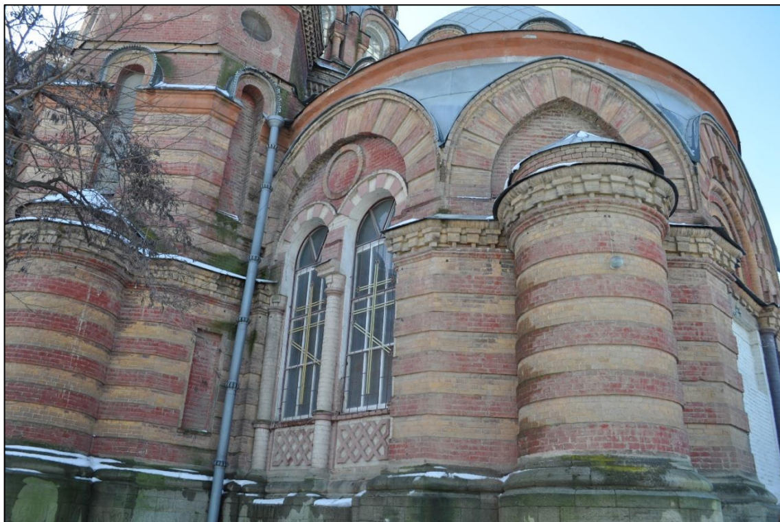
Фото 14. Общий вид здания, северо-восточный фасад. (Фото выполнены 30.03.2023 г.)
