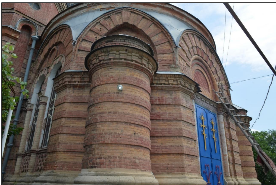
Фото 6. Общий вид здания, южный фасад. (Фото выполнены 30.03.2023 г.)
