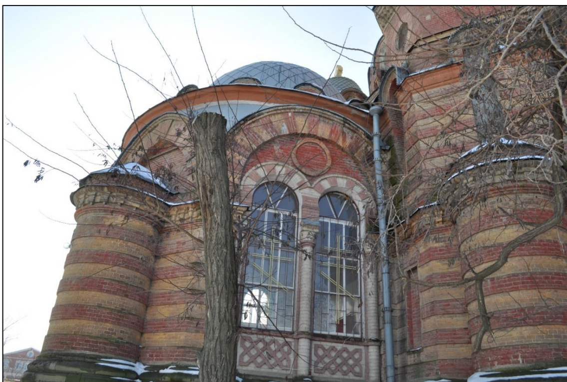
Фото 13. Общий вид здания, северо-восточный фасад. (Фото выполнены 30.03.2023 г.)
