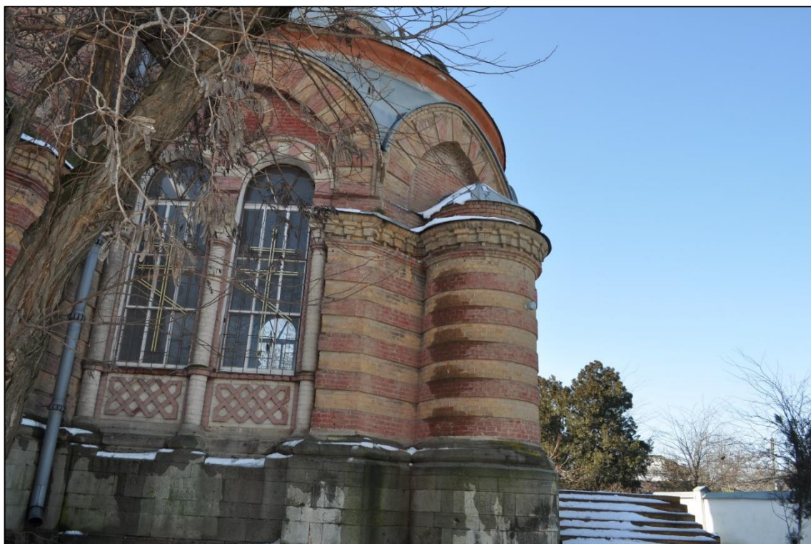
Фото 16. Общий вид здания, северо-восточный фасад. (Фото выполнены 30.03.2023 г.)
