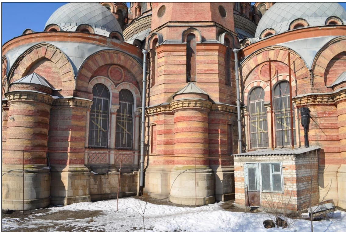
Фото 7. Общий вид здания, юго-восточный фасад. (Фото выполнены 30.03.2023 г.)
