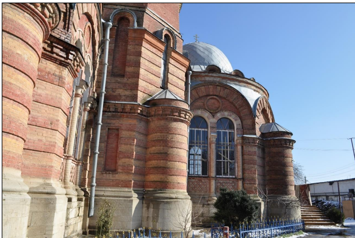
Фото 5. Общий вид здания, юго-западный фасад. (Фото выполнены 30.03.2023 г.)
