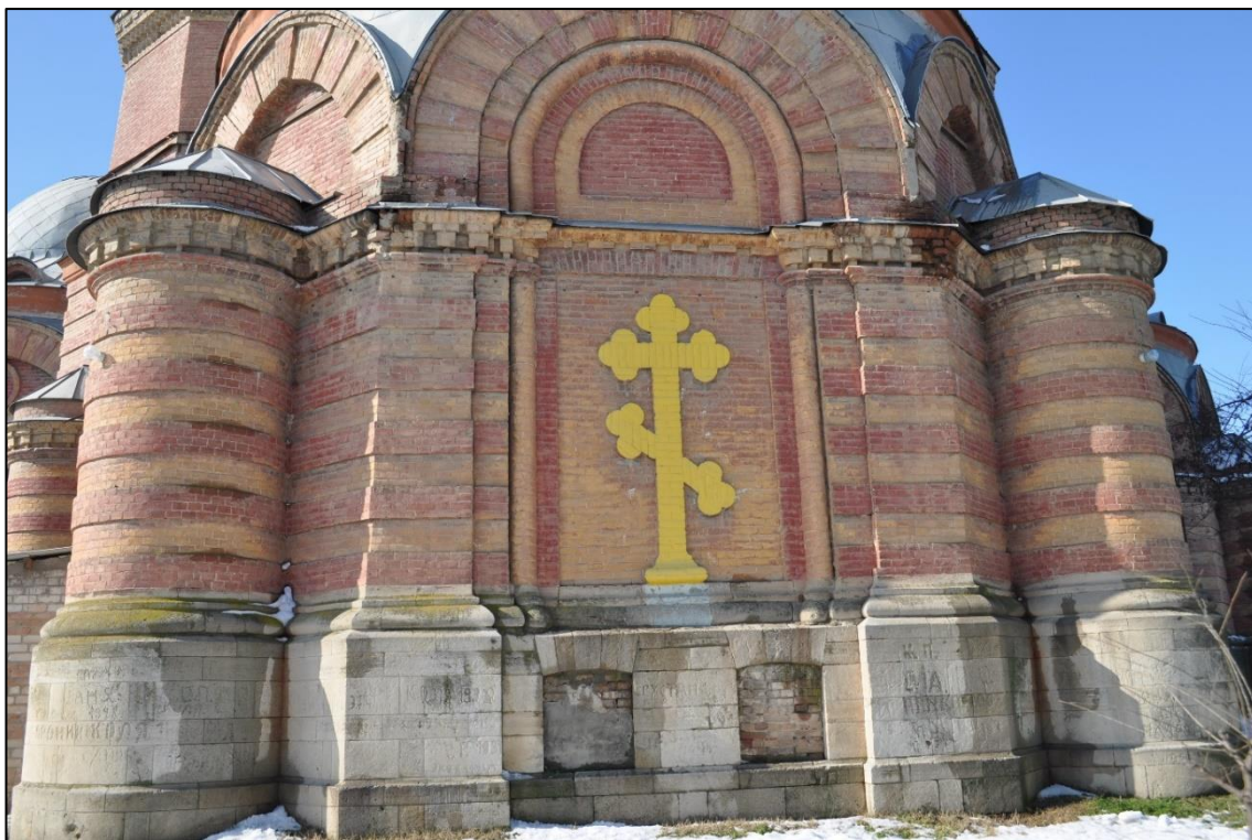
Фото 11. Общий вид здания, восточный фасад. (Фото выполнены 30.03.2023 г.)
