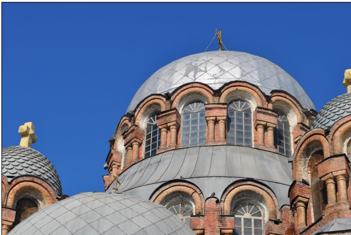
Фото 20. Общий вид здания, центральный купол. (Фото выполнены 30.03.2023 г.)
