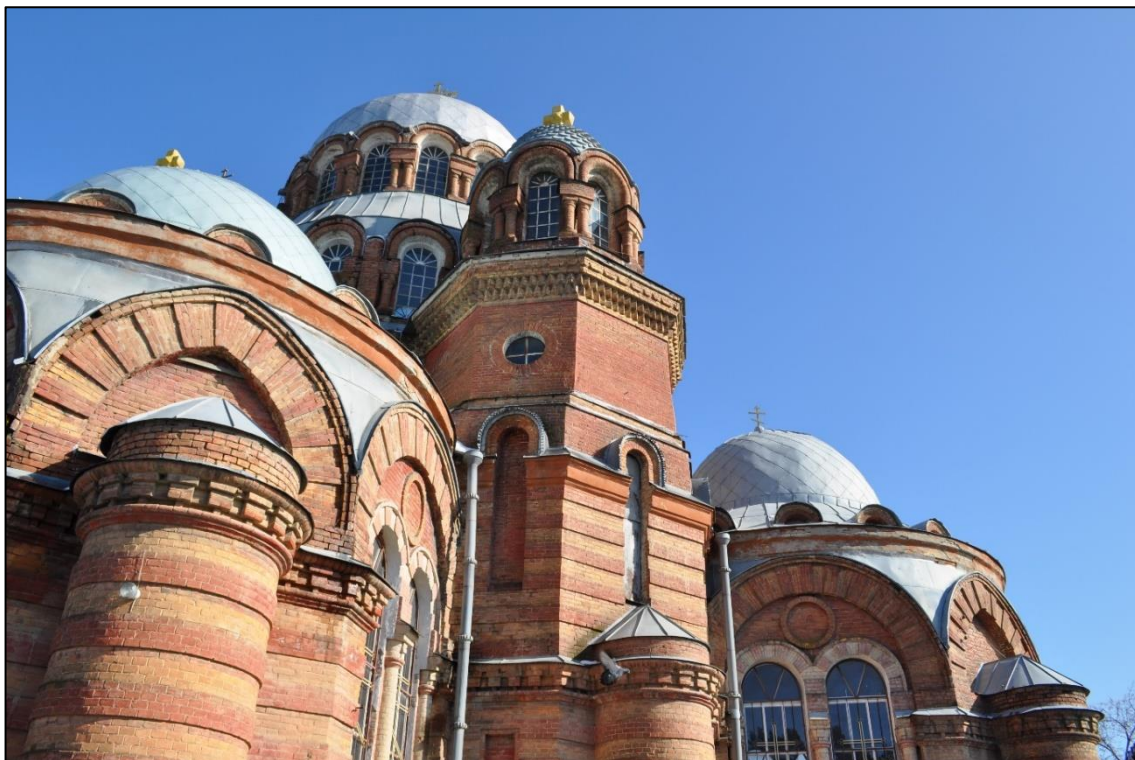
Фото 10. Общий вид здания, юго-восточный фасад. (Фото выполнены 30.03.2023 г.)
