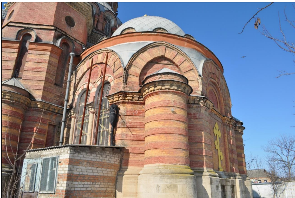
Фото 8. Общий вид здания, юго-восточный фасад. (Фото выполнены 30.03.2023 г.)
