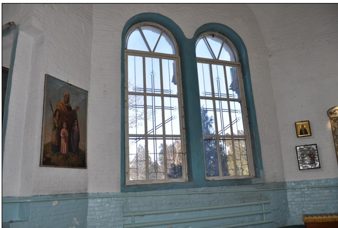
Фото 33. Общий вид интерьера объекта, оконные проемы. (Фото выполнены 30.03.2023 г.)
