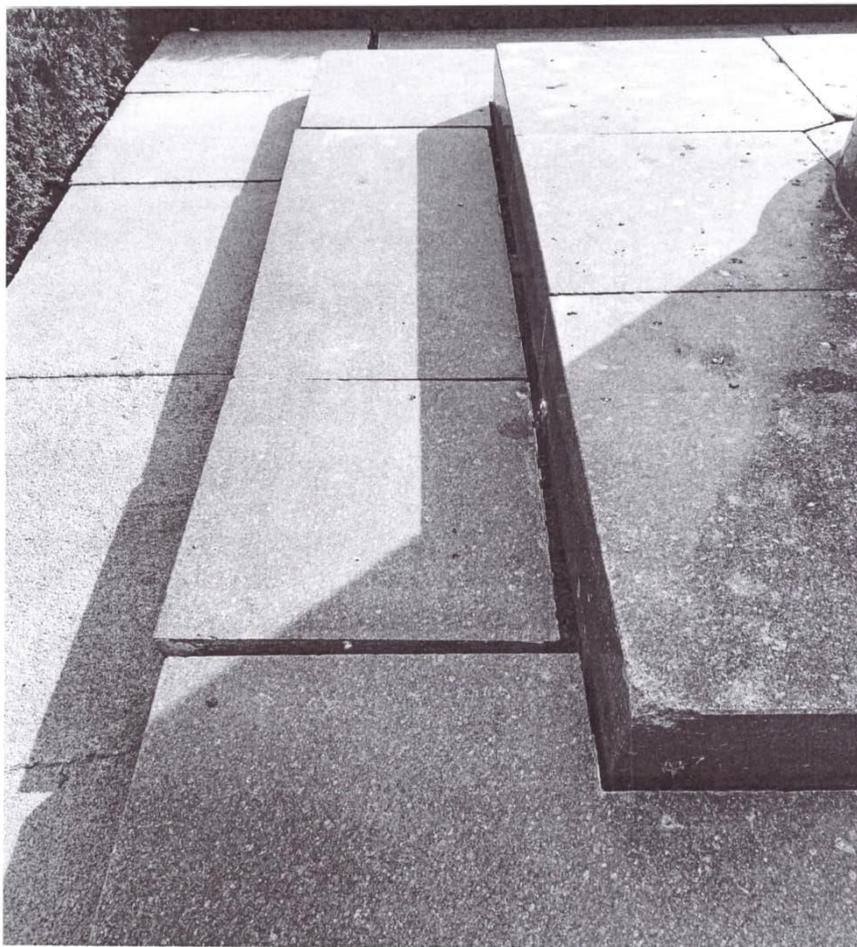
Рис.2 Осадка гранитных плит у основания объекта «могила Стальского Сулеймана (1869-1937 гг.)». Зафиксированы образовавшиеся зазоры между плитами.
