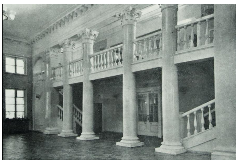
Илл. 3. Гор. Жуковский, Московская область, кинотеатр на 300 мест. Типовой проект. Арх. З.О. Брод. Внутренний зал (фойе) с колоннадой и лестницами.
