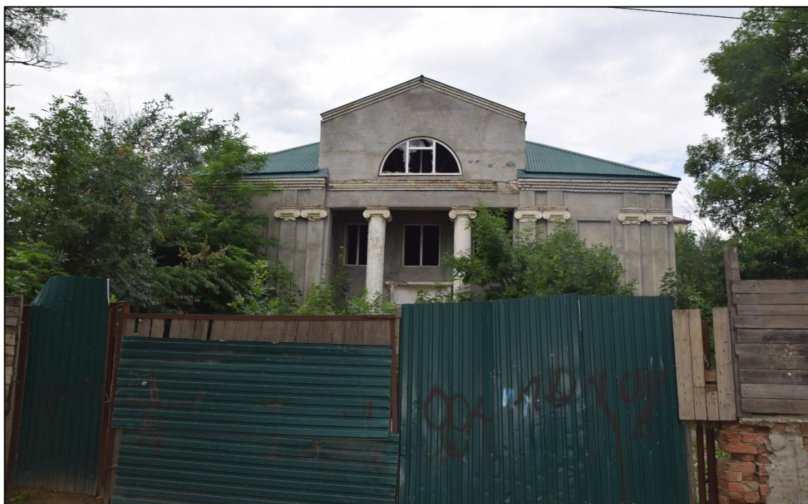
Фото 2. Общий вид на исследуемый объект, главный вход на территорию объекта. Вид на здание с лицевой стороны. (Фото выполнено: 14.06.2024 г.)
