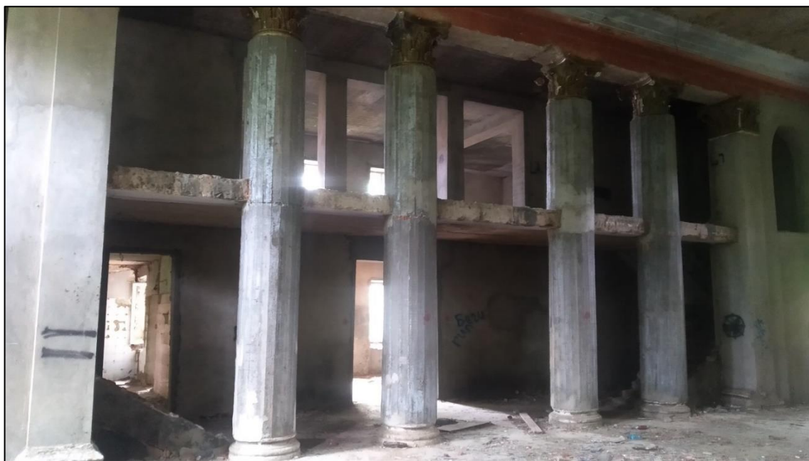
Фото 7. Вид на фойе здания с каннелированными колонами увенчанными композитными/коринфскими ордерами. По бокам выполнены лестницы. (Фото выполнено: 30.04.2024 г.)
