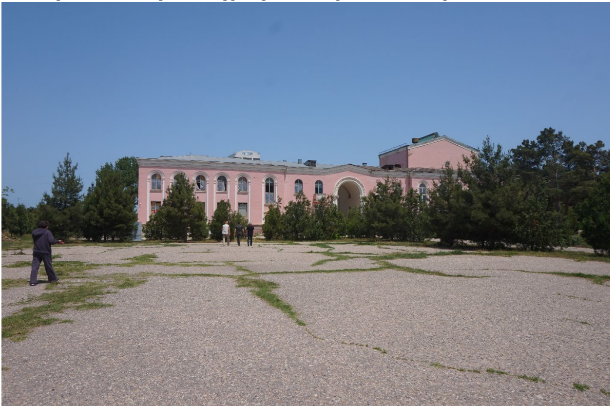
Фото 8. Вид на клубную часть ансамбля Дворца культуры «Дагдизель» с прилегающей парковой территорией с юго-западной стороны
