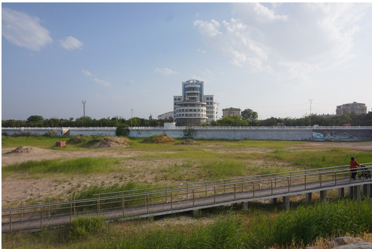
Фото 43. Вид на Объект (обозначен стрелкой) с береговой линии Каспийского моря. Видимость фрагментарная
