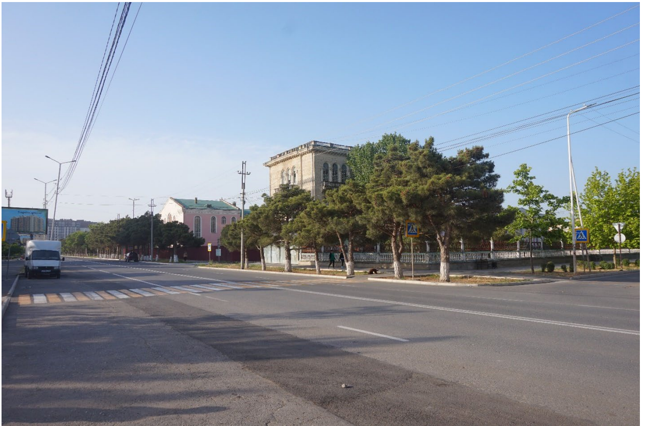
Фото 17. Вид на Объект с ул. Халилова с северо-западной стороны. Фрагментарная видимость.
