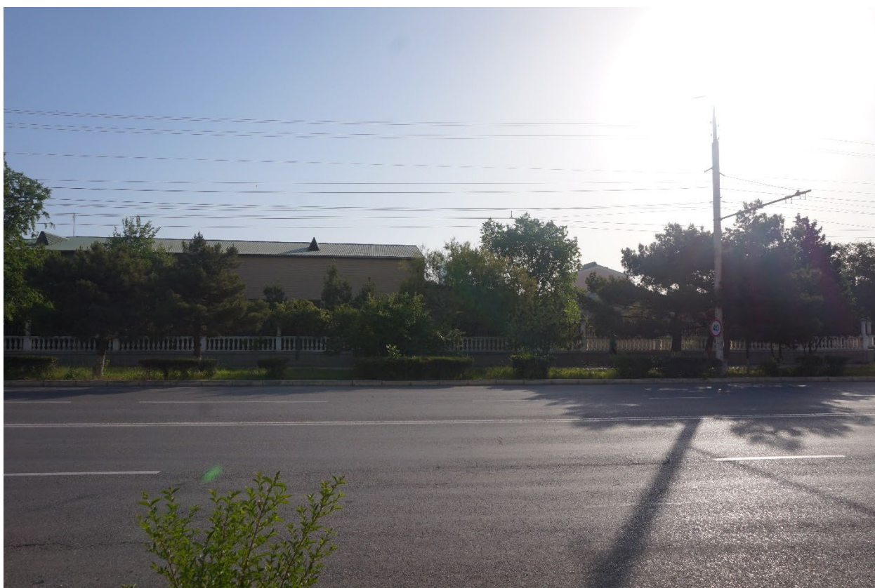
Фото 32. Вид на Объект с ул. Ленина с юго-западной стороны. Фрагментарная видимость
