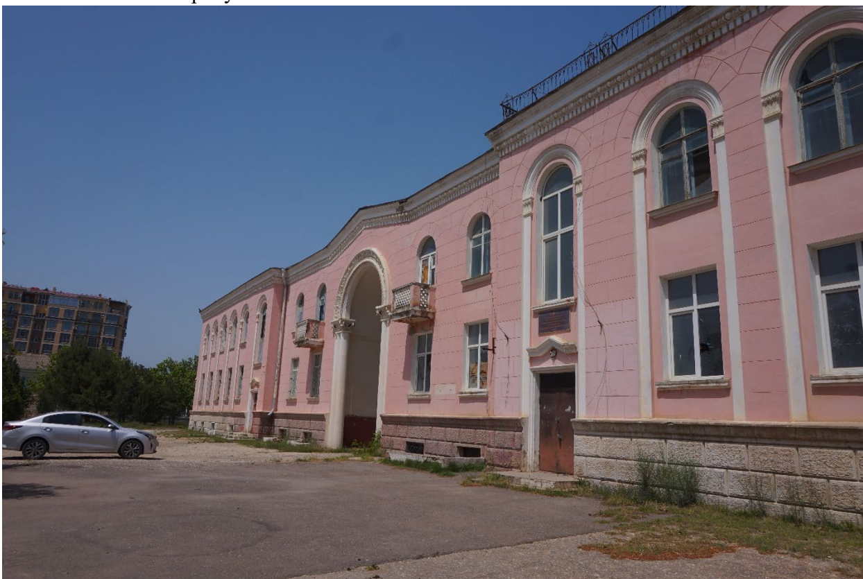
Фото 10. Вид на клубную часть ансамбля Дворца культуры «Дагдизель» с прилегающей парковой территорией с южной стороны
