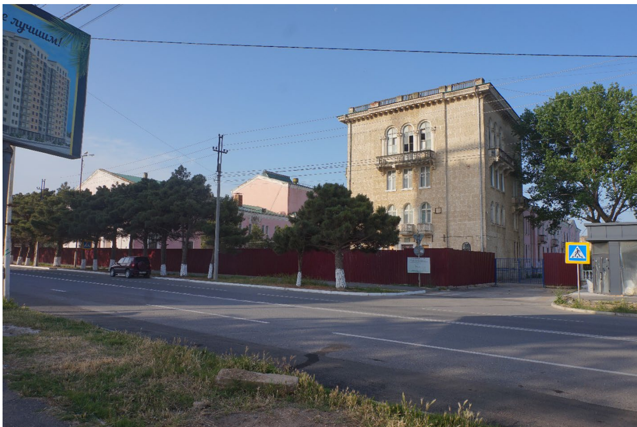
Фото 15. Вид на Объект с ул. Халилова с северо-западной стороны. Фрагментарная видимость.
