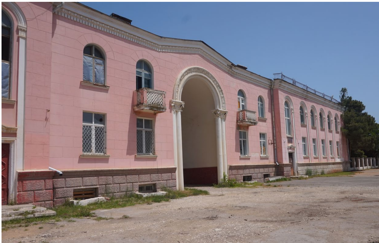
Фото 1. Вид Объекта в 2024 г.
