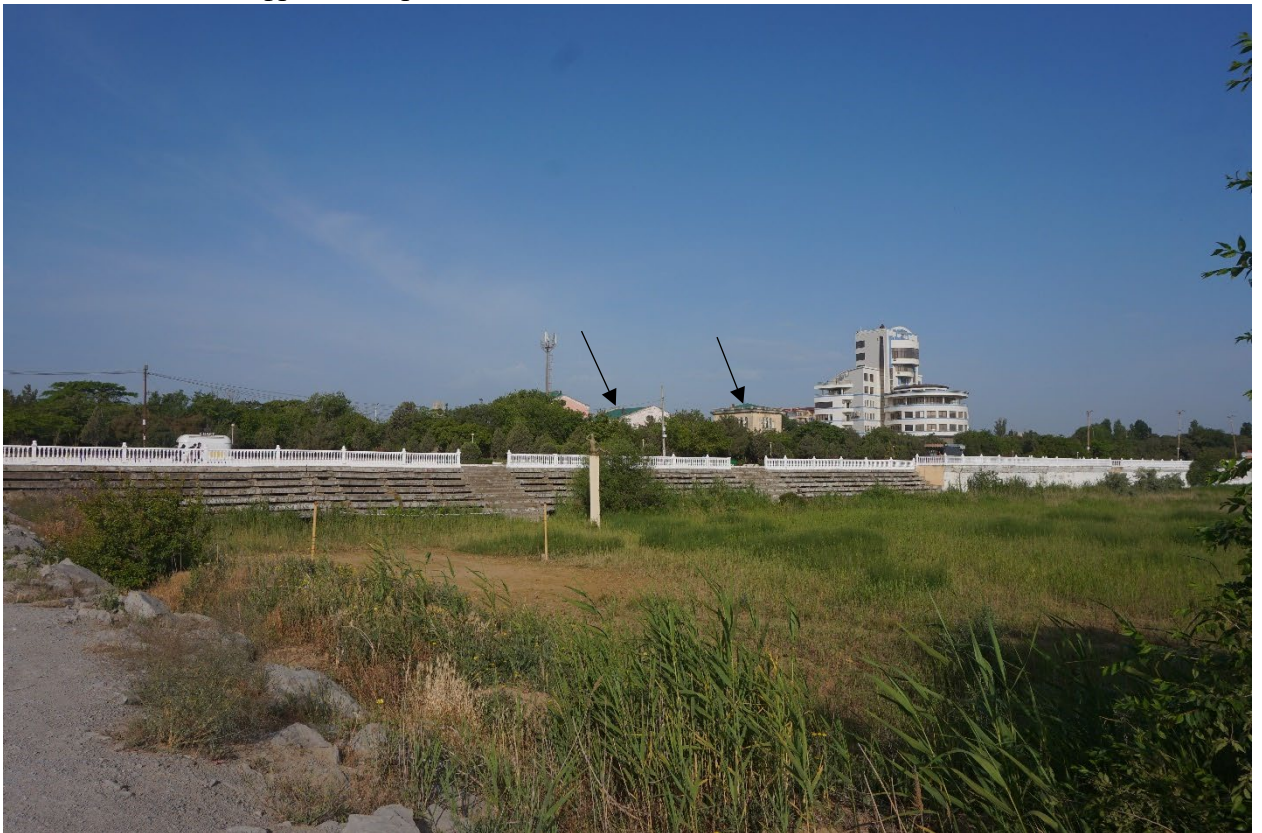
Фото 42. Вид на Объект (обозначен стрелкой) с береговой линии Каспийского моря. Видимость фрагментарная
