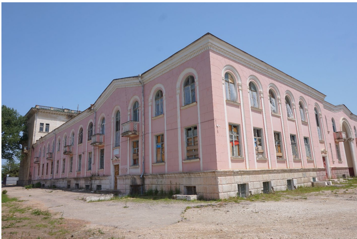
Фото 11. Вид на клубную часть ансамбля Дворца культуры «Дагдизель» с прилегающей парковой территорией с юго-западной стороны
