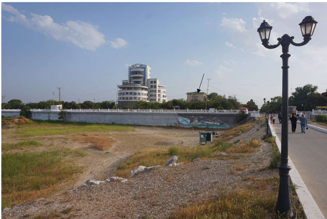
Фото 39. Вид на Объект (обозначен стрелкой) с береговой линии Каспийского моря. Видимость фрагментарная
