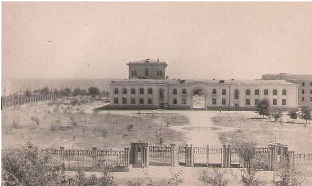
Фото 8. Вид Объекта в 1950 г.
