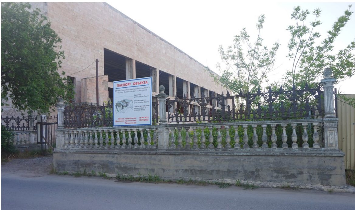
Фото 32. Реконструкция спортивного комплекса по ул. Комсомольская,1
