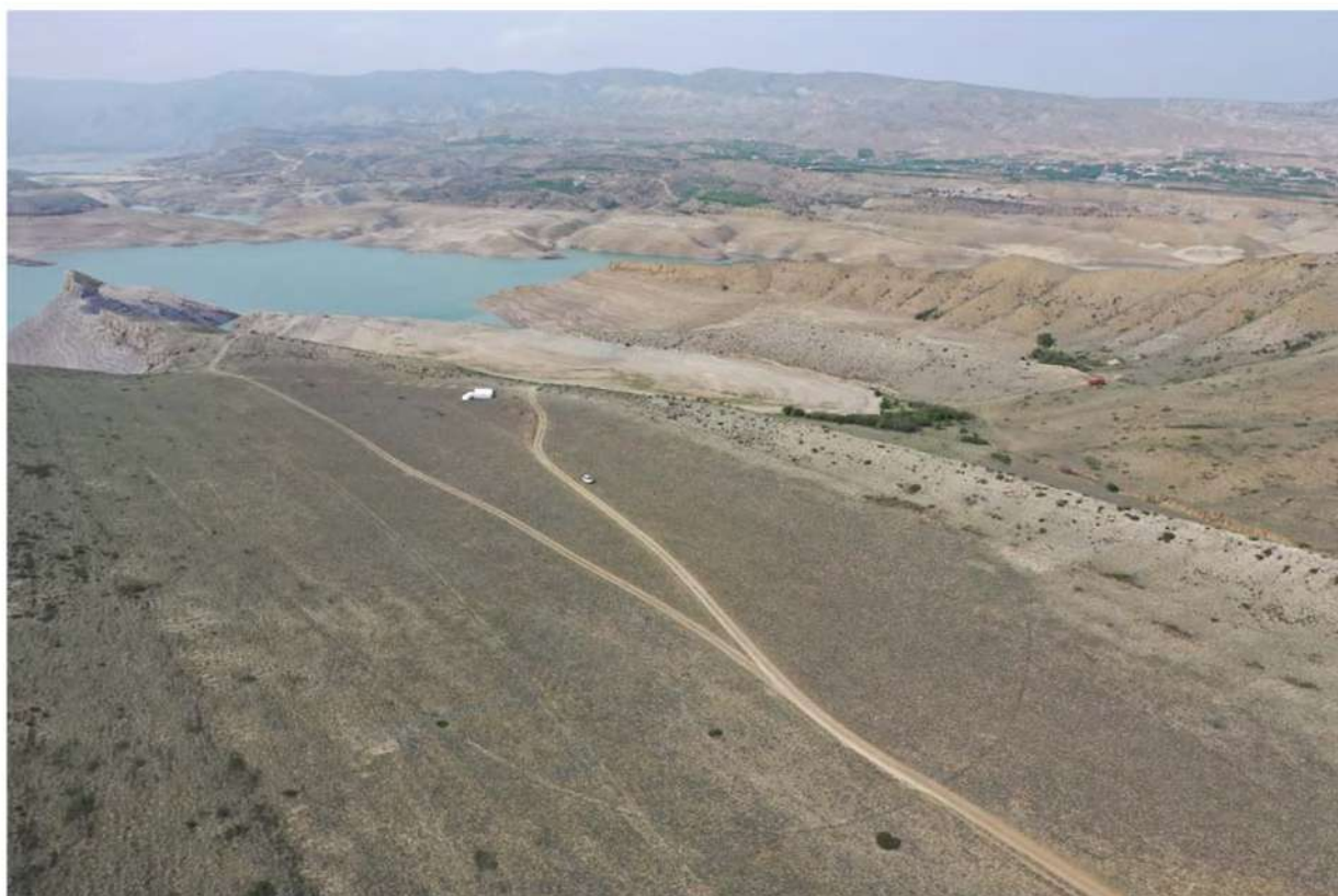
Рис. 4. Республика Дагестан. «Проектирование и строительство магистрального водовода Чиркей-Махачкала-Каспийск, Республика Дагестан. Территория площадки 1 этапа проектирования. Вид с юго-востока.
