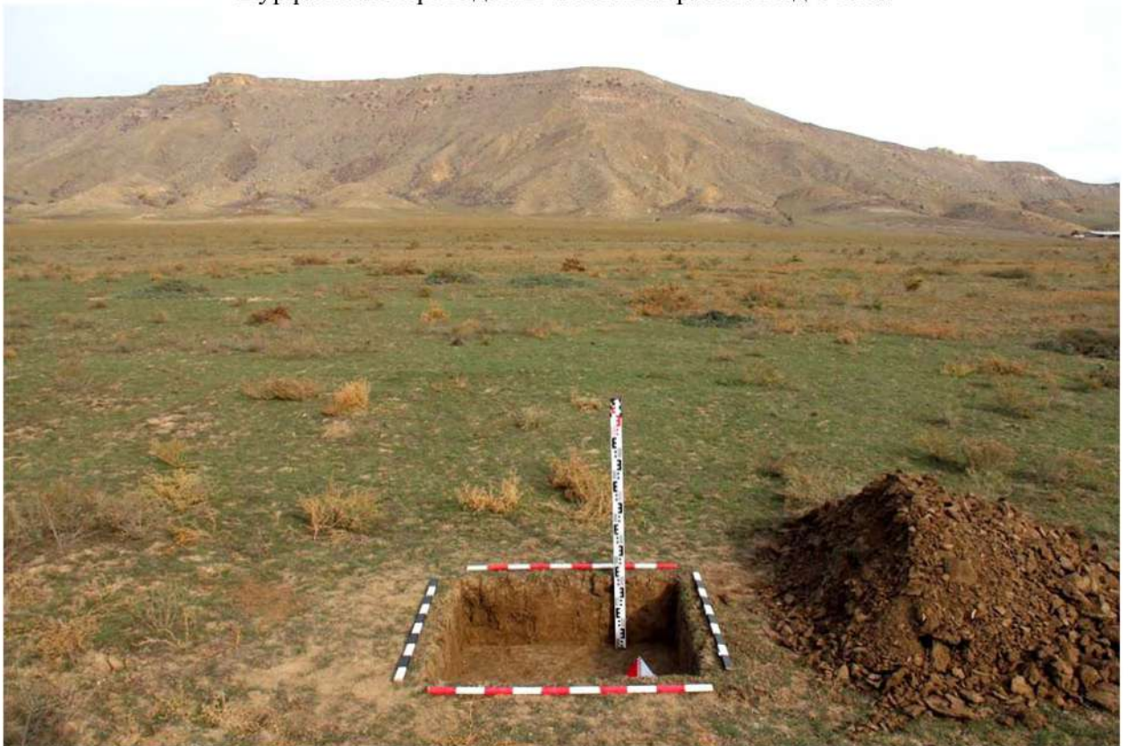
Рис. 209. Республика Дагестан. «Проектирование и строительство магистрального водовода Чиркей-Махачкала-Каспийск, Республика Дагестан». Шурф 16. Окончание земляных работ. Вид с юга.
