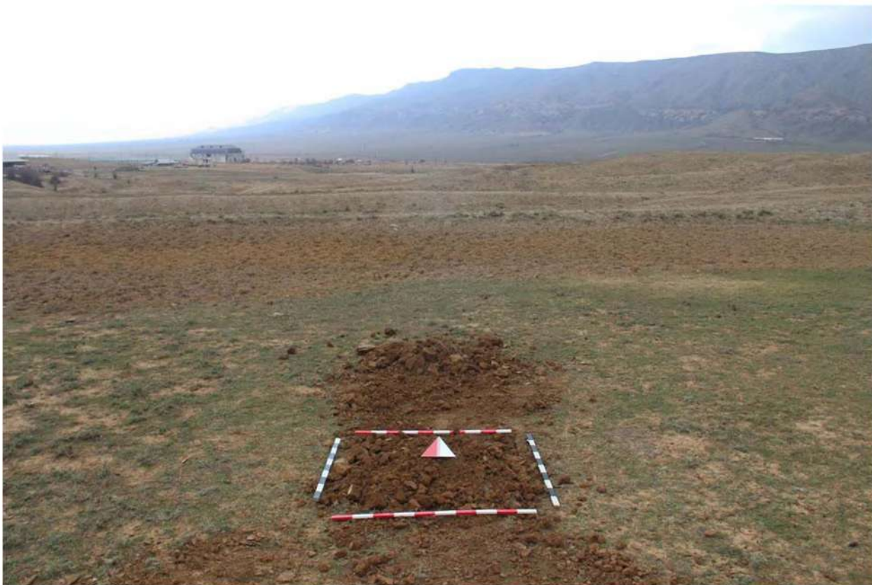
Рис. 202. Республика Дагестан. «Проектирование и строительство магистрального водовода Чиркей-Махачкала-Каспийск, Республика Дагестан». Шурф 13. Рекультивация шурфа после проведения земляных работ. Вид с юга.
