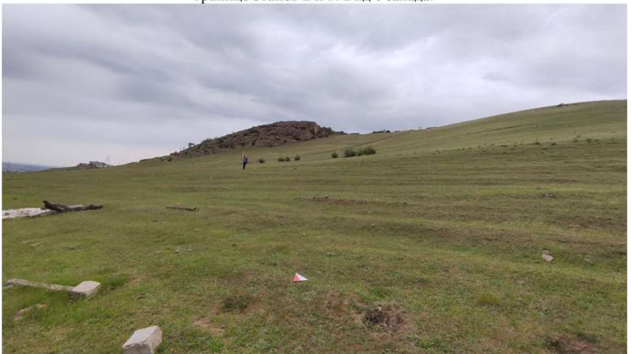
Рис. 112. Республика Дагестан. «Проектирование и строительство магистрального водовода Чиркей-Махачкала-Каспийск, Республика Дагестан». Место площадки на границе этапов 2 и 3. Вид с севера.
