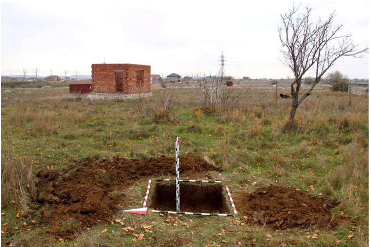
Рис. 416. Республика Дагестан. «Проектирование и строительство магистрального водовода Чиркей-Махачкала-Каспийск, Республика Дагестан». Шурф 80. Окончание земляных работ. Вид с запада.
