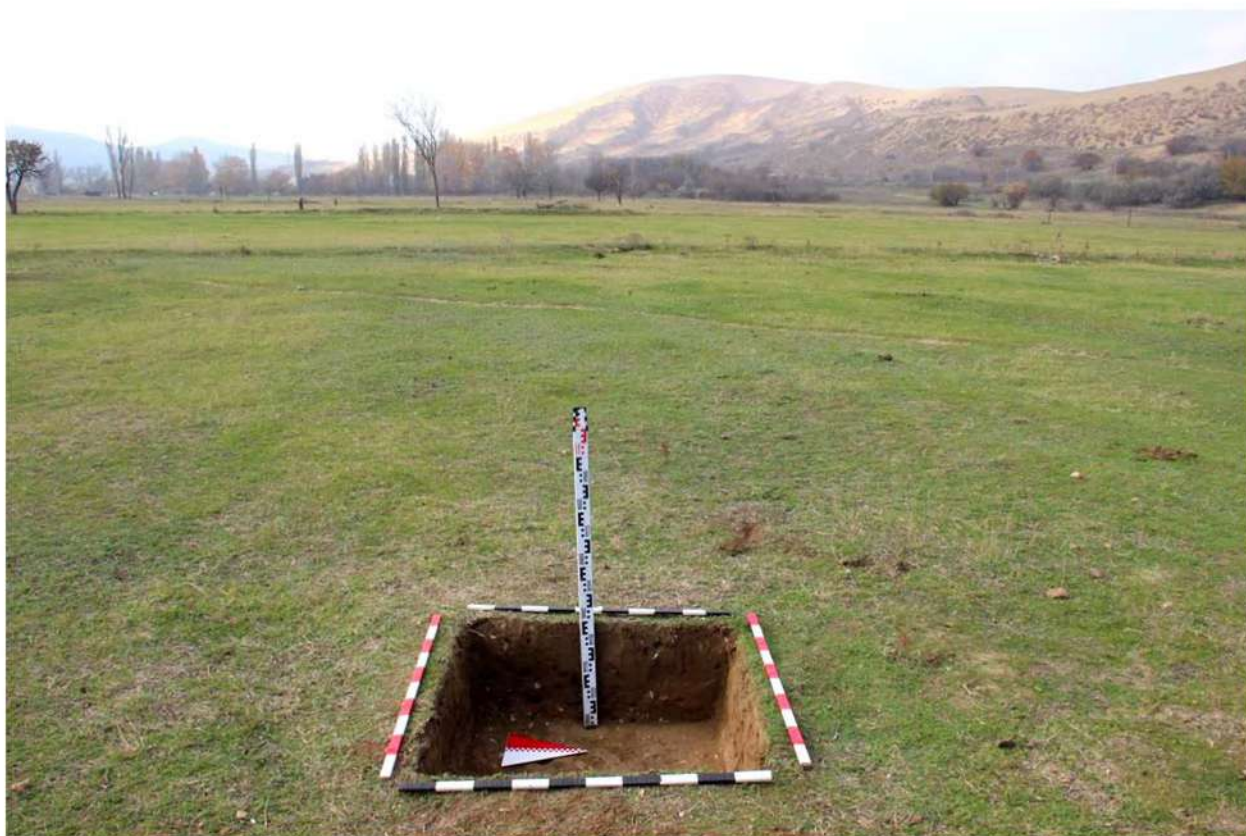
Рис. 302. Республика Дагестан. «Проектирование и строительство магистрального водовода Чиркей-Махачкала-Каспийск, Республика Дагестан». Шурф 45. Окончание земляных работ. Вид с востока.
