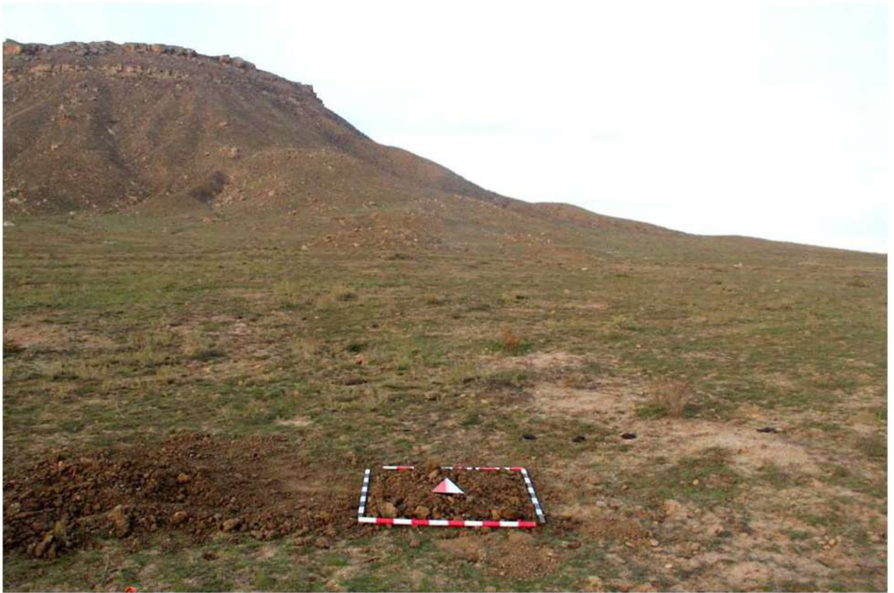
Рис. 224. Республика Дагестан. «Проектирование и строительство магистрального водовода Чиркей-Махачкала-Каспийск, Республика Дагестан». Шурф 19. Рекультивация шурфа после проведения земляных работ. Вид с юга.
