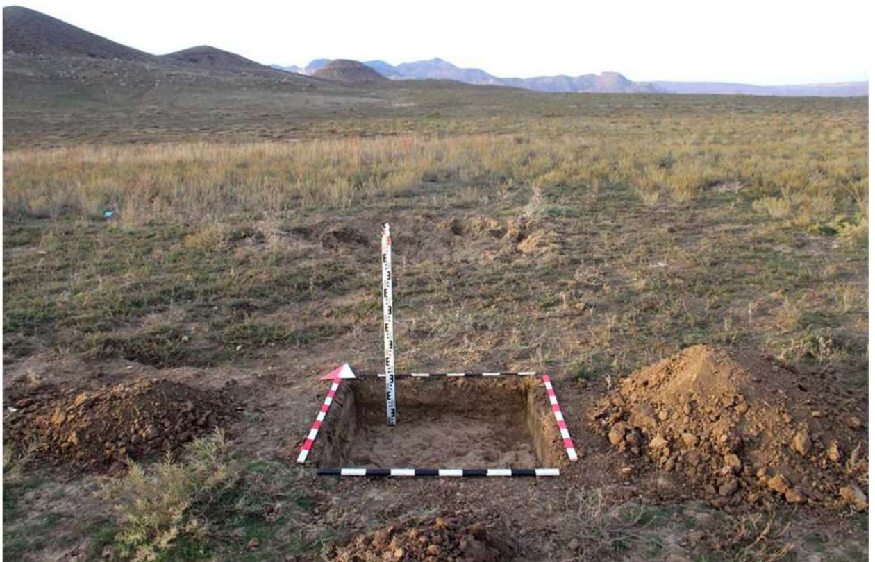
Рис. 225. Республика Дагестан. «Проектирование и строительство магистрального водовода Чиркей-Махачкала-Каспийск, Республика Дагестан». Шурф 20. Окончание земляных работ. Вид с юга.
