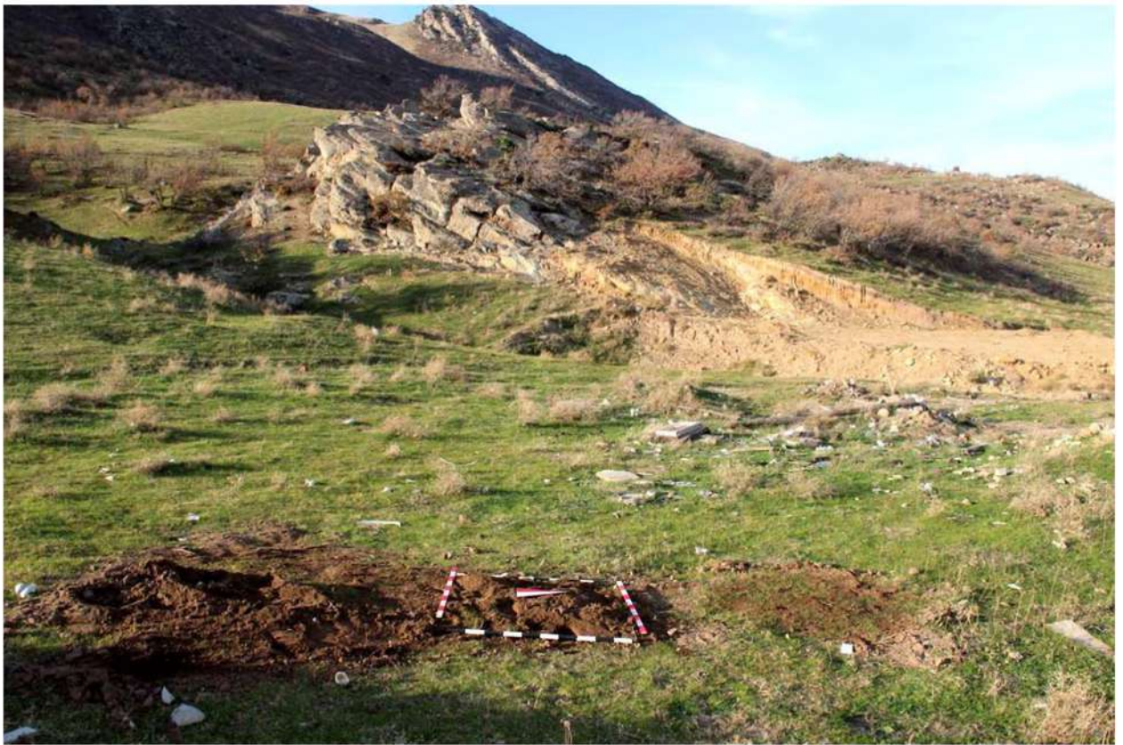
Рис. 348. Республика Дагестан. «Проектирование и строительство магистрального водовода Чиркей-Махачкала-Каспийск, Республика Дагестан». Шурф 58. Рекультивация шурфа после проведения земляных работ. Вид с востока.
