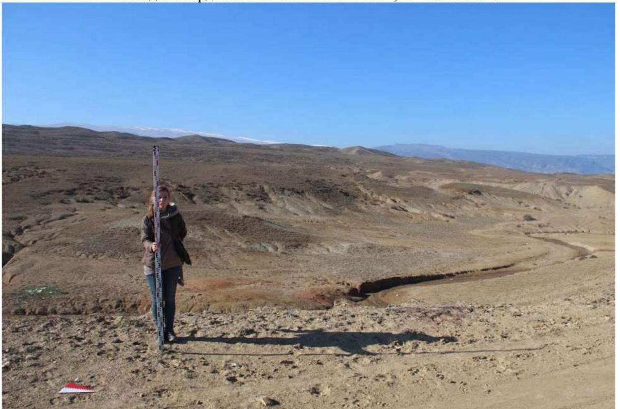
Рис. 17. Республика Дагестан. «Проектирование и строительство магистрального водовода Чиркей-Махачкала-Каспийск, Республика Дагестан». Вид с востока на трассу. Координаты точки: N 42.94291°, E 46.97215°.
