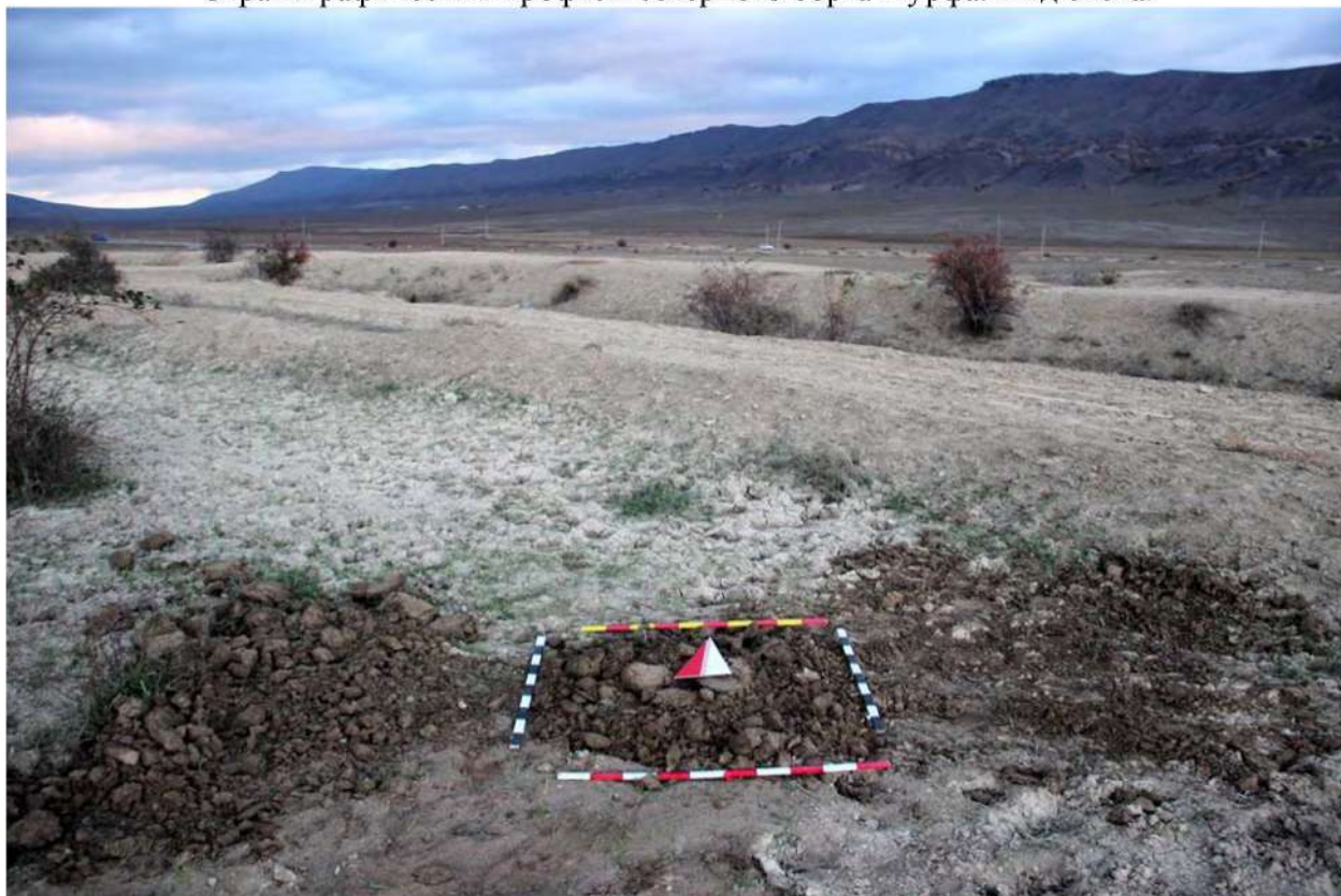
Рис. 199. Республика Дагестан. «Проектирование и строительство магистрального водовода Чиркей-Махачкала-Каспийск, Республика Дагестан». Шурф 12. Рекультивация шурфа после проведения земляных работ. Вид с юга.
