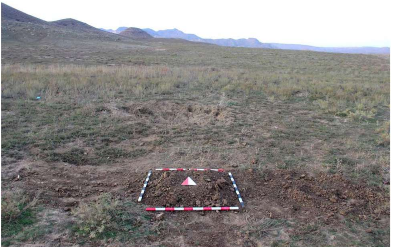
Рис. 227. Республика Дагестан. «Проектирование и строительство магистрального водовода Чиркей-Махачкала-Каспийск, Республика Дагестан». Шурф 20. Рекультивация шурфа после проведения земляных работ. Вид с юга.
