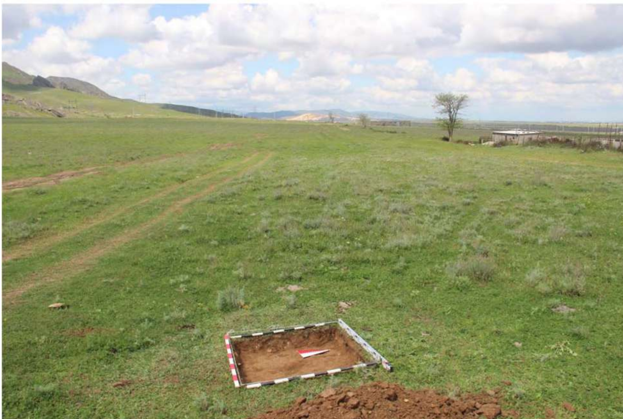
Рис. 334. Республика Дагестан. «Проектирование и строительство магистрального водовода Чиркей-Махачкала-Каспийск, Республика Дагестан». Шурф 55доп. Окончание земляных работ. Вид с востока.
