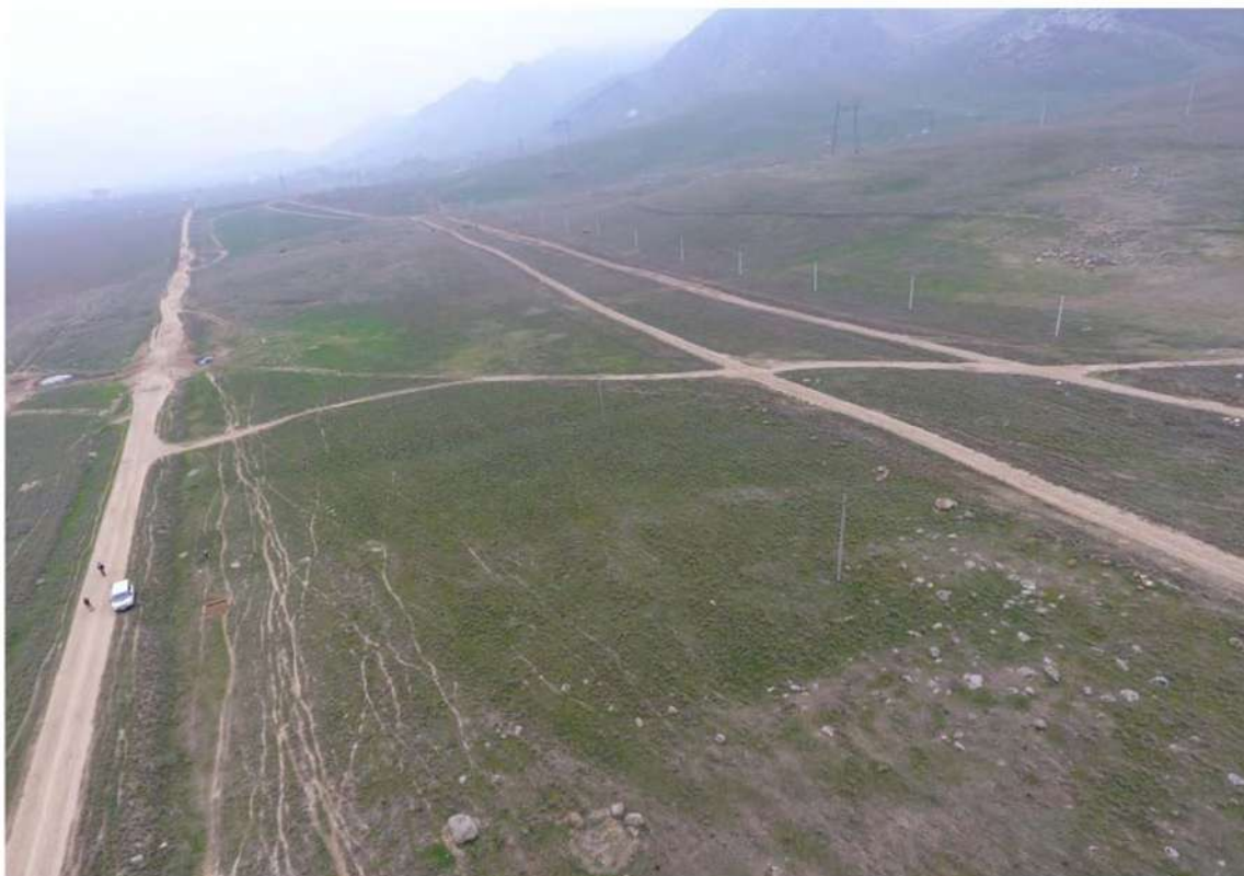
Рис. 453. Республика Дагестан. «Проектирование и строительство магистрального водовода Чиркей-Махачкала-Каспийск, Республика Дагестан». Вид с запада на территорию «Могильника «Ленинкентский Западный» в зоне проектируемой трассы. Координаты: N 42.97841°, E 47.31332°.
