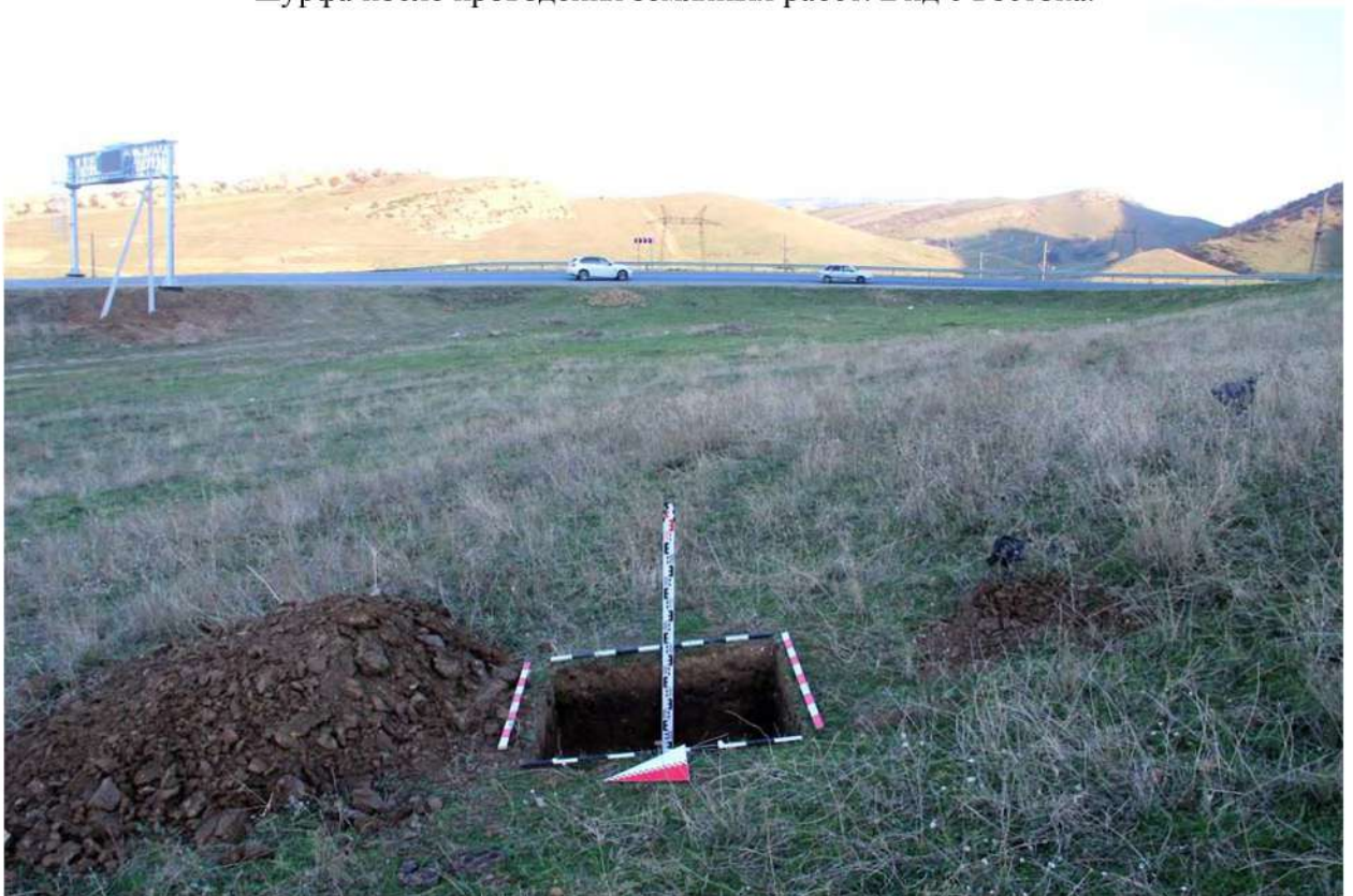
Рис. 349. Республика Дагестан. «Проектирование и строительство магистрального водовода Чиркей-Махачкала-Каспийск, Республика Дагестан». Шурф 59. Окончание земляных работ. Вид с запада.
