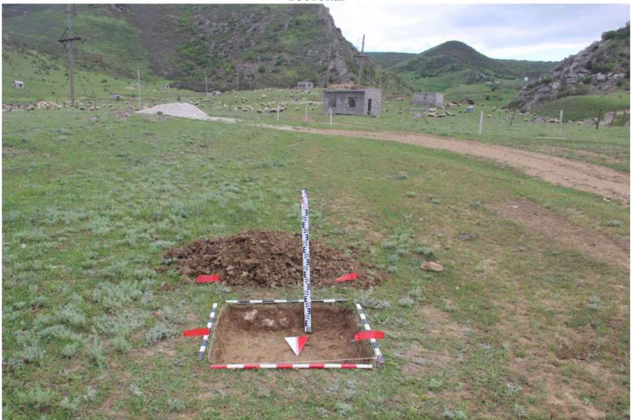
Рис. 353. Республика Дагестан. «Проектирование и строительство магистрального водовода Чиркей-Махачкала-Каспийск, Республика Дагестан». Шурф 60 доп. Вид с севера.
