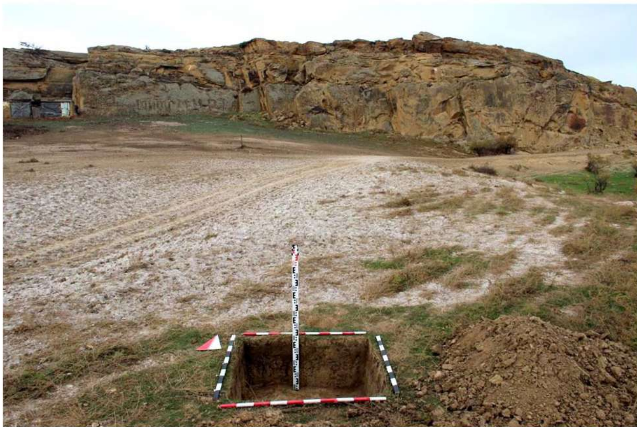
Рис. 282. Республика Дагестан. «Проектирование и строительство магистрального водовода Чиркей-Махачкала-Каспийск, Республика Дагестан». Шурф 38. Окончание земляных работ. Вид с юга.
