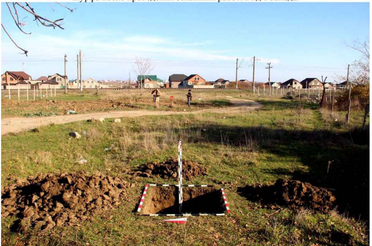
Рис. 413. Республика Дагестан. «Проектирование и строительство магистрального водовода Чиркей-Махачкала-Каспийск, Республика Дагестан». Шурф 79. Окончание земляных работ. Вид с запада.
