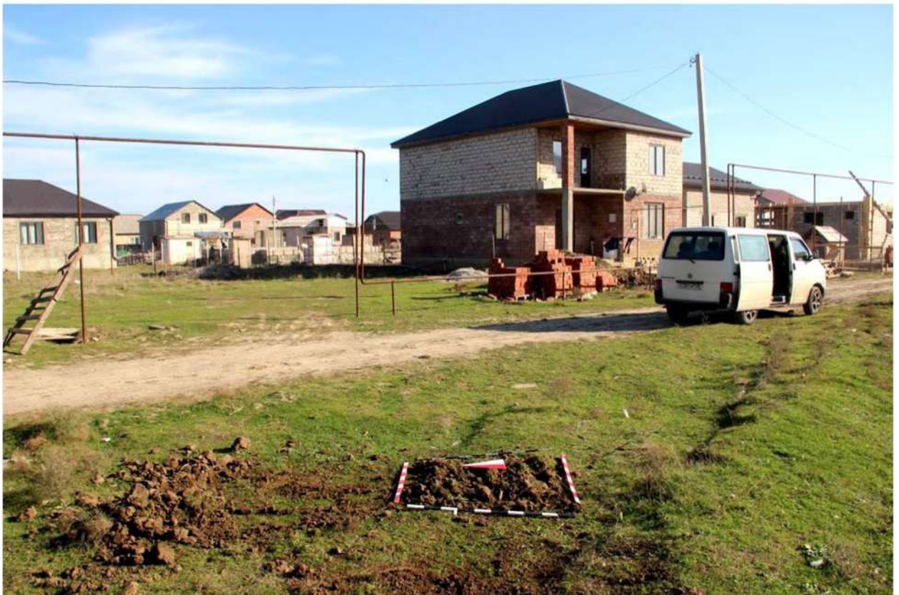
Рис. 412. Республика Дагестан. «Проектирование и строительство магистрального водовода Чиркей-Махачкала-Каспийск, Республика Дагестан». Шурф 78. Рекультивация шурфа после проведения земляных работ. Вид с запада.
