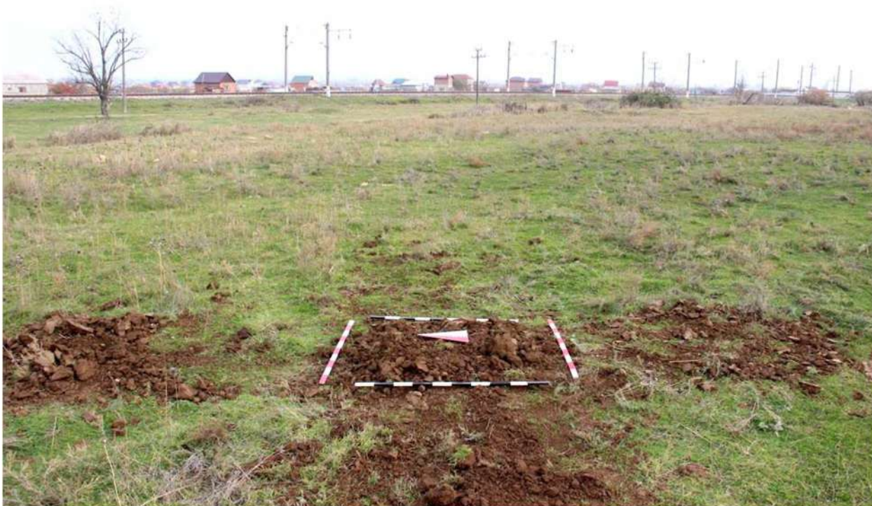
Рис. 424. Республика Дагестан. «Проектирование и строительство магистрального водовода Чиркей-Махачкала-Каспийск, Республика Дагестан». Шурф 82. Рекультивация шурфа после проведения земляных работ. Вид с запада.
