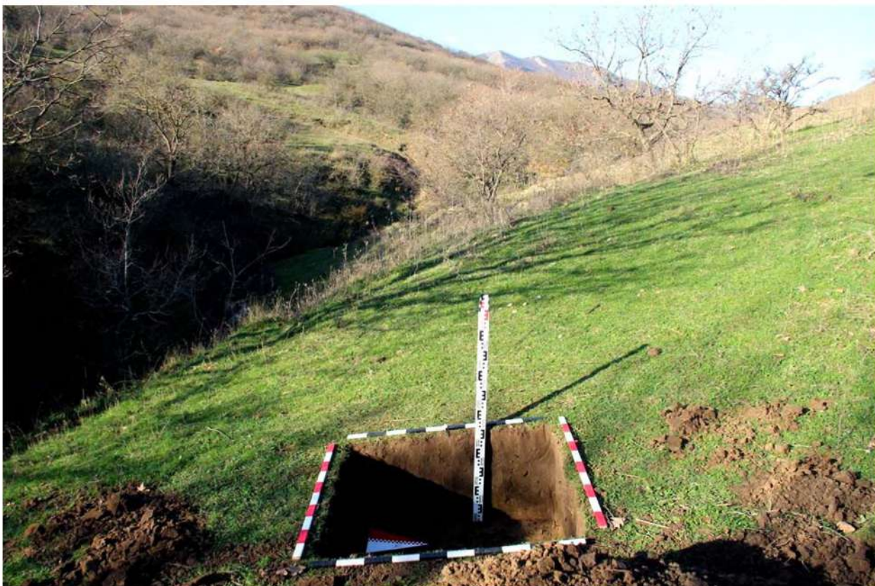
Рис. 386. Республика Дагестан. «Проектирование и строительство магистрального водовода Чиркей-Махачкала-Каспийск, Республика Дагестан». Шурф 70. Окончание земляных работ. Вид с востока.
