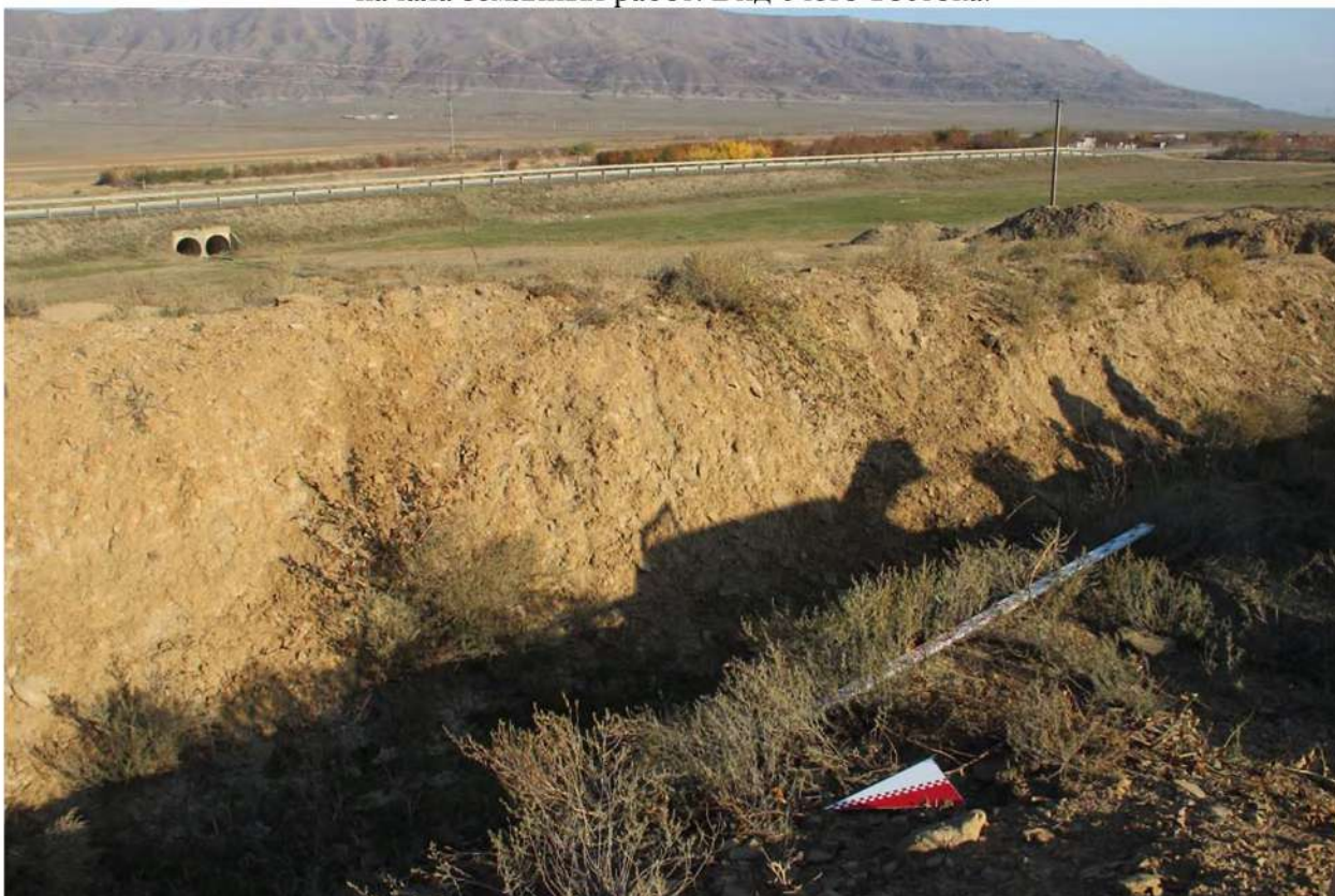
Рис. 27. Республика Дагестан. «Проектирование и строительство магистрального водовода Чиркей-Махачкала-Каспийск, Республика Дагестан». Место разбивки шурфа 9. Вид с запада.
