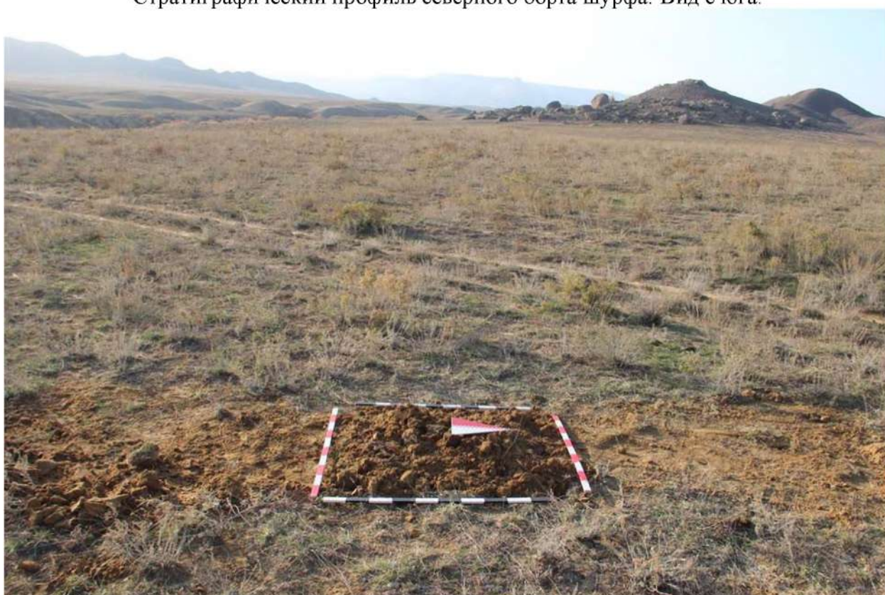
Рис. 251. Республика Дагестан. «Проектирование и строительство магистрального водовода Чиркей-Махачкала-Каспийск, Республика Дагестан». Шурф 28. Рекультивация шурфа после проведения земляных работ. Вид с востока.
