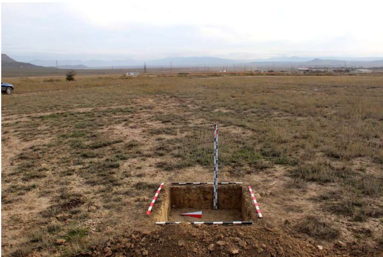
Рис. 203. Республика Дагестан. «Проектирование и строительство магистрального водовода Чиркей-Махачкала-Каспийск, Республика Дагестан». Шурф 14. Окончание земляных работ. Вид с запада.
