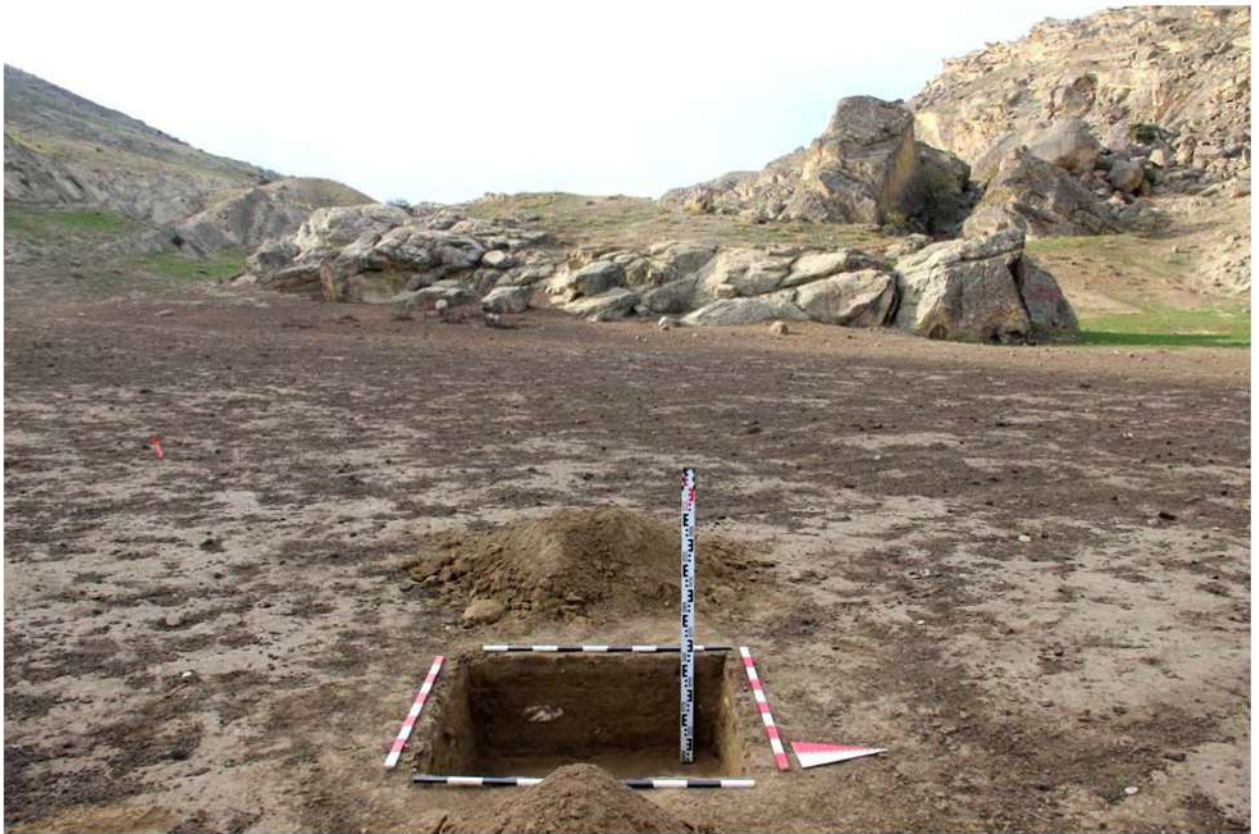
Рис. 276. Республика Дагестан. «Проектирование и строительство магистрального водовода Чиркей-Махачкала-Каспийск, Республика Дагестан». Шурф 36. Окончание земляных работ. Вид с востока.
