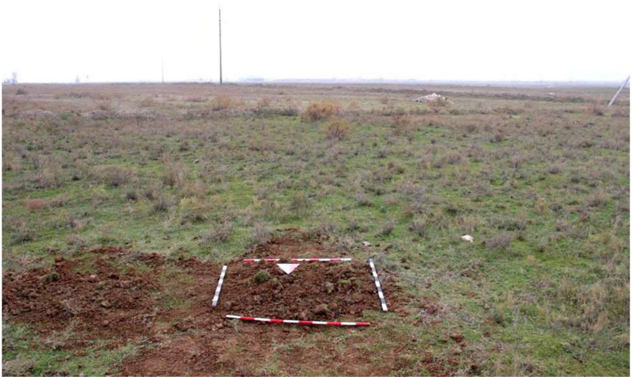
Рис. 430. Республика Дагестан. «Проектирование и строительство магистрального водовода Чиркей-Махачкала-Каспийск, Республика Дагестан». Шурф 84. Рекультивация шурфа после проведения земляных работ. Вид с севера.
