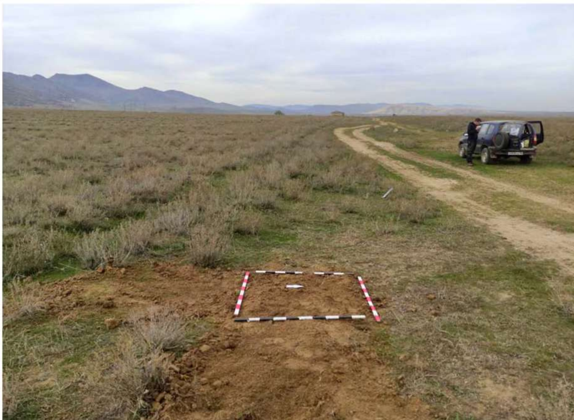
Рис. 322. Республика Дагестан. «Проектирование и строительство магистрального водовода Чиркей-Махачкала-Каспийск, Республика Дагестан». Шурф 51. Рекультивация шурфа после проведения земляных работ. Вид с востока.
