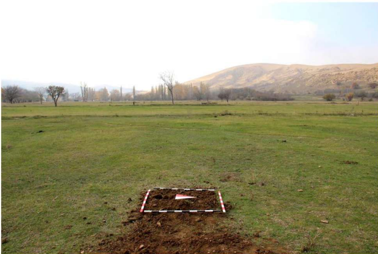
Рис. 304. Республика Дагестан. «Проектирование и строительство магистрального водовода Чиркей-Махачкала-Каспийск, Республика Дагестан». Шурф 45. Рекультивация шурфа после проведения земляных работ. Вид с востока.
