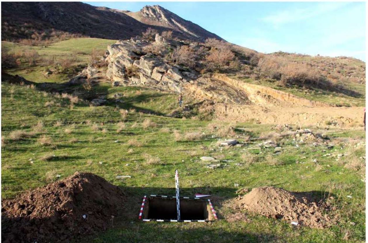
Рис. 346. Республика Дагестан. «Проектирование и строительство магистрального водовода Чиркей-Махачкала-Каспийск, Республика Дагестан». Шурф 58. Окончание земляных работ. Вид с востока.
