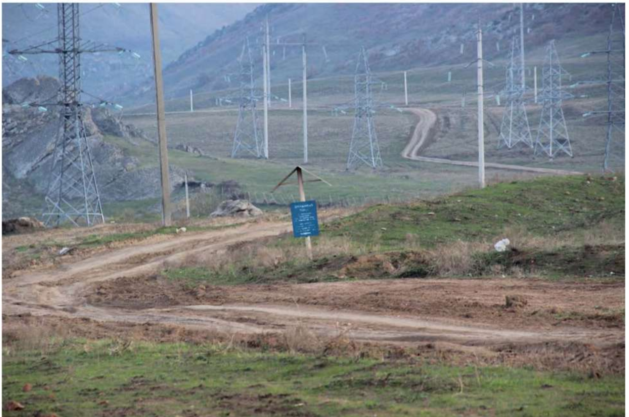
Рис. 100. Республика Дагестан. «Проектирование и строительство магистрального водовода Чиркей-Махачкала-Каспийск, Республика Дагестан». Вид с запада на изгиб трассы.
