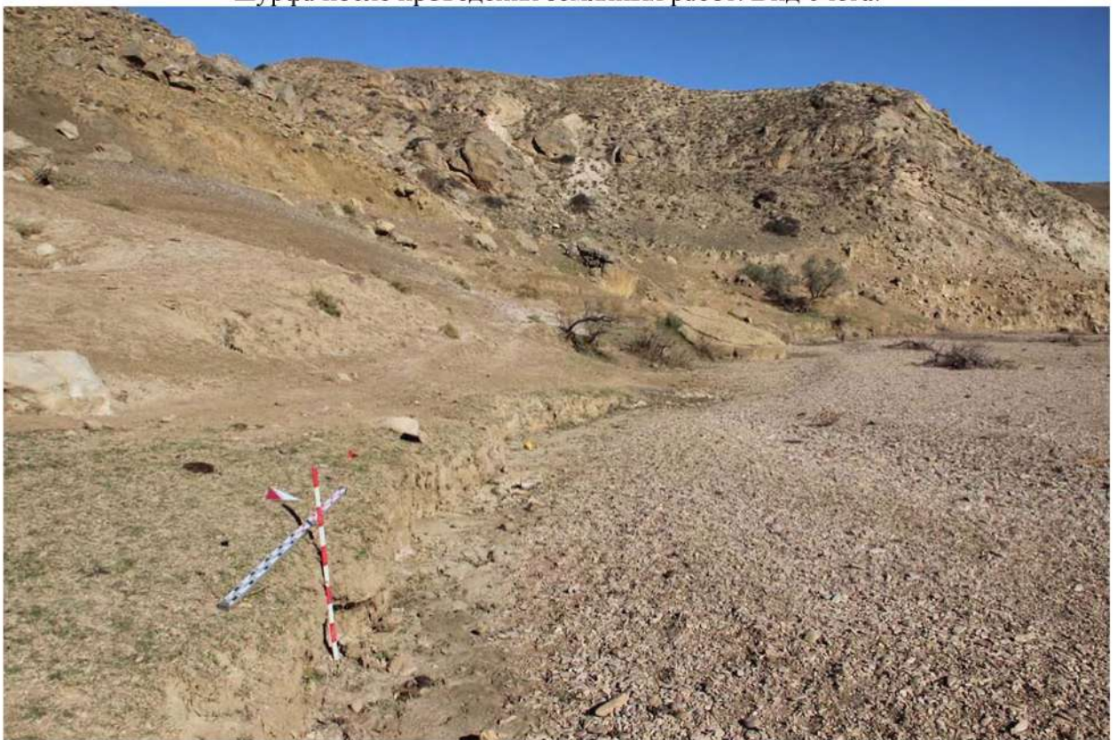
Рис. 291. Республика Дагестан. «Проектирование и строительство магистрального водовода Чиркей-Махачкала-Каспийск, Республика Дагестан». Шурф 41. Место разбивки шурфа до начала земляных работ. Вид с юга.
