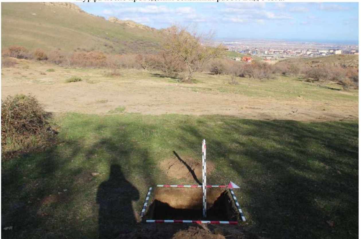
Рис. 359. Республика Дагестан. «Проектирование и строительство магистрального водовода Чиркей-Махачкала-Каспийск, Республика Дагестан». Шурф 61. Вид с юга.
