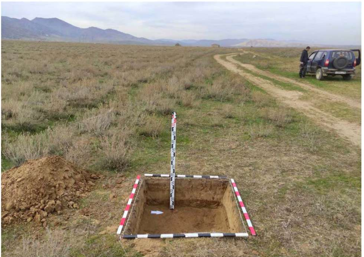
Рис. 320. Республика Дагестан. «Проектирование и строительство магистрального водовода Чиркей-Махачкала-Каспийск, Республика Дагестан». Шурф 51. Вид с востока.
