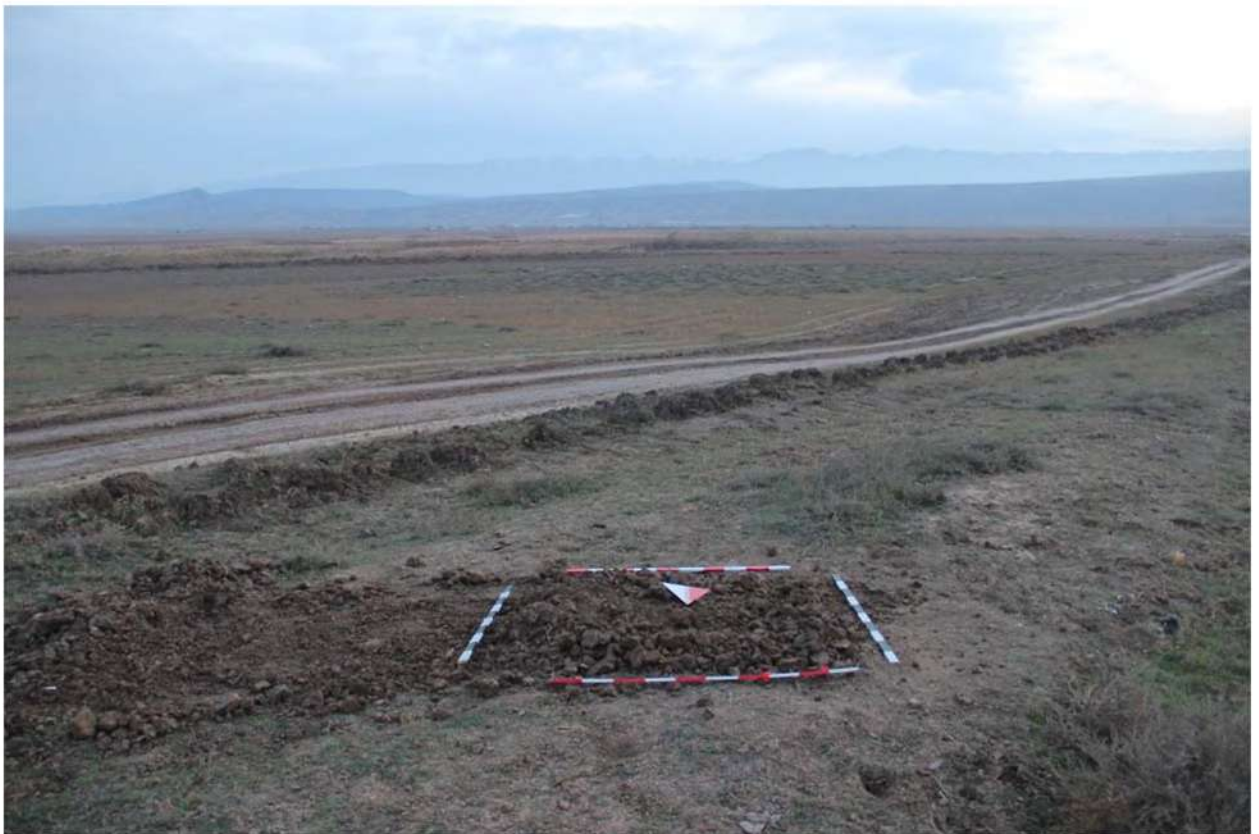
Рис. 218. Республика Дагестан. «Проектирование и строительство магистрального водовода Чиркей-Махачкала-Каспийск, Республика Дагестан». Шурф 17. Рекультивация шурфа после проведения земляных работ. Вид с севера.
