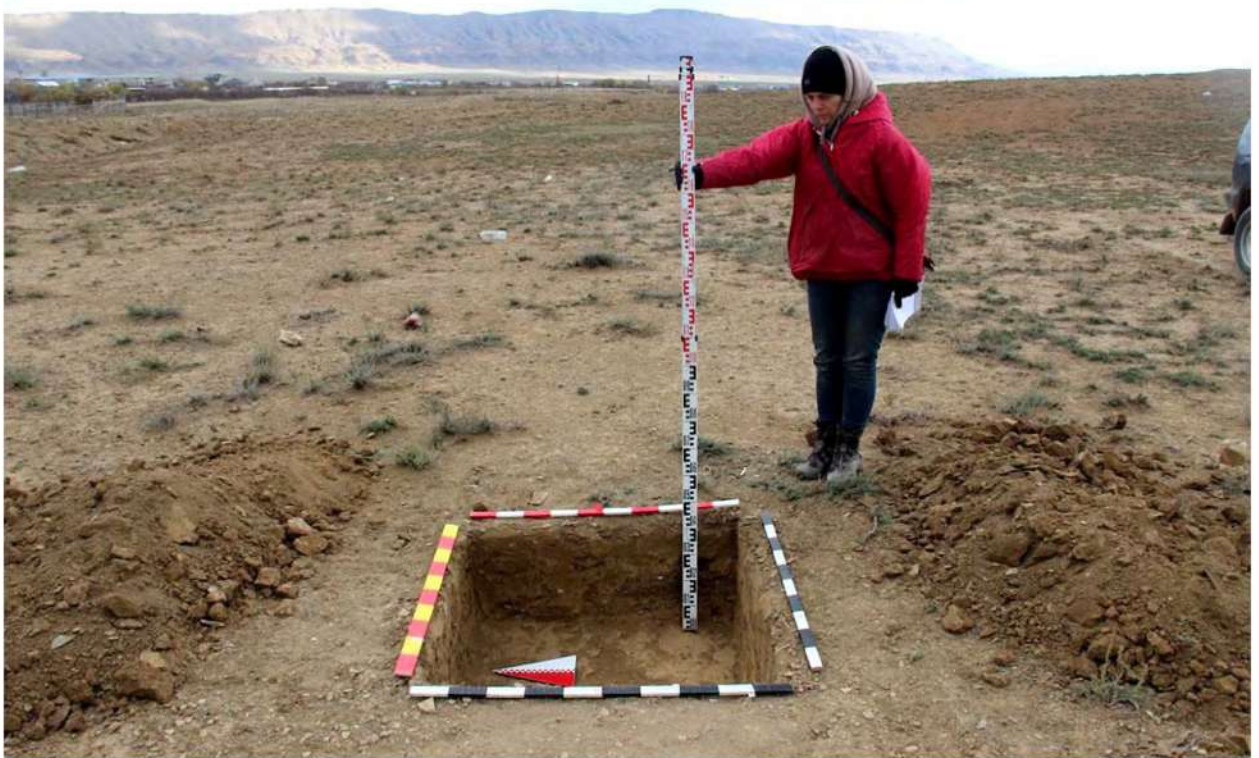
Рис. 180. Республика Дагестан. «Проектирование и строительство магистрального водовода Чиркей-Махачкала-Каспийск, Республика Дагестан». Шурф 5. Окончание земляных работ. Вид с запада.
