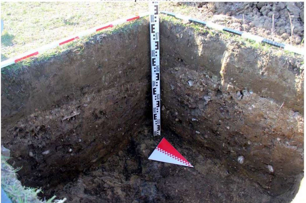
Рис. 405. Республика Дагестан. «Проектирование и строительство магистрального водовода Чиркей-Махачкала-Каспийск, Республика Дагестан». Шурф 76. Стратиграфический профиль южного и западного бортов шурфа. Вид с востока.
