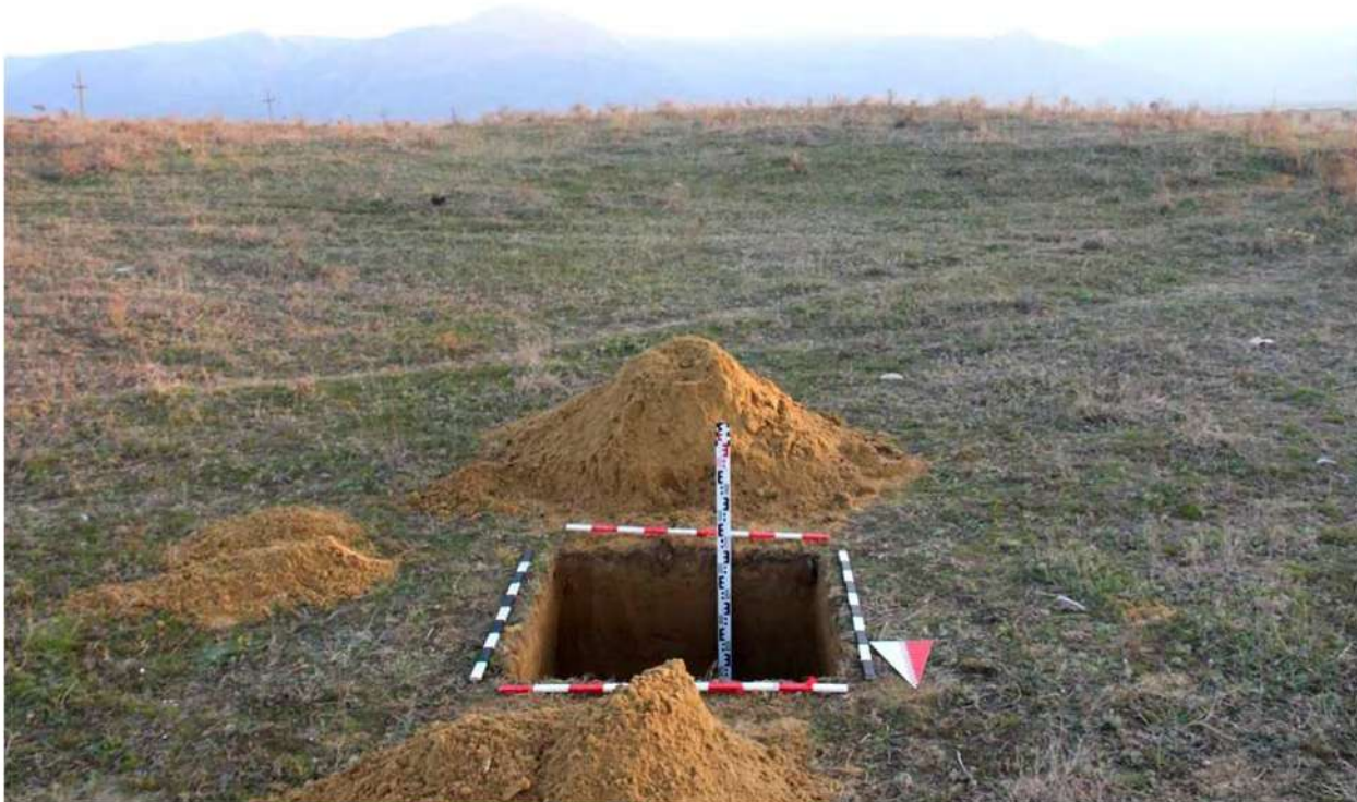
Рис. 308. Республика Дагестан. «Проектирование и строительство магистрального водовода Чиркей-Махачкала-Каспийск, Республика Дагестан». Шурф 47. Окончание земляных работ. Вид с севера.
