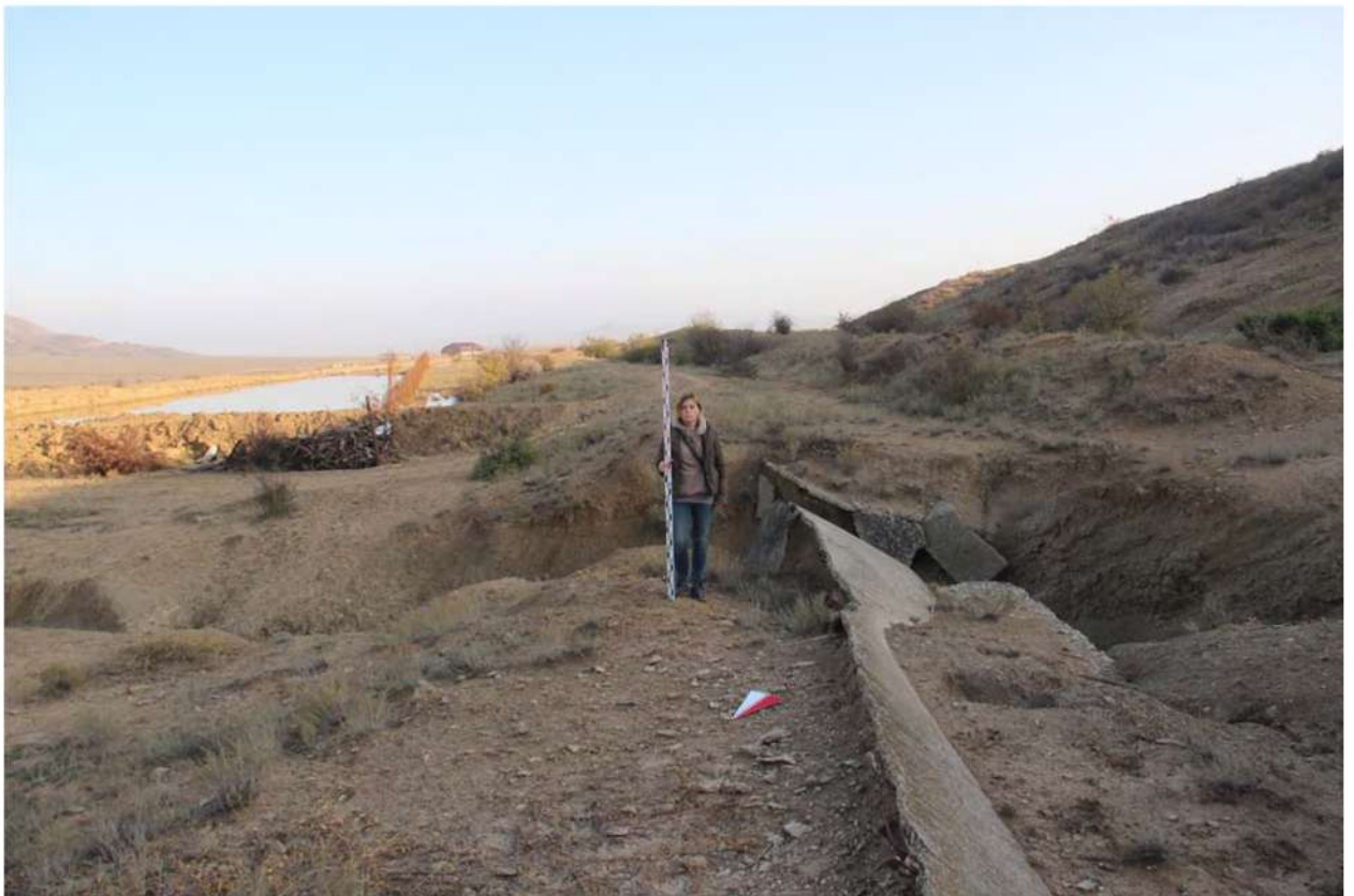
Рис. 28. Республика Дагестан. «Проектирование и строительство магистрального водовода Чиркей-Махачкала-Каспийск, Республика Дагестан». Вид с северо-запада на трассу. Координаты точки: N 42.91451°, E 47.02470°.
