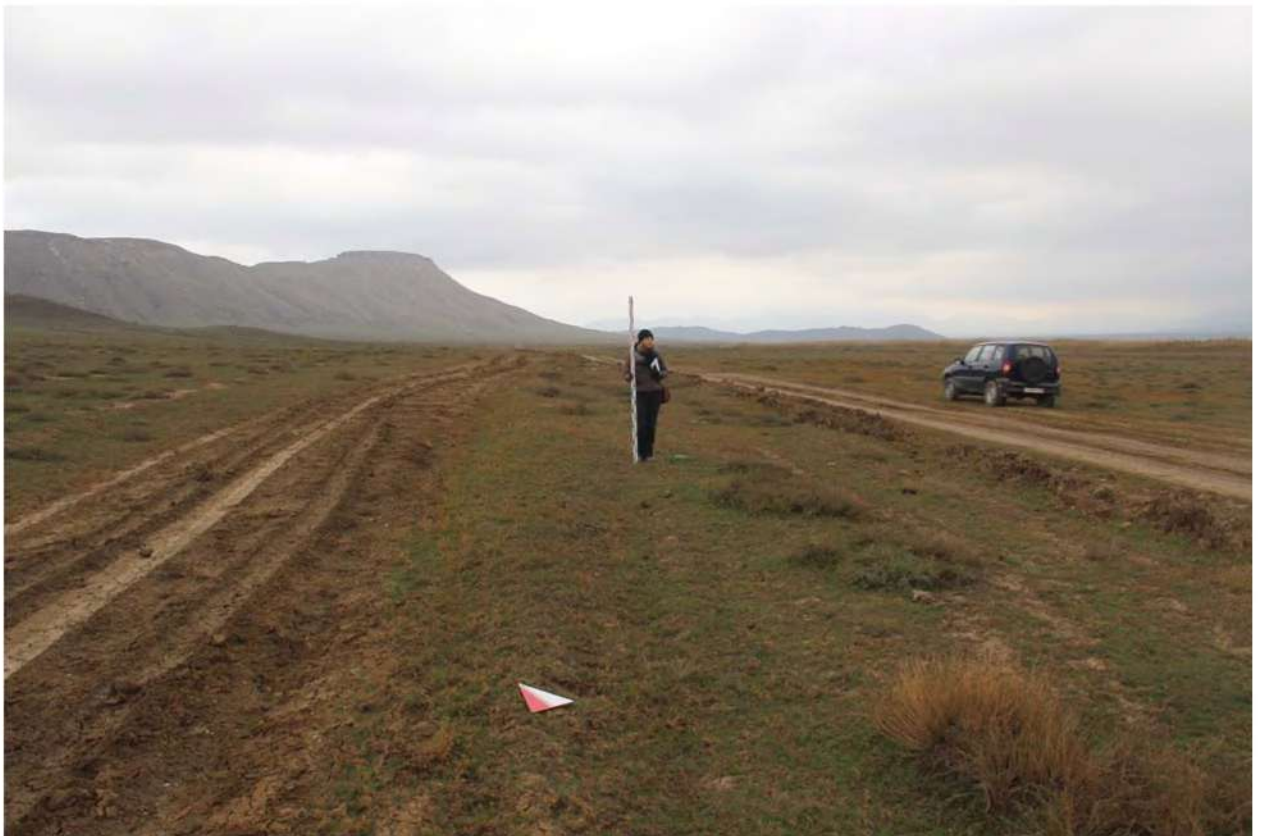
Рис. 43. Республика Дагестан. «Проектирование и строительство магистрального водовода Чиркей-Махачкала-Каспийск, Республика Дагестан». Место разбивки шурфа 17. Вид с юго-запада. Координаты точки: N 42.905393°, E 47.076789°.
