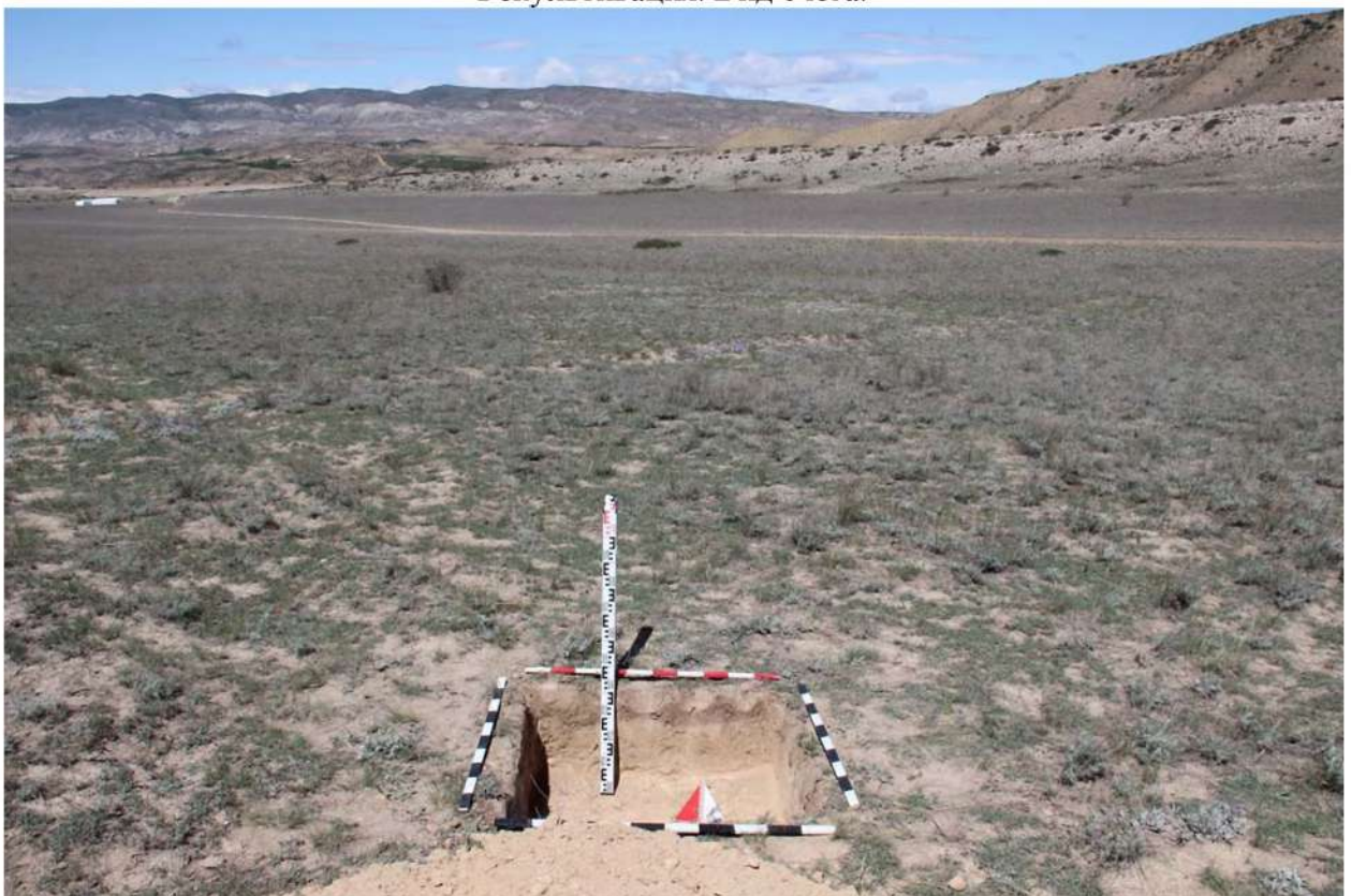
Рис. 159. Республика Дагестан. «Проектирование и строительство магистрального водовода Чиркей-Махачкала-Каспийск, Республика Дагестан». Шурф 85. Окончание земляных работ. Вид с юга.
