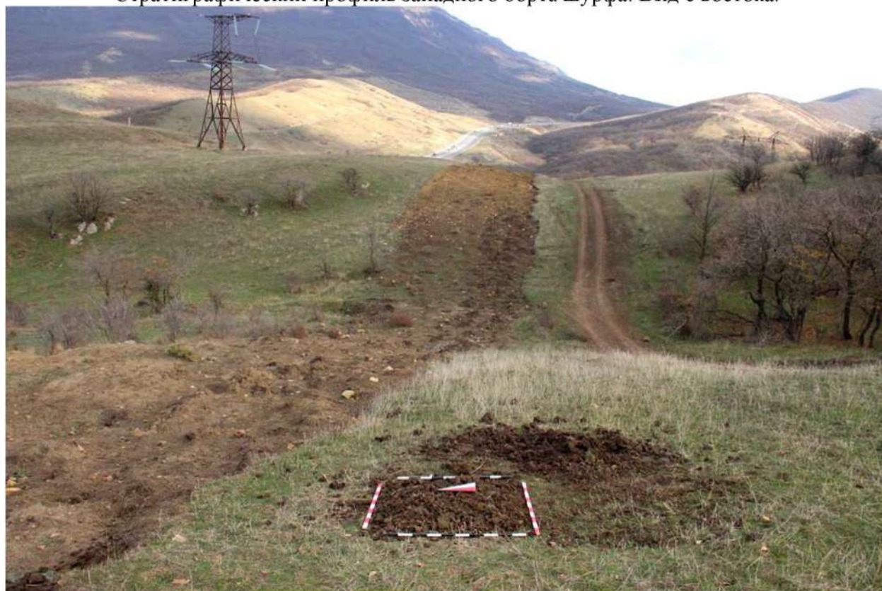
Рис. 367. Республика Дагестан. «Проектирование и строительство магистрального водовода Чиркей-Махачкала-Каспийск, Республика Дагестан». Шурф 63. Рекультивация шурфа после проведения земляных работ. Вид с запада.
