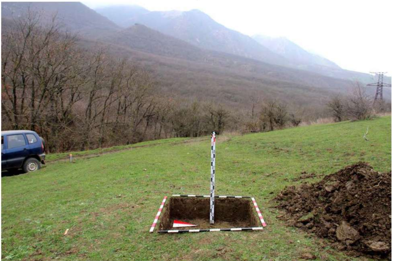
Рис. 371. Республика Дагестан. «Проектирование и строительство магистрального водовода Чиркей-Махачкала-Каспийск, Республика Дагестан». Шурф 65. Окончание земляных работ. Вид с востока.
