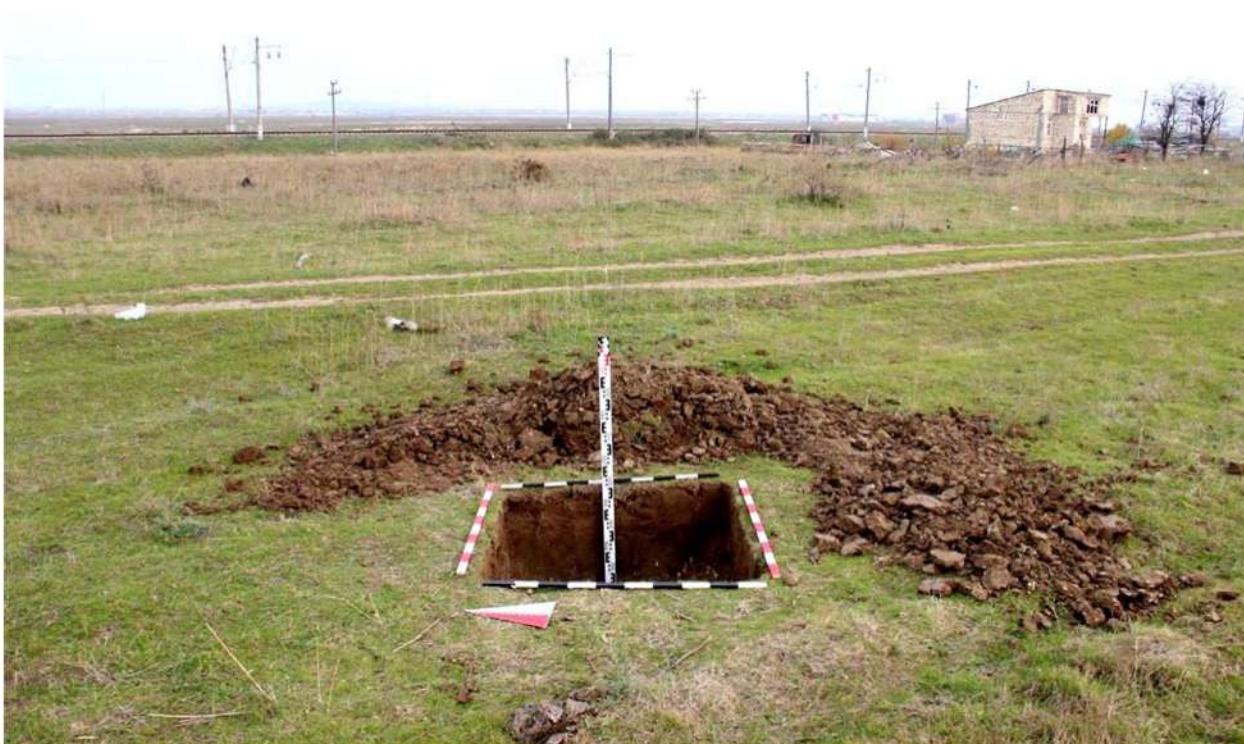
Рис. 425. Республика Дагестан. «Проектирование и строительство магистрального водовода Чиркей-Махачкала-Каспийск, Республика Дагестан». Шурф 83. Окончание земляных работ. Вид с запада.
