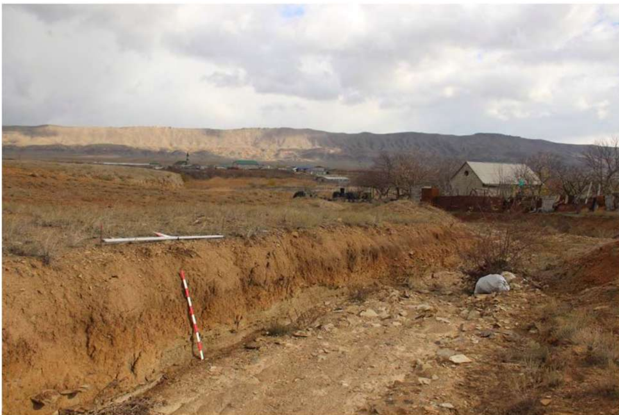
Рис. 183. Республика Дагестан. «Проектирование и строительство магистрального водовода Чиркей-Махачкала-Каспийск, Республика Дагестан». Зачистка - Шурф 6. Место разбивки шурфа до начала земляных работ. Вид с юго-запада.
