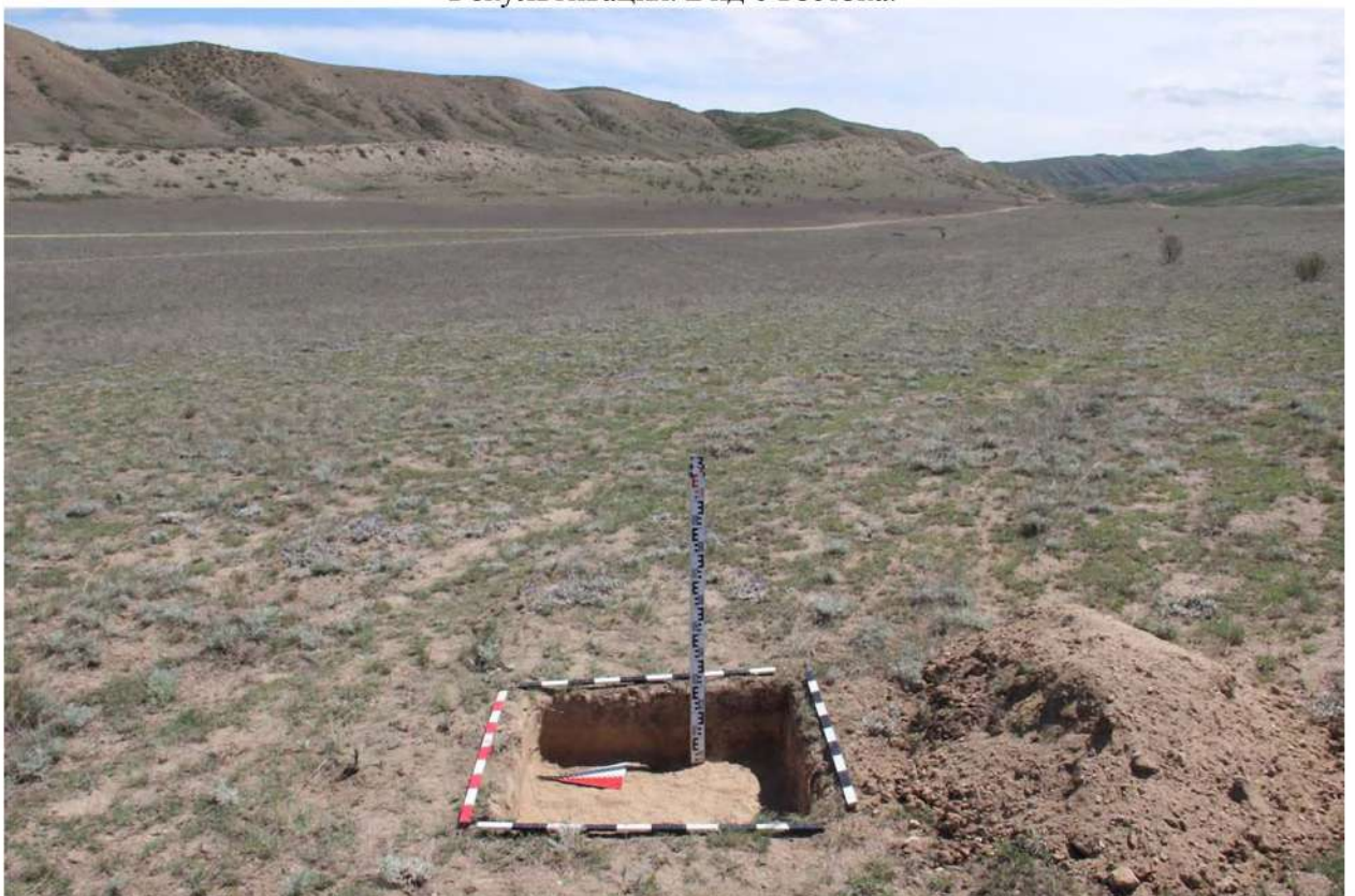
Рис. 165. Республика Дагестан. «Проектирование и строительство магистрального водовода Чиркей-Махачкала-Каспийск, Республика Дагестан». Шурф 87. Окончание земляных работ. Вид с запада.
