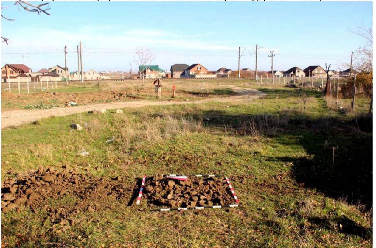
Рис. 415. Республика Дагестан. «Проектирование и строительство магистрального водовода Чиркей-Махачкала-Каспийск, Республика Дагестан». Шурф 79. Рекультивация шурфа после проведения земляных работ. Вид с запада.
