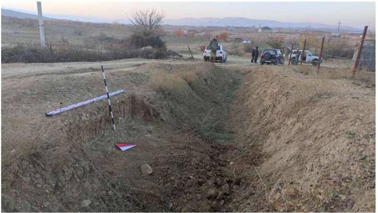
Рис. 188. Республика Дагестан. «Проектирование и строительство магистрального водовода Чиркей-Махачкала-Каспийск, Республика Дагестан». Зачистка - Шурф 8. Окончание земляных работ. Вид с востока.
