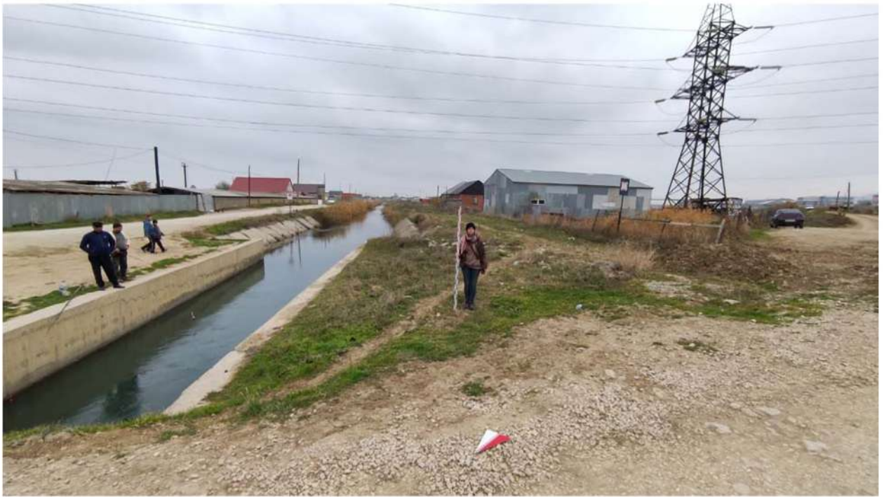
Рис. 137. Республика Дагестан. «Проектирование и строительство магистрального водовода Чиркей-Махачкала-Каспийск, Республика Дагестан». Место ответвления трассы к северу от шурфа 77 в Новом Хушете. Вид с севера.
