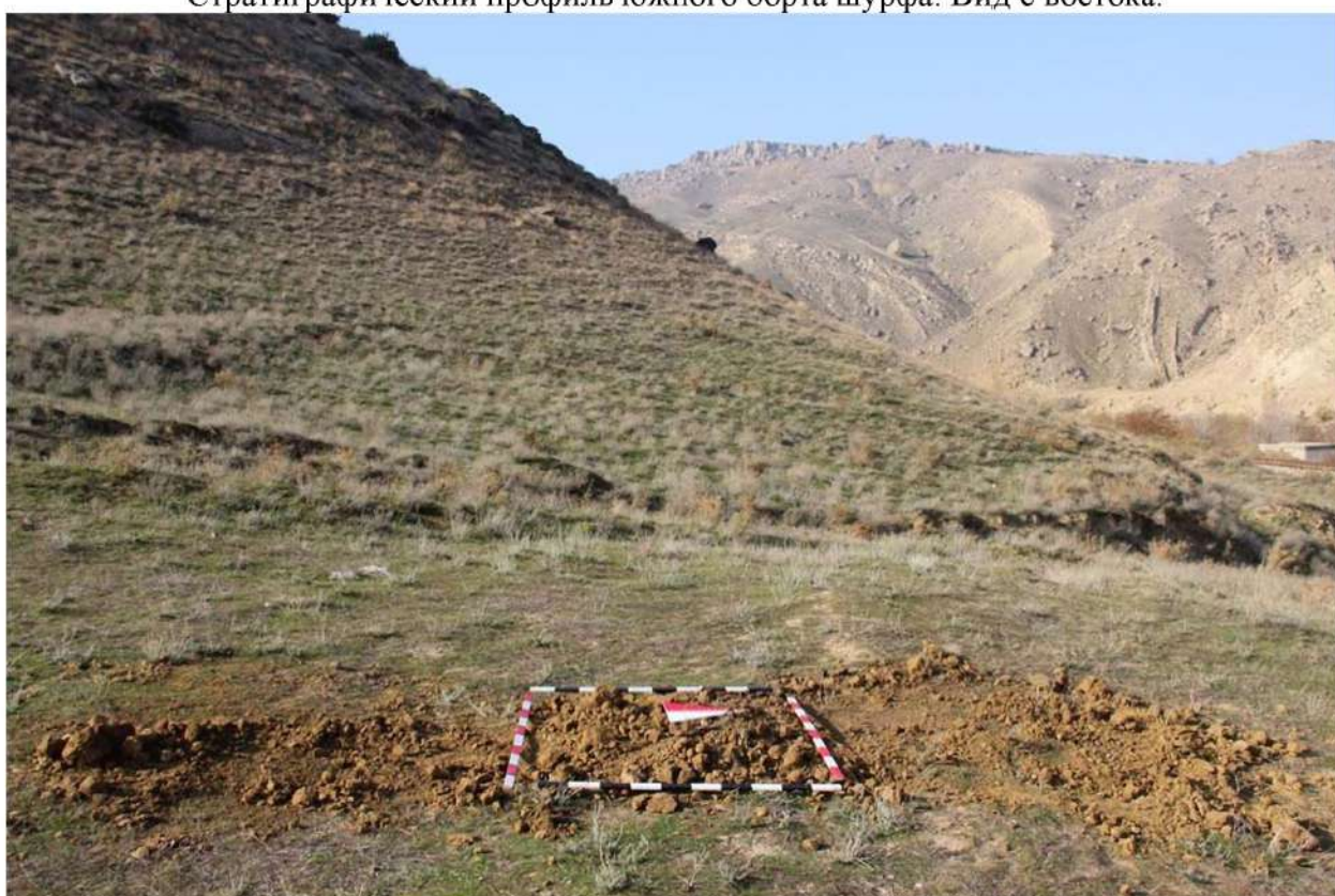
Рис. 295. Республика Дагестан. «Проектирование и строительство магистрального водовода Чиркей-Махачкала-Каспийск, Республика Дагестан». Шурф 42. Рекультивация шурфа после проведения земляных работ. Вид с востока.
