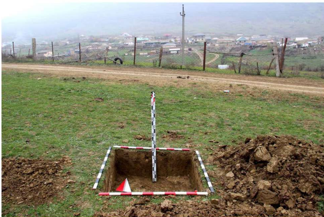
Рис. 380. Республика Дагестан. «Проектирование и строительство магистрального водовода Чиркей-Махачкала-Каспийск, Республика Дагестан». Шурф 68. Окончание земляных работ. Вид с юга.
