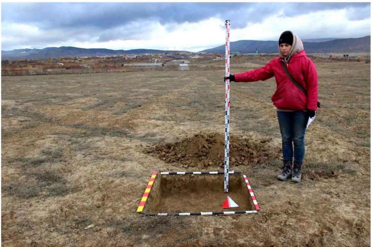
Рис. 185. Республика Дагестан. «Проектирование и строительство магистрального водовода Чиркей-Махачкала-Каспийск, Республика Дагестан». Шурф 7. Окончание земляных работ. Вид с юга.
