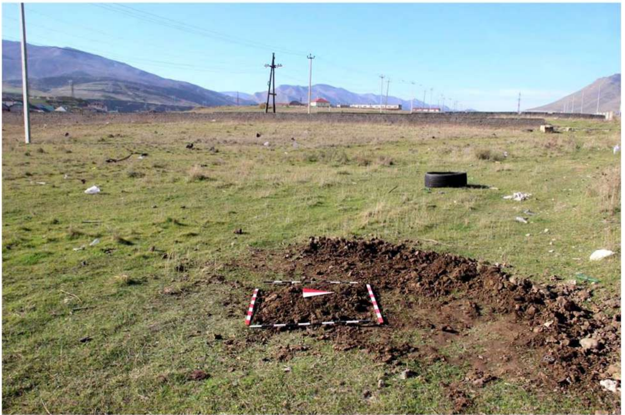
Рис. 406. Республика Дагестан. «Проектирование и строительство магистрального водовода Чиркей-Махачкала-Каспийск, Республика Дагестан». Шурф 76. Рекультивация шурфа после проведения земляных работ. Вид с востока.
