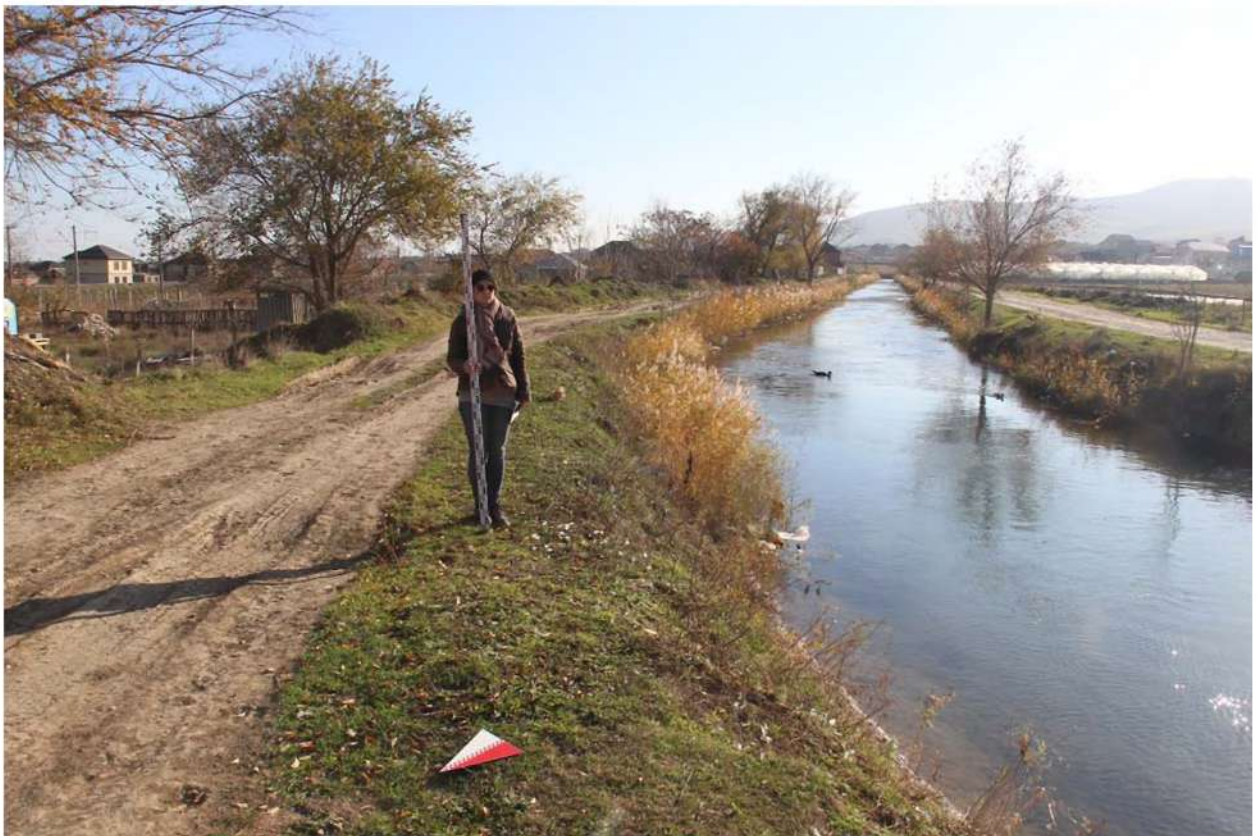
Рис. 145. Республика Дагестан. «Проектирование и строительство магистрального водовода Чиркей-Махачкала-Каспийск, Республика Дагестан». Место разбивки шурфа 79. Вид с северо-запада. Координаты точки: N 42.884598°, E 47.554788°.
