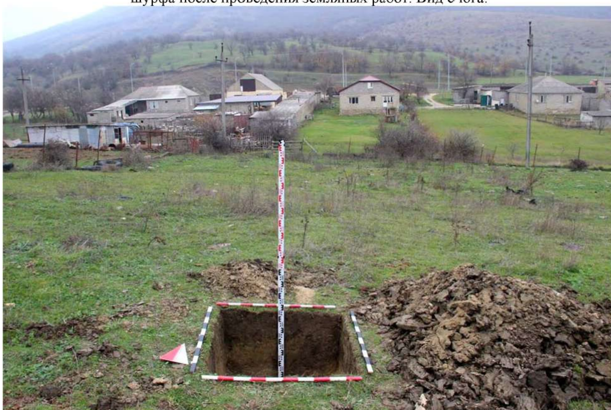
Рис. 377. Республика Дагестан. «Проектирование и строительство магистрального водовода Чиркей-Махачкала-Каспийск, Республика Дагестан». Шурф 67. Окончание земляных работ. Вид с юга.
