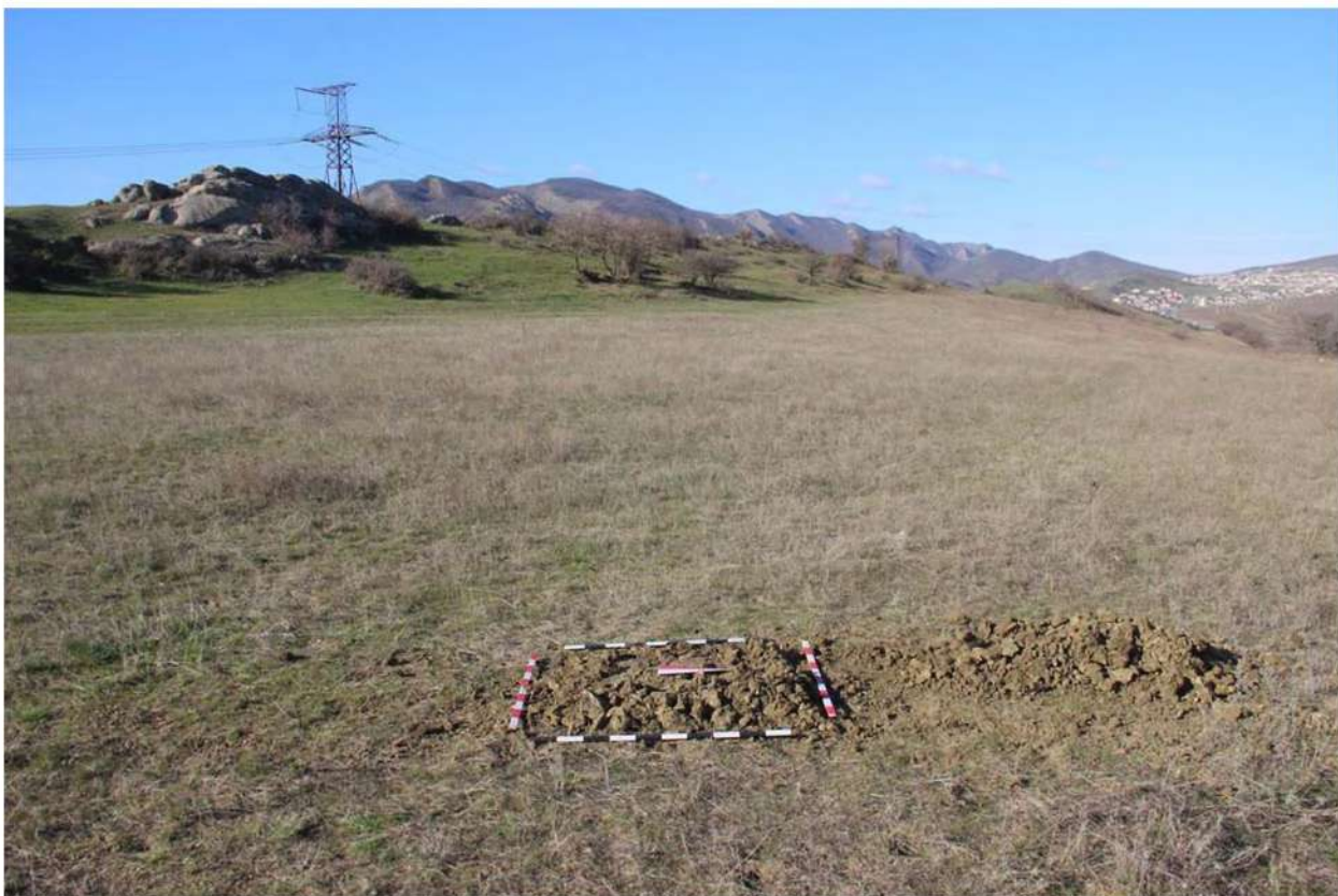
Рис. 394. Республика Дагестан. «Проектирование и строительство магистрального водовода Чиркей-Махачкала-Каспийск, Республика Дагестан». Шурф 72. Рекультивация шурфа после проведения земляных работ. Вид с востока.
