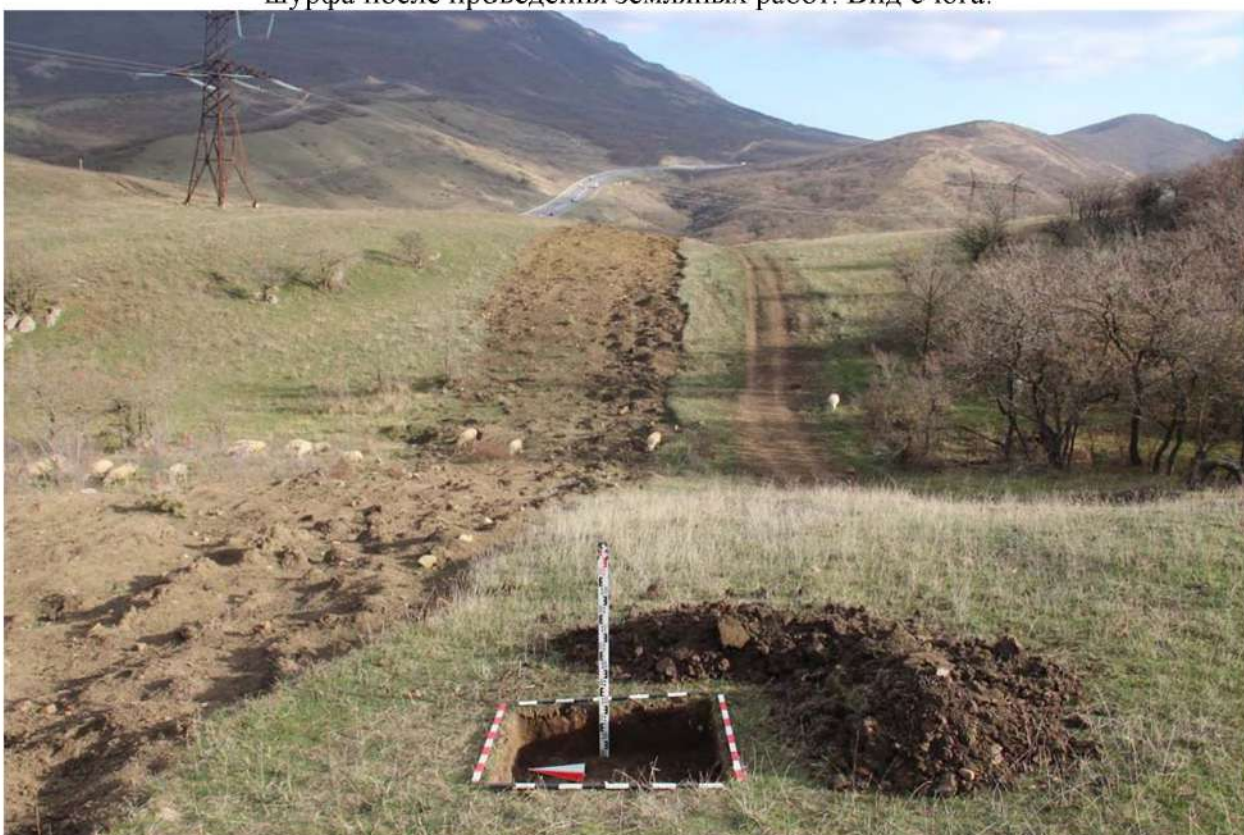
Рис. 365. Республика Дагестан. «Проектирование и строительство магистрального водовода Чиркей-Махачкала-Каспийск, Республика Дагестан». Шурф 63. Окончание земляных работ. Вид с запада.
