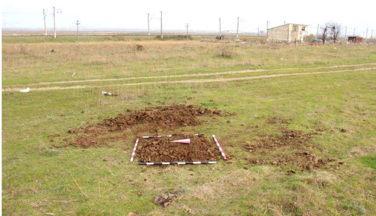
Рис.427. Республика Дагестан. «Проектирование и строительство магистрального водовода Чиркей-Махачкала-Каспийск, Республика Дагестан». Шурф 83. Рекультивация шурфа после проведения земляных работ. Вид с запада.
