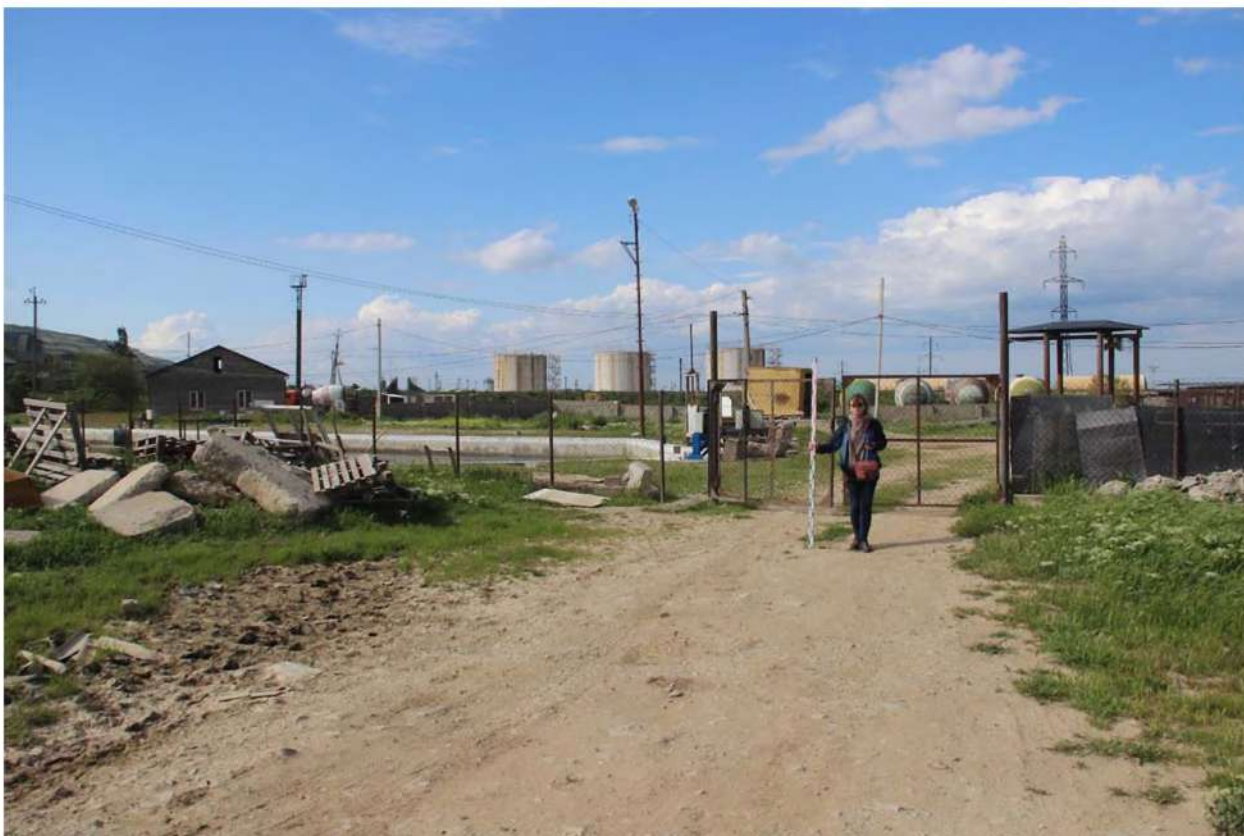
Рис. 141. Республика Дагестан. «Проектирование и строительство магистрального водовода Чиркей-Махачкала-Каспийск, Республика Дагестан». Место ответвления трассы к северу от шурфа 77 в Новом Хушете. Вид с юга.
