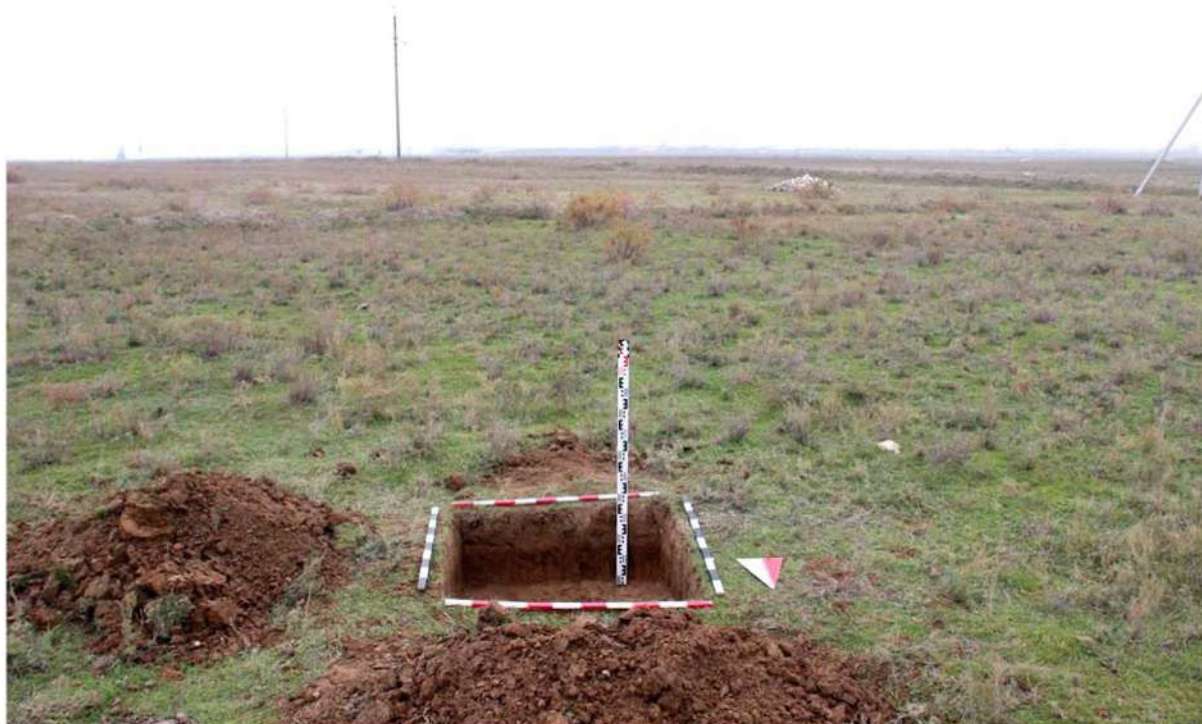
Рис. 428. Республика Дагестан. «Проектирование и строительство магистрального водовода Чиркей-Махачкала-Каспийск, Республика Дагестан». Шурф 84. Окончание земляных работ. Вид с севера.
