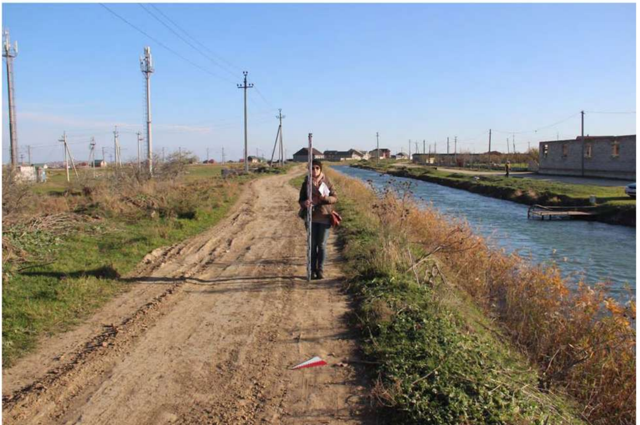
Рис. 148. Республика Дагестан. «Проектирование и строительство магистрального водовода Чиркей-Махачкала-Каспийск, Республика Дагестан». Место разбивки шурфа 81. Вид с северо-запада. Координаты точки: N 42.870844°, E 47.569887°.
