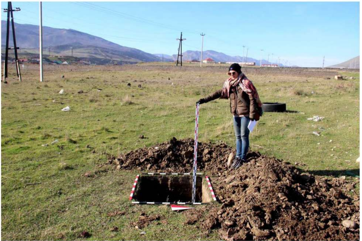
Рис. 404. Республика Дагестан. «Проектирование и строительство магистрального водовода Чиркей-Махачкала-Каспийск, Республика Дагестан». Шурф 76. Окончание земляных работ. Вид с востока.
