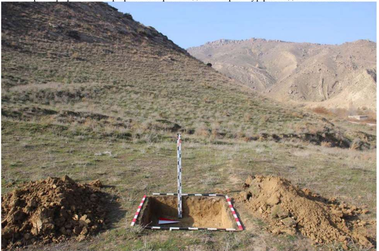
Рис. 293. Республика Дагестан. «Проектирование и строительство магистрального водовода Чиркей-Махачкала-Каспийск, Республика Дагестан». Шурф 42. Окончание земляных работ. Вид с востока.
