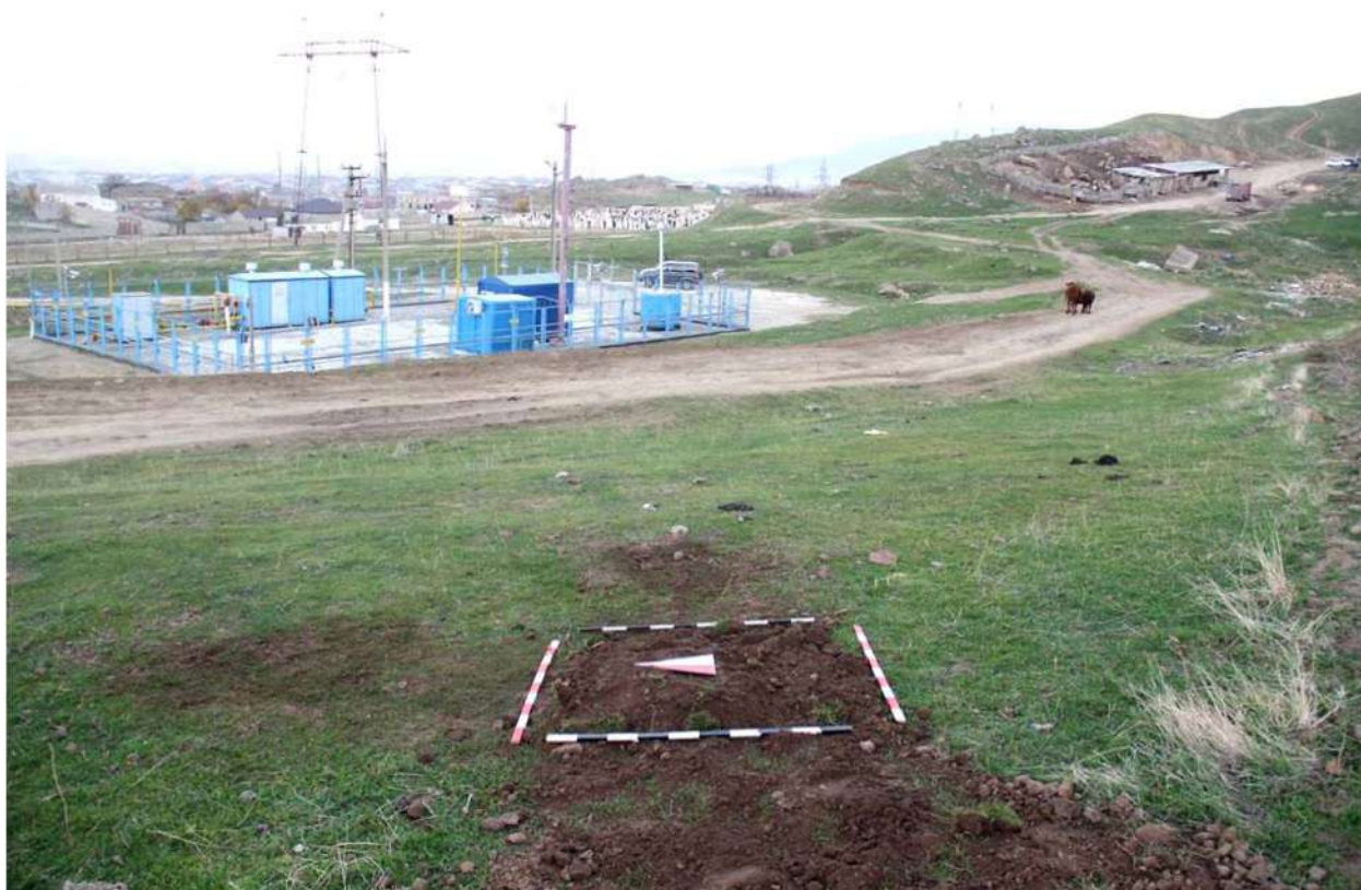
Рис. 345. Республика Дагестан. «Проектирование и строительство магистрального водовода Чиркей-Махачкала-Каспийск, Республика Дагестан». Шурф 57. Рекультивация шурфа после проведения земляных работ. Вид с запада.
