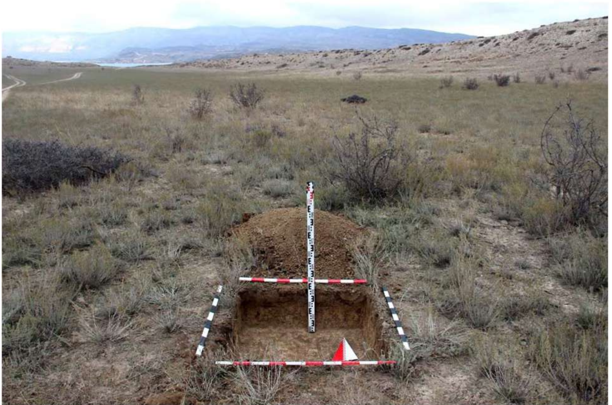
Рис. 156. Республика Дагестан. «Проектирование и строительство магистрального водовода Чиркей-Махачкала-Каспийск, Республика Дагестан». Шурф 2. Окончание земляных работ. Вид с юга.
