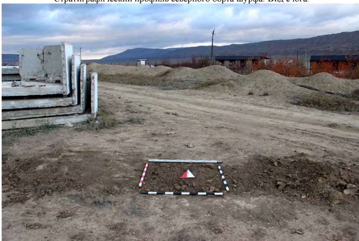
Рис. 193. Республика Дагестан. «Проектирование и строительство магистрального водовода Чиркей-Махачкала-Каспийск, Республика Дагестан». Шурф 10. Рекультивация шурфа после проведения земляных работ. Вид с юга.
