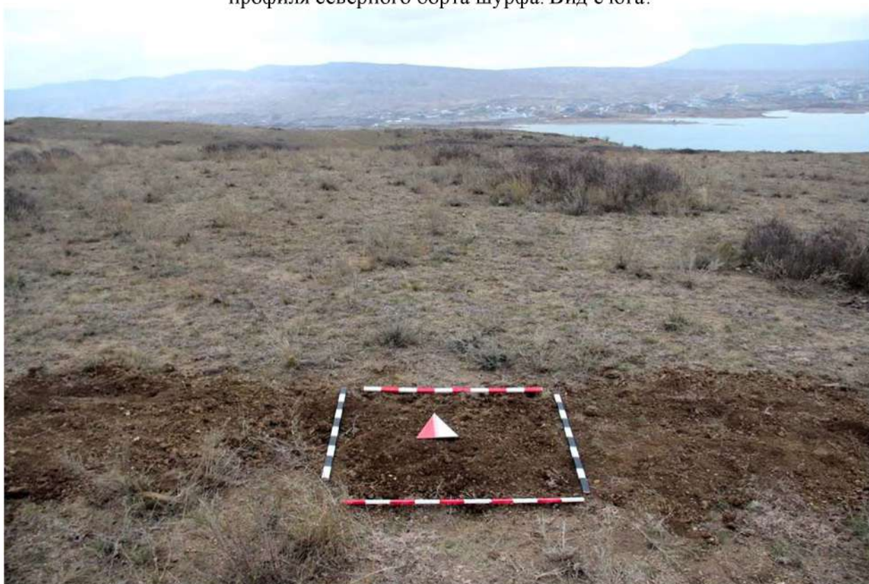
Рис. 173. Республика Дагестан. «Проектирование и строительство магистрального водовода Чиркей-Махачкала-Каспийск, Республика Дагестан». Шурф 3. Рекультивация шурфа после проведения земляных работ. Вид с юга
