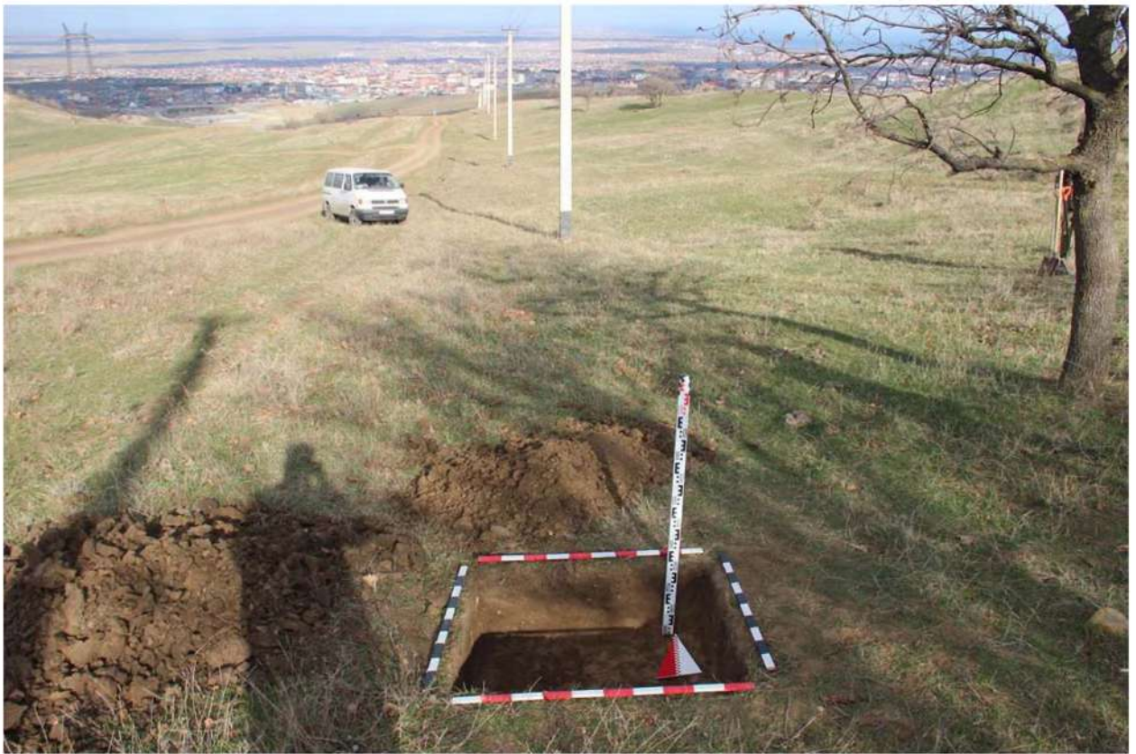
Рис. 362. Республика Дагестан. «Проектирование и строительство магистрального водовода Чиркей-Махачкала-Каспийск, Республика Дагестан». Шурф 62. Окончание земляных работ. Вид с юга.
