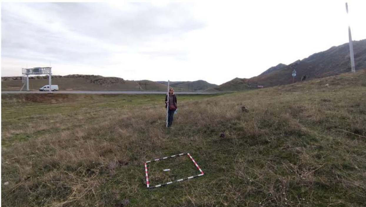
Рис. 109. Республика Дагестан. «Проектирование и строительство магистрального водовода Чиркей-Махачкала-Каспийск, Республика Дагестан». Место разбивки шурфа 59 до начала земляных работ. Вид с запада на подъем трассы из Махачкалы в Буйнакск. Координаты точки: N 42.956006°, E 47.366375°.
