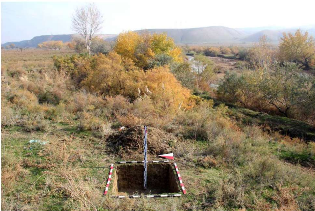
Рис. 296. Республика Дагестан. «Проектирование и строительство магистрального водовода Чиркей-Махачкала-Каспийск, Республика Дагестан». Шурф 43. Окончание земляных работ. Вид с запада.
