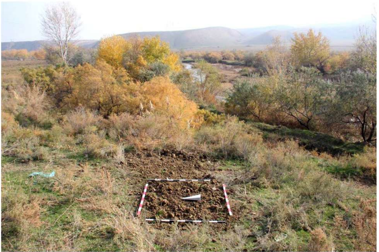
Рис. 298. Республика Дагестан. «Проектирование и строительство магистрального водовода Чиркей-Махачкала-Каспийск, Республика Дагестан». Шурф 43. Рекультивация шурфа после проведения земляных работ. Вид с запада.
