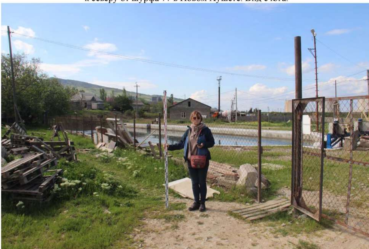
Рис. 142. Республика Дагестан. «Проектирование и строительство магистрального водовода Чиркей-Махачкала-Каспийск, Республика Дагестан». Место ответвления трассы к северу от шурфа 77 в Новом Хушете. Вид с юга.
