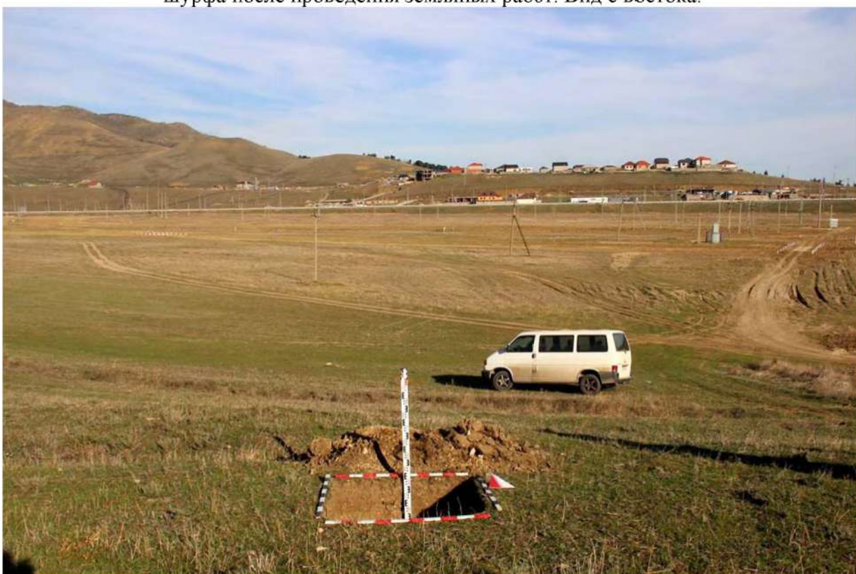
Рис. 395. Республика Дагестан. «Проектирование и строительство магистрального водовода Чиркей-Махачкала-Каспийск, Республика Дагестан». Шурф 73. Окончание земляных работ. Вид с юга.
