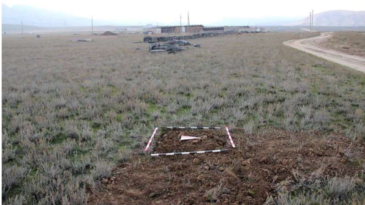
Рис. 313. Республика Дагестан. «Проектирование и строительство магистрального водовода Чиркей-Махачкала-Каспийск, Республика Дагестан». Шурф 48. Рекультивация шурфа после проведения земляных работ. Вид с востока.
