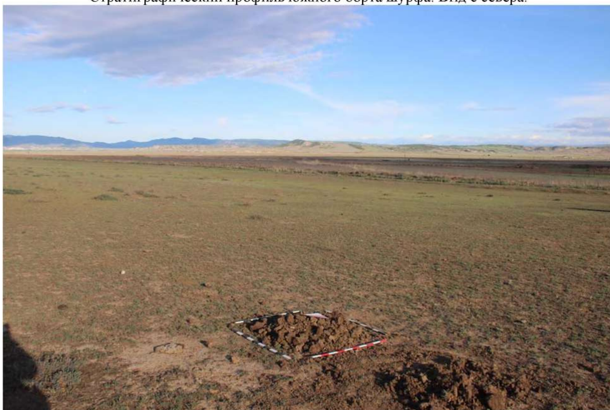
Рис. 215. Республика Дагестан. «Проектирование и строительство магистрального водовода Чиркей-Махачкала-Каспийск, Республика Дагестан». Шурф 16. Рекультивация шурфа после проведения земляных работ. Вид с северо-запада.
