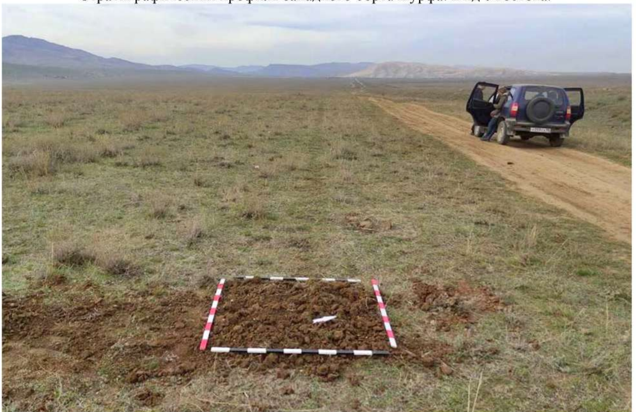
Рис. 319. Республика Дагестан. «Проектирование и строительство магистрального водовода Чиркей-Махачкала-Каспийск, Республика Дагестан». Шурф 50. Рекультивация шурфа после проведения земляных работ. Вид с востока.
