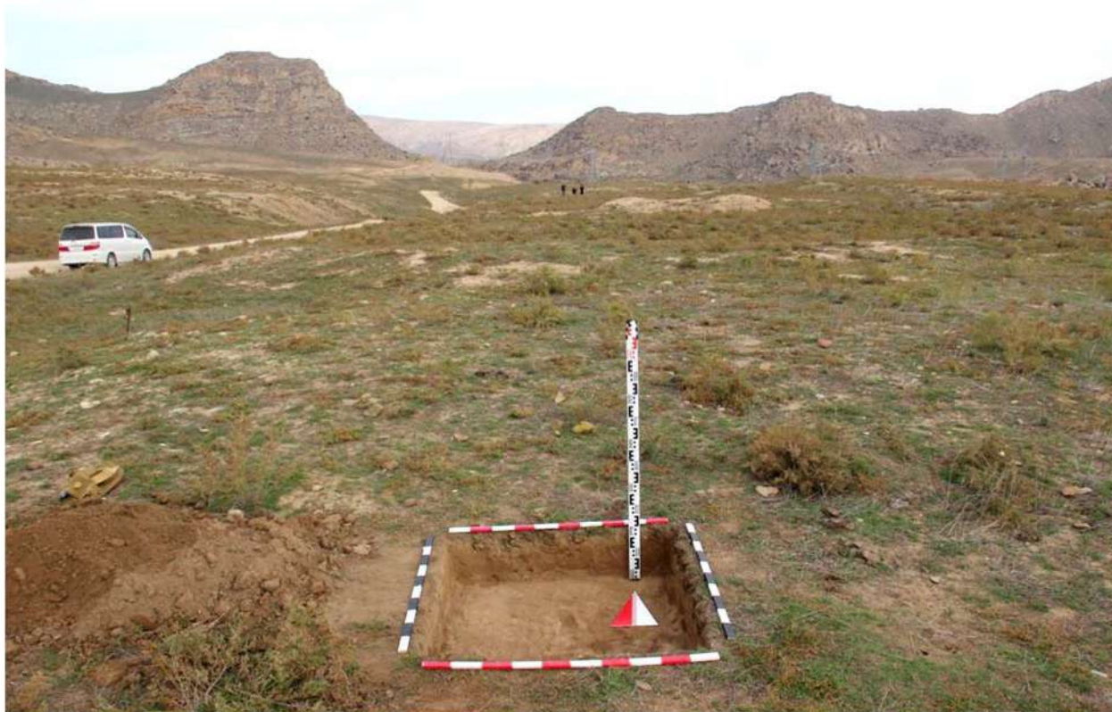
Рис. 264. Республика Дагестан. «Проектирование и строительство магистрального водовода Чиркей-Махачкала-Каспийск, Республика Дагестан». Шурф 33. Окончание земляных работ. Вид с юга.
