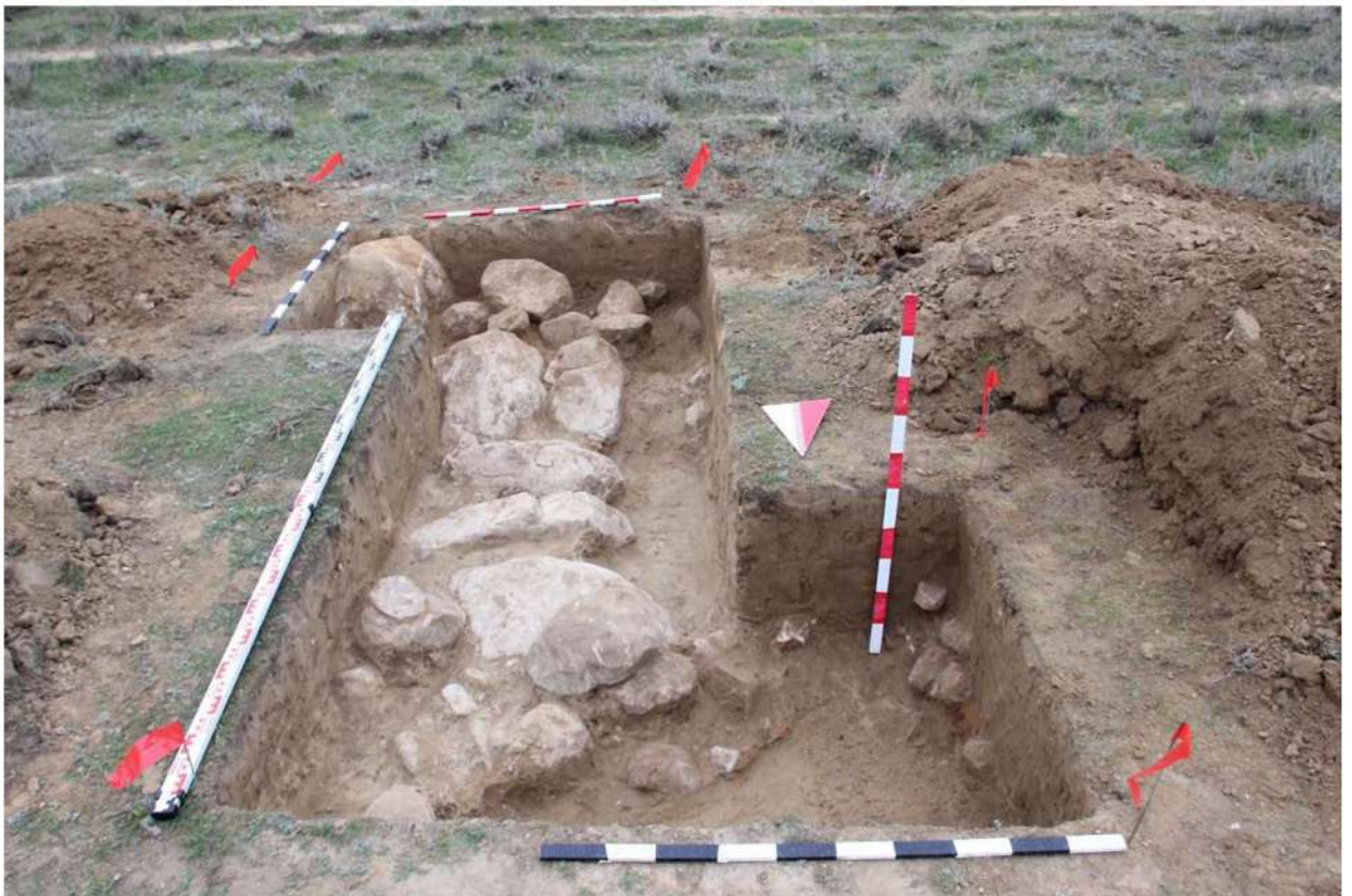
Рис. 458. Республика Дагестан. «Проектирование и строительство магистрального водовода Чиркей-Махачкала-Каспийск, Республика Дагестан». Вид с севера на объект шурфа 53 в зоне проектируемой трассы. Координаты: N 42.97841°, E 47.31332°.
