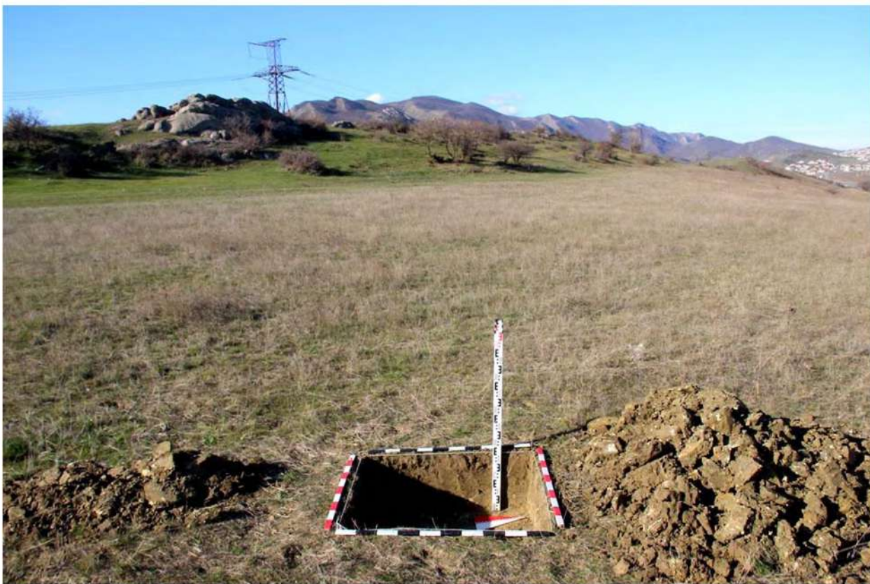
Рис. 392. Республика Дагестан. «Проектирование и строительство магистрального водовода Чиркей-Махачкала-Каспийск, Республика Дагестан». Шурф 72. Окончание земляных работ. Вид с востока.
