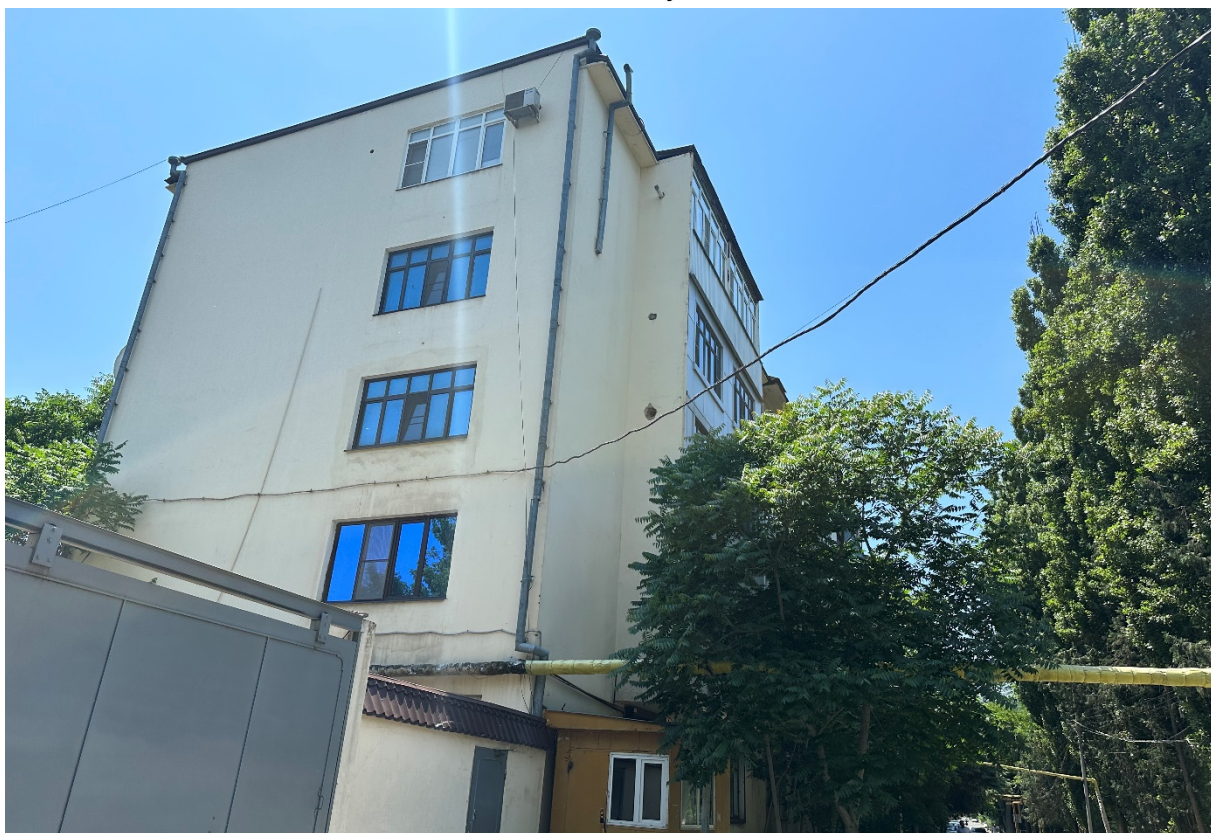
Фото 4. Торцевой фасад здания с ул. Умаханова.
