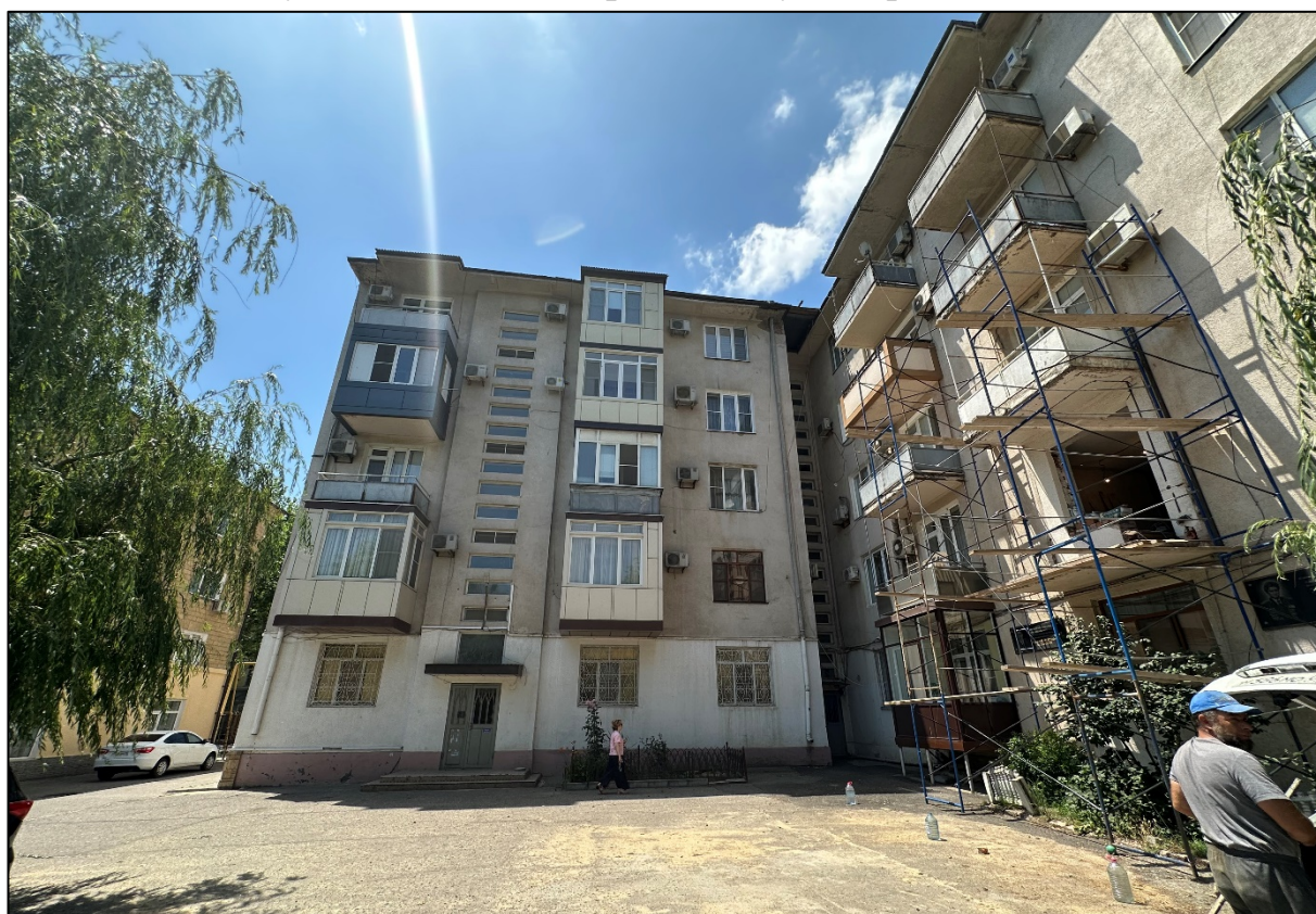
Фото 8. Дворовой фасад здания.
