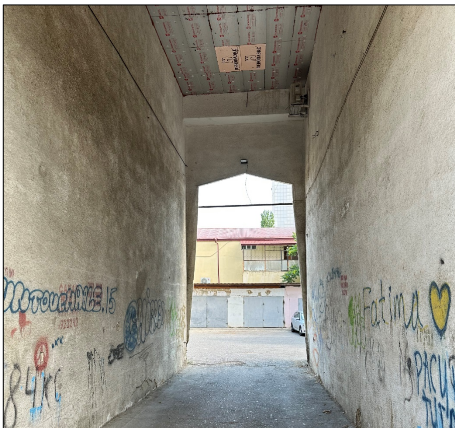
Фото 7. Сквозной проезд через здание в уровне первого этажа.
