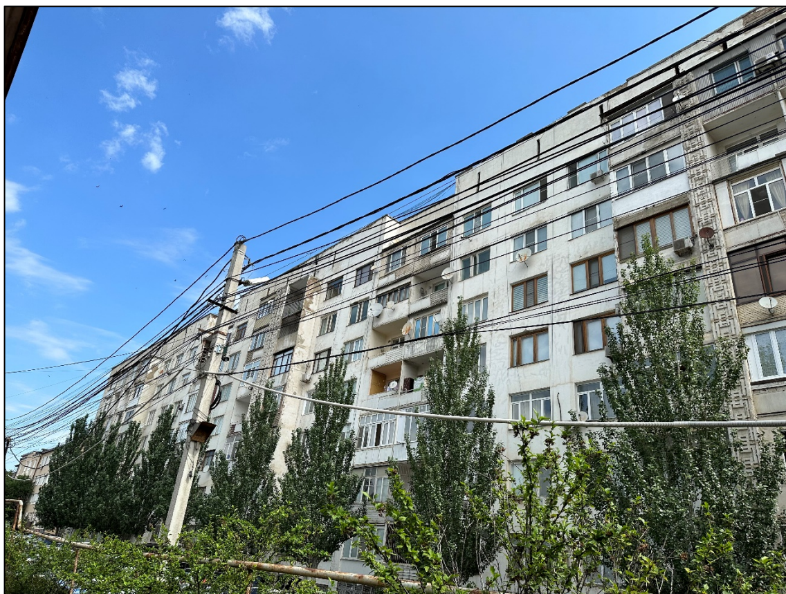
Фото 2. Общий вид здания с ул. Оскара.
