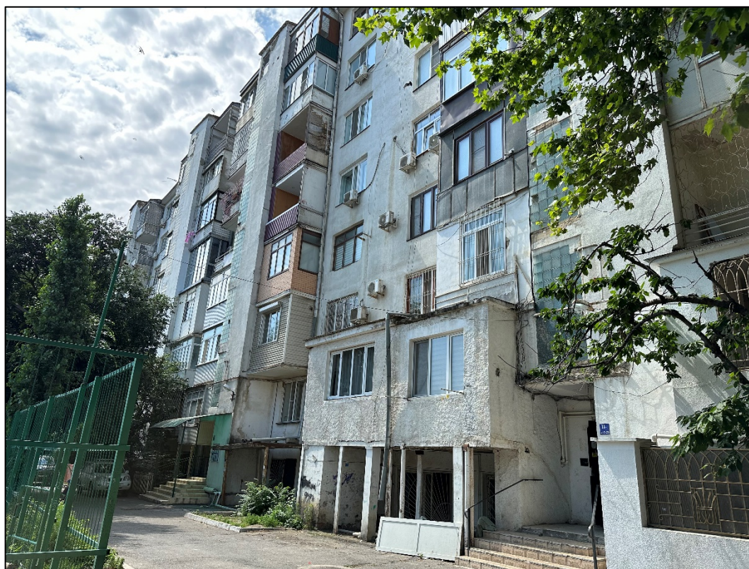
Фото 9. Общий вид на дворовое пространство исследуемого объекта, пристройки по первому этажу.
