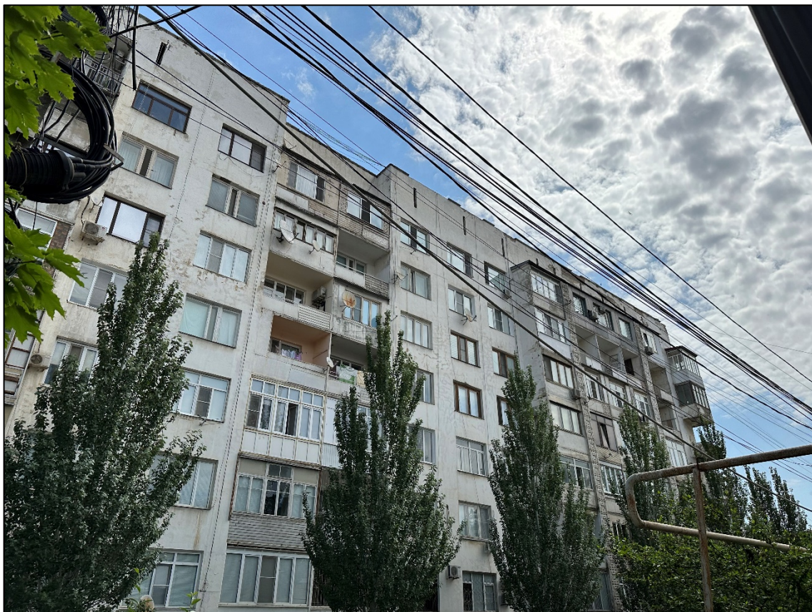
Фото 4. Общий вид здания по ул. Оскара, центральная ось здания.
