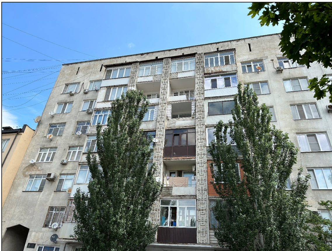
Фото 5. Часть фасада по ул. Оскара (северо-западное направление), балконный блок.
