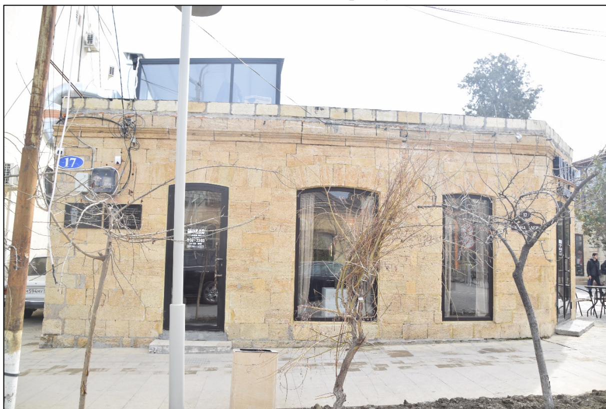
Фото 2. Вид северного фасада здания по ул. Канделаки.
