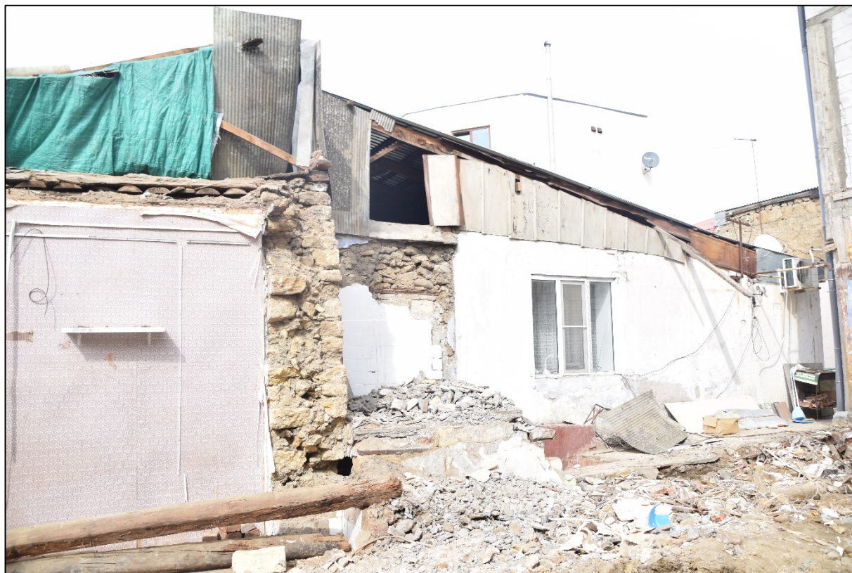
Фото 6. Вид на дворовой фасад здания, часть несохранившихся помещений.
