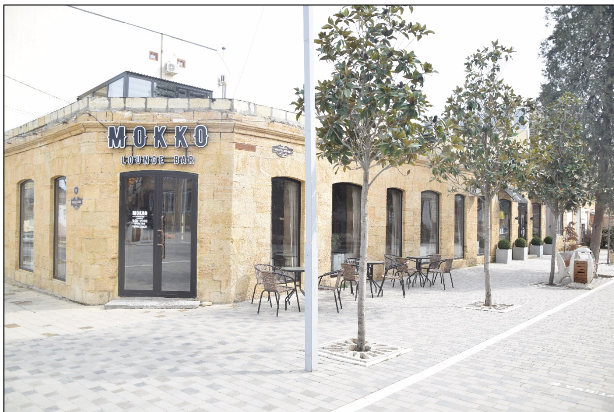
Фото 4. Вид на западный фасад здания по ул. Казы-Бека, главный и дополнительные входы в здание.
