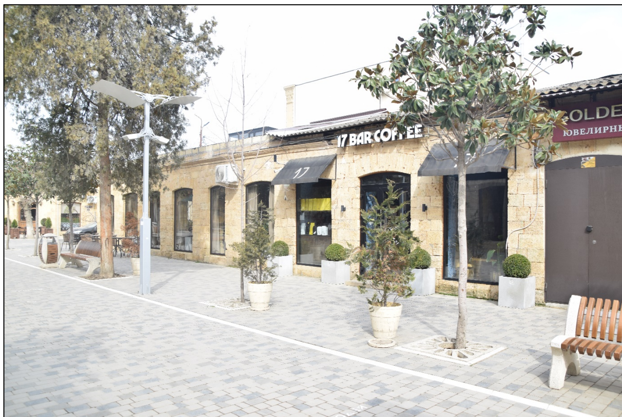
Фото 7. Вид на западный фасад здания с ул. Кази-Бека, вид в условиях градостроительной среды.
