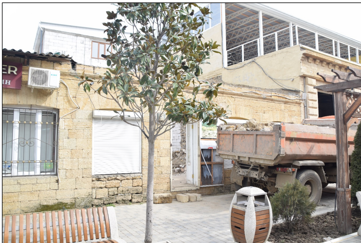
Фото 5. Вид на западный фасад здания с ул. Казы-Бека, несохранившиеся оконные проемы и часть отсутствующих внутренних помещений.
