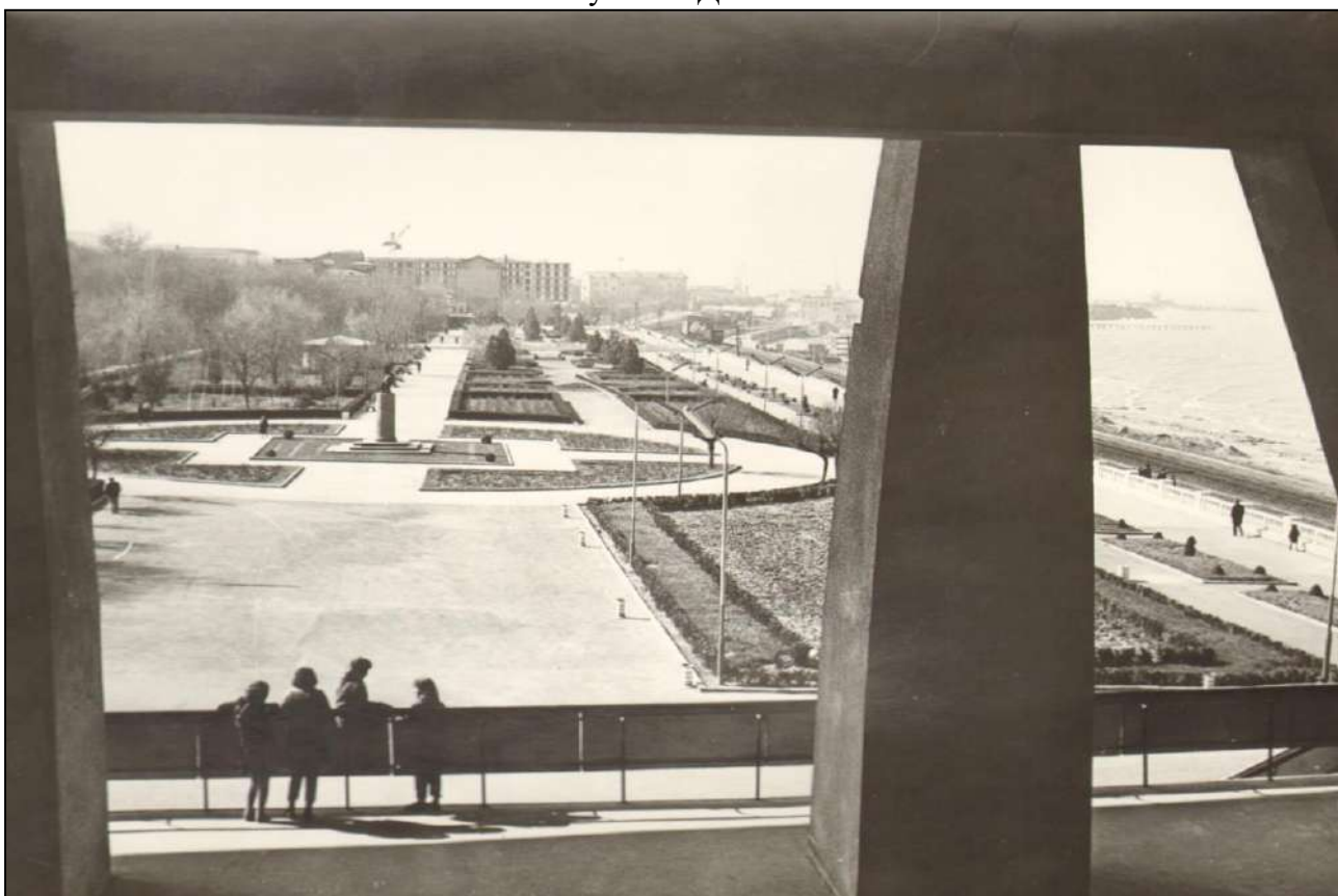
Вид на бульвар с террасы здания музыкально-драматического театра. Источник: Центральный государственный архив Республики Дагестан
