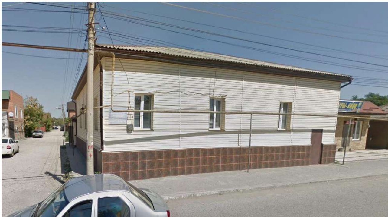
Фото 2. Фото Объекта на август 2019 года.
