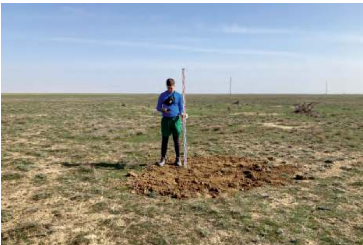
Илл. 250. Республика Дагестан, Ногайский район. Земельный участок с кадастровым номером 03:03:000000:898 , предназначенный для строительства «Чолпанской СЭС». Шурф 53 после рекультивации. Общий вид с Ю.
