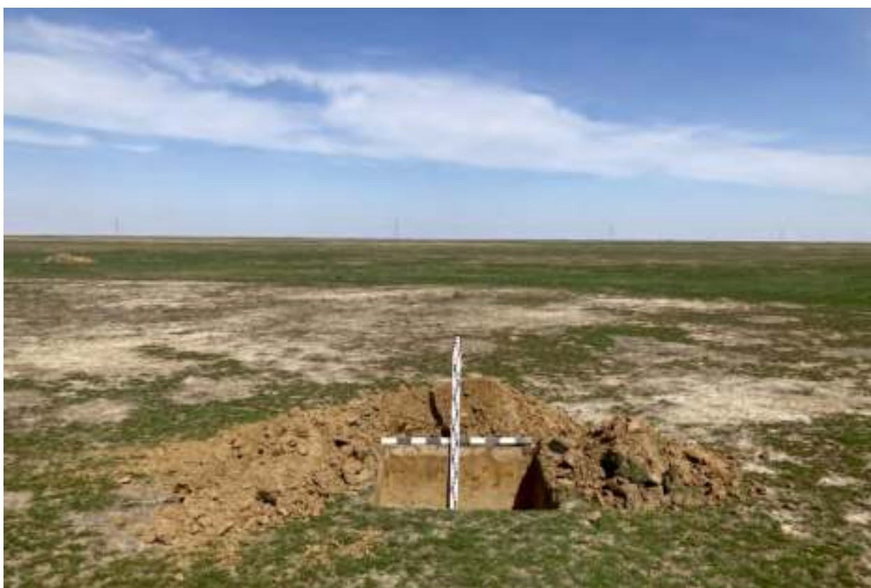
Илл. 628. Республика Дагестан, Ногайский район. Земельный участок с кадастровым номером 03:03:000000:898 , предназначенный для строительства «Чолпанской СЭС». Шурф 148. Общий вид с Ю.
