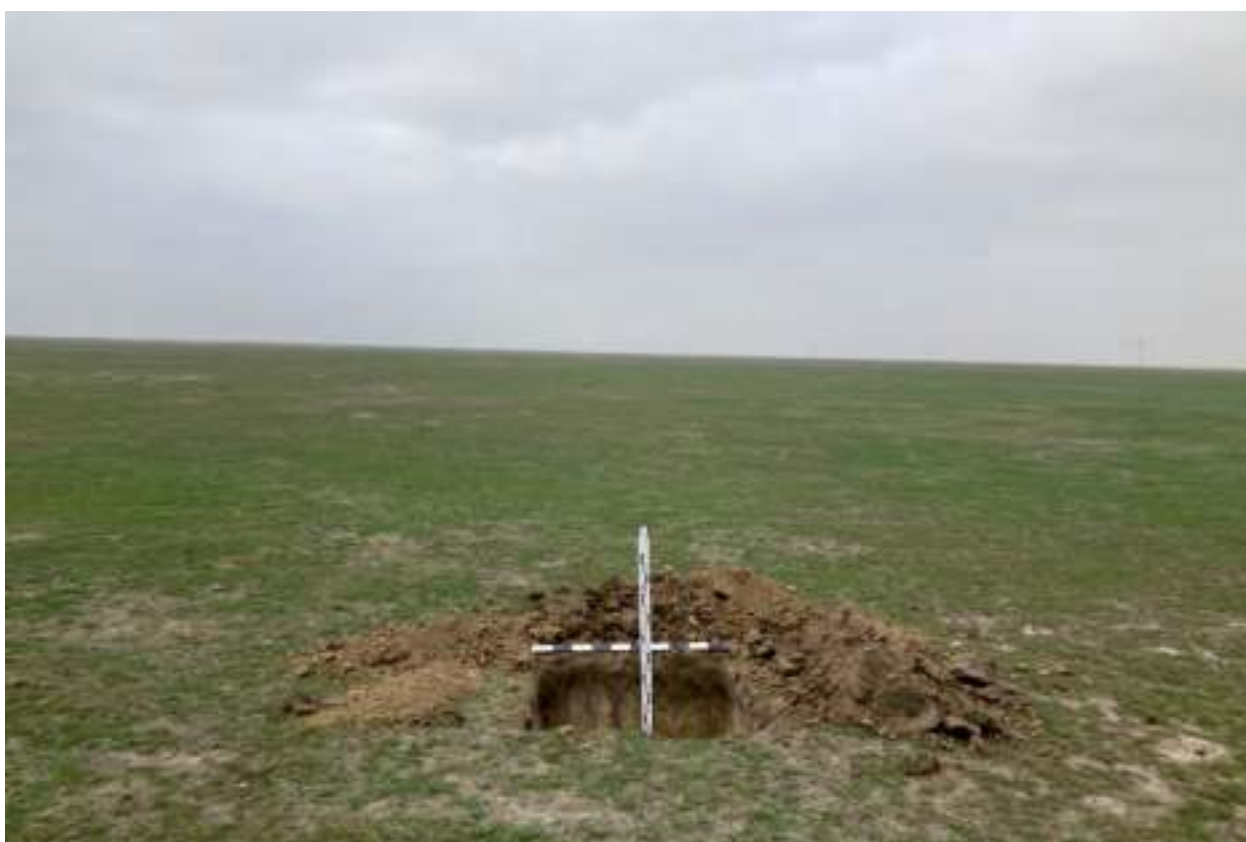
Илл. 224. Республика Дагестан, Ногайский район. Земельный участок с кадастровым номером 03:03:000000:898 , предназначенный для строительства «Чолпанской СЭС». Шурф 47. Общий вид с Ю.
