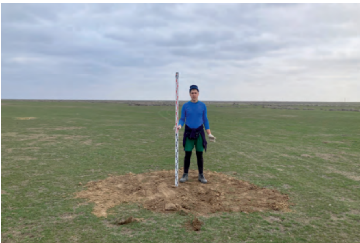
Илл. 206. Республика Дагестан, Ногайский район. Земельный участок с кадастровым номером 03:03:000000:898 , предназначенный для строительства «Чолпанской СЭС». Шурф 42 после рекультивации. Общий вид с Ю.
