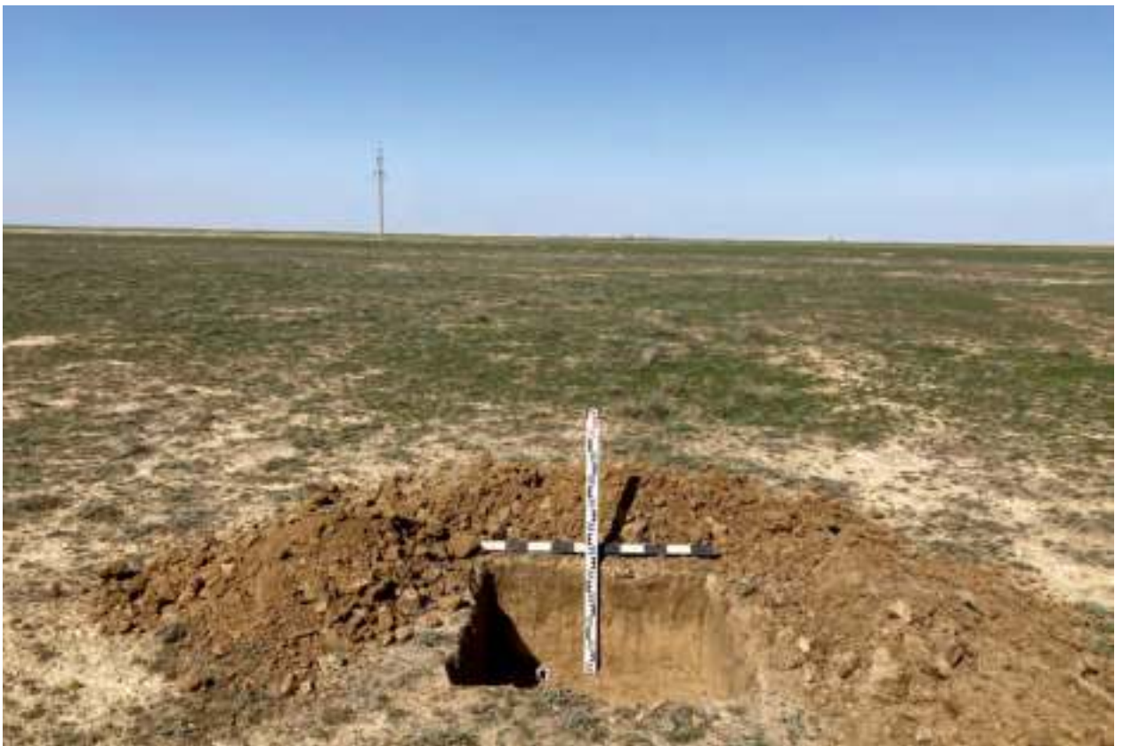
Илл. 252. Республика Дагестан, Ногайский район. Земельный участок с кадастровым номером 03:03:000000:898 , предназначенный для строительства «Чолпанской СЭС». Шурф 54. Общий вид с Ю.
