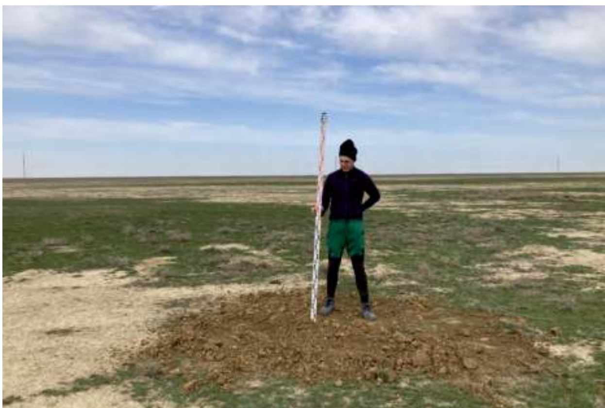
Илл. 578. Республика Дагестан, Ногайский район. Земельный участок с кадастровым номером 03:03:000000:898 , предназначенный для строительства «Чолпанской СЭС». Шурф 135 после рекультивации. Общий вид с Ю.
