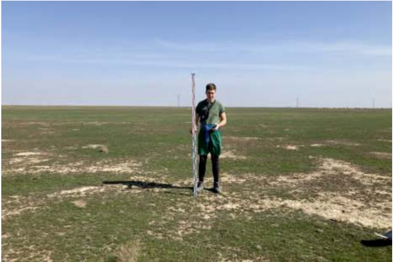
Илл. 423. Республика Дагестан, Ногайский район. Земельный участок с кадастровым номером 03:03:000000:898 , предназначенный для строительства «Чолпанской СЭС». Шурф 97 до начала работ. Вид с Ю.
