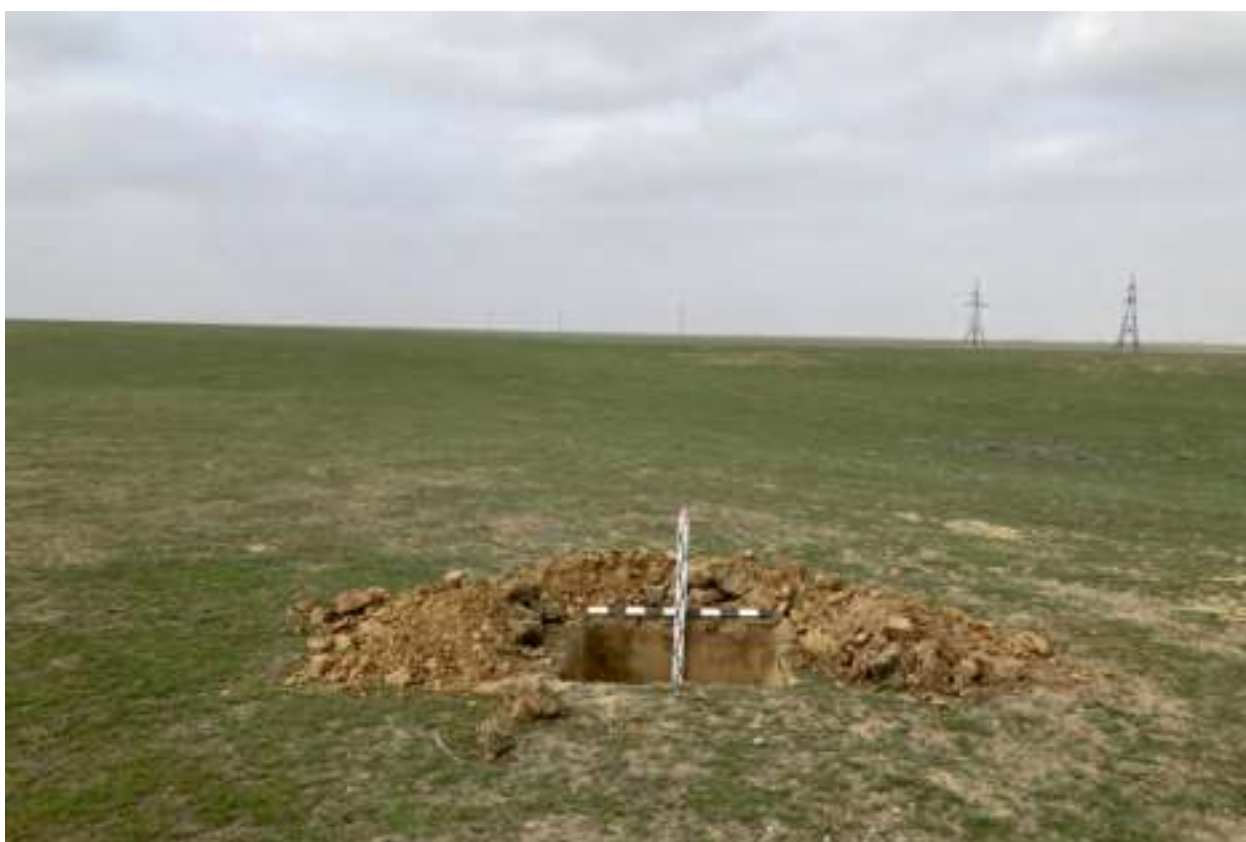
Илл. 332. Республика Дагестан, Ногайский район. Земельный участок с кадастровым номером 03:03:000000:898 , предназначенный для строительства «Чолпанской СЭС». Шурф 74. Общий вид с Ю.
