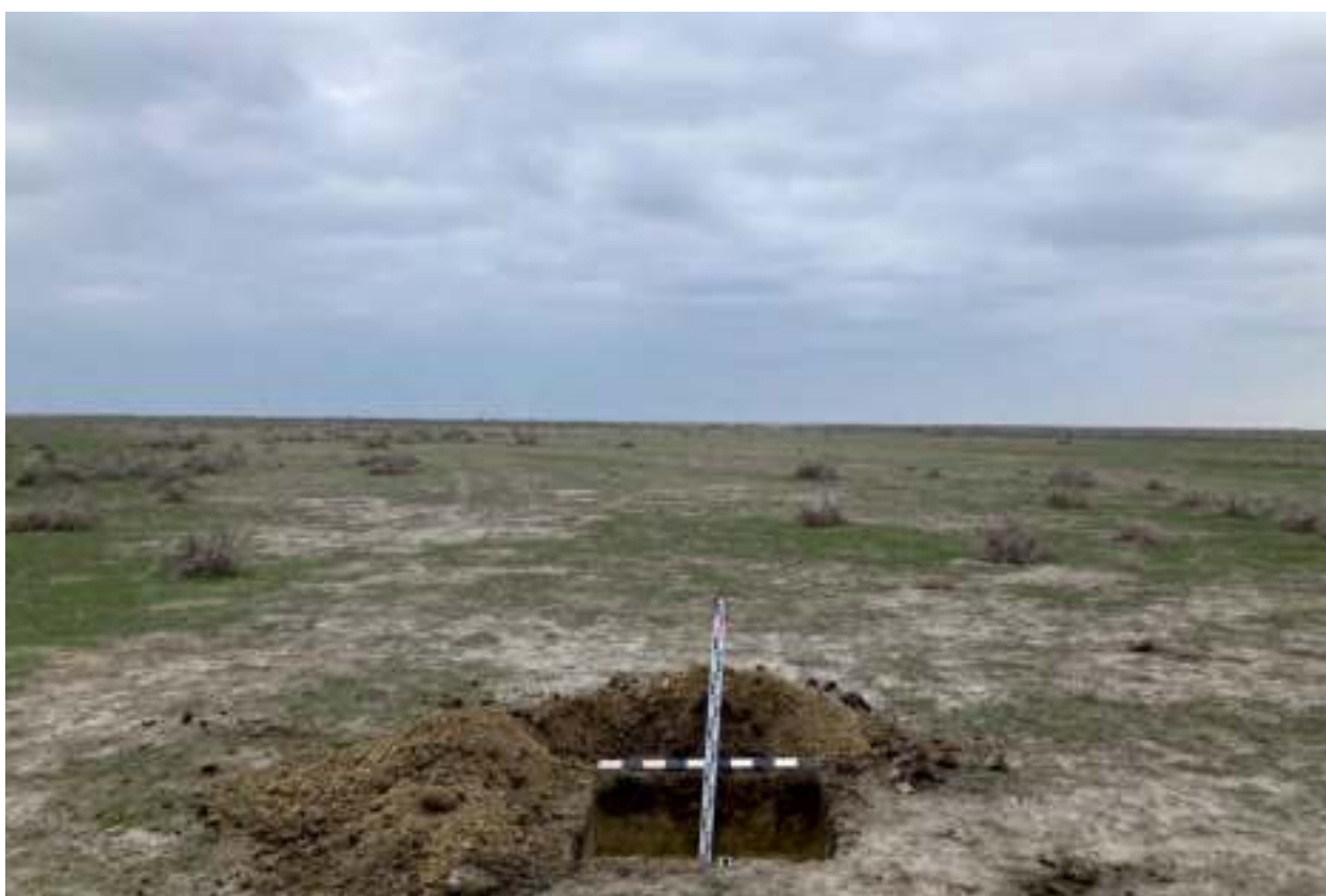
Илл. 60. Республика Дагестан, Ногайский район. Земельный участок с кадастровым номером 03:03:000000:898 , предназначенный для строительства «Чолпанской СЭС». Шурф 6. Общий вид с З.
