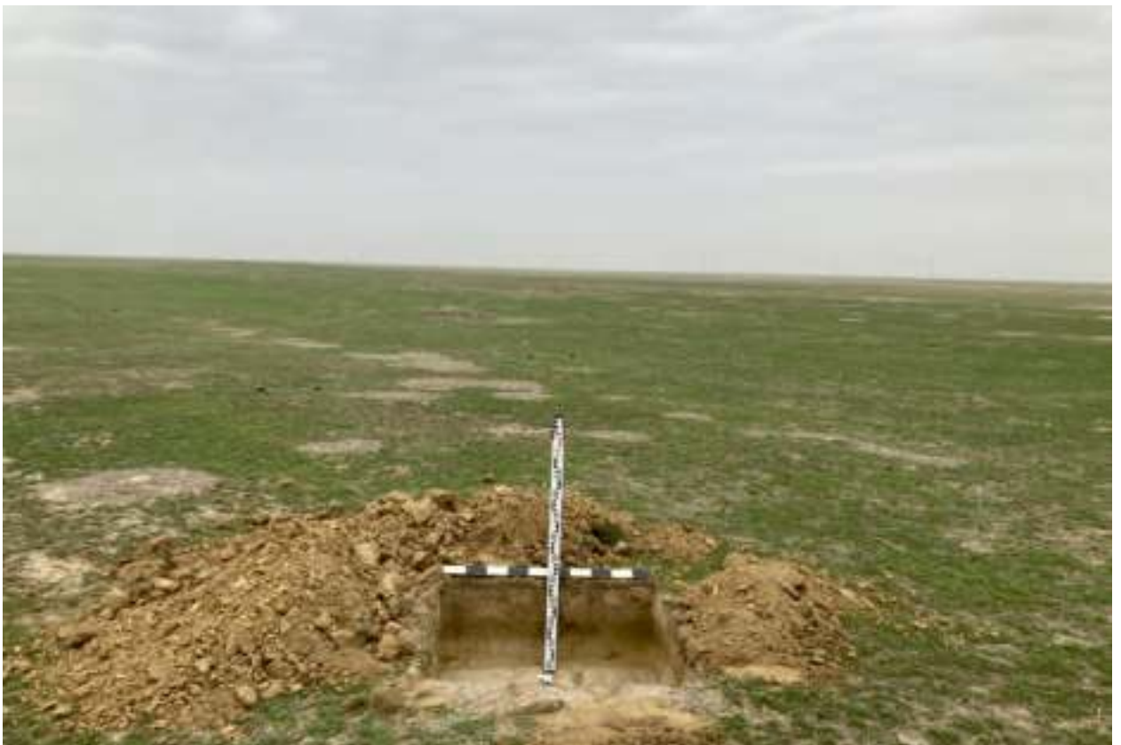
Илл. 660. Республика Дагестан, Ногайский район. Земельный участок с кадастровым номером 03:03:000000:898 , предназначенный для строительства «Чолпанской СЭС». Шурф 156. Общий вид с З.
