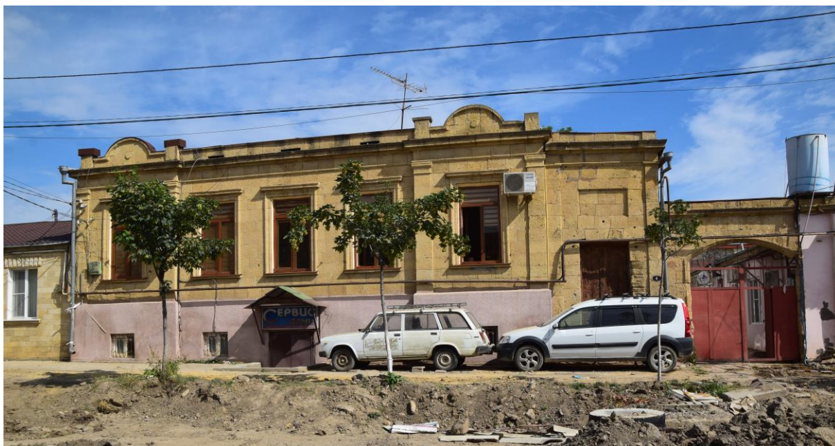
Фото 2. Общий вид исследуемого объекта с ул. Курбанова
