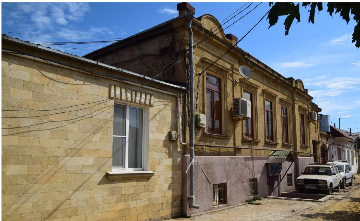
Фото 3. Вид на фасад здания, ризалит слева от входа
