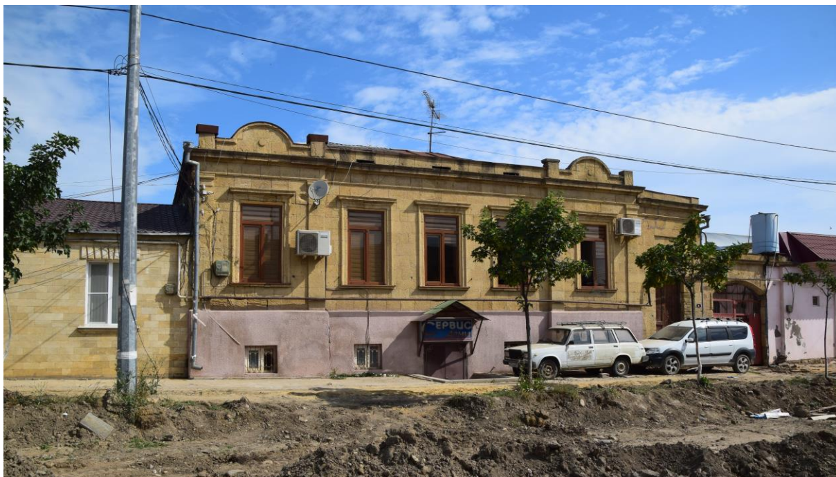
Фото 1. Общий вид исследуемого объекта с ул. Курбанова
