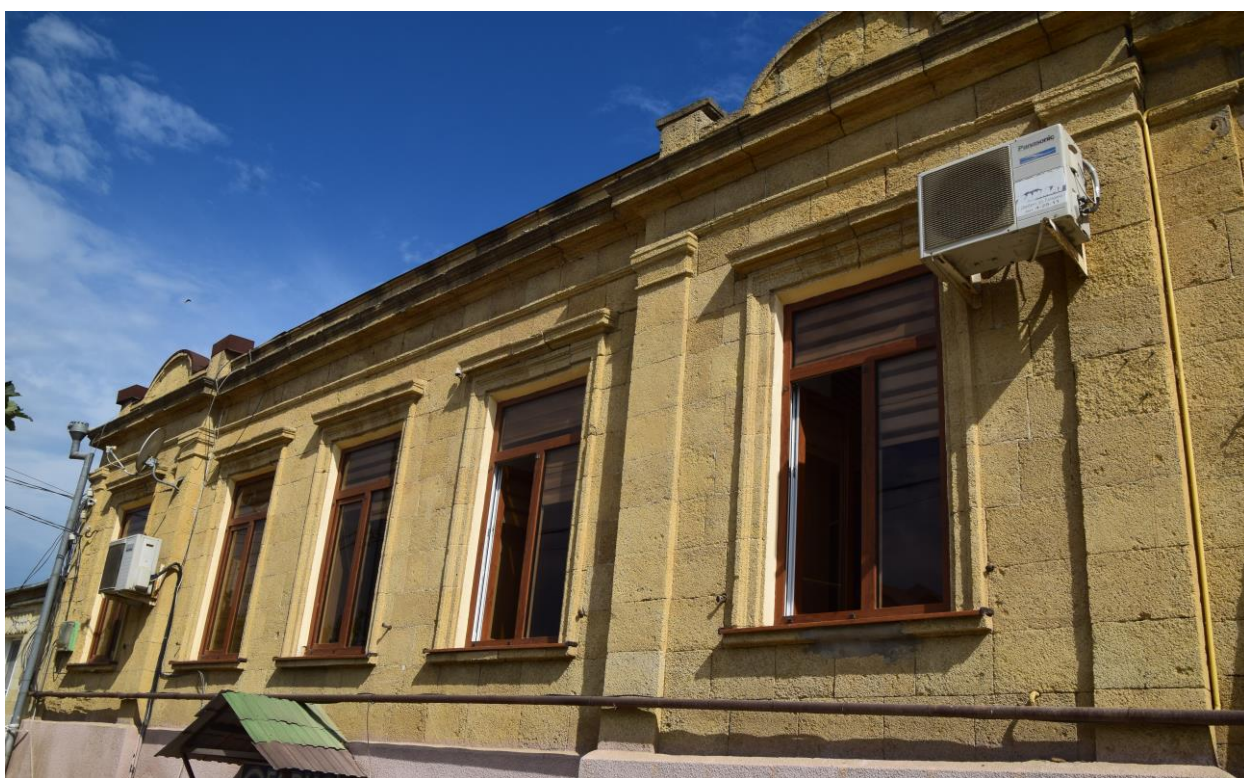
Фото 6. Сандрики и наличники оконных проемов первого этажа
