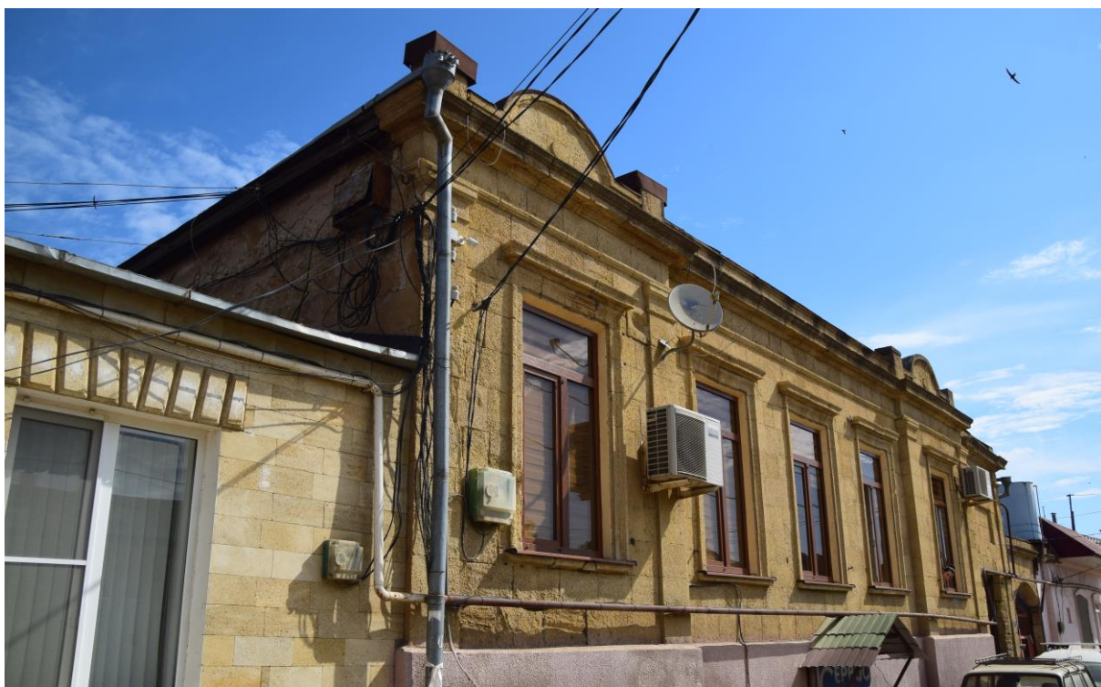
Фото 4. Вид на ризалит и аттик здания
