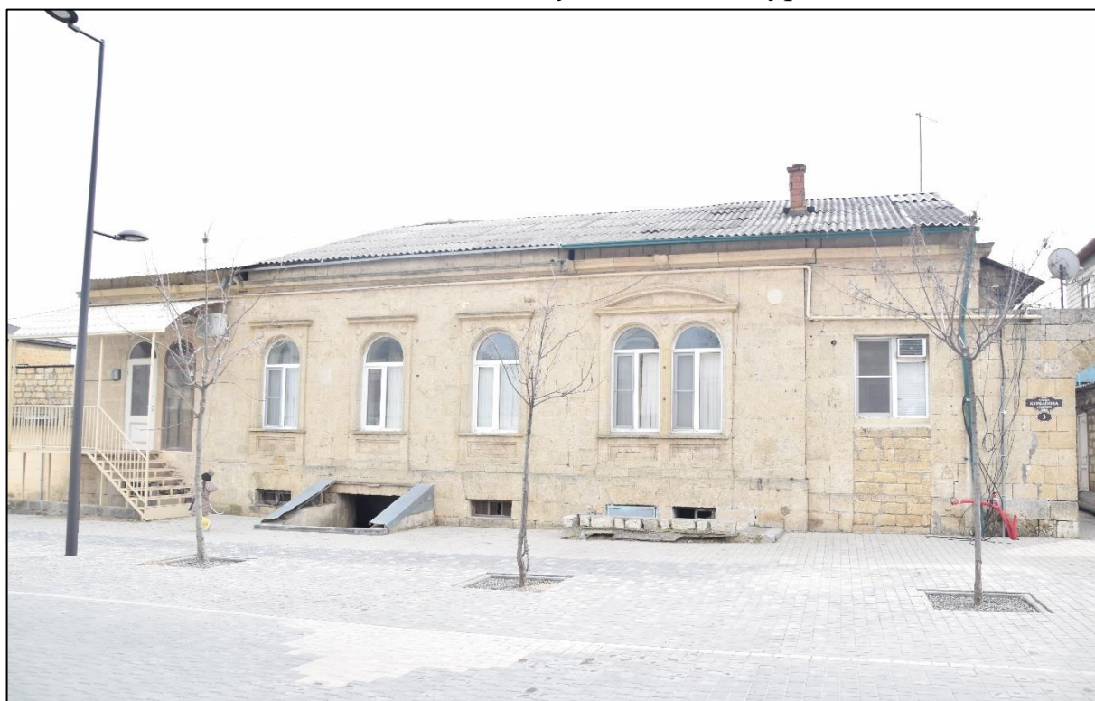
Фото 2. Вид здания, ризалит, заложенный дверной проем справа, оконные проемы.
