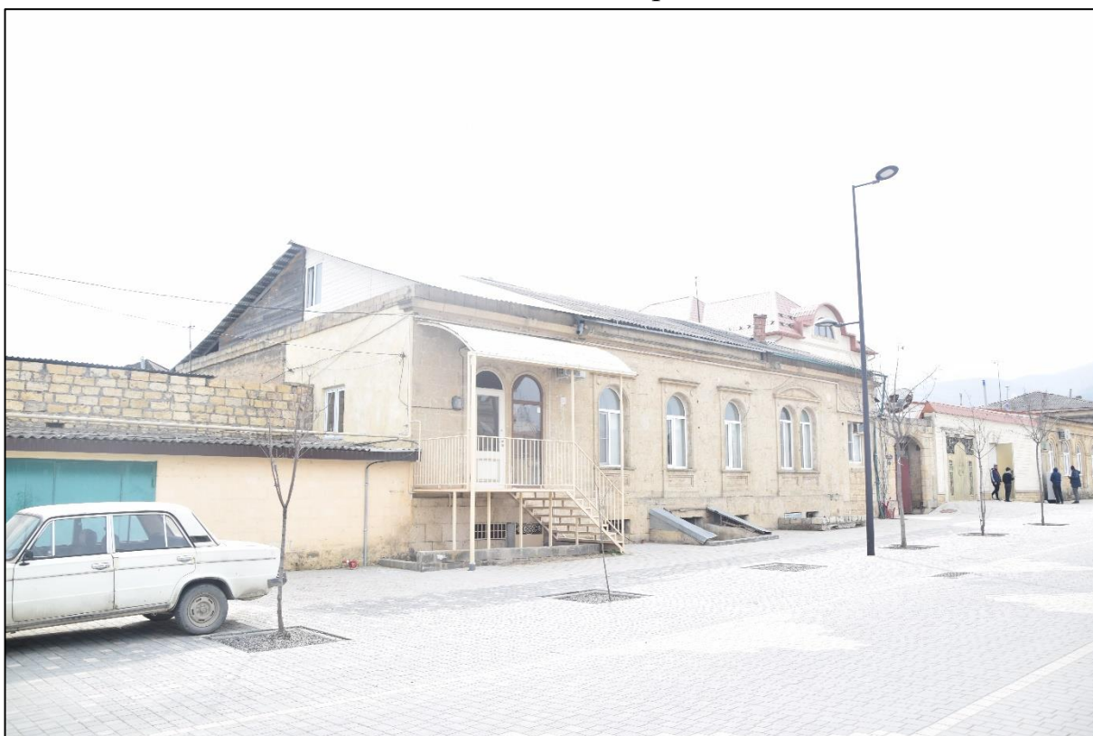
Фото 4. Вид на восточный угол дома по улице Курбанова, элементы позднего оформления дверных проемов из оконных.
