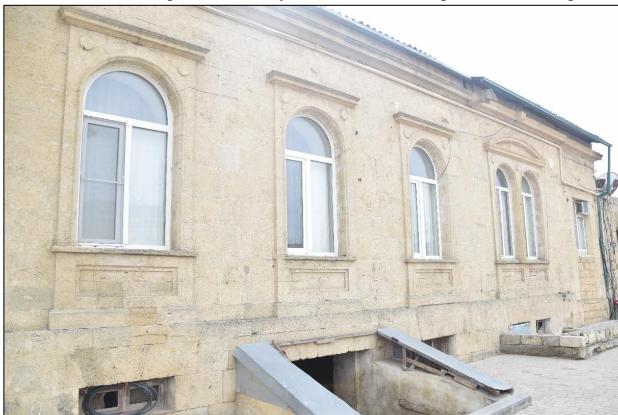
Фото 6. Три одинарных оконных проема с наличниками и спаренный оконный проем, бифорий (справа).
