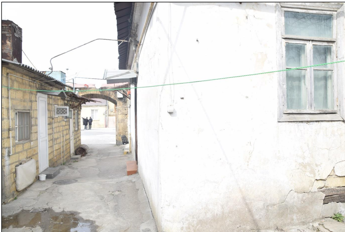
Фото 11. Угол здания, южный фасад и проход к въездной арке со стороны двора.
