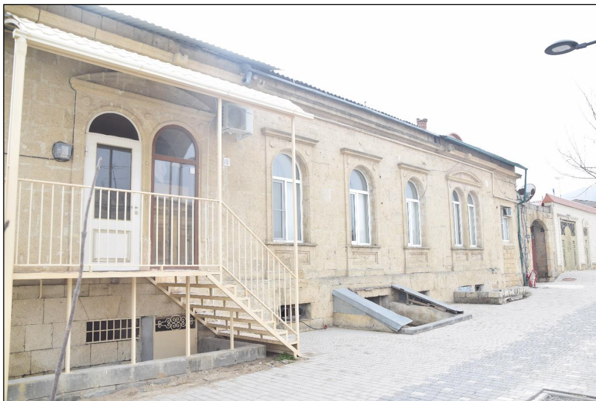
Фото 5. Оконные проемы исследуемого объекта, спаренные и одинарные.
