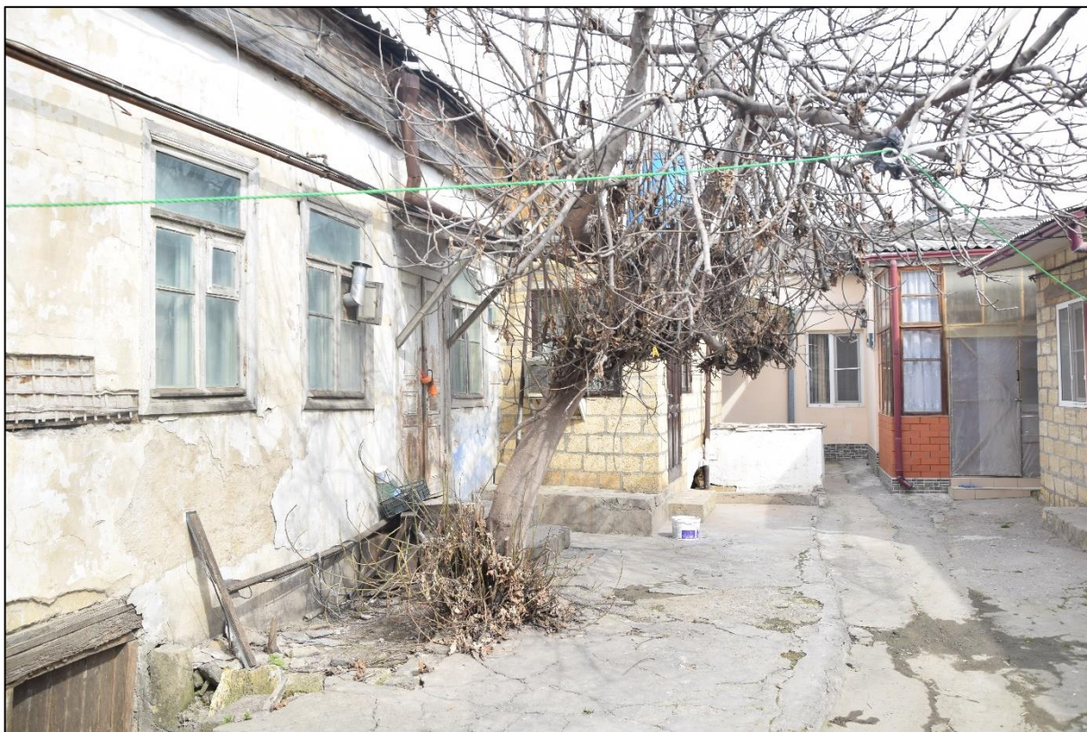
Фото 10. Вид на дворовую территорию и южный фасад исследуемого объекта.
