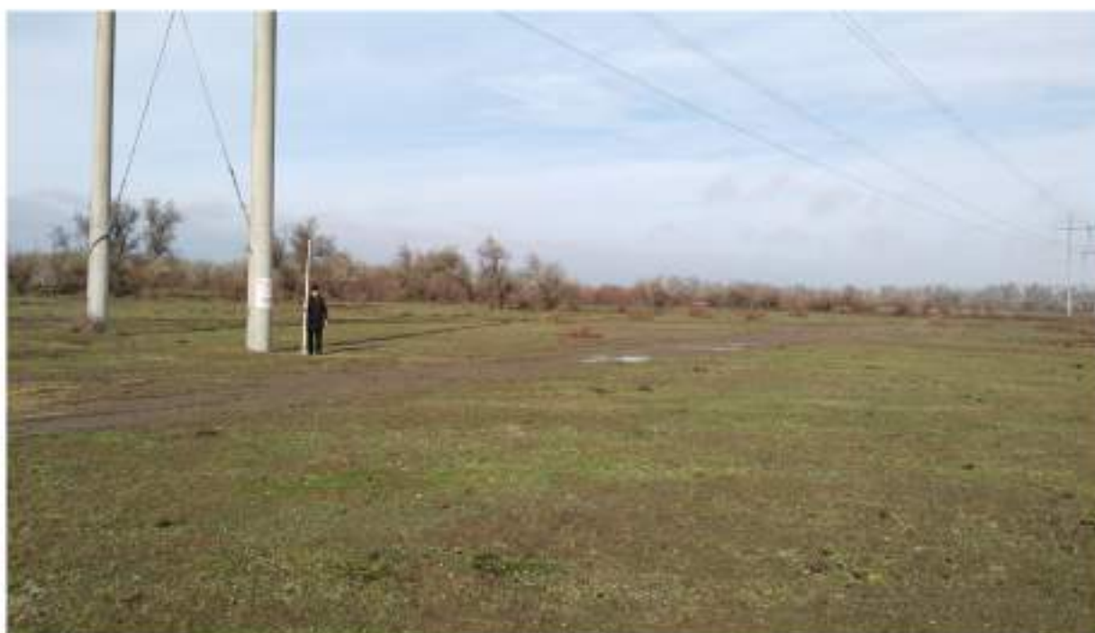
Рис. 37. Археологические разведки в зоне объекта «Реконструкция ВЛ 330 кВ Буденновск - Чирюрт (вынос опор №1258 и 1259 из зоны затопления р. Терек, установка защитных сооружений от размыва опор №1566 и №1566А р. Сулак)». Этап 2. Работы по установке защитных сооружений р. Сулак. Кумторкалинский район. ТФ 1. Вид с ЮВ.
