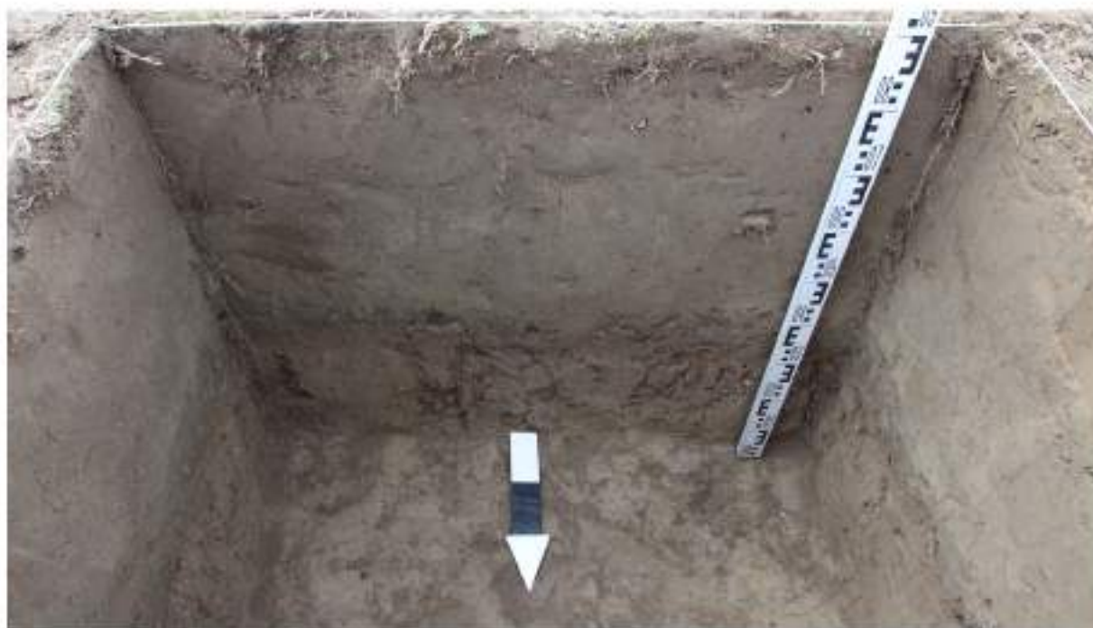
Рис. 130. Археологические разведки в зоне объекта «Реконструкция ВЛ 330 кВ Буденновск - Чирюрт (вынос опор №1258 и 1259 из зоны затопления р. Терек, установка защитных сооружений от размыва опор №1566 и №1566А р. Сулак)». Этап 2. Работы по установке защитных сооружений р. Сулак. Кизилюртовский район. Шурф 5. Южная стенка шурфа (вид с С).
