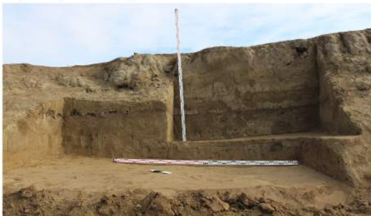
Рис. 89. Археологические разведки в зоне объекта «Реконструкция ВЛ 330 кВ Буденновск - Чирюрт (вынос опор №1258 и 1259 из зоны затопления р. Терек, установка защитных сооружений от размыва опор №1566 и №1566А р. Сулак)». Этап 2. Работы по установке защитных сооружений р. Сулак. Кизилюртовский район. ВОКН Шайтан-Казакское поселение. Зачистка 2. Профиль борта (СВ). Вид с ЮЗ.
