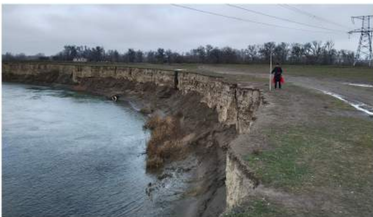
Рис. 52. Археологические разведки в зоне объекта «Реконструкция ВЛ 330 кВ Буденновск - Чирюрт (вынос опор №1258 и 1259 из зоны затопления р. Терек, установка защитных сооружений от размыва опор №1566 и №1566А р. Сулак)». Этап 2. Работы по установке защитных сооружений р. Сулак. Кумторкалинский район. ТФ 6. Вид с ЮЮВ.
