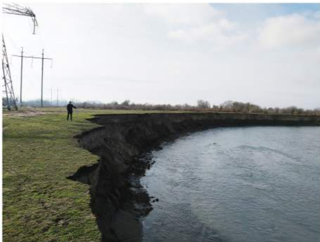
Рис. 50. Археологические разведки в зоне объекта «Реконструкция ВЛ 330 кВ Буденновск - Чирюрт (вынос опор №1258 и 1259 из зоны затопления р. Терек, установка защитных сооружений от размыва опор №1566 и №1566А р. Сулак)». Этап 2. Работы по установке защитных сооружений р. Сулак. Кумторкалинский район. ТФ 5. Правый берег р. Сулак, размываемый участок. Вид с ССВ.
