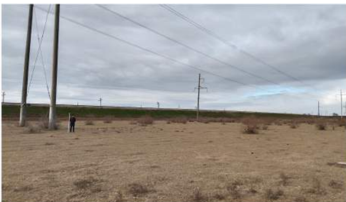
Рис. 10. Археологические разведки в зоне объекта «Реконструкция ВЛ 330 кВ Буденновск - Чирюрт (вынос опор №1258 и 1259 из зоны затопления р. Терек, установка защитных сооружений от размыва опор №1566 и №1566А р. Сулак)». Этап 1. Вынос опор №1258 и 1259 из зоны затопления р. Терек. Бабаюртовский район. ТФ 1. Вид с ЮВ.
