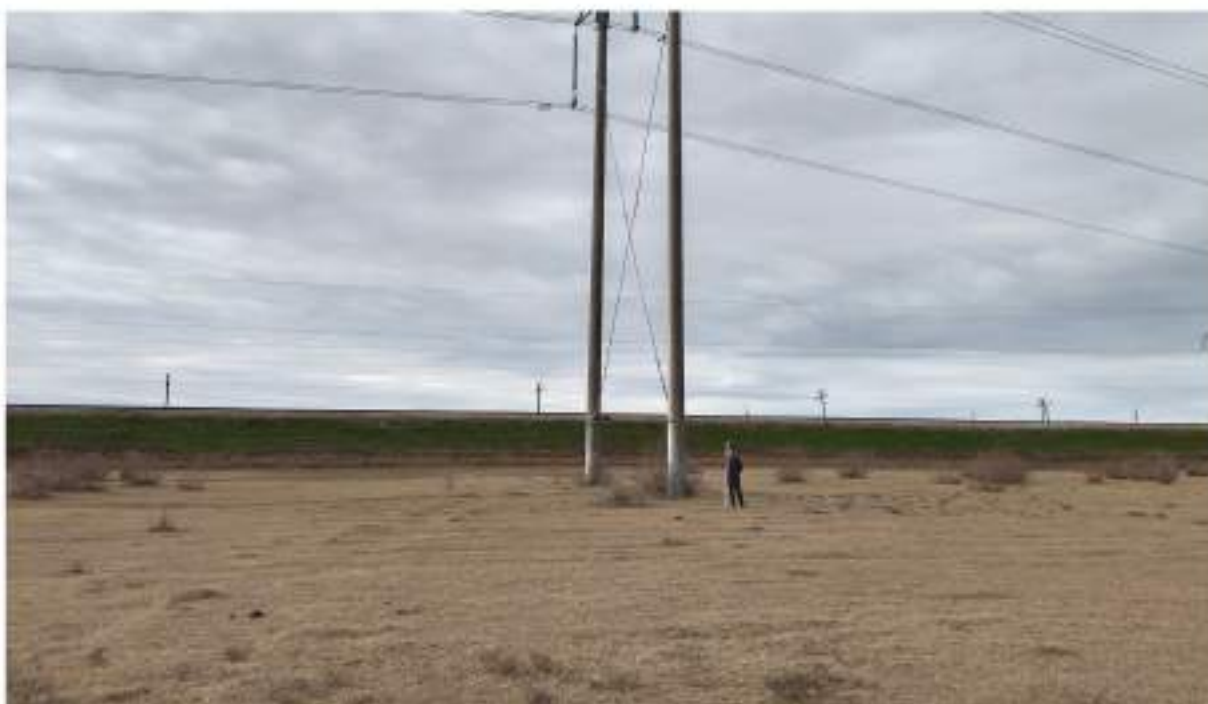
Рис. 9. Археологические разведки в зоне объекта «Реконструкция ВЛ 330 кВ Буденновск - Чирюрт (вынос опор №1258 и 1259 из зоны затопления р. Терек, установка защитных сооружений от размыва опор №1566 и №1566А р. Сулак)». Этап 1. Вынос опор №1258 и 1259 из зоны затопления р. Терек. Бабаюртовский район. ТФ 1. Вид с В.
