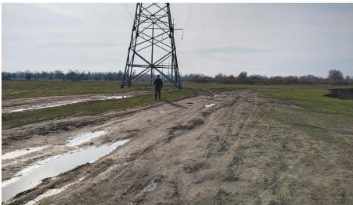
Рис. 48. Археологические разведки в зоне объекта «Реконструкция ВЛ 330 кВ Буденновск - Чирюрт (вынос опор №1258 и 1259 из зоны затопления р. Терек, установка защитных сооружений от размыва опор №1566 и №1566А р. Сулак)». Этап 2. Работы по установке защитных сооружений р. Сулак. Кумторкалинский район. ТФ 4. Вид с С.
