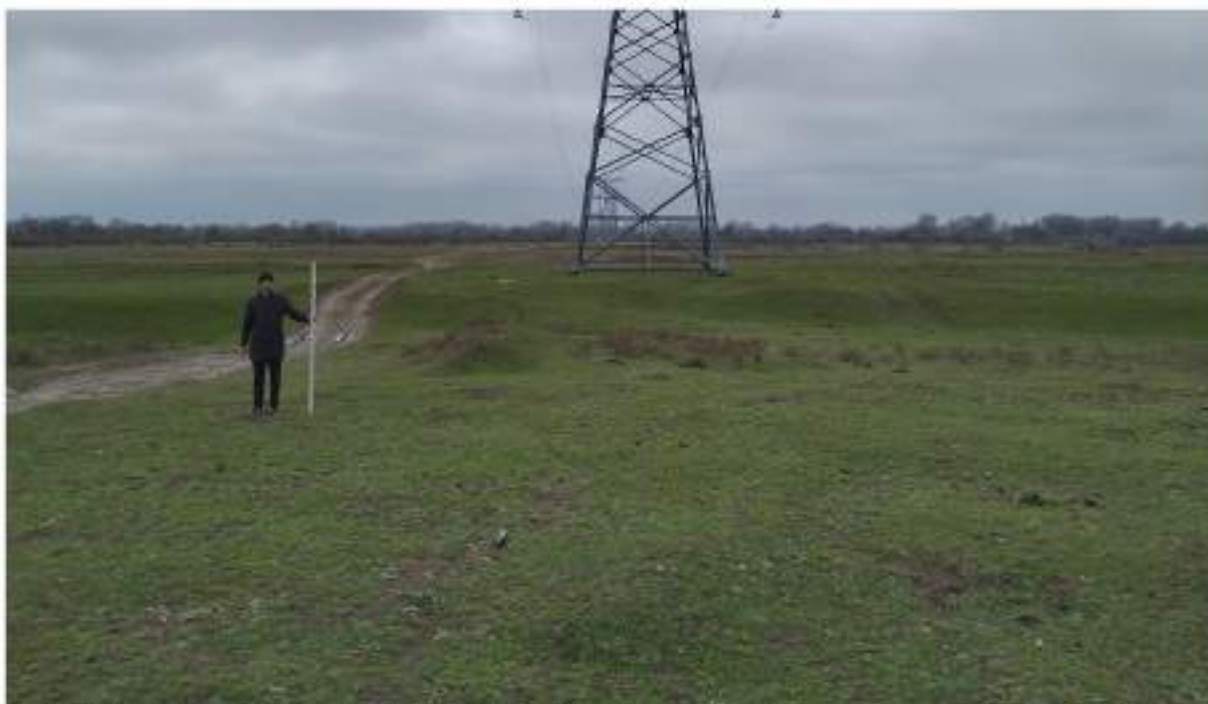
Рис. 53. Археологические разведки в зоне объекта «Реконструкция ВЛ 330 кВ Буденновск - Чирюрт (вынос опор №1258 и 1259 из зоны затопления р. Терек, установка защитных сооружений от размыва опор №1566 и №1566А р. Сулак)». Этап 2. Работы по установке защитных сооружений р. Сулак. Кумторкалинский район. ТФ 7. Вид с С.
