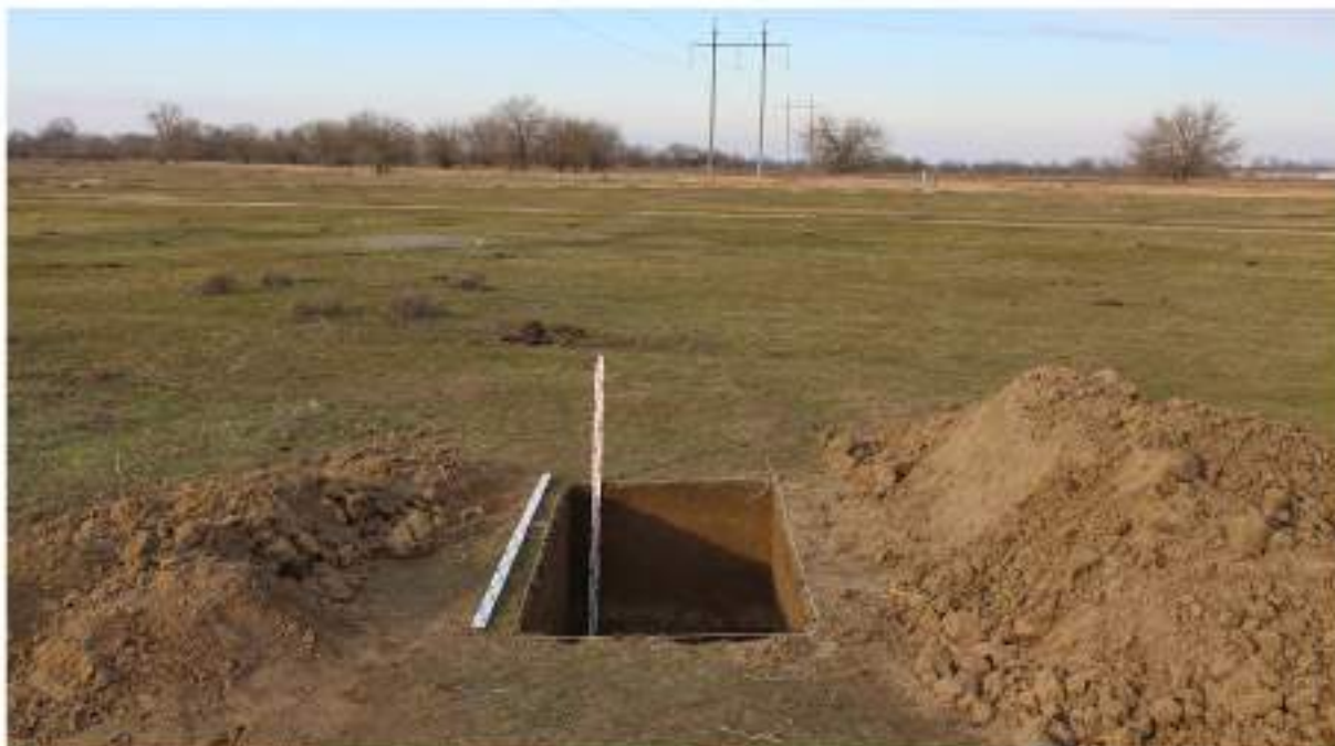
Рис. 93. Археологические разведки в зоне объекта «Реконструкция ВЛ 330 кВ Буденновск - Чирюрт (вынос опор №1258 и 1259 из зоны затопления р. Терек, установка защитных сооружений от размыва опор №1566 и №1566А р. Сулак)». Этап 2. Работы по установке защитных сооружений р. Сулак. Кизилюртовский район. ВОКН Шайтан-Казакское поселение. Шурф 2. Общий вид после завершения работ. Вид с Ю.
