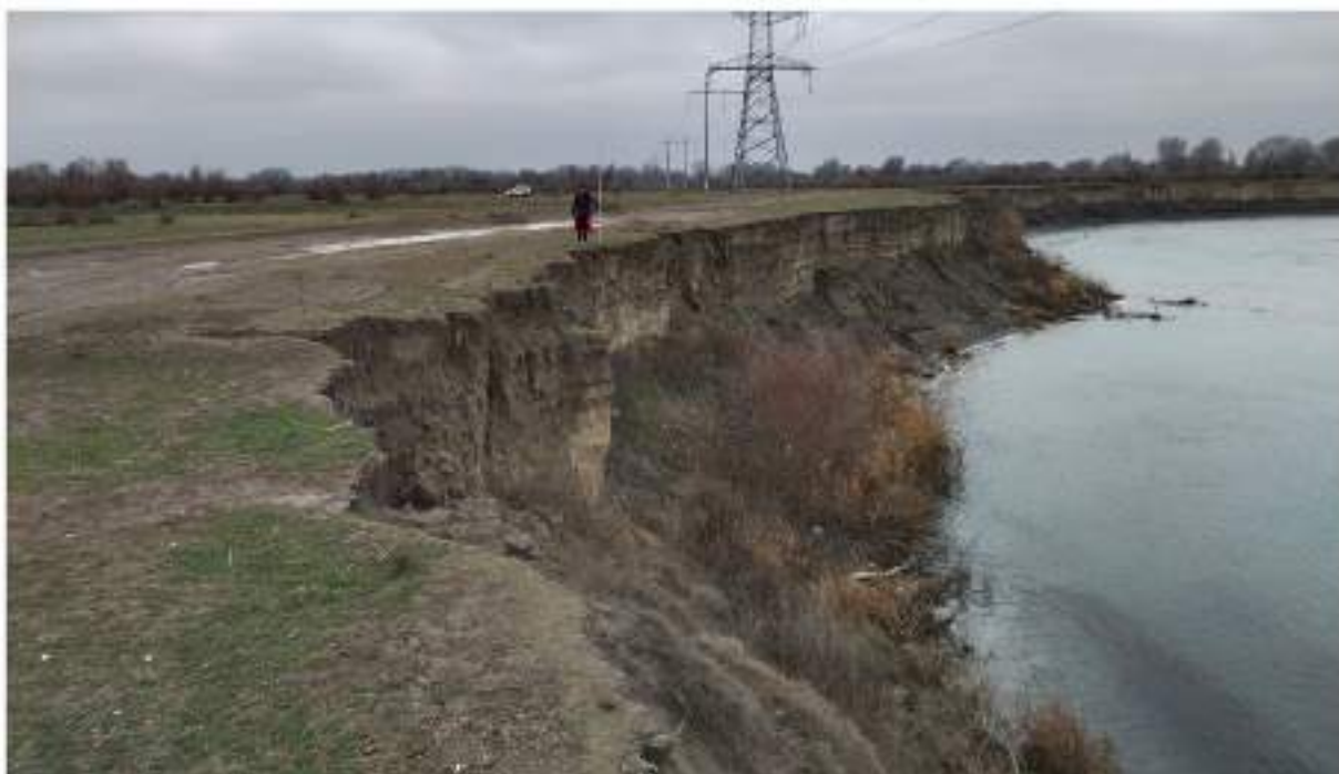
Рис. 51. Археологические разведки в зоне объекта «Реконструкция ВЛ 330 кВ Буденновск - Чирюрт (вынос опор №1258 и 1259 из зоны затопления р. Терек, установка защитных сооружений от размыва опор №1566 и №1566А р. Сулак)». Этап 2. Работы по установке защитных сооружений р. Сулак. Кумторкалинский район. ТФ 6. Вид с С.
