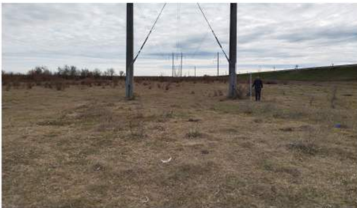
Рис. 19. Археологические разведки в зоне объекта «Реконструкция ВЛ 330 кВ Буденновск - Чирюрт (вынос опор №1258 и 1259 из зоны затопления р. Терек, установка защитных сооружений от размыва опор №1566 и №1566А р. Сулак)». Этап 1. Вынос опор №1258 и 1259 из зоны затопления р. Терек. Бабаюртовский район. ТФ 3. Вид с ССЗ.
