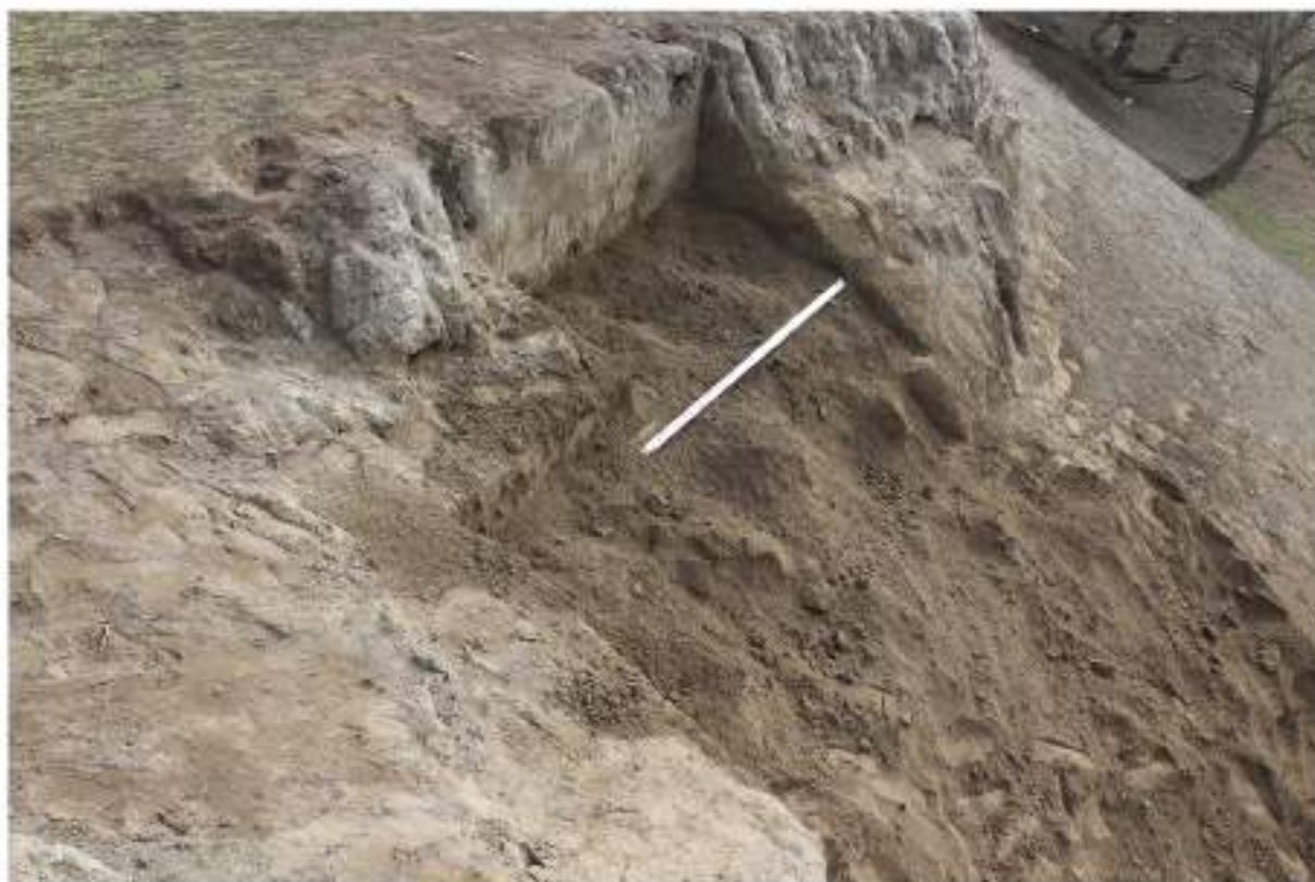
Рис. 90. Археологические разведки в зоне объекта «Реконструкция ВЛ 330 кВ Буденновск - Чирюрт (вынос опор №1258 и 1259 из зоны затопления р. Терек, установка защитных сооружений от размыва опор №1566 и №1566А р. Сулак)». Этап 2. Работы по установке защитных сооружений р. Сулак. Кизилюртовский район. ВОКН Шайтан-Казакское поселение. Зачистка 2. Рекультивация. Вид с СЗ.
