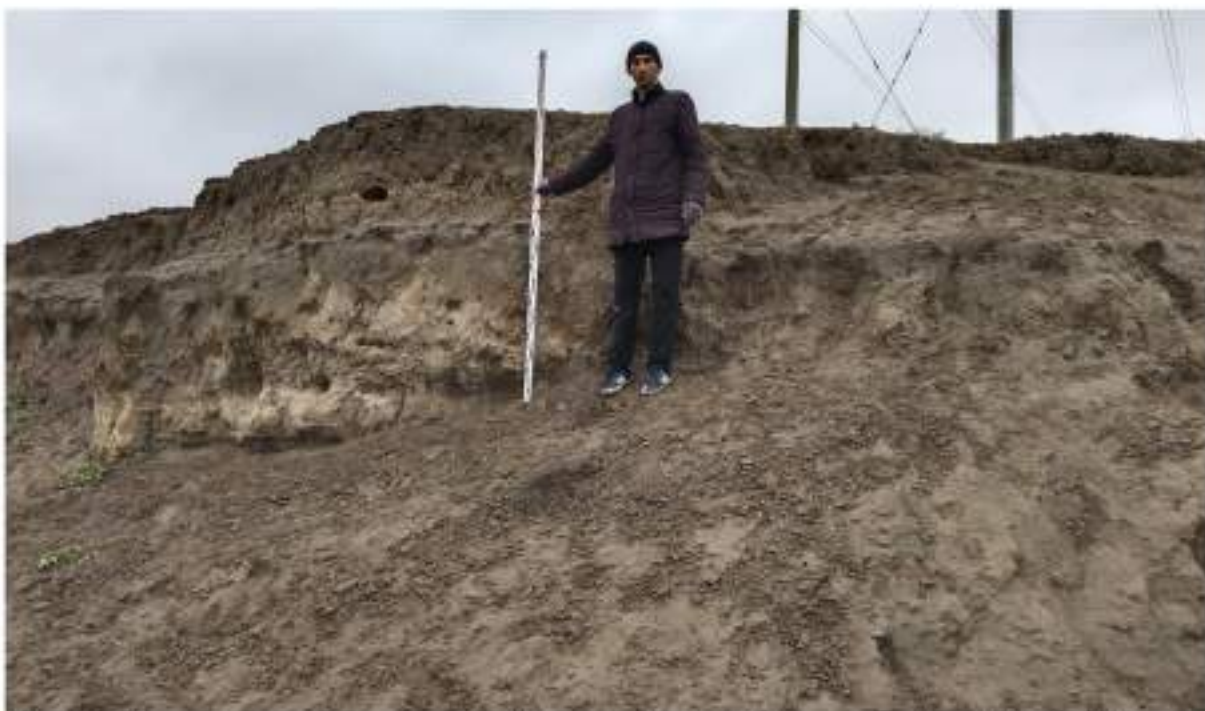
Рис. 69. Археологические разведки в зоне объекта «Реконструкция ВЛ 330 кВ Буденновск - Чирюрт (вынос опор №1258 и 1259 из зоны затопления р. Терек, установка защитных сооружений от размыва опор №1566 и №1566А р. Сулак)». Этап 2. Работы по установке защитных сооружений р. Сулак. Кизилюртовский район. Зачистка 1 до начала работ. Вид с ЮВ.
