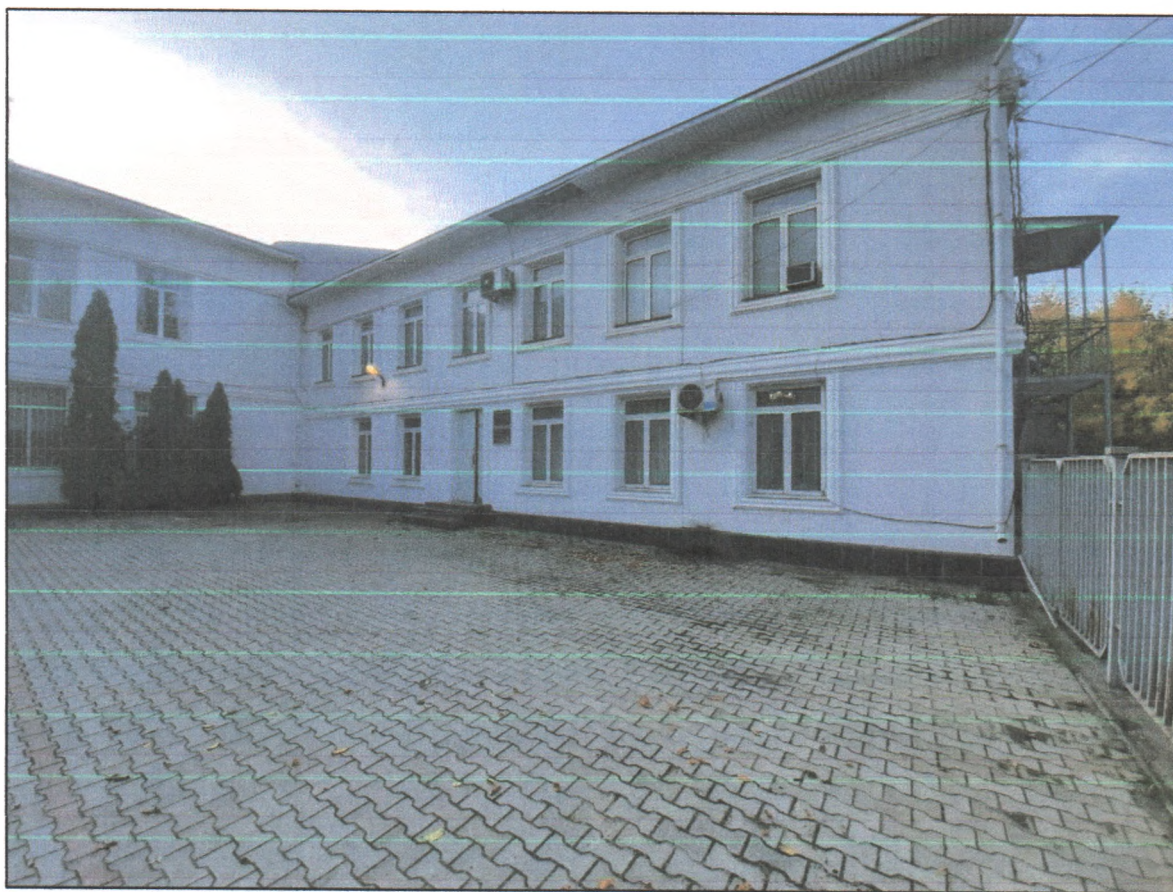
Т.ф.2. Вид на фасад второго корпуса здания.
