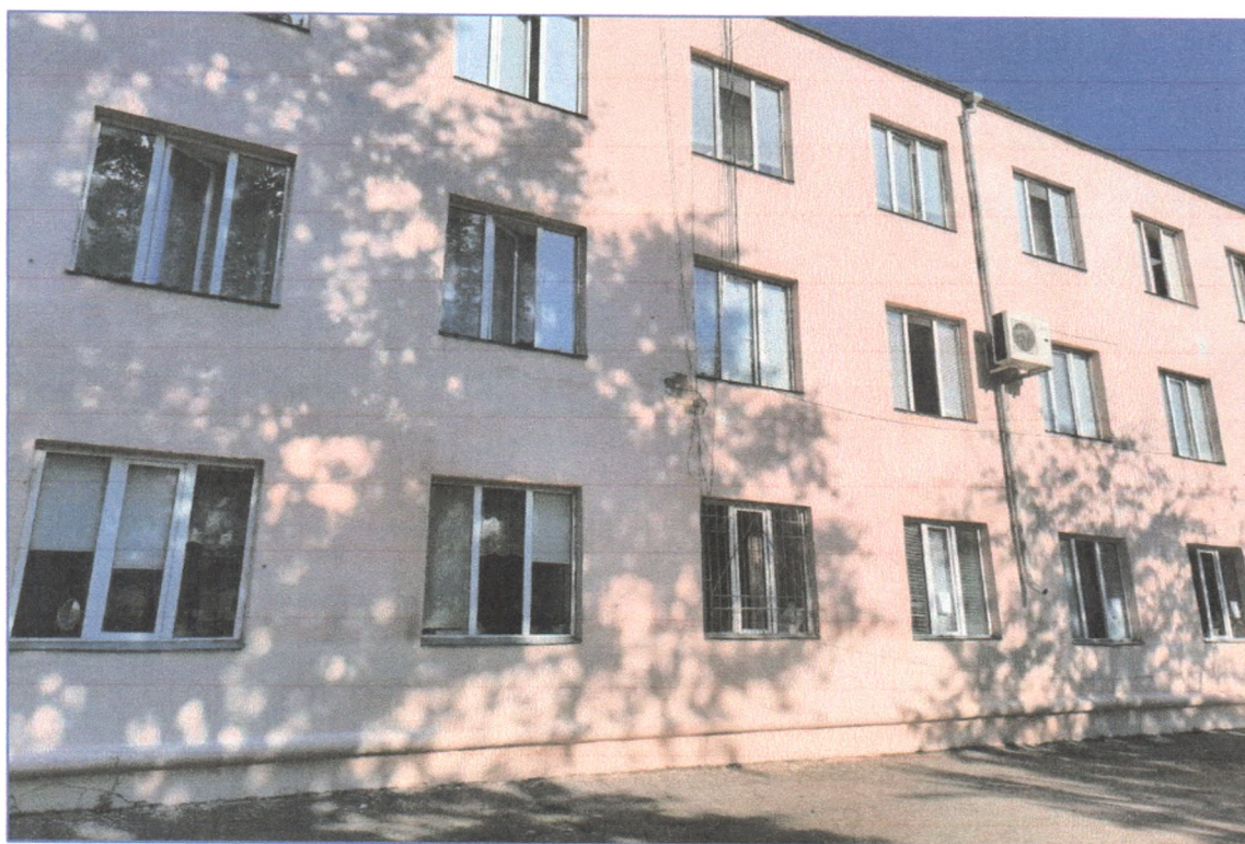
Т.ф.7. Вид с юга на главный корпус школы.
