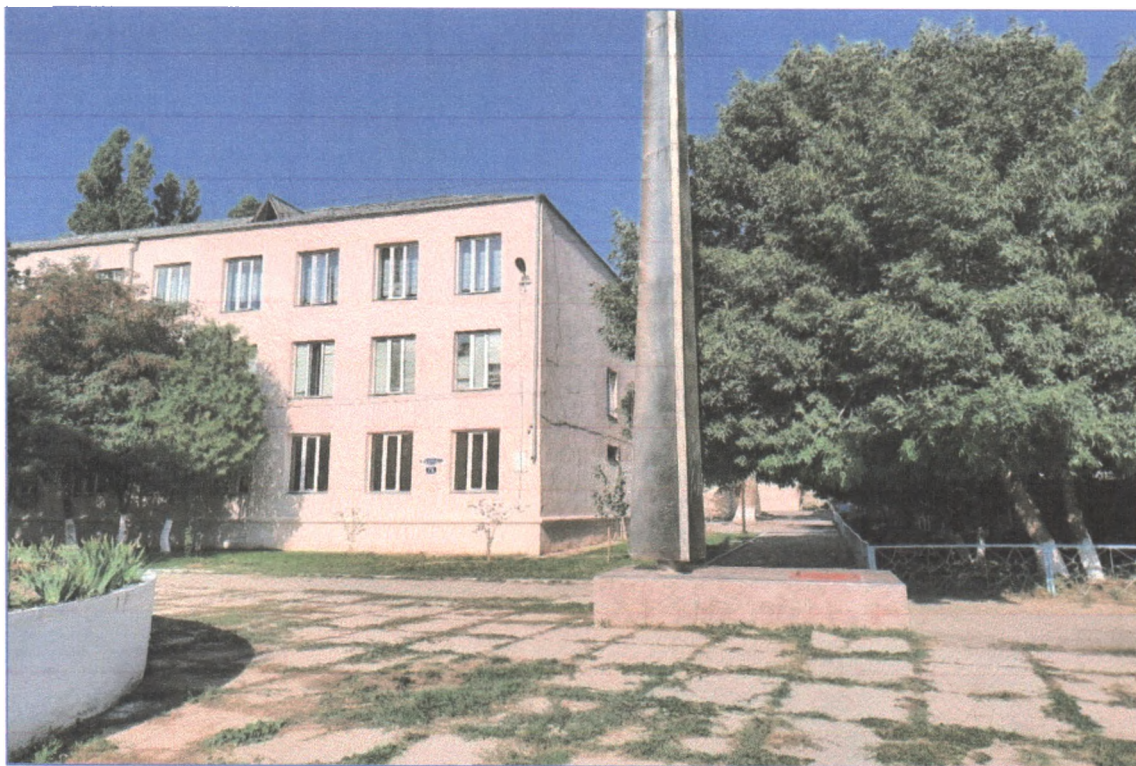
Т.ф.12. Вид с юга на главный корпус школы.
