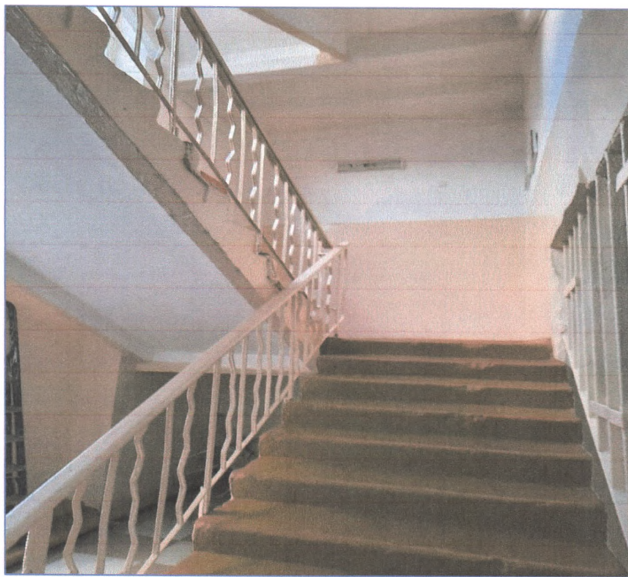
Т.ф.19. Междуетажная лестница школы.
