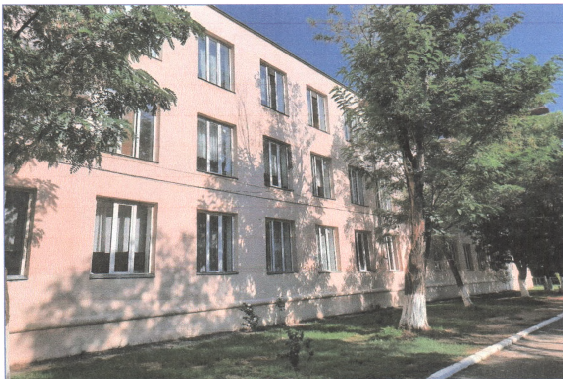
Т.ф.11. Вид с юга на главный корпус школы.
