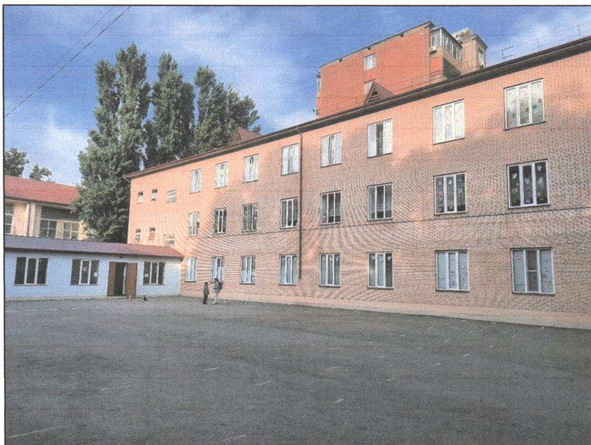
Т.ф.11. Вид на четвертый корпус школы с восточной стороны.
