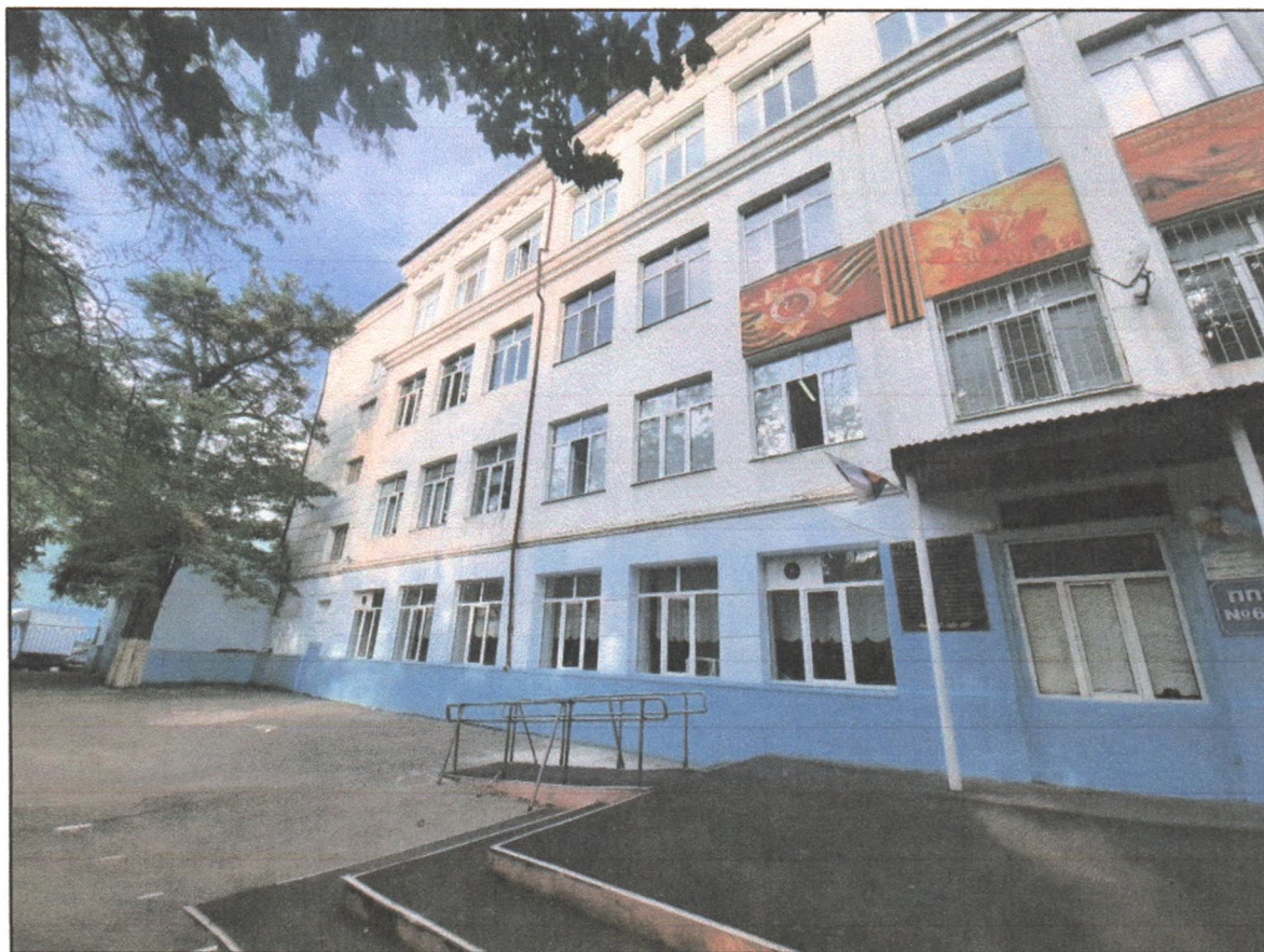
Т.ф.4. Фрагмент главного фасада, вид с северо-востока.
