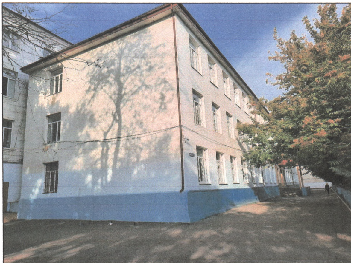
Т.ф.5. Общий вид на второй корпус школы с восточной стороны.
