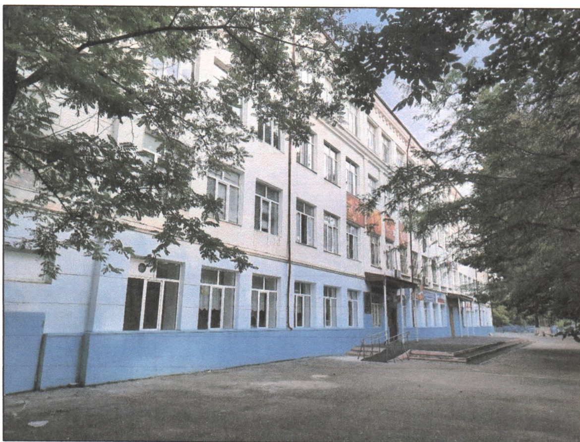
Т.ф.1. Вид на главный фасад с северной стороны.
