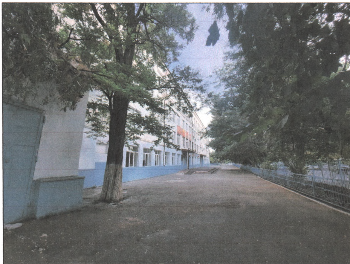
Т.ф.3. Общий вид на главный фасад.
