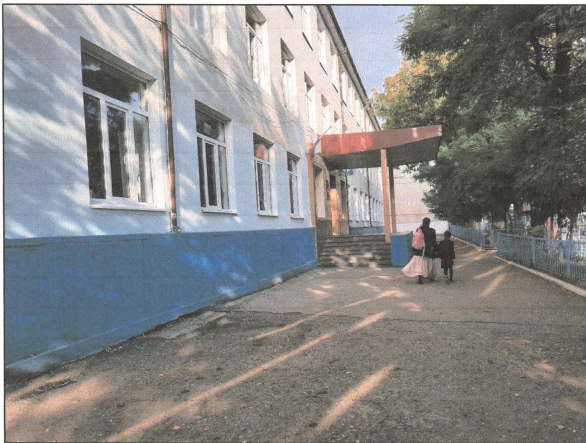
Т.ф.6. Вид на второй корпус школы с восточной стороны.
