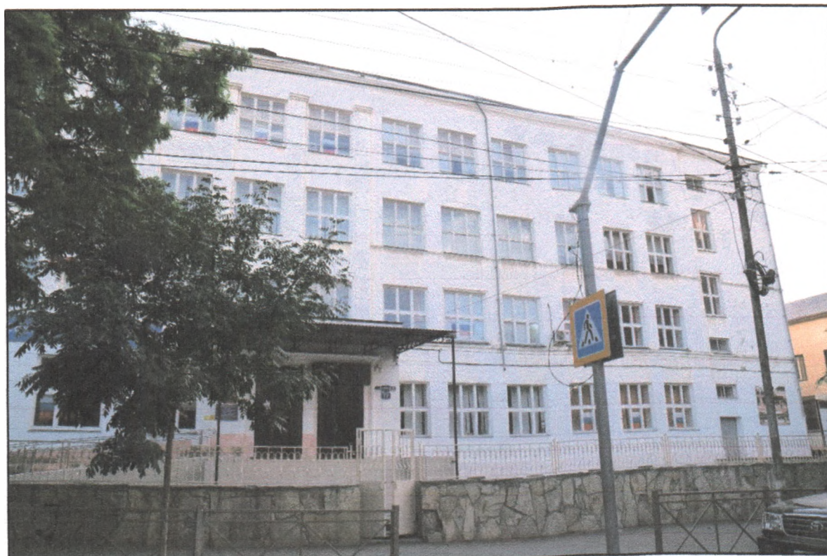
Т.ф.1. Вид на главный вход в здание со стороны улицы Даниялова.
