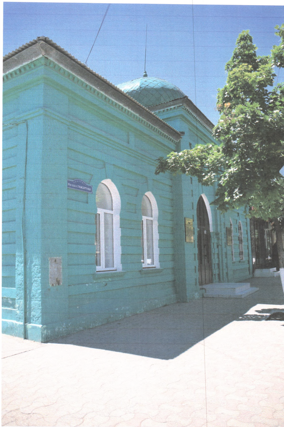
Т.ф.2. Вид на главный фасад здания, выходящий на пр-т. Р. Гамзатова.
