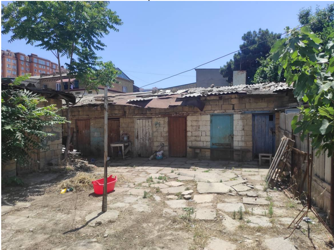
Илл. 39. Фото жилого дома. Вид со двора.
