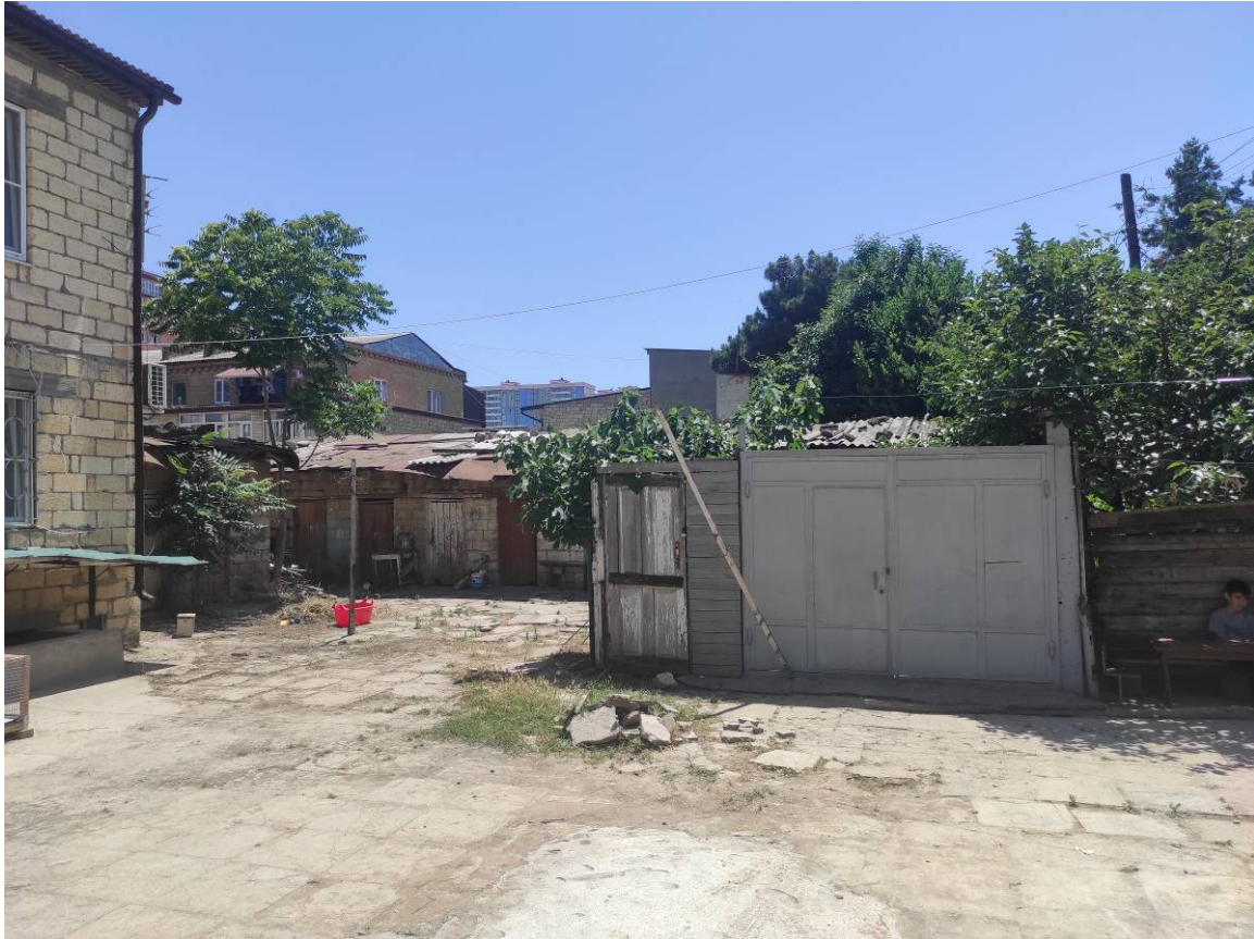
Илл. 38. Фото жилого дома. Вид со двора.
