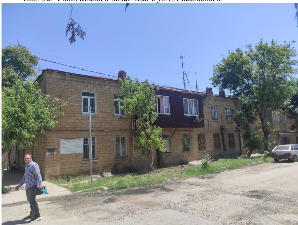
Илл. 33. Фото жилого дома. Вид с ул.С.Стальского.
