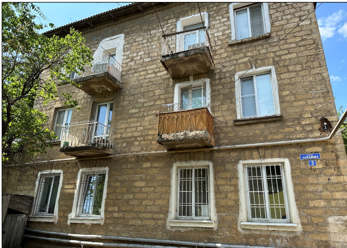
Фото 1. Общий вид бокового фасада здания по ул. Заманова.
