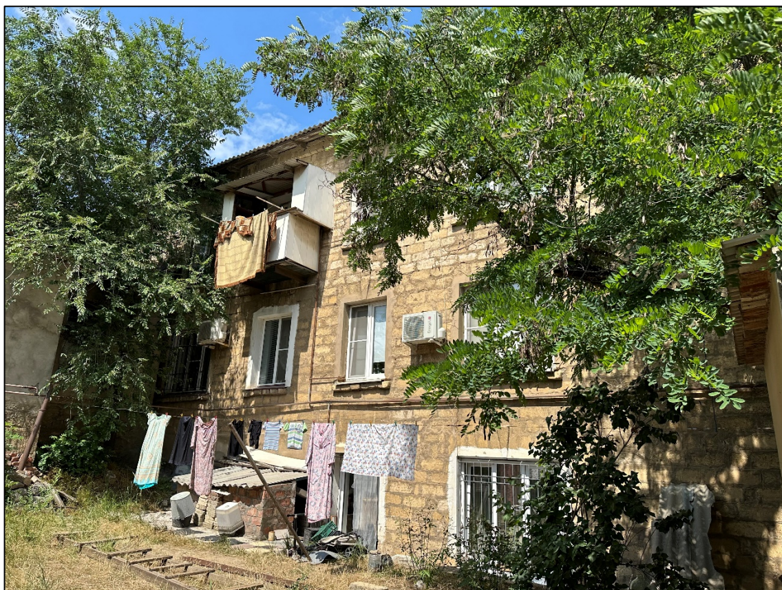
Фото 5. Юго-восточный фасад здания.
