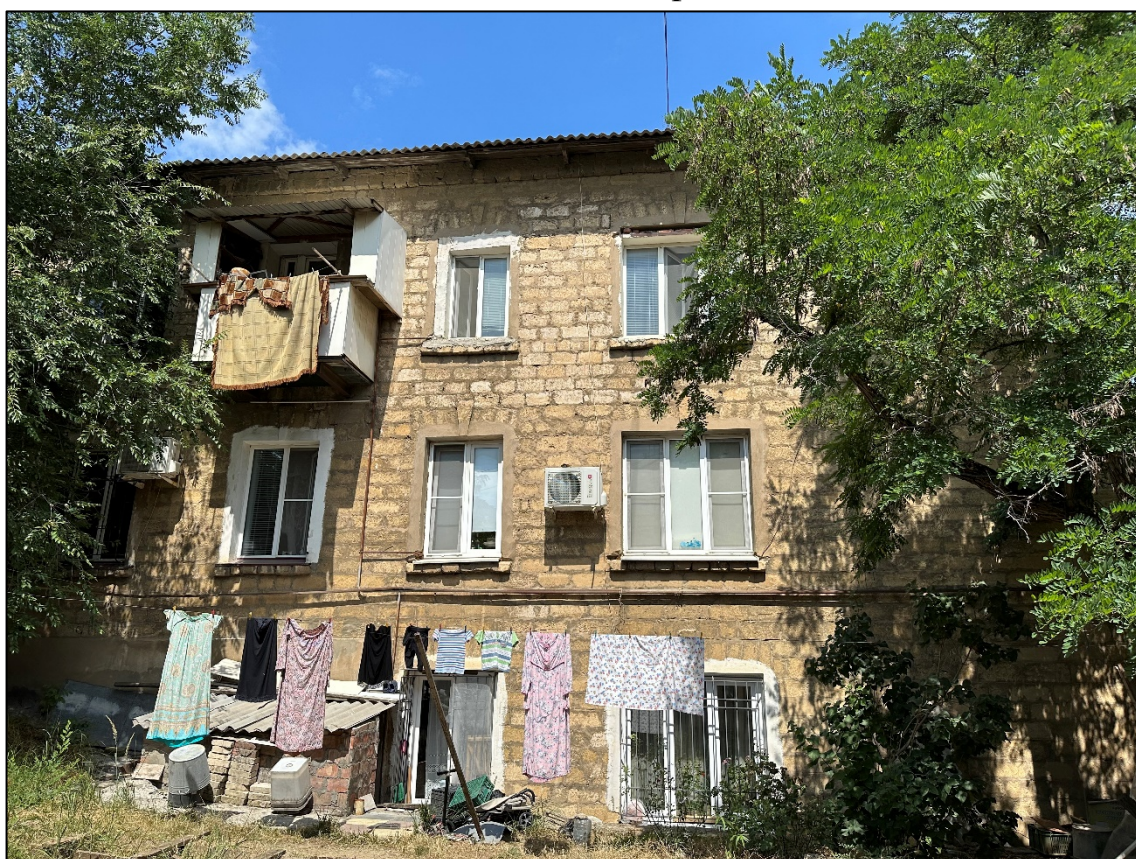
Фото 6. Юго-восточный фасад здания, поздние пристройки здания, уровень первого этажа заглублен в землю.
