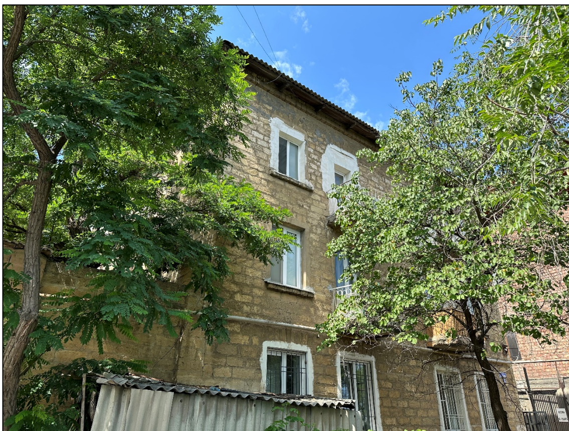
Фото 4. Боковой фасад здания по ул. Заманова с поздними пристройками.
