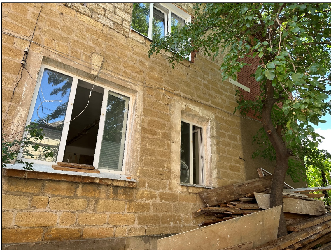
Фото 3. Фасад здания с северо-западной стороны, видны элементы поздней перестройки.
