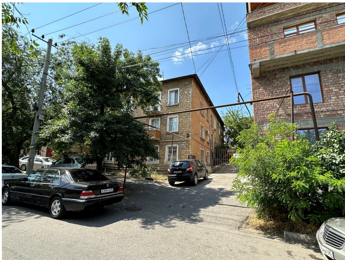
Фото 7. Общий вид на главный фасад здания и угол со стороны входа.
