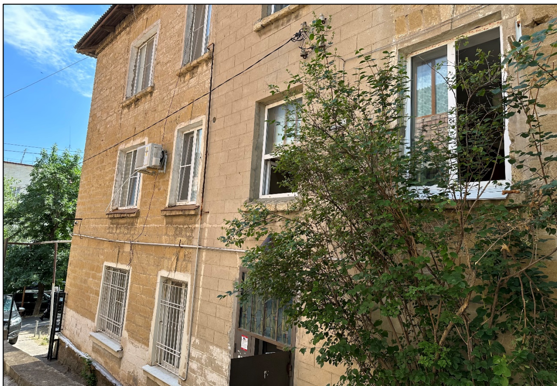
Фото 2. Северо-западный фасад здания с дворовой стороны, основные входы в подьезды здания.
