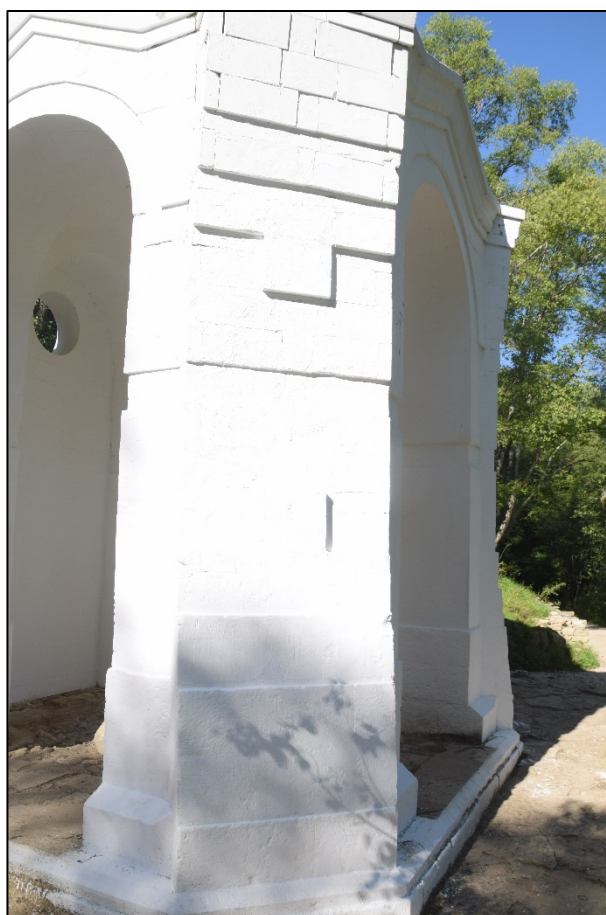
Фото 8. Одна из опор беседки, со ступенчатым основанием, рустом по поверхности и завершением в виде профилированного карниза.
