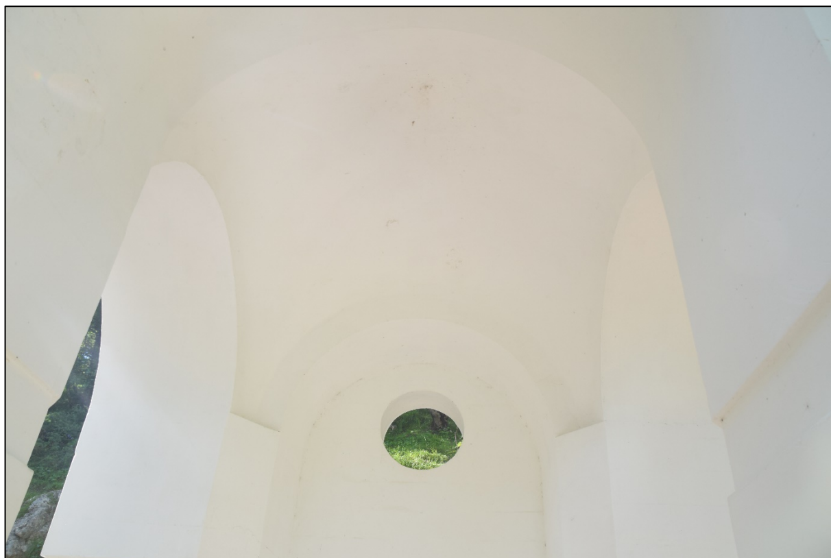
Фото 7. Внутренняя поверхность тыльной стенки беседки, купол беседки и круглый проем в стенке.
