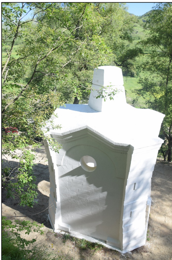
Фото 3. Вид на тыльную сторону беседки, со стороны скалы и подпорной стены, венчающий обелиск и стенка с круглым проемом.
