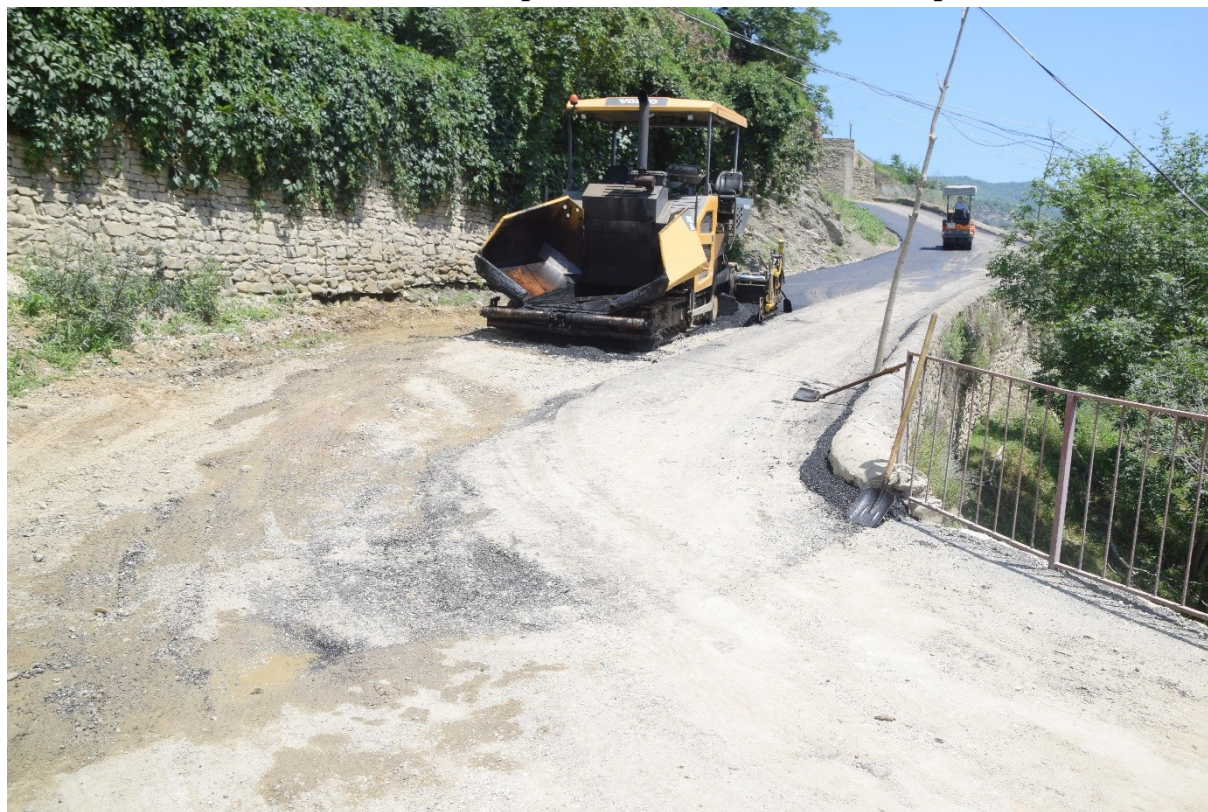
Фото 4. Основание моста со стороны села Ругуж, подпорная стена.
