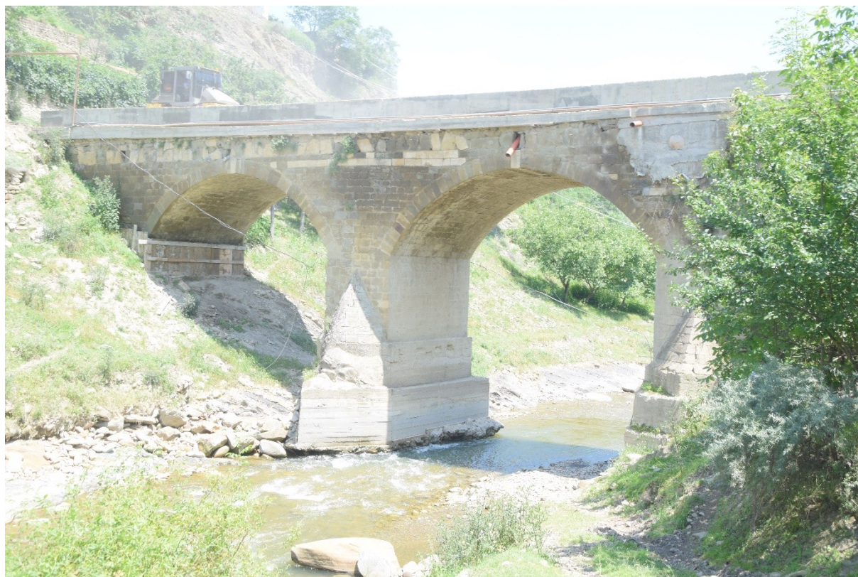
Фото 7. Вид на западную сторону моста, видно основание, встроенное в скалистый берег, а также массивное основание среднего пролета.
