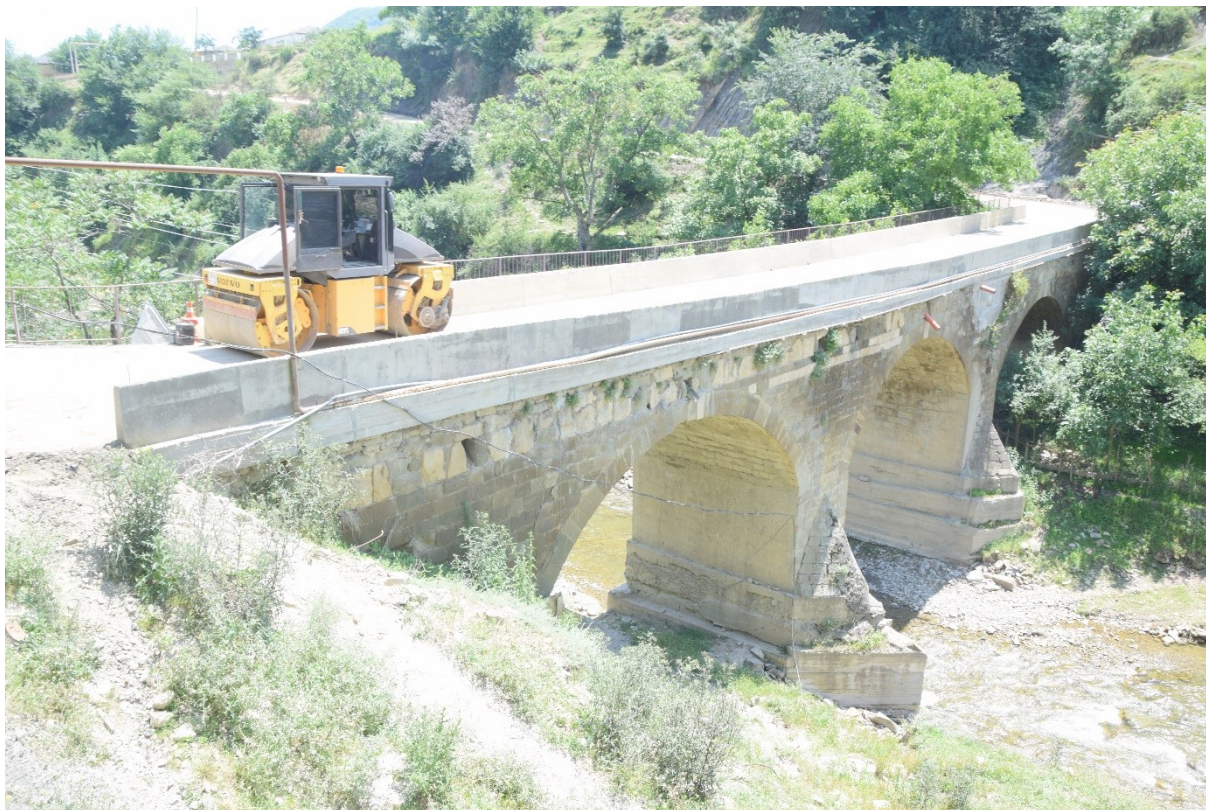
Фото 5. Общий вид на мост с левого берега реки Ханаг-чай, три пролета моста и массивное основание среднего пролета с волнорезами.
