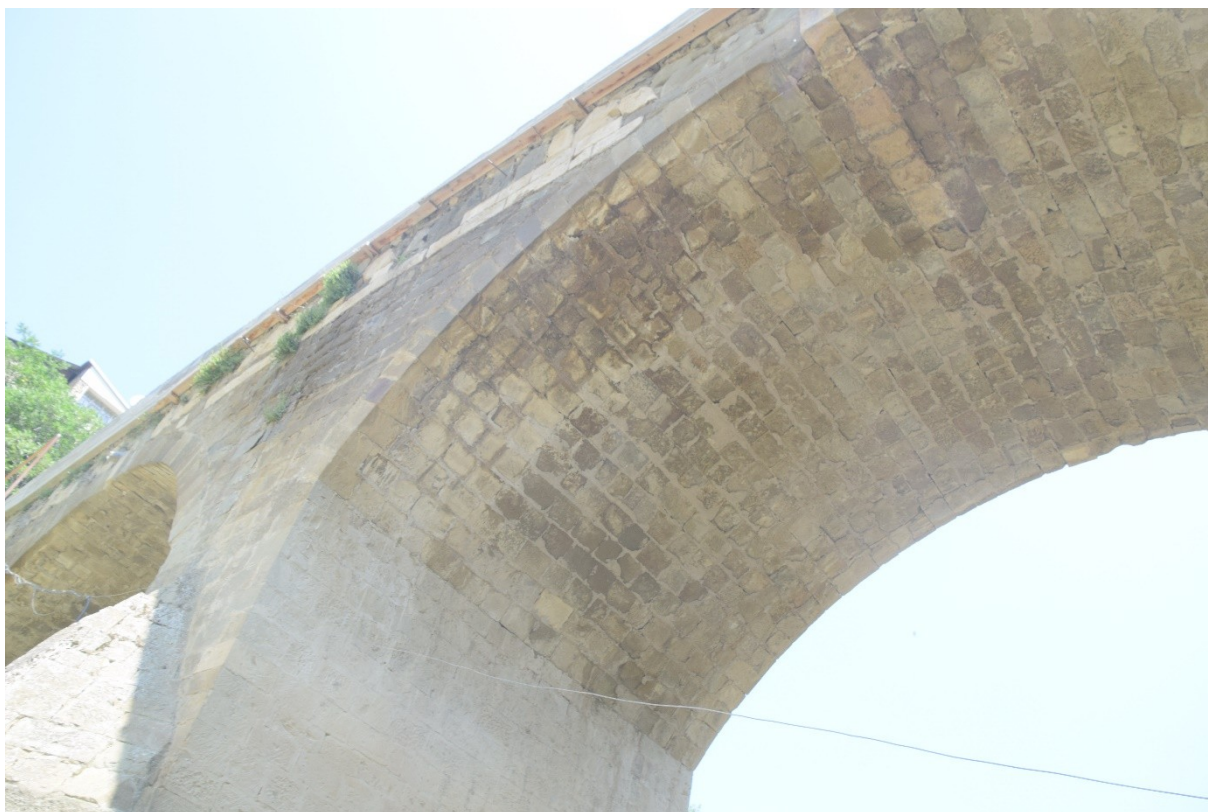
Фото 11. Каменная кладка центральной арки моста.
