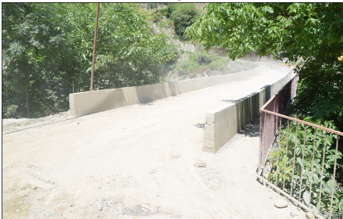
Фото 1. Общий вид моста со сторон села Ханаг, новое дорожное покрытие и бетонное ограждение.
