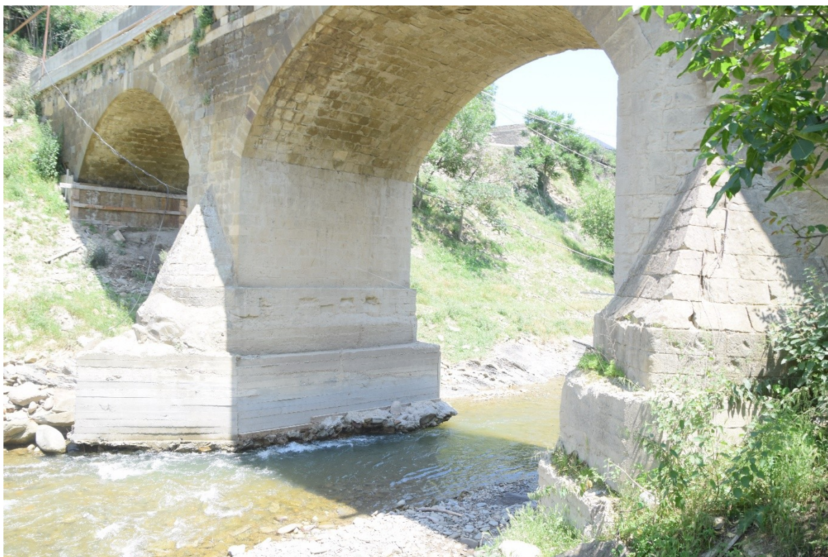
Фото 9. Массивные ступенчатые основания моста, среднего его пролета, против течения рек устроены остроугольные волнорезы.
