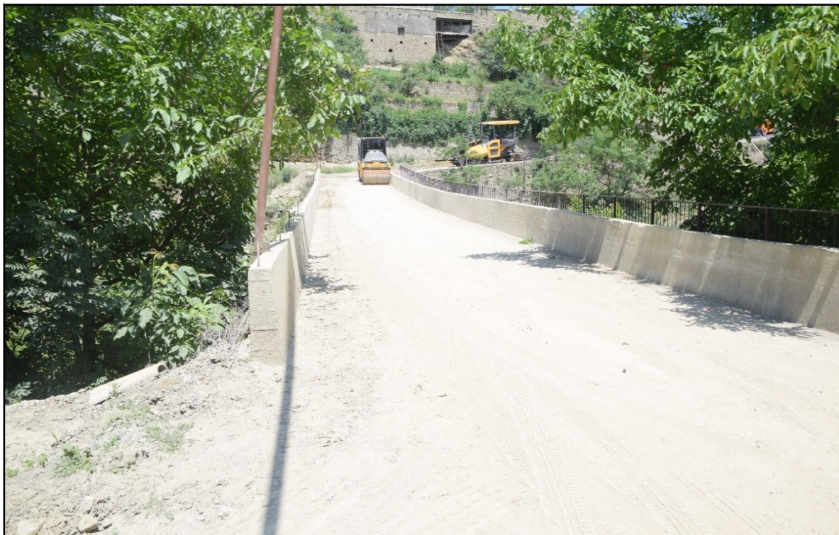
Фото 1. Общий вид моста со сторон села Ханаг, новое дорожное покрытие и бетонное ограждение.
