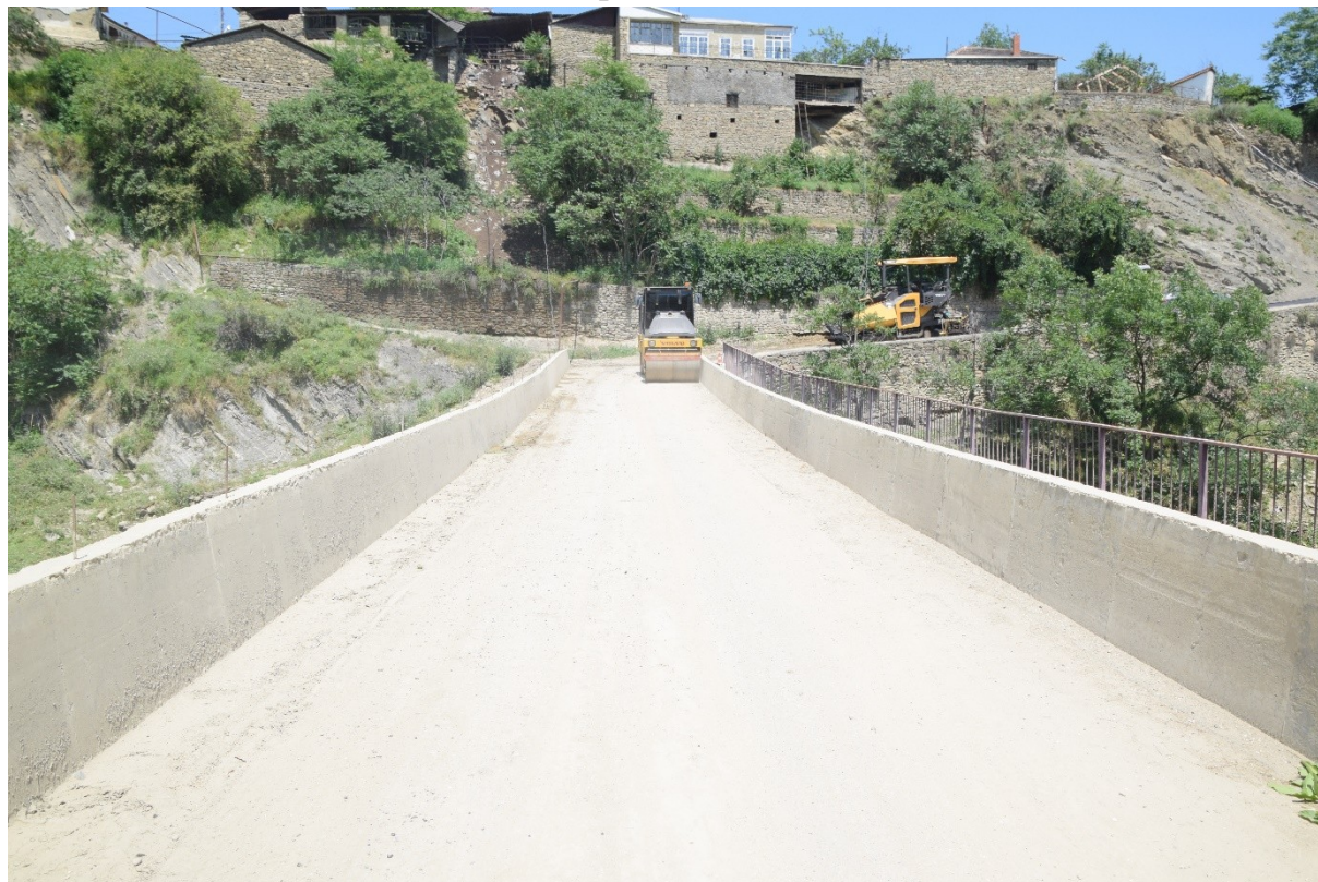
Фото 3. Вид на новое дорожное полотно моста, ограждения.
