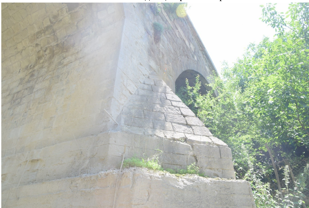
Фото 12. Волнорез остроугольной пирамидообразной формы на ступенчатом основании центрального пролета.
