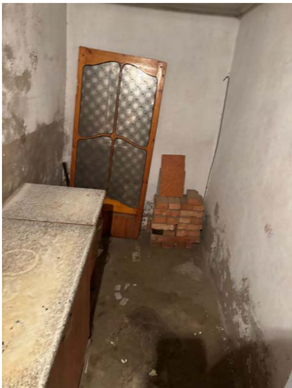
Илл. 45. Фото существующего положения домостроения. Вид помещений в подвальном этаже.
