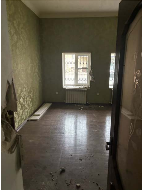
Илл. 41. Фото существующего положения домостроения. Вид помещений на 1 этаже.
