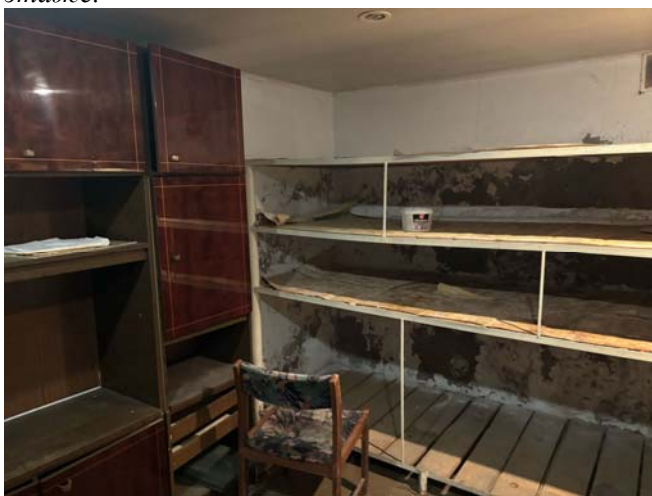
Илл. 47. Фото существующего положения домостроения. Вид помещений в подвальном этаже.
