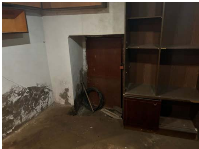
Илл. 46. Фото существующего положения домостроения. Вид помещений в подвальном этаже.
