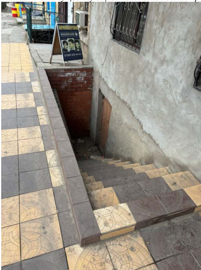
Илл. 36. Фото существующего положения домостроения. Вид на ход в подвальное помещение со стороны ул. Таги-Заде.
