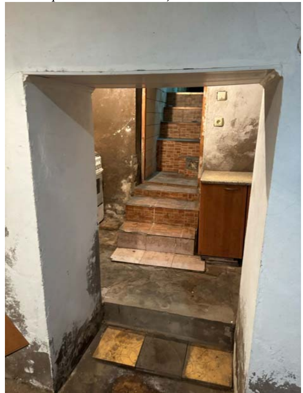
Илл. 44. Фото существующего положения домостроения. Вид лестничного проема на 1 этаж.
