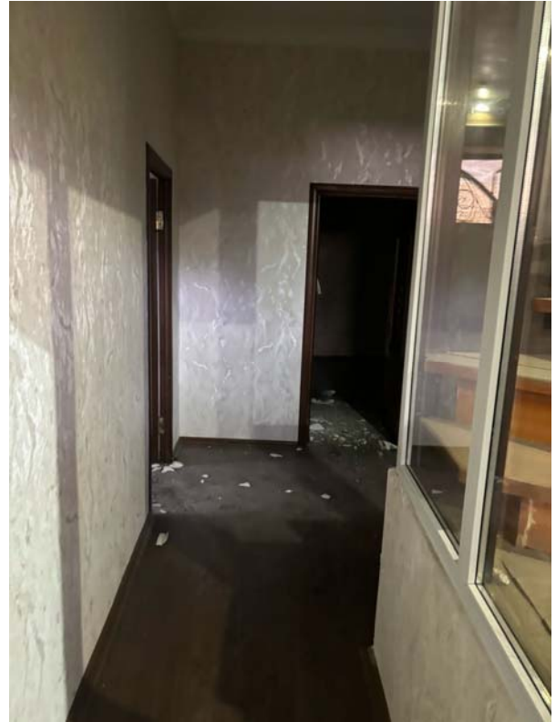
Илл. 42. Фото существующего положения домостроения. Вид помещений на 1 этаже.
