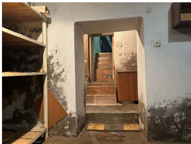
Илл. 48. Фото существующего положения домостроения. Вид помещений в подвальном этаже.
