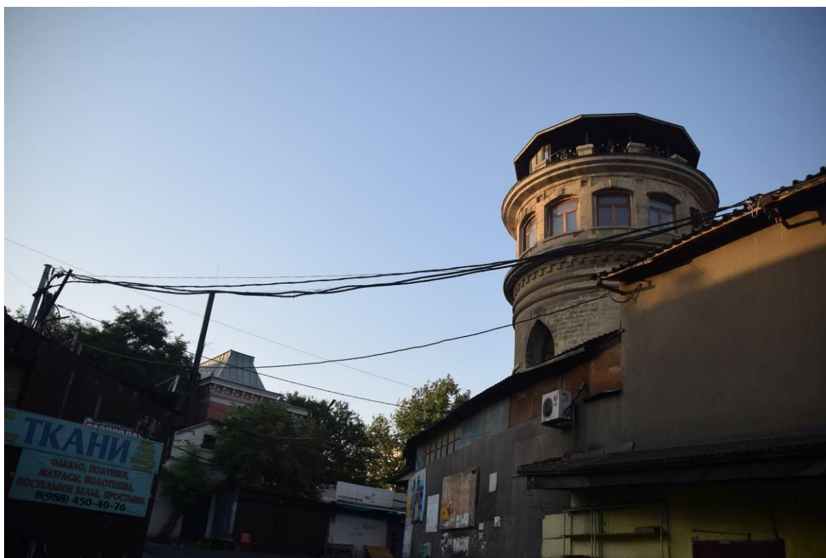
Фото 10. Вид на исследуемое сооружение, смотровая площадка и крыша
