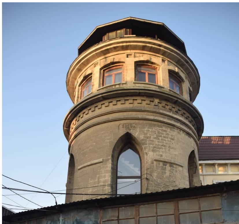
Фото 9. Вид на тягу и венчающий карниз сооружения, смотровая площадка и крыша
