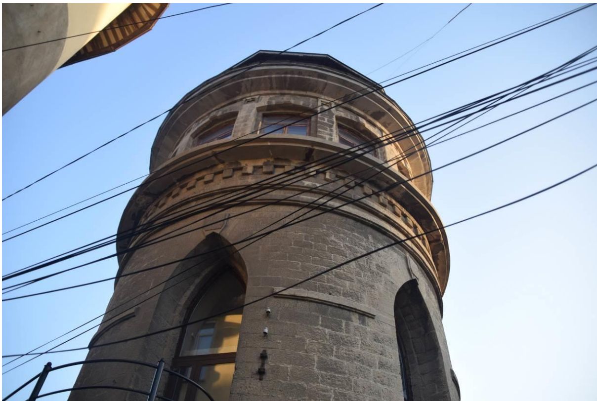
Фото 6. Вид на тягу и венчающий карниз сооружения
