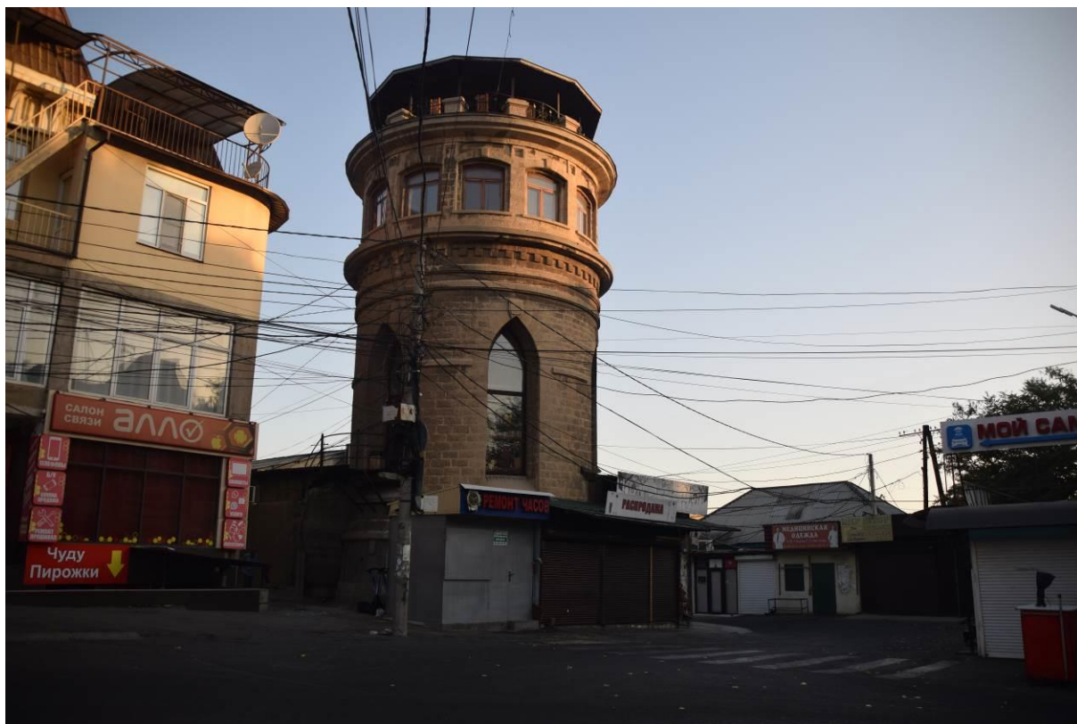
Фото 3. Вид объекта с угла ул. Эмирова
