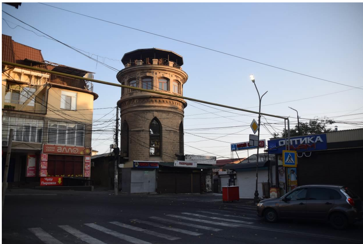
Фото 2. Общий вид объекта с угла ул. Эмирова
