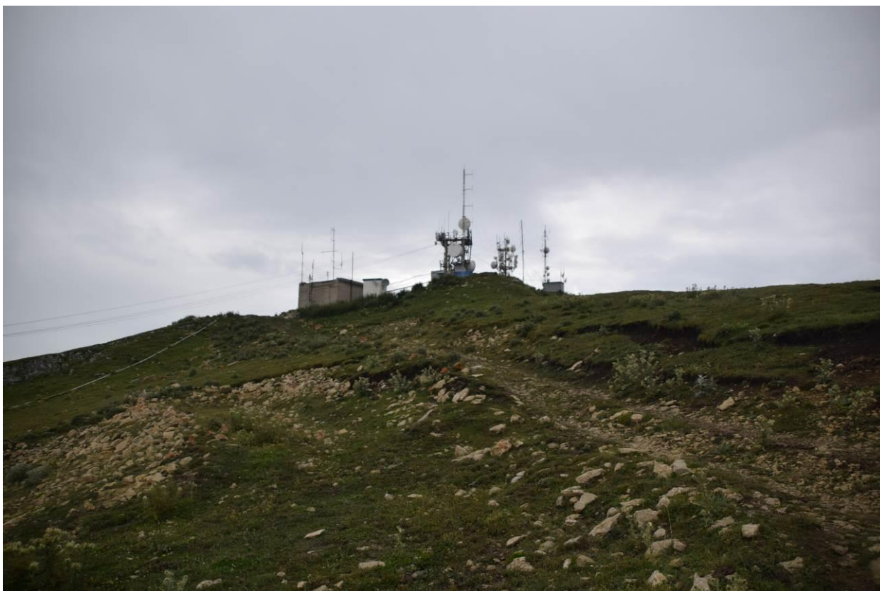
Фото 9. Общий вид на исследуемый объект, подъем на вершину, вышка связи
