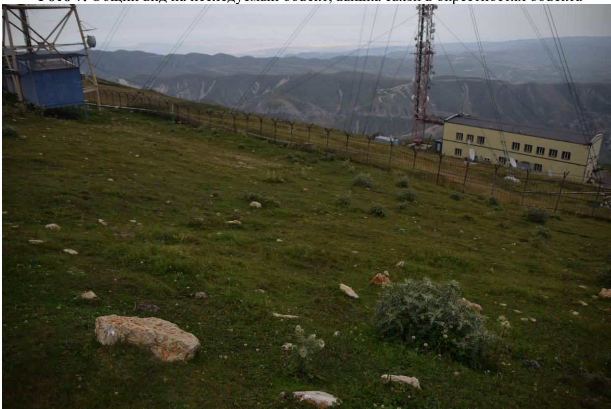
Фото 8. Общий вид на исследуемый объект, территория вышки связи
