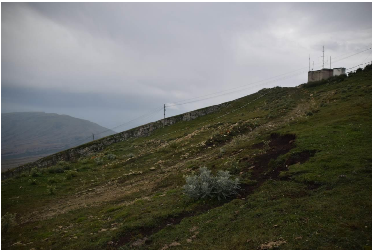
Фото 12. Общий вид на исследуемый объект, подъем на вершину, вышка связи
