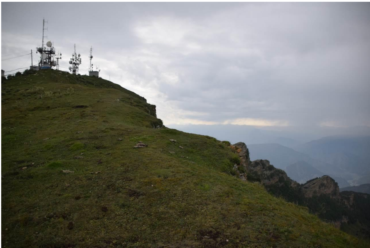
Фото 11. Общий вид на исследуемый объект, подъем на вершину, вышка связи
