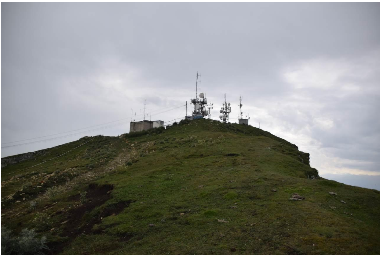
Фото 10. Общий вид на исследуемый объект, подъем на вершину, вышка связи
