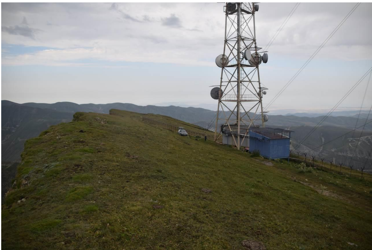
Фото 13. Общий вид на исследуемый объект, вышка связи в окрестностях объекта
