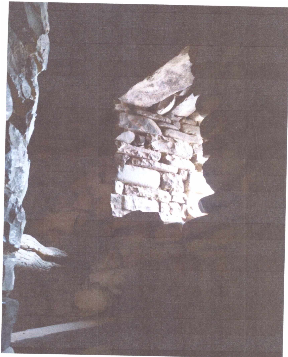
Проем в стене минарета. Вид изнутри башни
