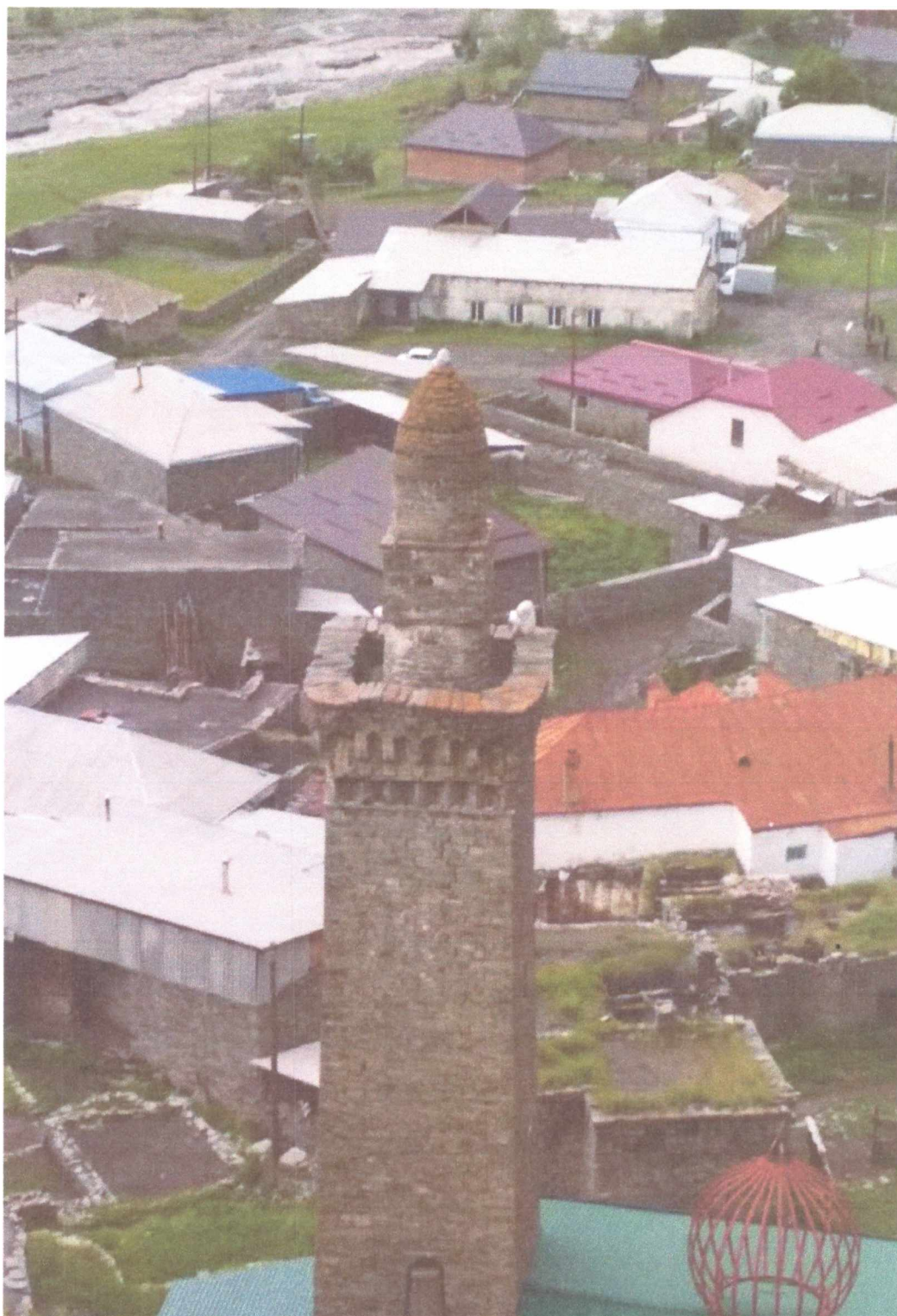
Общий вид минарета со стороны склона. Северный фасад
