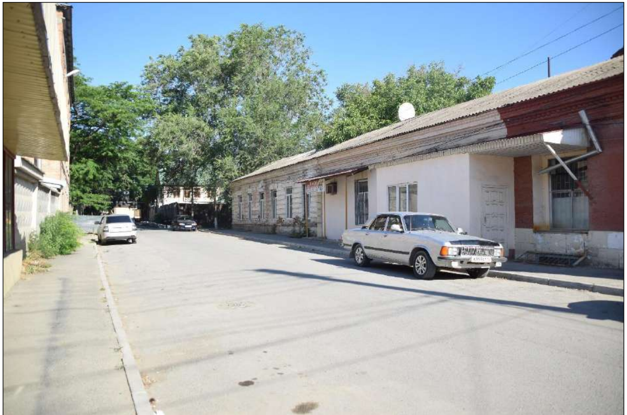
Т.ф. 3.1.2 Исторически ценный градоформирующий объект. Административное здание (г. Хасавюрт, ул. Абукова, 59). Вид с ул. Абукова, с юго-запада.
