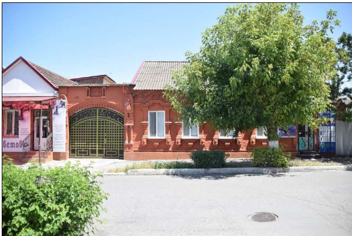
Т.ф. 3.12.2 Исторически ценный градоформирующий объект. Дом жилой (г. Хасавюрт, ул. Тотурбиева, 83). Вид с ул. Тотурбиева, с запада.
