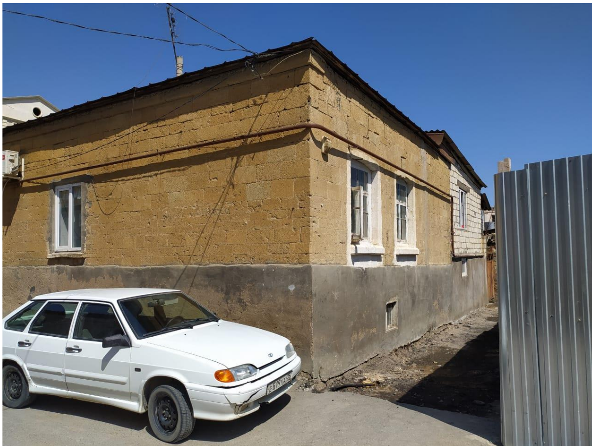
Фото 3. Вид на пристройку западного фасада здания с ул. 1-я Продольная.
