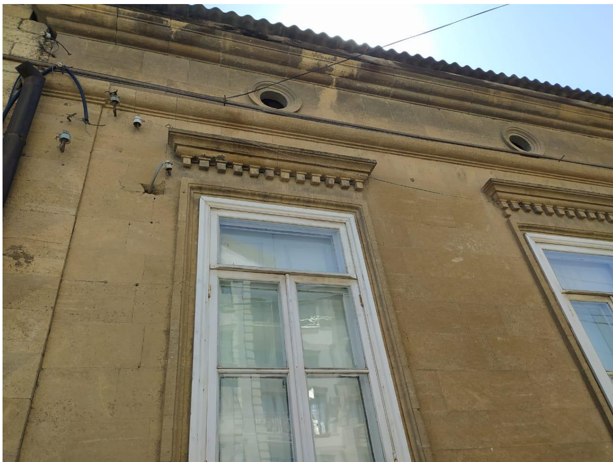
Фото 5. Вид на фрагмент северного фасада с профилированным наличником окна, сандриком и антаблементом.
