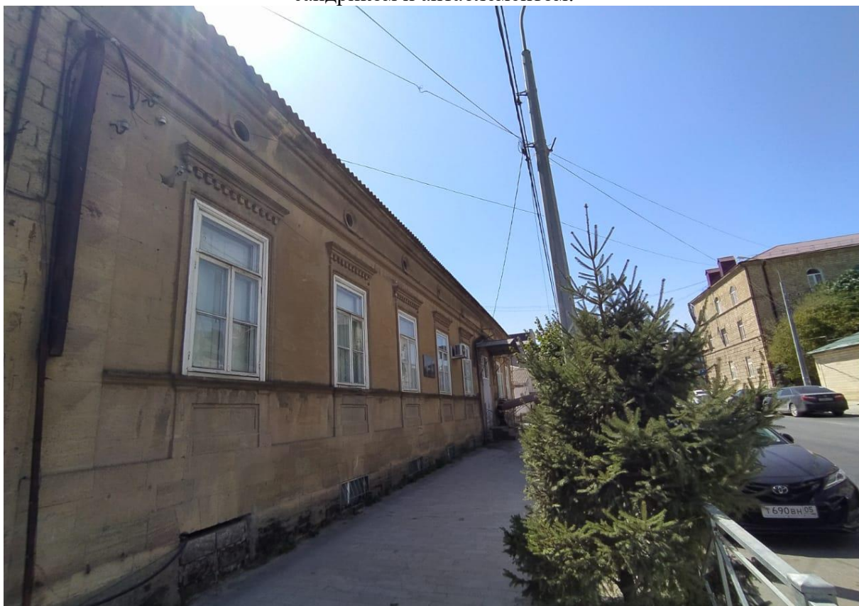
Фото 6. Вид на северный фасад исследуемого здания вдоль по ул. Курбанова
