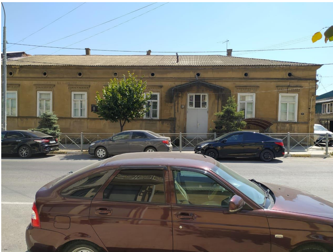
Фото 1. Вид на северный фасад здания с тротуара по ул. Курбанова.
