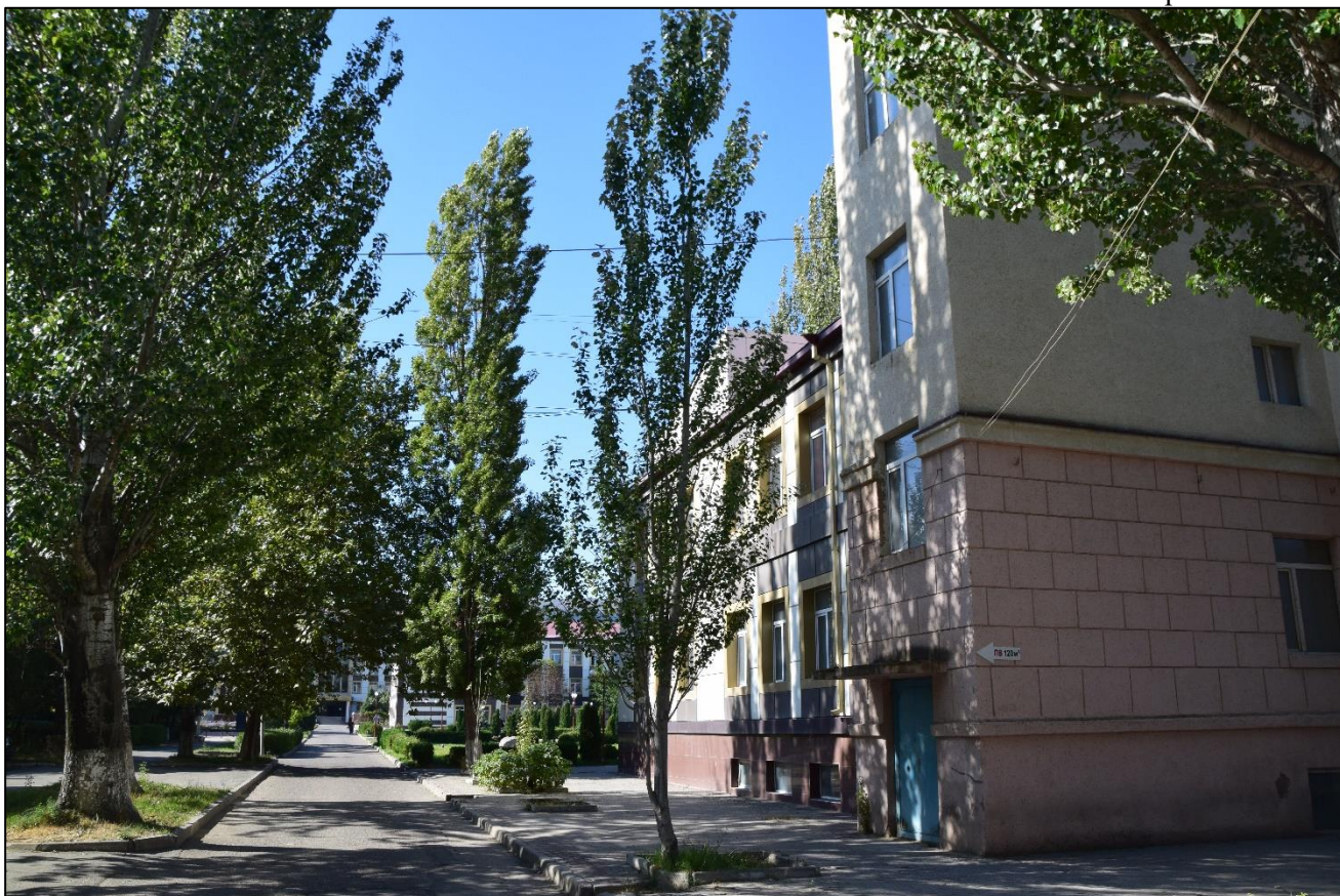
Т.ф. 9. Республика Дагестан, г.Махачкала, ул. Ярагского, д.57. «Здание, в котором в 1941-1945 гг. находился эвакуогоспиталь № 2924». Дворовый (юго-восточный) фасад исследуемого объекта. Фото: ООО «Сигма-Строй», октябрь 2020 г.
