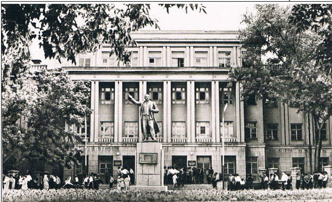
Главный (северо-западный) фасад Педагогического института имени Гамзата Цадасы (исследуемый объект) и памятник В.И. Ленину. Открытка 1967 г. Автор фото: Б.Кудояров. Источник: интернет ресурс. Режим доступа: https://pastvu.com
