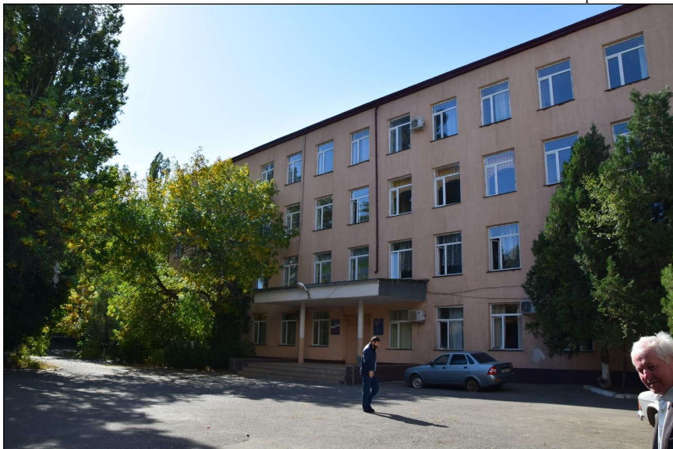
Т.ф. 27. Застройка с востока от исследуемого объекта. Вид с северо-запада. Фото: ООО «Сигма-Строй», октябрь 2020 г.
