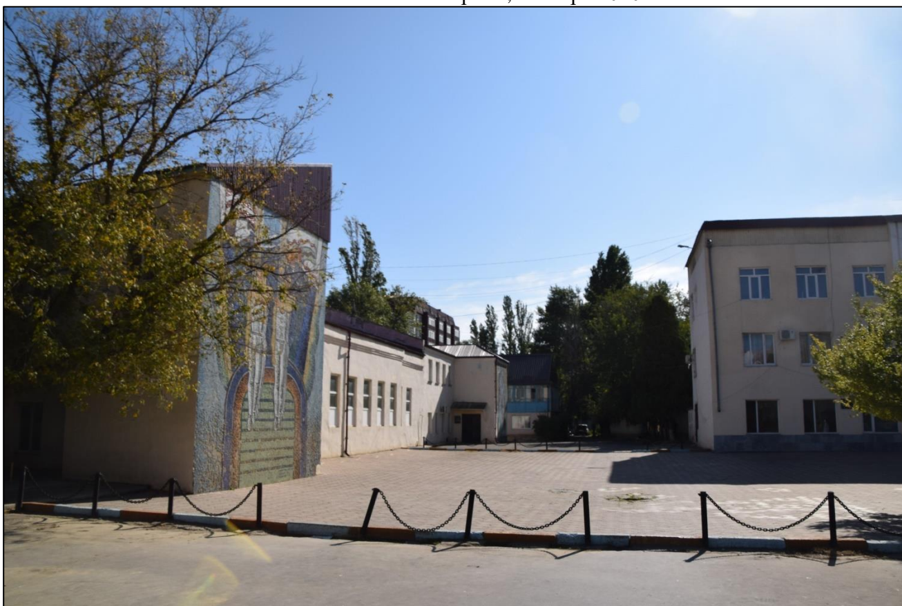
Т.ф. 26. Застройка с юго-востока от исследуемого объекта. Вид с запада. Фото: ООО «Сигма-Строй», октябрь 2020 г.
