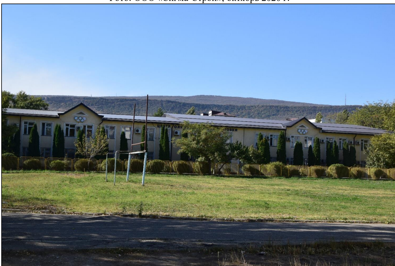
Т.ф. 18. Застройка с юга от исследуемого объекта. Вид с севера. Фото: ООО «Сигма-Строй», октябрь 2020 г.
