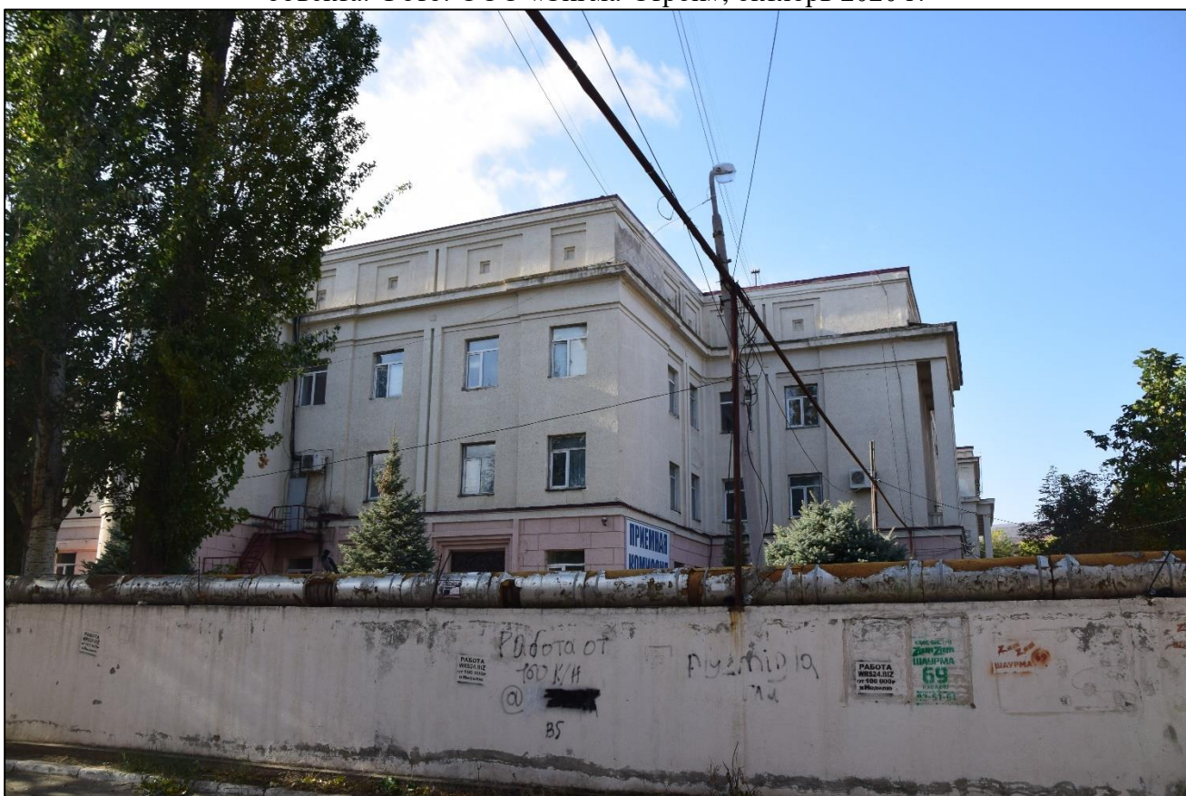
Т.ф. 10. Республика Дагестан, г.Махачкала, ул. Ярагского, д.57. «Здание, в котором в 1941-1945 гг. находился эвакуогоспиталь № 2924». Боковой (северо-восточный) фасад исследуемого объекта. Фото: ООО «Сигма-Строй», октябрь 2020 г.
