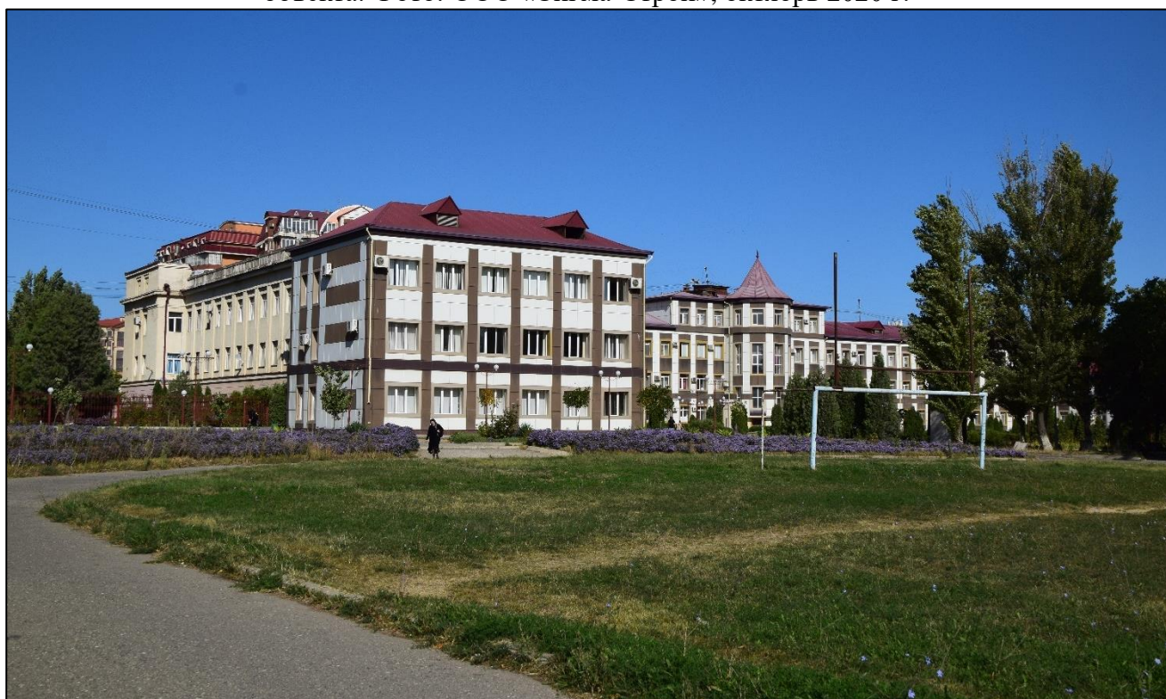
Т.ф. 6. Республика Дагестан, г.Махачкала, ул. Ярагского, д.57. «Здание, в котором в 1941-1945 гг. находился эвакуогоспиталь № 2924». Общий вид исследуемого объекта с юга, с прилегающей территории. Фото: ООО «Сигма-Строй», октябрь 2020 г.
