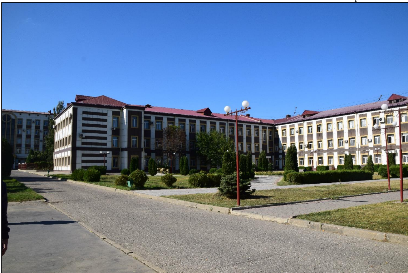
Т.ф. 7. Республика Дагестан, г.Махачкала, ул. Ярагского, д.57. «Здание, в котором в 1941-1945 гг. находился эвакуогоспиталь № 2924». Дворовые (юго-восточный и северо-восточный) фасады исследуемого объекта. Фото: ООО «Сигма-Строй», октябрь 2020 г.
