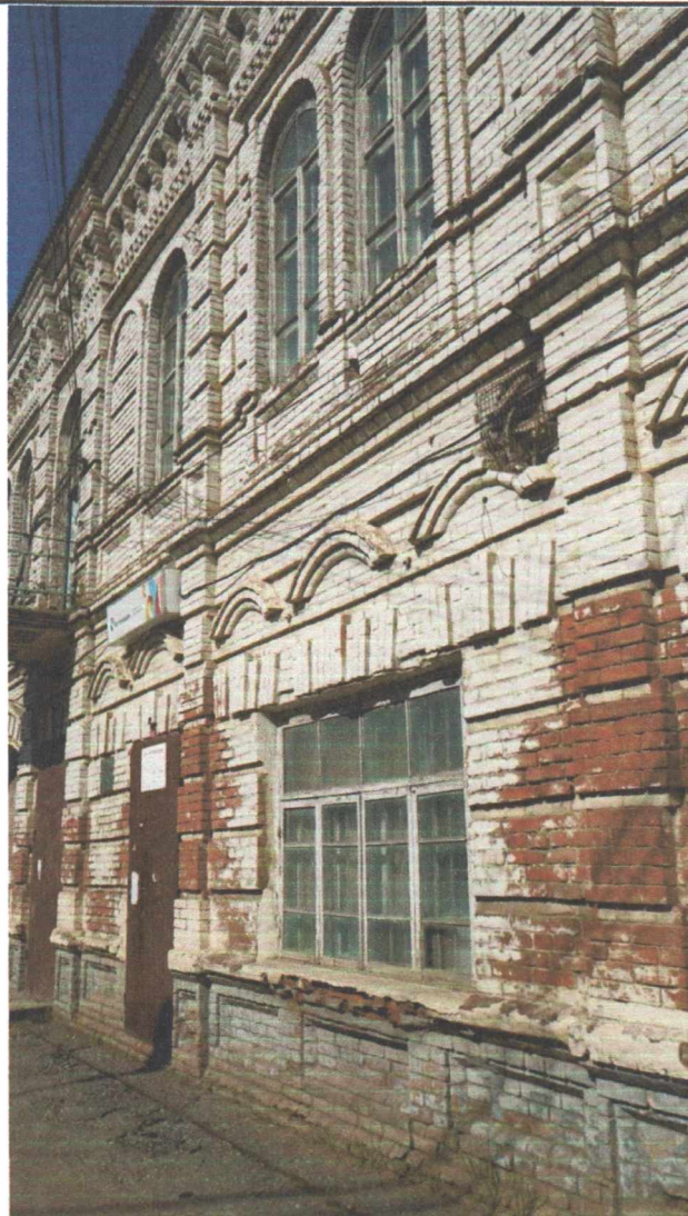
Фото 4. Объект культурного наследия регионального значения «Здание почты», расположенный по адресу: Республика Дагестан, г. Хасавюрт, ул. Тотурбиева, 42 (фактический адрес: ул. Увайса Мусаева, 49). Фрагмент западного фасада объекта культурного наследия в северо-восточном направлении. Кирпичное двухэтажное здание. Фасад рустован на всю высоту здания. Оконные проёмы первого этажа прямоугольной формы с клинчатыми перемычками, заполнены деревянными оконными блоками. Подоконное пространство второго этажа выделено вставкой из ряда прямоугольных филенок. Спаренные оконные проёмы второго этажа с полуциркульным завершением объединены прямоугольной рамкой. Оконные проёмы заполнены деревянными оконными блоками. Ряды оконных проёмов разделены рустованными пилястрами. Над оконными проемами второго этажа проходит двойной ряд сухариков. Завершает здание многоуровневый карниз с аркатурно-городчатым поясом под ним. Май 2022.
