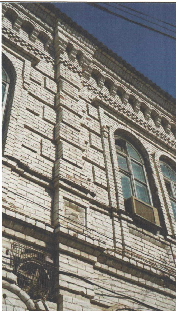
Фото 6. Объект культурного наследия регионального значения «Здание почты», расположенный по адресу: Республика Дагестан, г. Хасавюрт, ул. Тотурбиева, 42 (фактический адрес: ул. Увайса Мусаева, 49). Фрагмент западного фасада объекта культурного наследия в юго-восточном направлении. Кирпичное двухэтажное здание. Фасад рустован на всю высоту здания. Подоконное пространство второго этажа выделено вставкой из ряда прямоугольных филенок. Спаренные оконные проёмы второго этажа с полуциркульным завершением объединены прямоугольной рамкой. Ряды оконных проёмов разделены рустованными пилястрами. Оконные проёмы заполнены деревянными оконными блоками. Над оконными проемами второго этажа проходит двойной ряд сухариков. Завершает здание многоуровневый карниз с аркатурно-городчатым поясом под ним. Май 2022.
