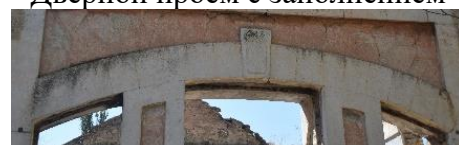
Единая перемычка с замковым камнем на центральном ризалите
