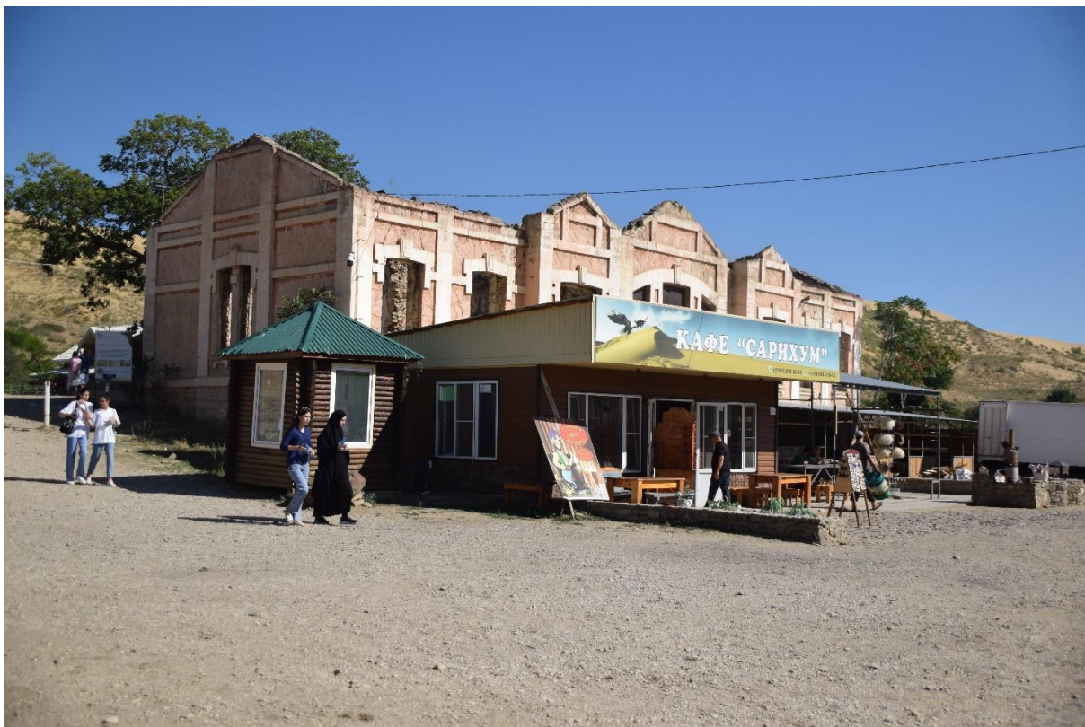
Фото 1. Общий вид на исследуемый объект с южной стороны.
