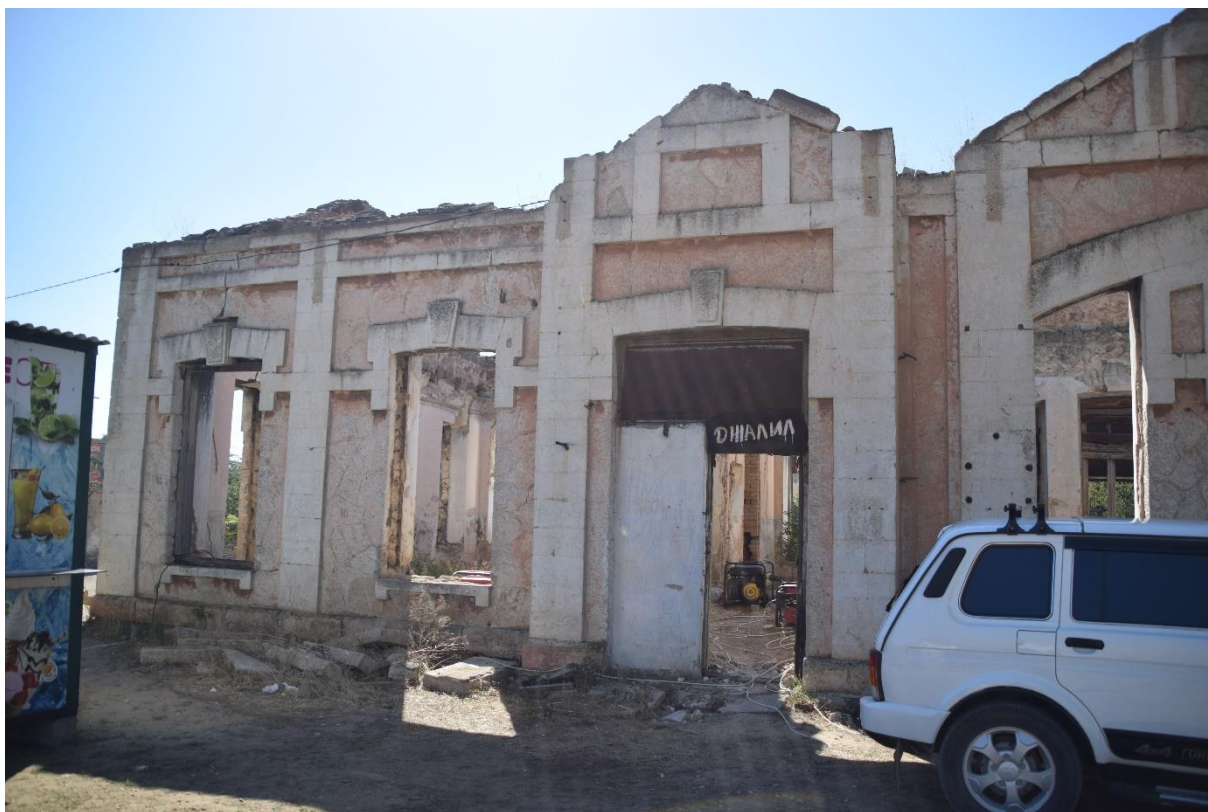
Фото 7. Фрагмент северного фасада.
