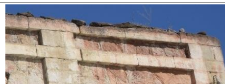
Карниз южного фасада
