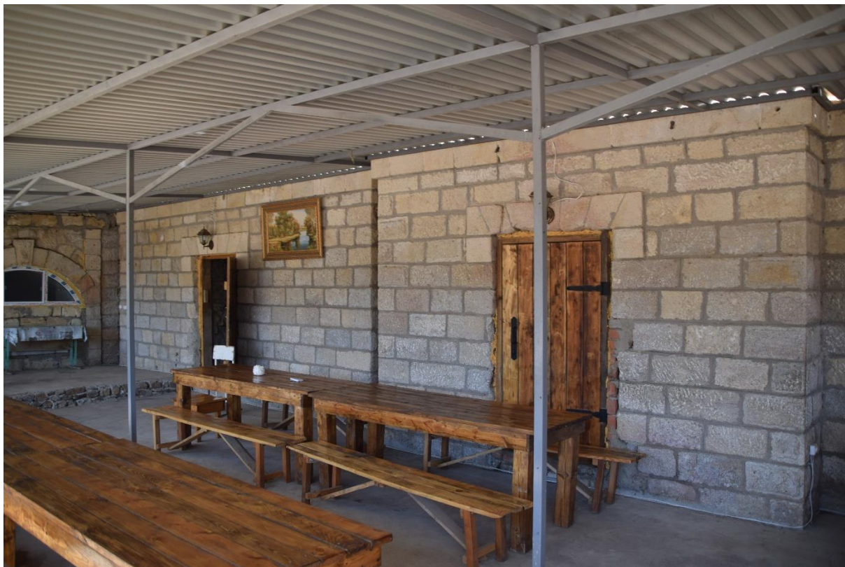
Фото 13. Вид на помещение галереи в уровне цоколя, дверные и оконный проёмы.
