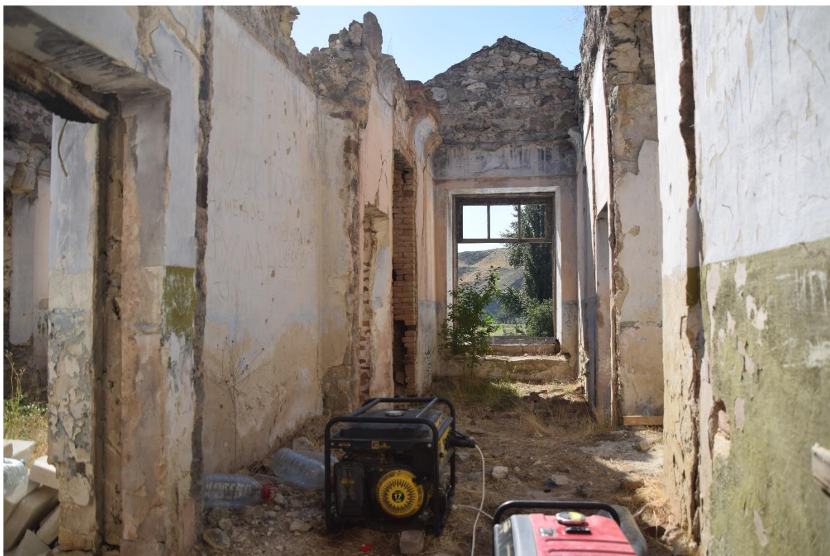
Фото 10. Видовая точка на внутренние стены и оконный проём южного фасада.
