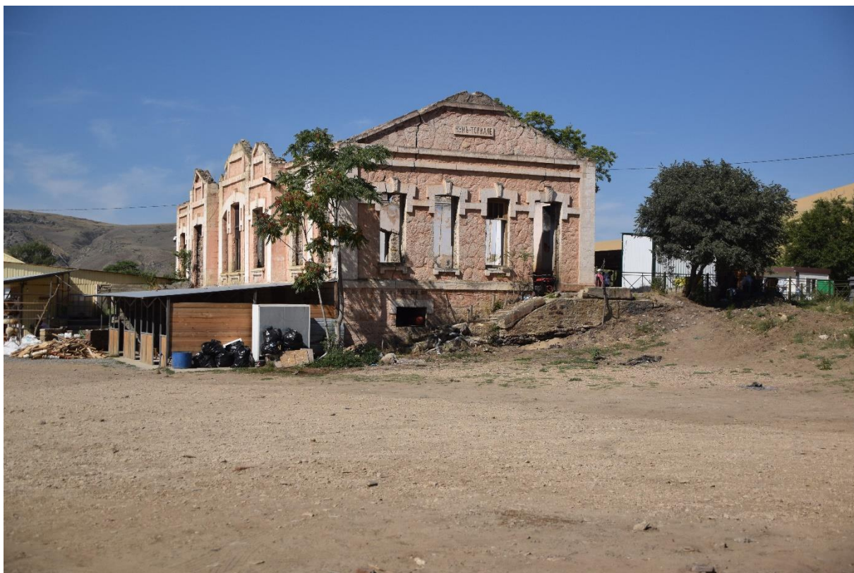
Фото 3. Вид на юго-восточный фасад исследуемого объекта
