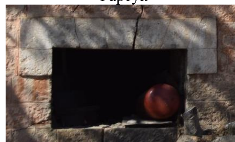
Оконный проём цоколя
