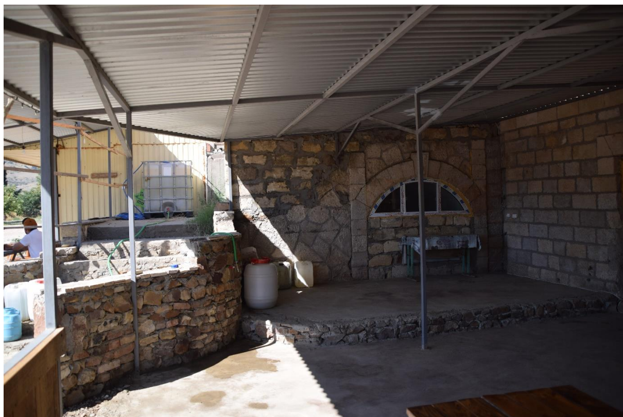
Фото 12. Вид на помещение галереи в уровне цоколя.
