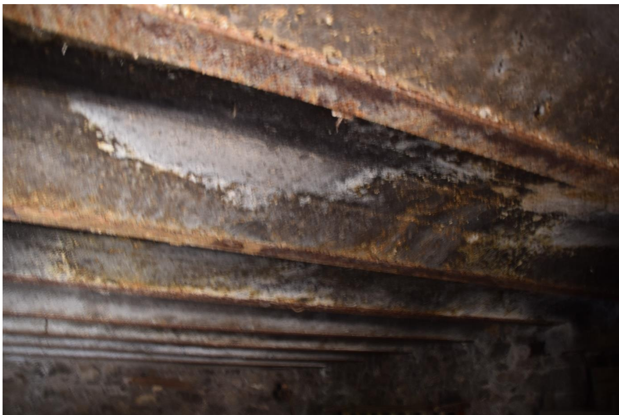
Фото 14. Вид на цилиндрические своды, расположенные над помещениями цоколя.
