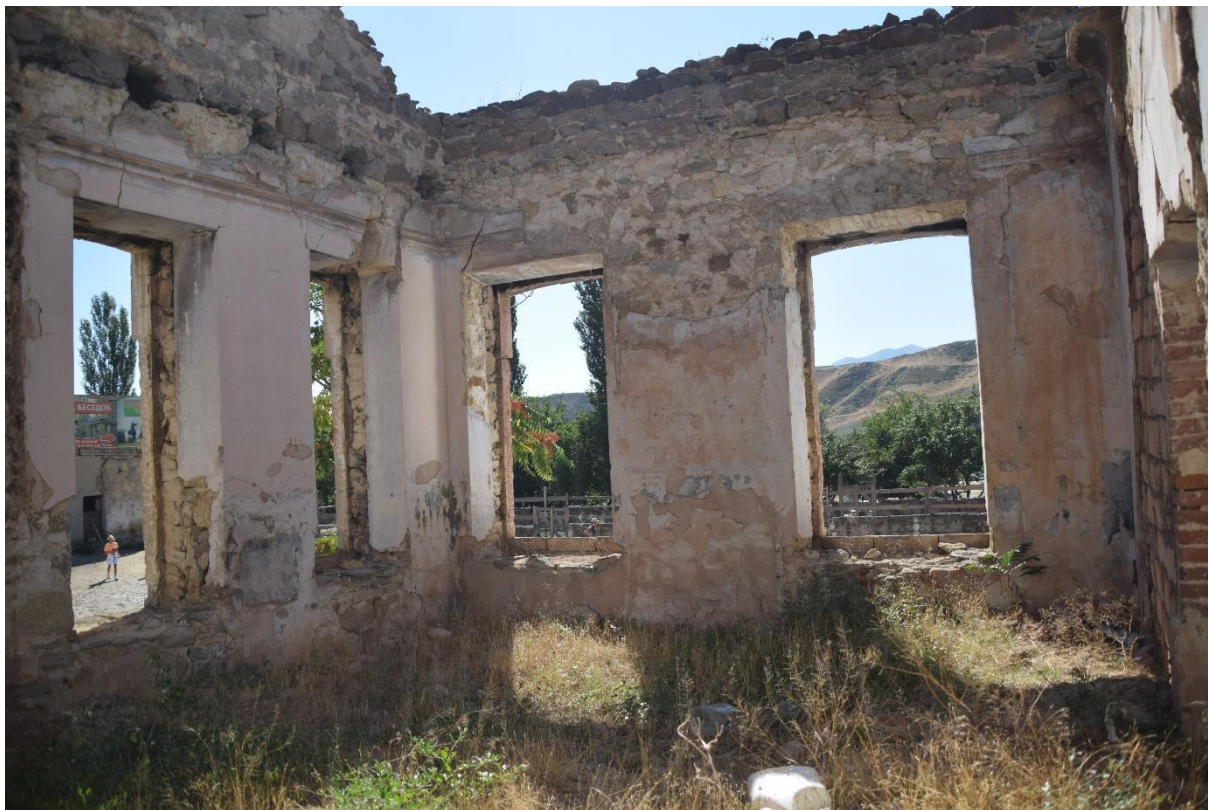
Фото 9. Видовая точка изнутри на оконные проёмы и отверстия для деревянных балок.
