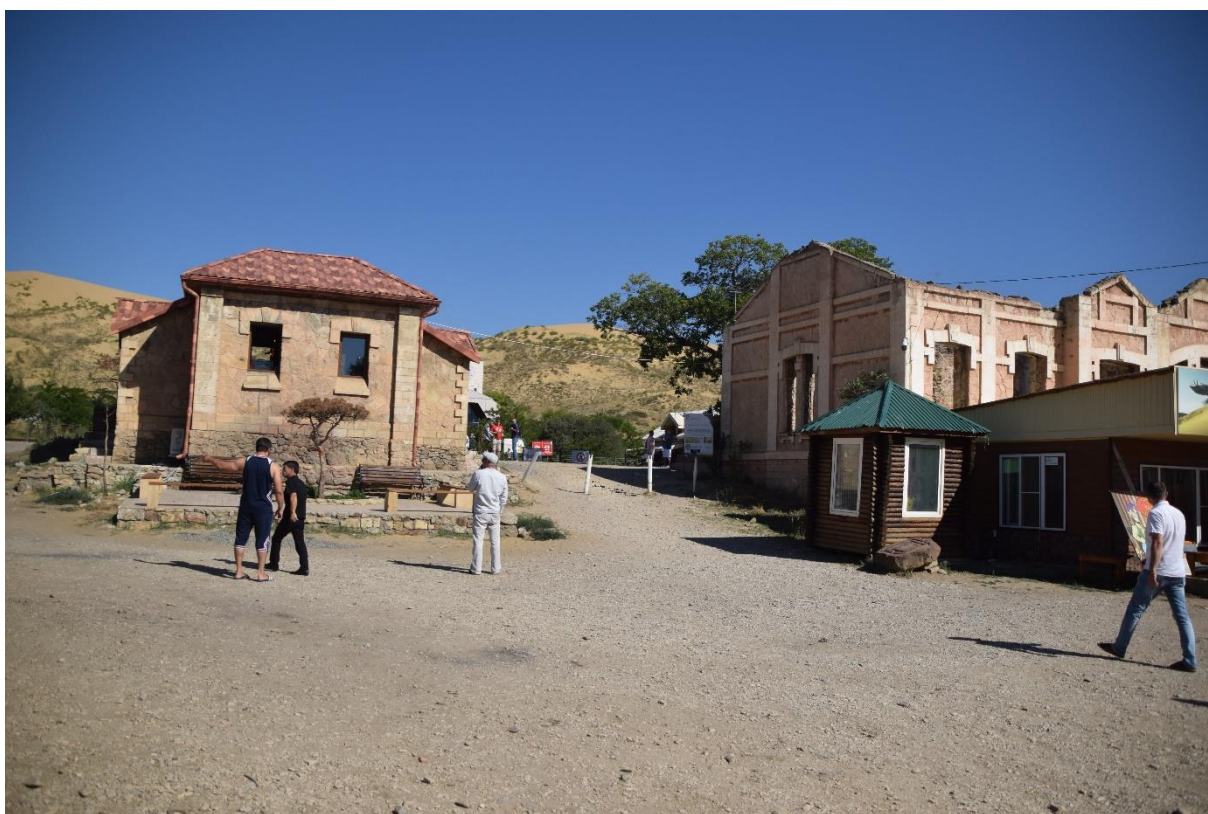
Фото 2. Вид на объект и окружающую застройку с южной стороны.
