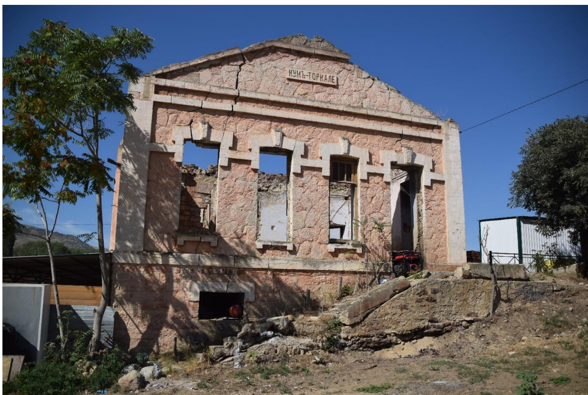
Фото 8. Общий вид восточного фасада.
