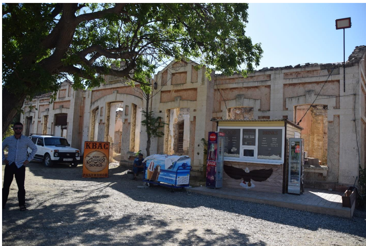
Фото 6. Общий вид северного фасада.
