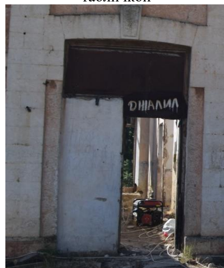
Дверной проём с заполнением
