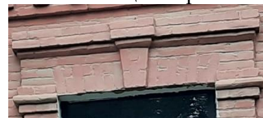
Прямая клинчатая перемычка с фрагментом наличника и замковым камнем
