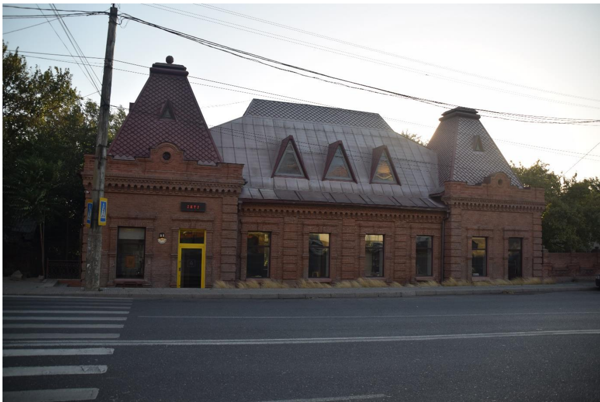
Фото 1. Общий вид на исследуемый объект с ул. Мирзабекова
