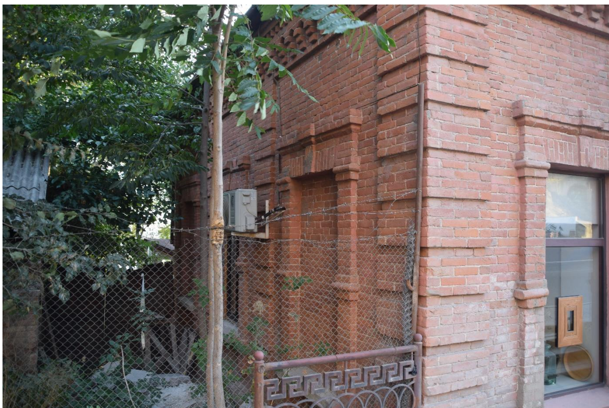
Фото 4. Фрагмент западного фасада исследуемого здания
