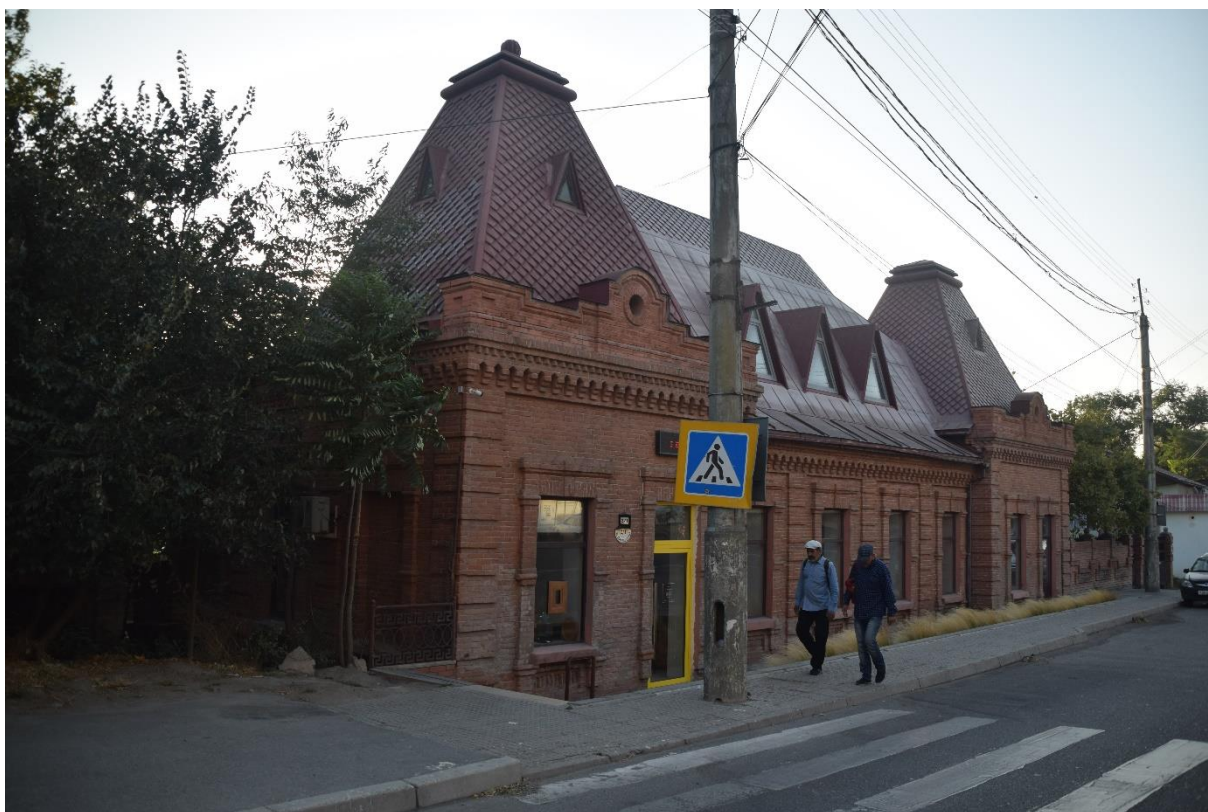
Фото 2. Вид на южный фасад (главный фасад) с ул. Мирзабекова
