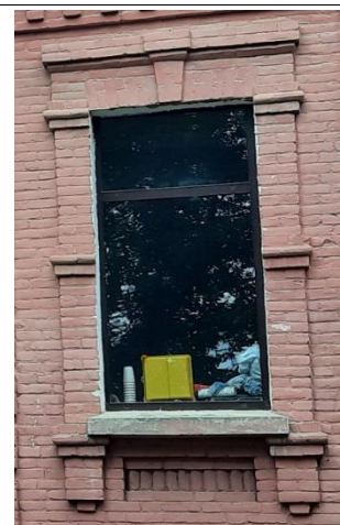
Оконный проём и наличник
