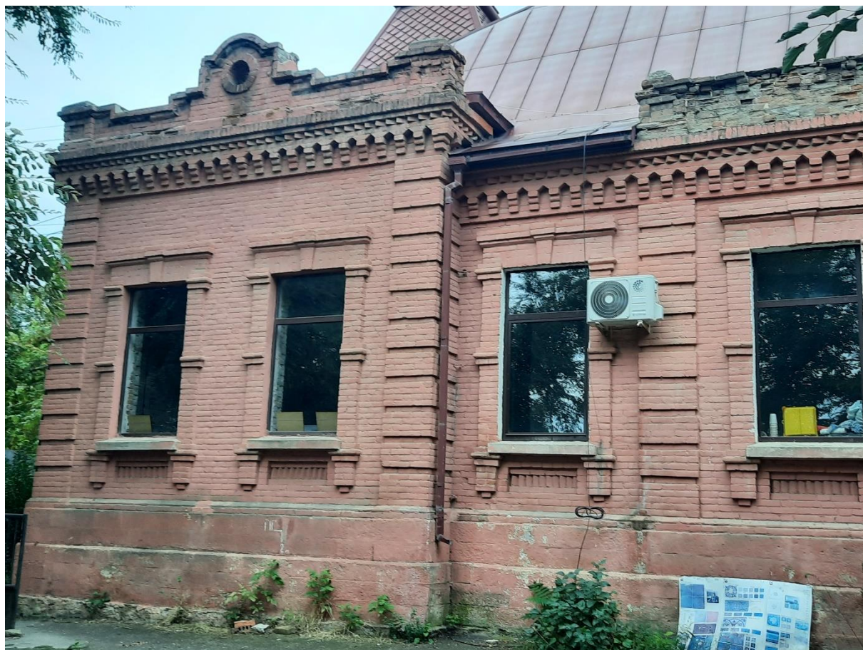
Фото 7. Видовая точка на фрагмент северного фасада с ризалитом
