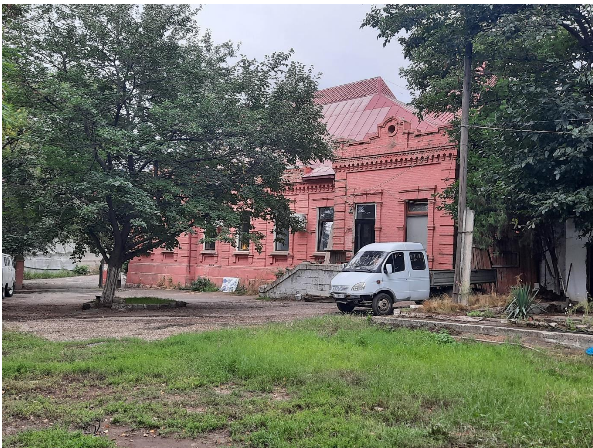
Фото 6. Общий вид на северный фасад исследуемого объекта
