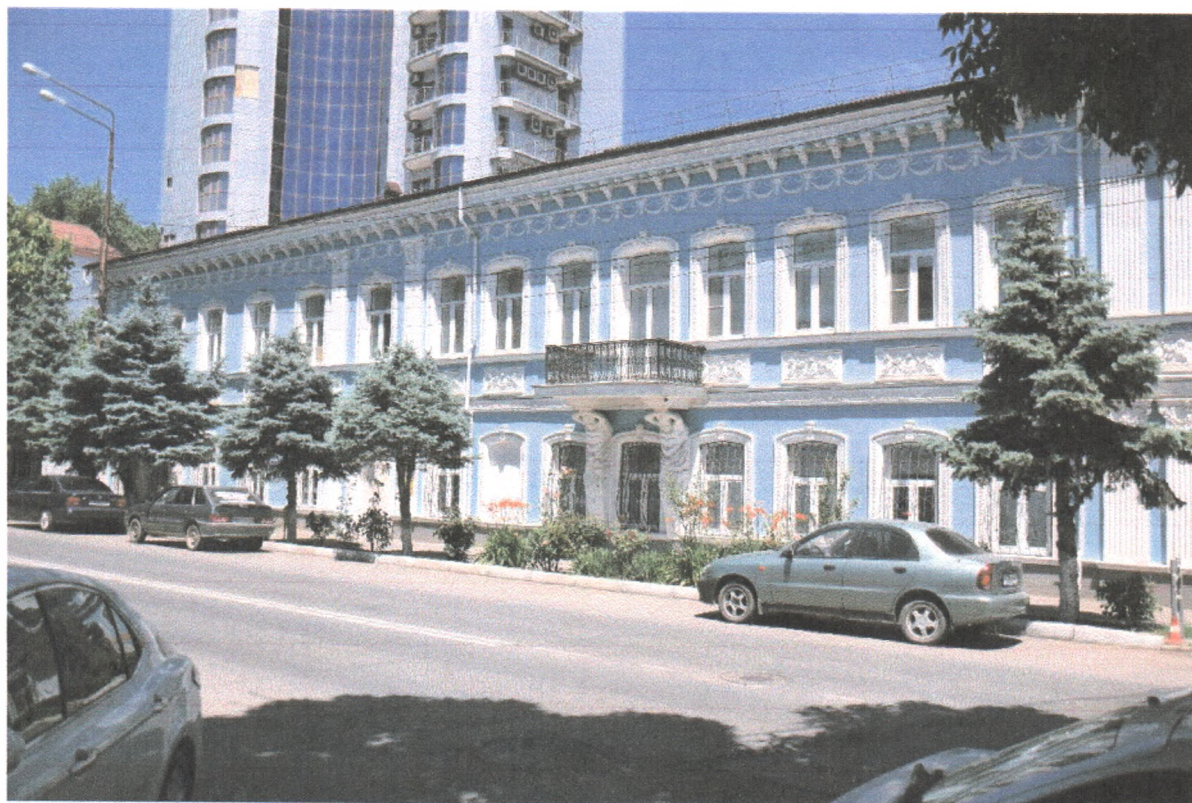
Т.ф.6. Вид на главный фасад.
