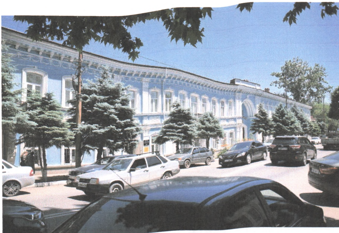
Т.ф.1. Общий вид на главный фасад здания
