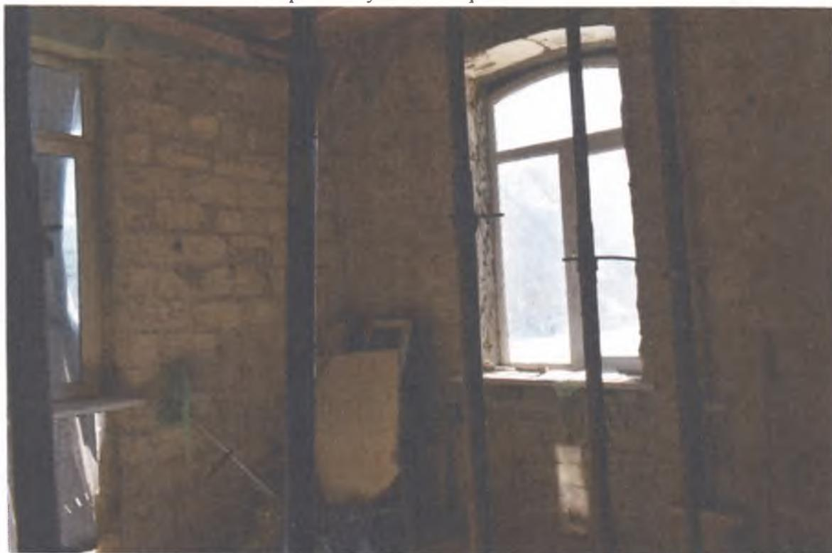
Т.ф.10. Фрагмент интерьера. Вид на сохранившийся исторический фрагмент стены. Оконный проем с лучковой перемычкой
