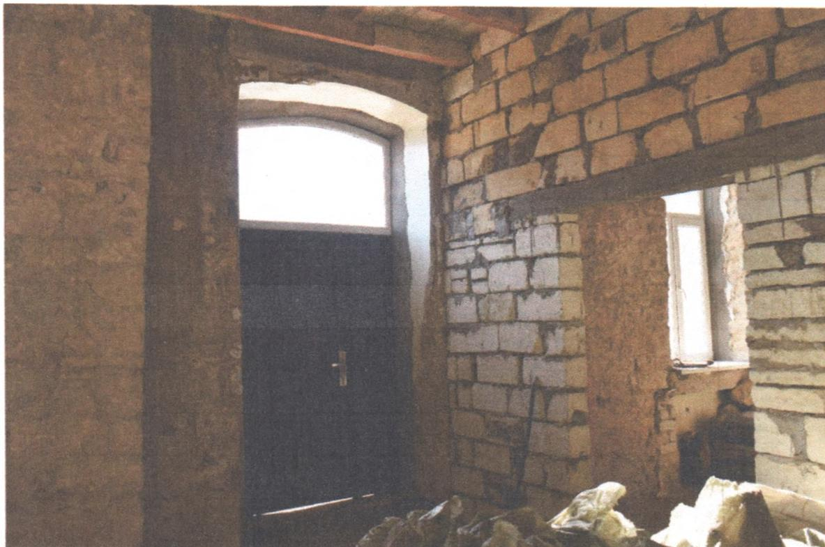
Т.ф.9. Фрагмент интерьера. Вид на сохранившийся исторический фрагмент стены. Дверной проем с лучковой перемычкой
