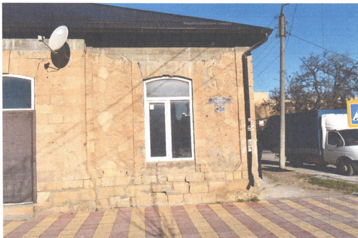
Т.ф.6. Фрагмент юго-восточного фасада: оконный и дверной проемы с лучковыми перемычками. центральный ризалит
