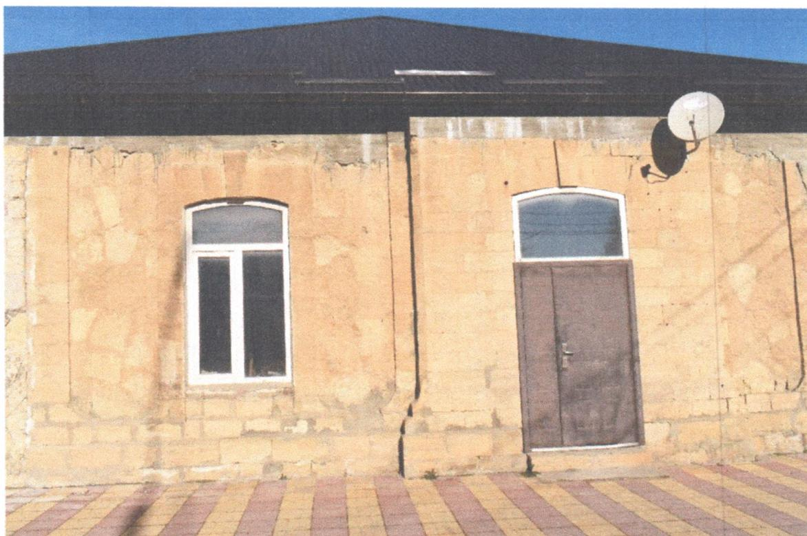
Т.ф.5. Фрагмент юго-восточного фасада: оконный и дверной проемы с лучковыми перемычками, центральный ризалит
