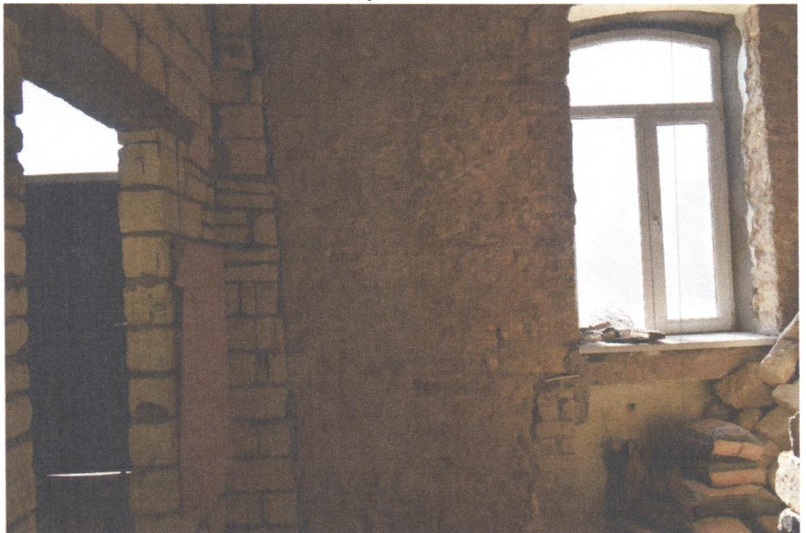
Т.ф.8. Фрагмент интерьера. Вид на сохранившийся исторический фрагмент стены. Оконный проем с лучковой перемычкой
