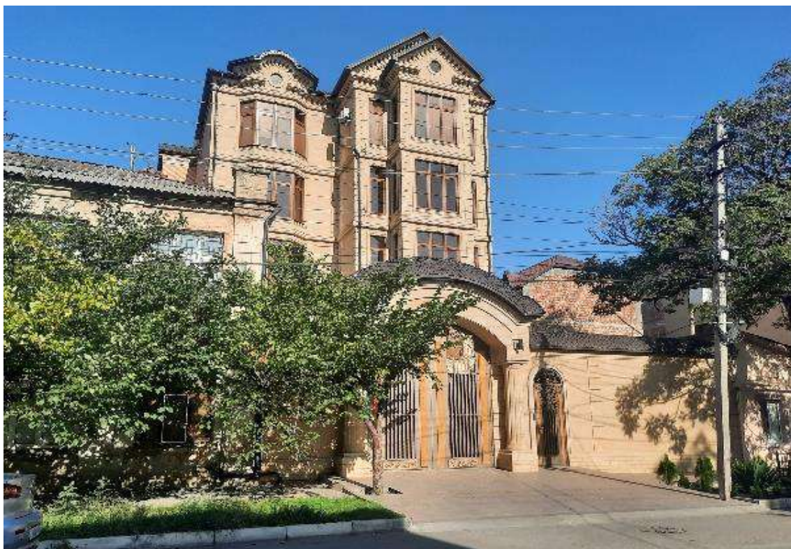
Т.ф. 39. Ул. Гаида Далгата, 28. Здание современной застройки, адаптированное к характеру исторической градостроительной среды. Общий вид с юго-востока.
