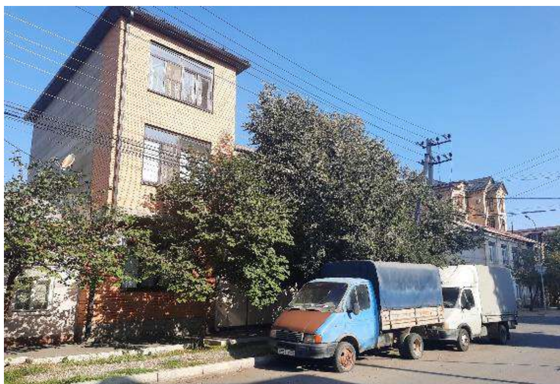
Т.ф. 37. Ул. Гамида Далгата, 32. Здание современной застройки, адаптированное к характеру исторической градостроительной среды. Общий вид с юга.
