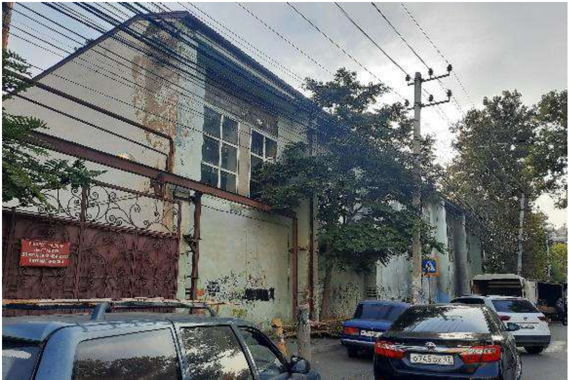
Т.ф. 32. Ул. Нурадилова. Объект, нейтральный по своим объемно-пространственным характеристикам к историко-градостроительной среде. Общий вид с юго-запада.
