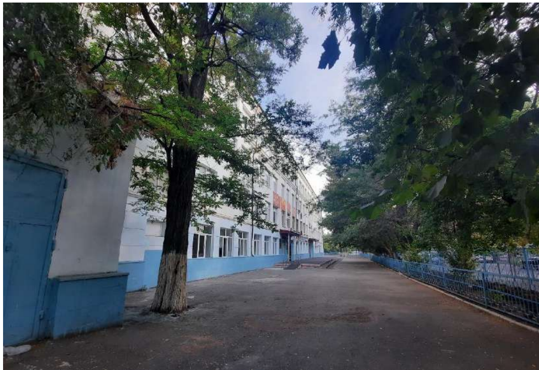
Т.ф. 01. Общий вид на Объект исследования с юго-запада.
