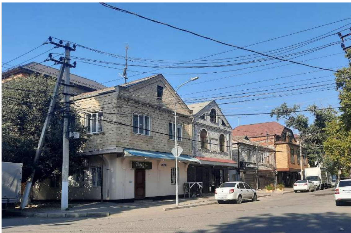
Т.ф. 27. Ул. Нурадилова, 26, 26А, Абубакарова, 35. Здания современной застройки, адаптированные к характеру исторической градостроительной среды (слева направо). Общий вид с востока.
