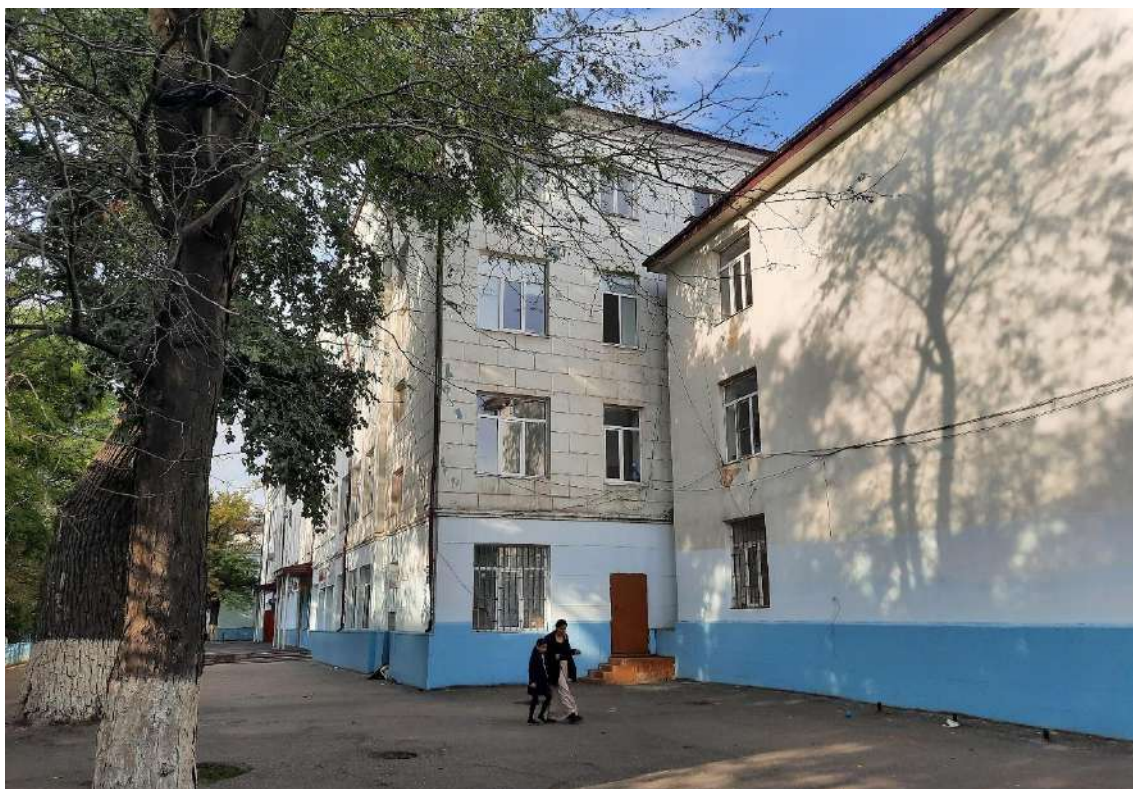
Т.ф. 05. Общий вид на Объект исследования с северо-востока.
