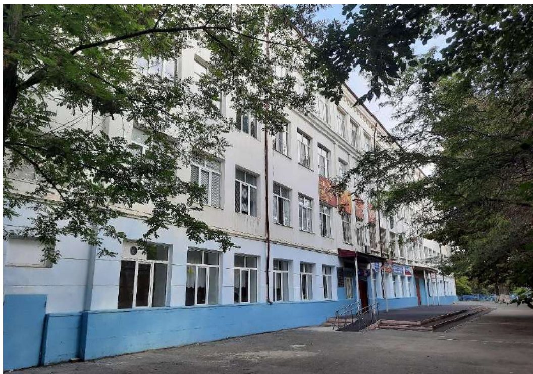
Т.ф. 02. Общий вид на Объект исследования с юго-запада.
