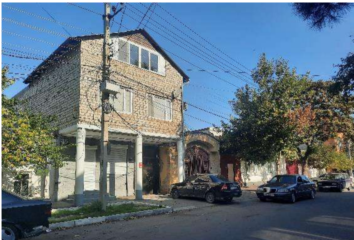
Т.ф. 36. Ул. Гамида Далгата, 36, 34 (справа налево). Здание современной застройки, адаптированное к характеру исторической градостроительной среды; здание исторической застройки и застройки традиционного типа. Общий вид с юга.
