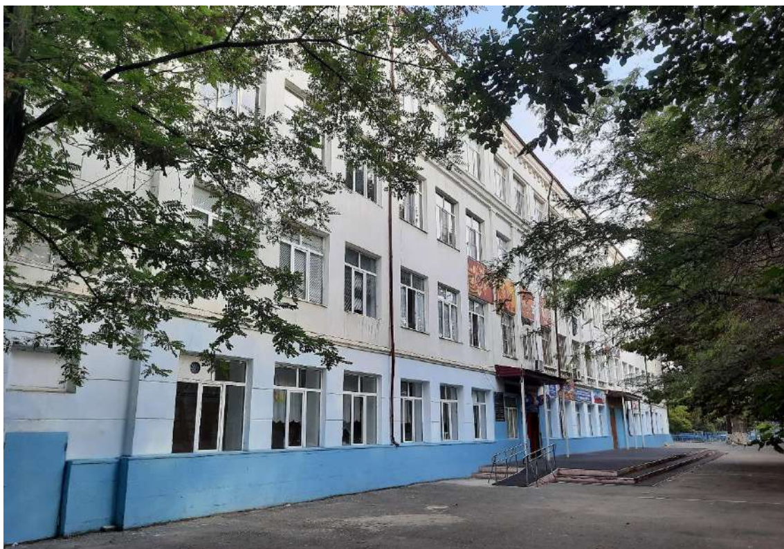
Т.ф. 02. Общий вид с юга на Объект исследования.
