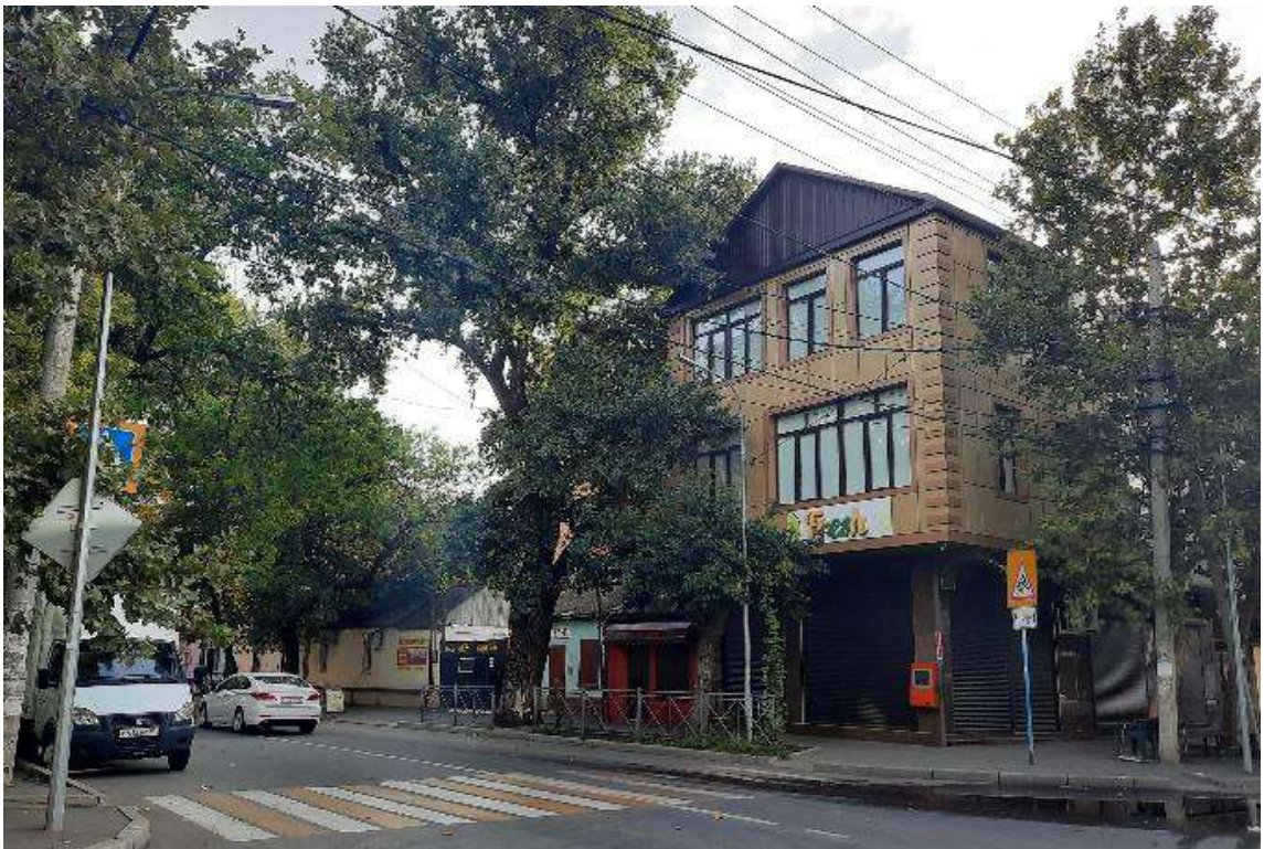
Т.ф. 35. Ул. Нурадилова, 11к1. Здание современной застройки, адаптированное к характеру исторической градостроительной среды. Общий вид с запада.
