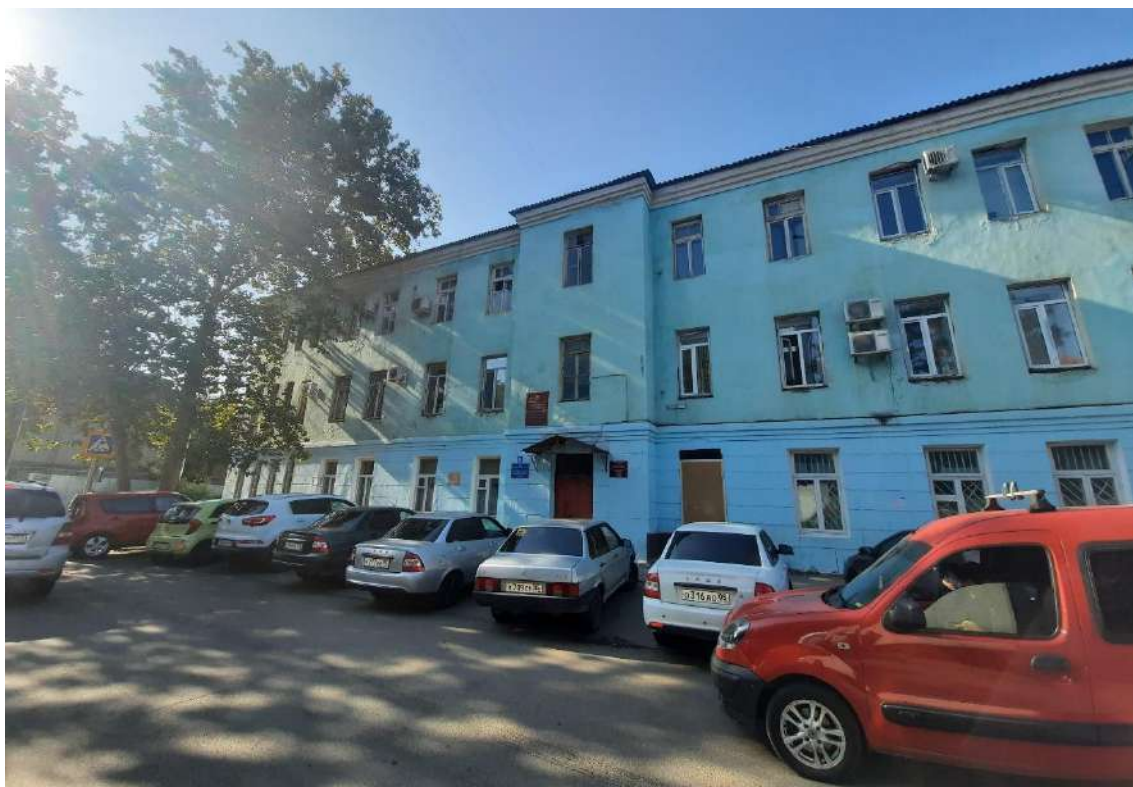
Т.ф. 28. Ул. Нурадилова, 24. Объект, нейтральный по своим объемно-пространственным характеристикам к историко-градостроительной среде. Общий вид с северо-востока.
