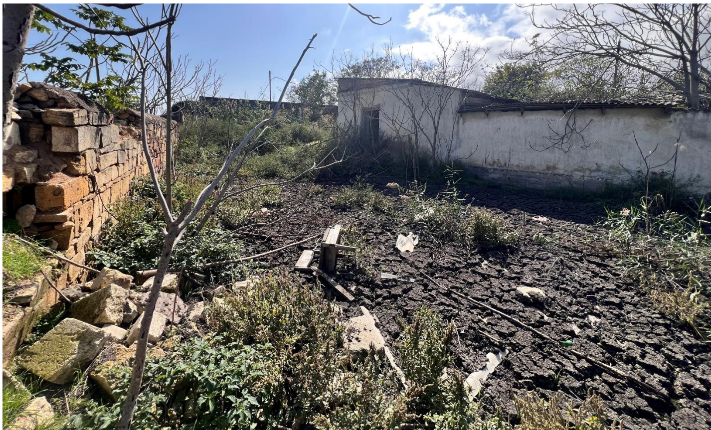
Фото 4. Общий вид территорий, с расположенными строениями, 2025г
