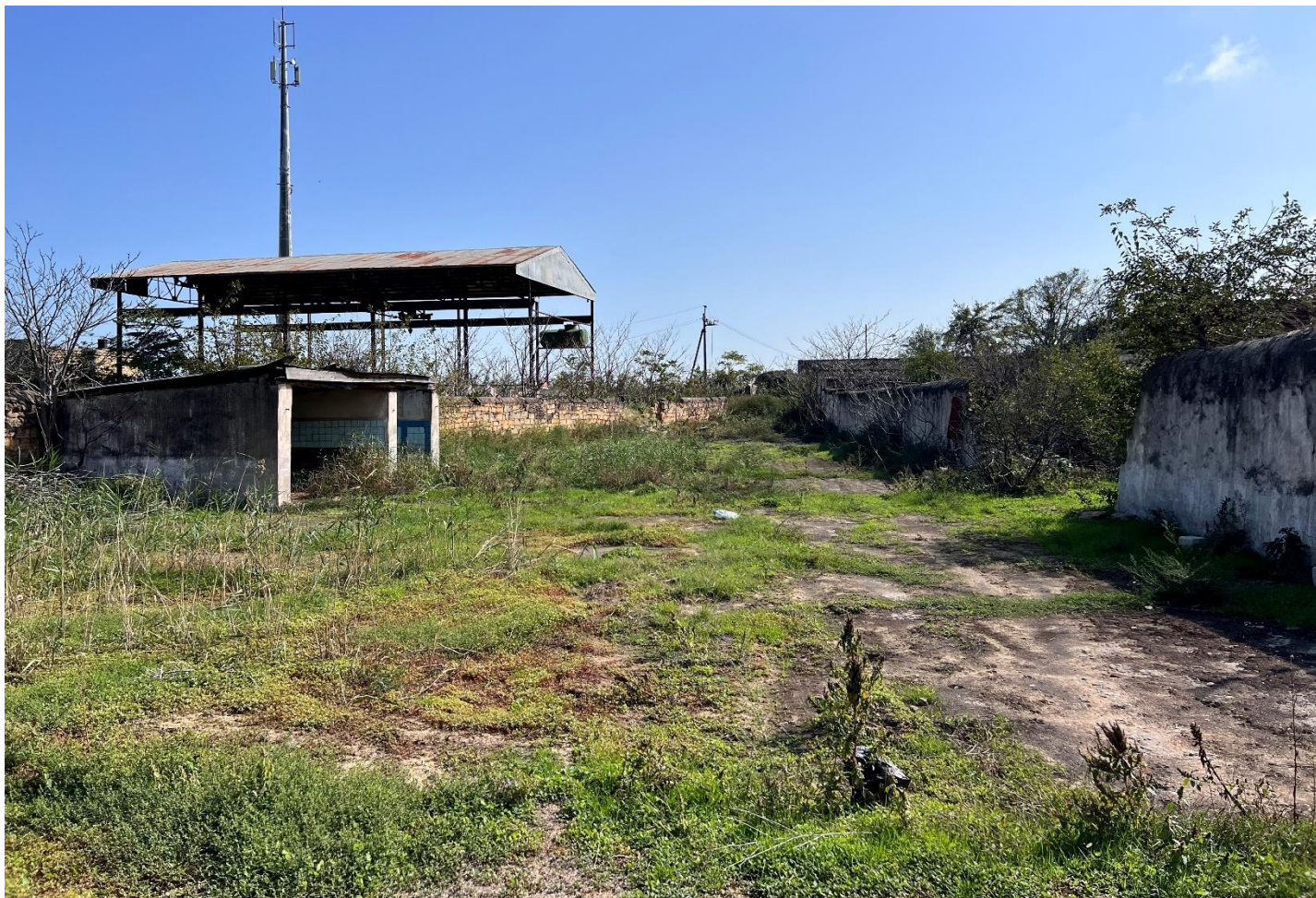
Фото 3. Общий вид территорий, с расположенными строениями, 2025г.
