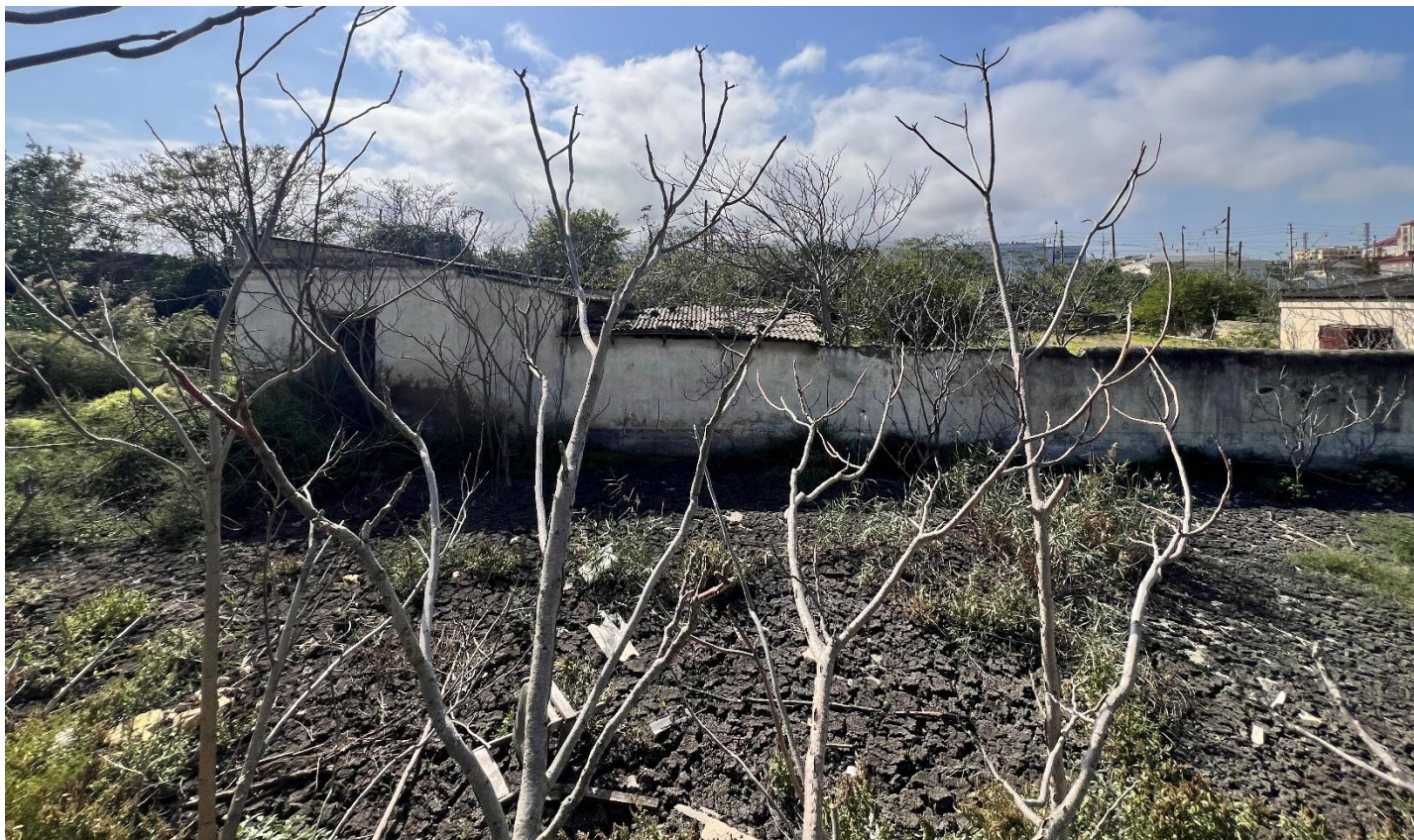
Фото 5. Общий вид территорий, с расположенными строениями, 2025г
