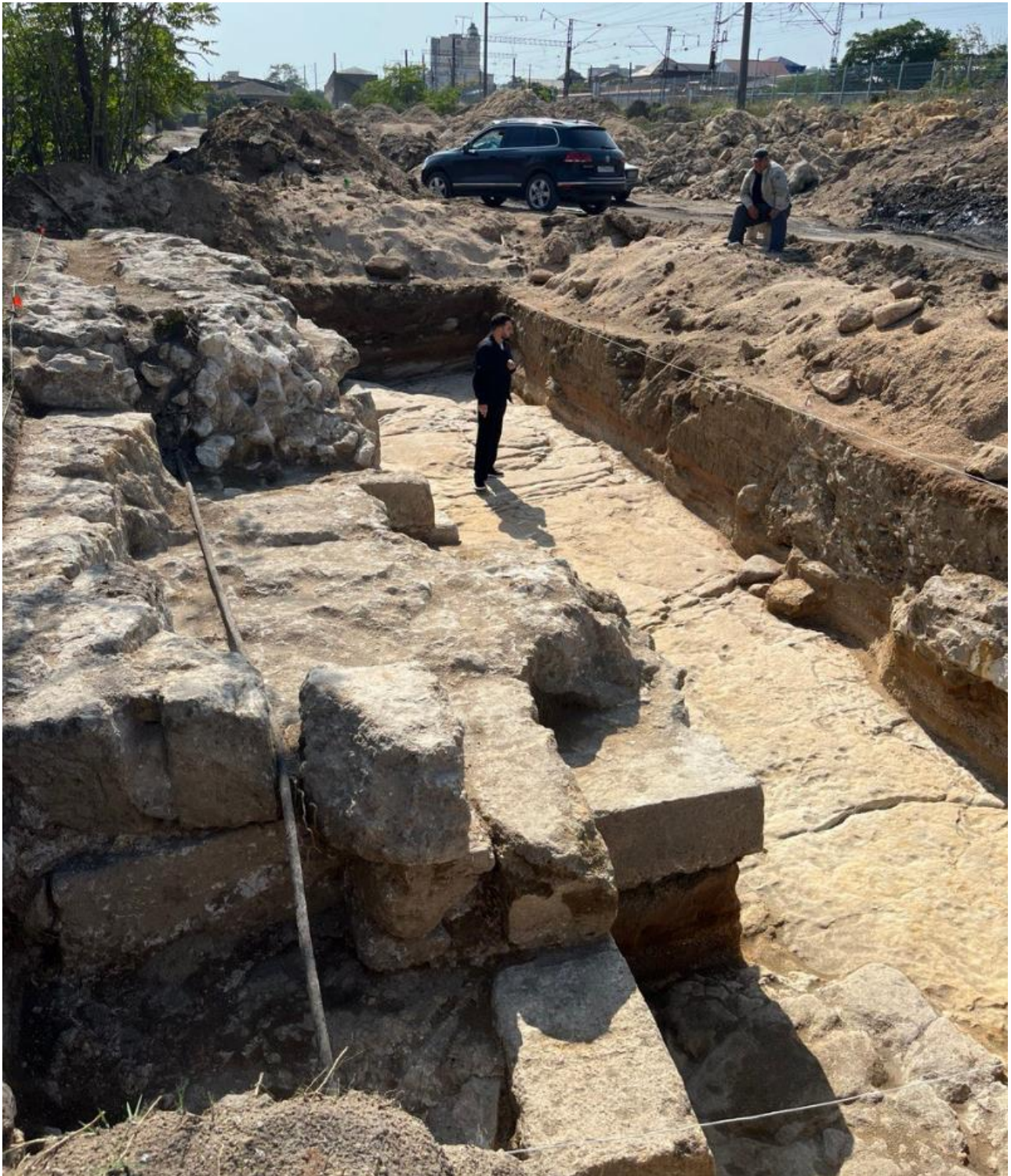
Фото 3. Общий вид археологического раскопа при проведении работ по реконструкции бытовой канализации и строительства инженерной коммуникации по ул. Строительная
