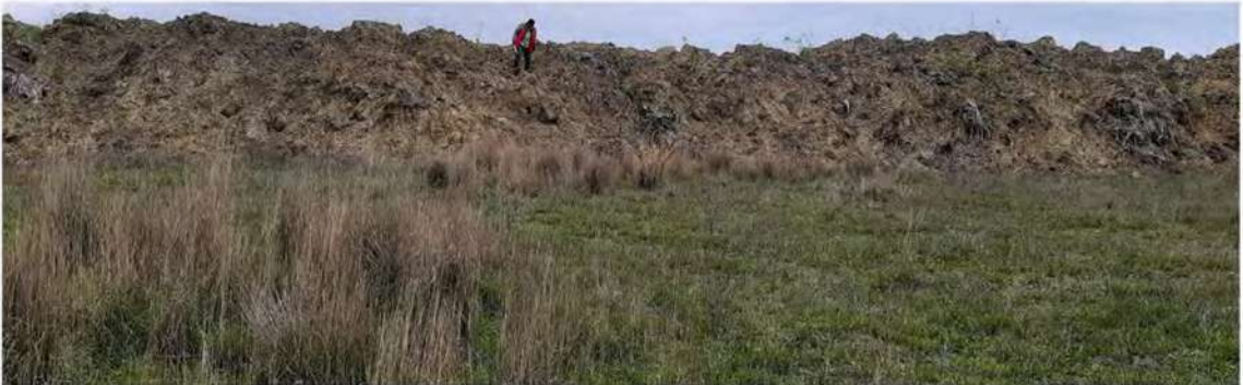
Рис. 31 . Обследование территории под проектируемый объект «Строительство автодороги Р-217 «Кавказ» автомобильная дорога М-4 «Дон» – Владикавказ – Грозный – Махачкала – граница с Азербайджанской Республикой на участке обхода города Дербент, Республика Дагестан». Точка фотофиксации 6. Вид на север.
