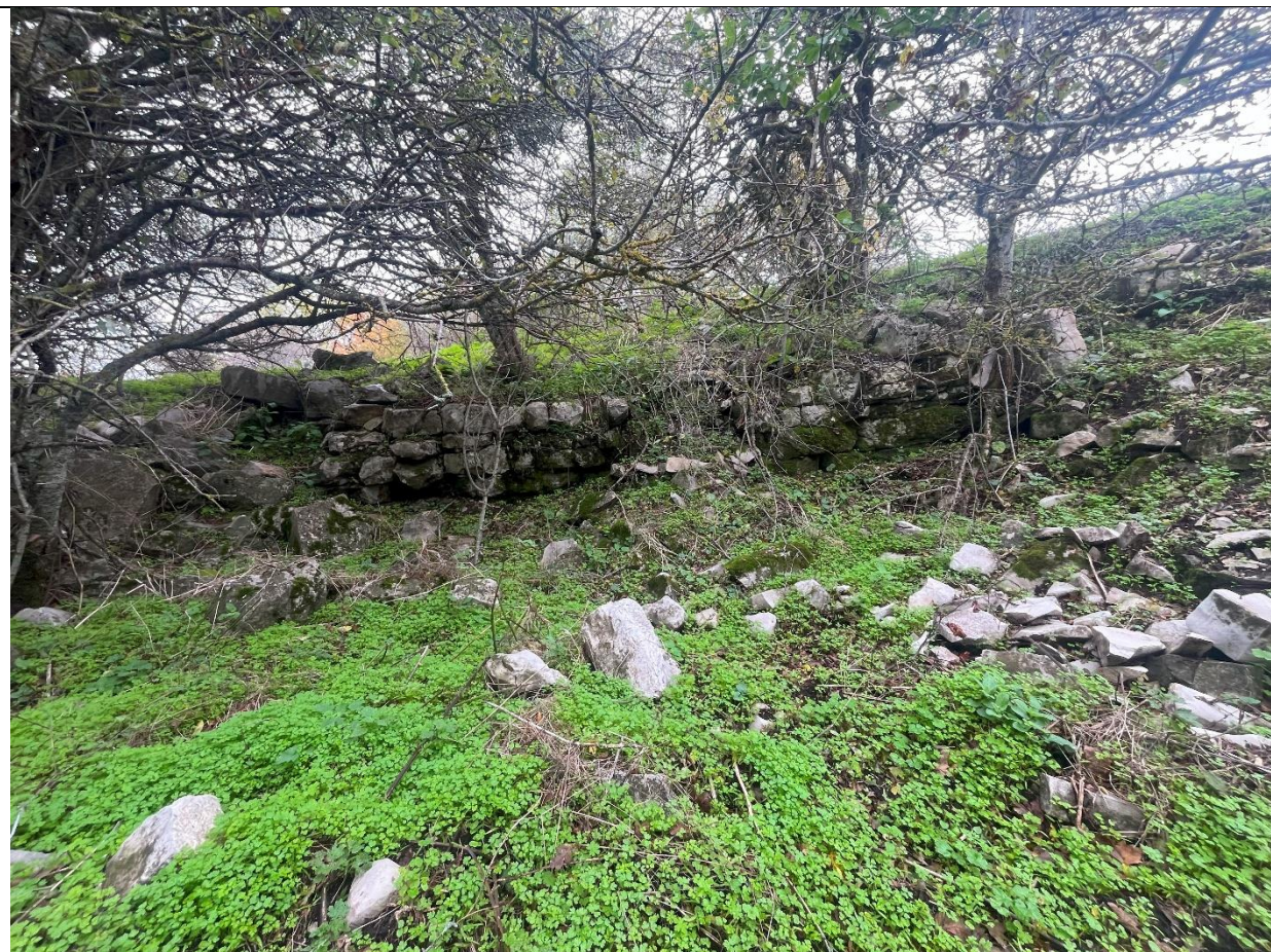
Фото 9. Кладка каменной постройки в северной части
