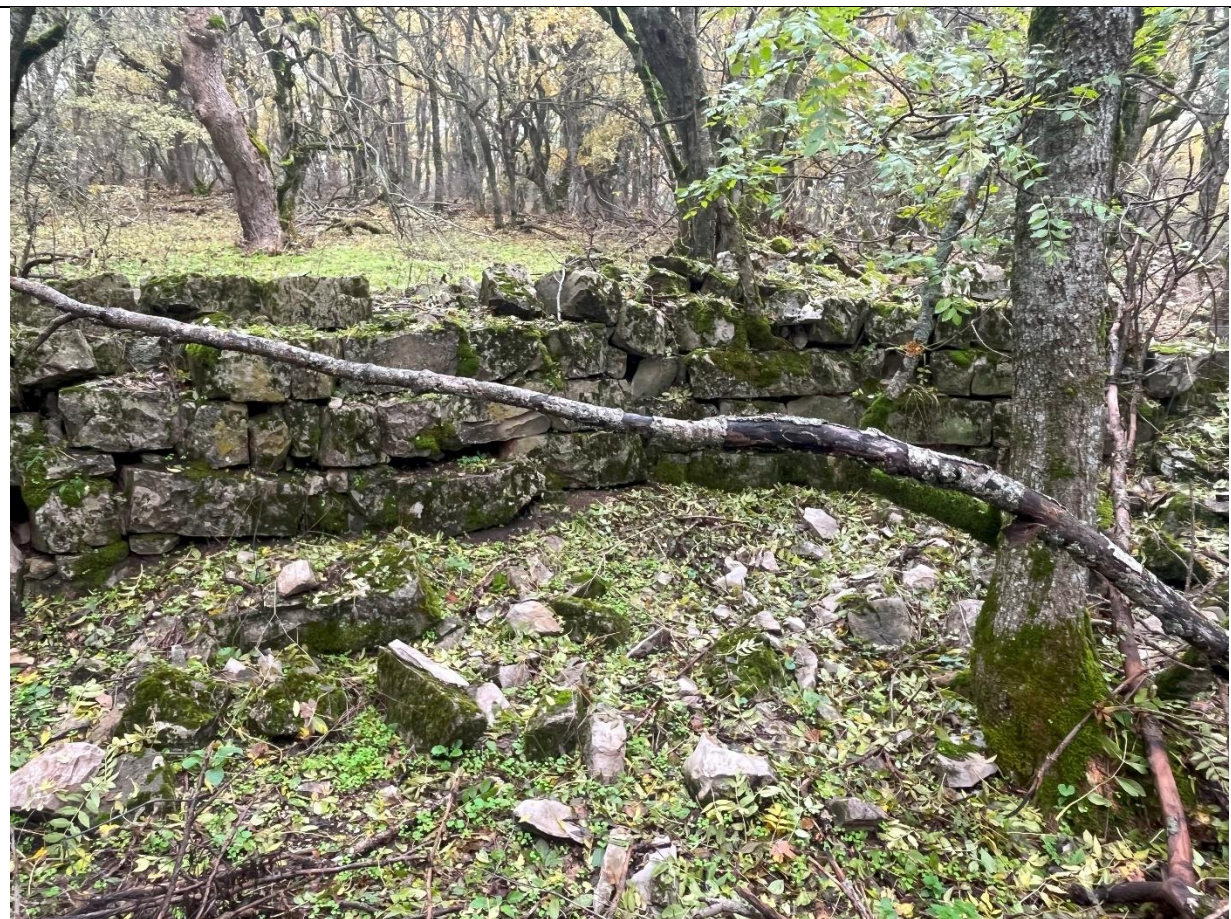
Фото 15. Кладка каменной постройки в восточной части местности
