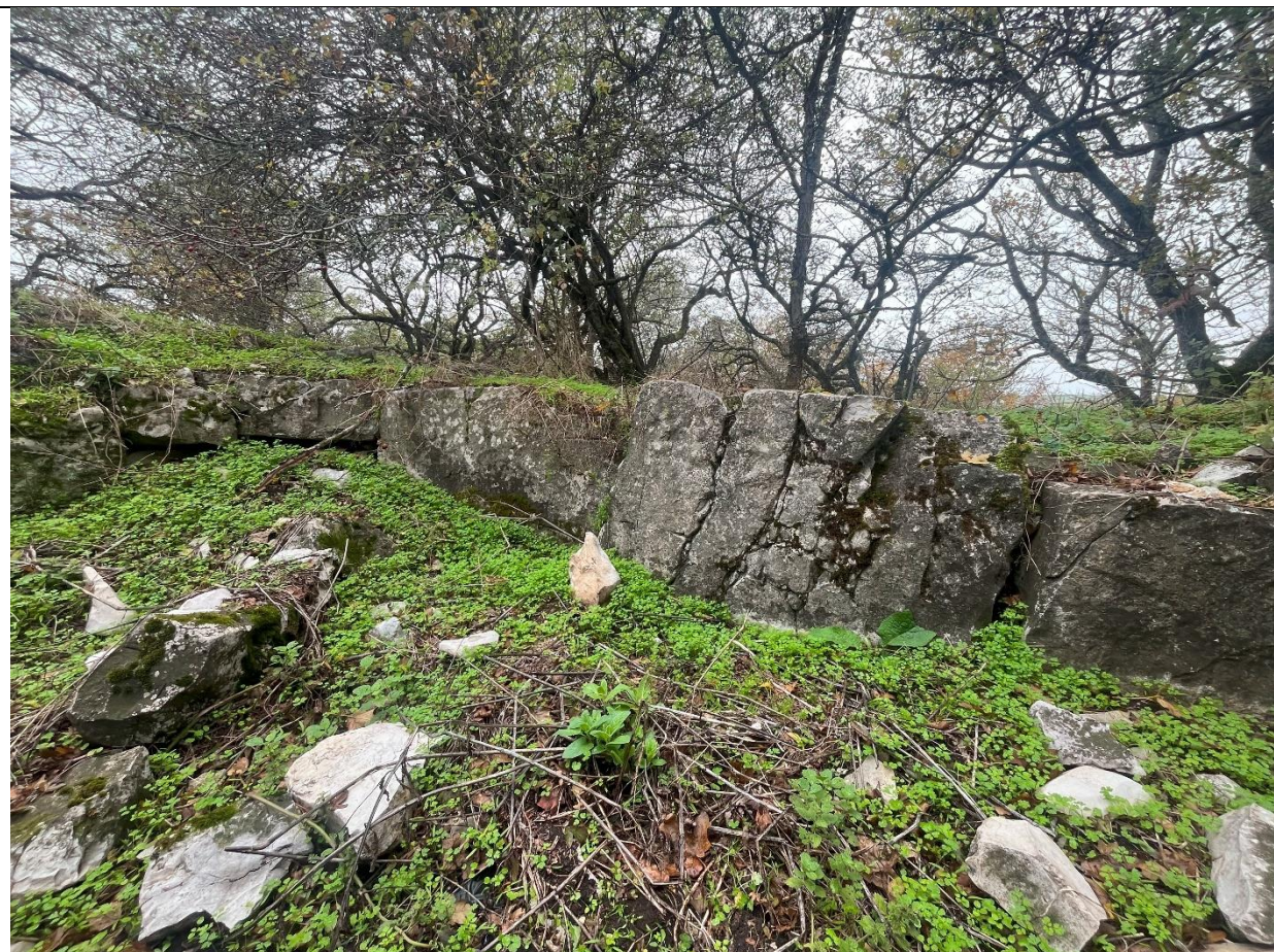
Фото 7. Кладка каменной постройки в северной части
