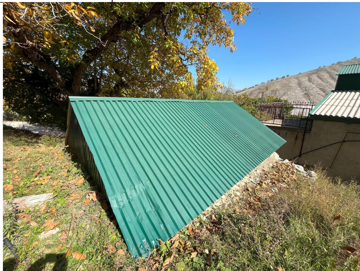
Фото 2. Северо-восточная сторона источника
