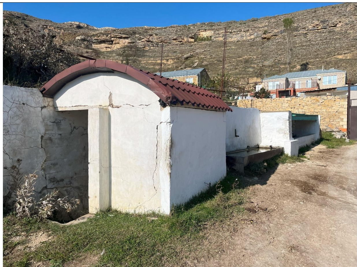
Фото 1. Южный угол сооружения источника
