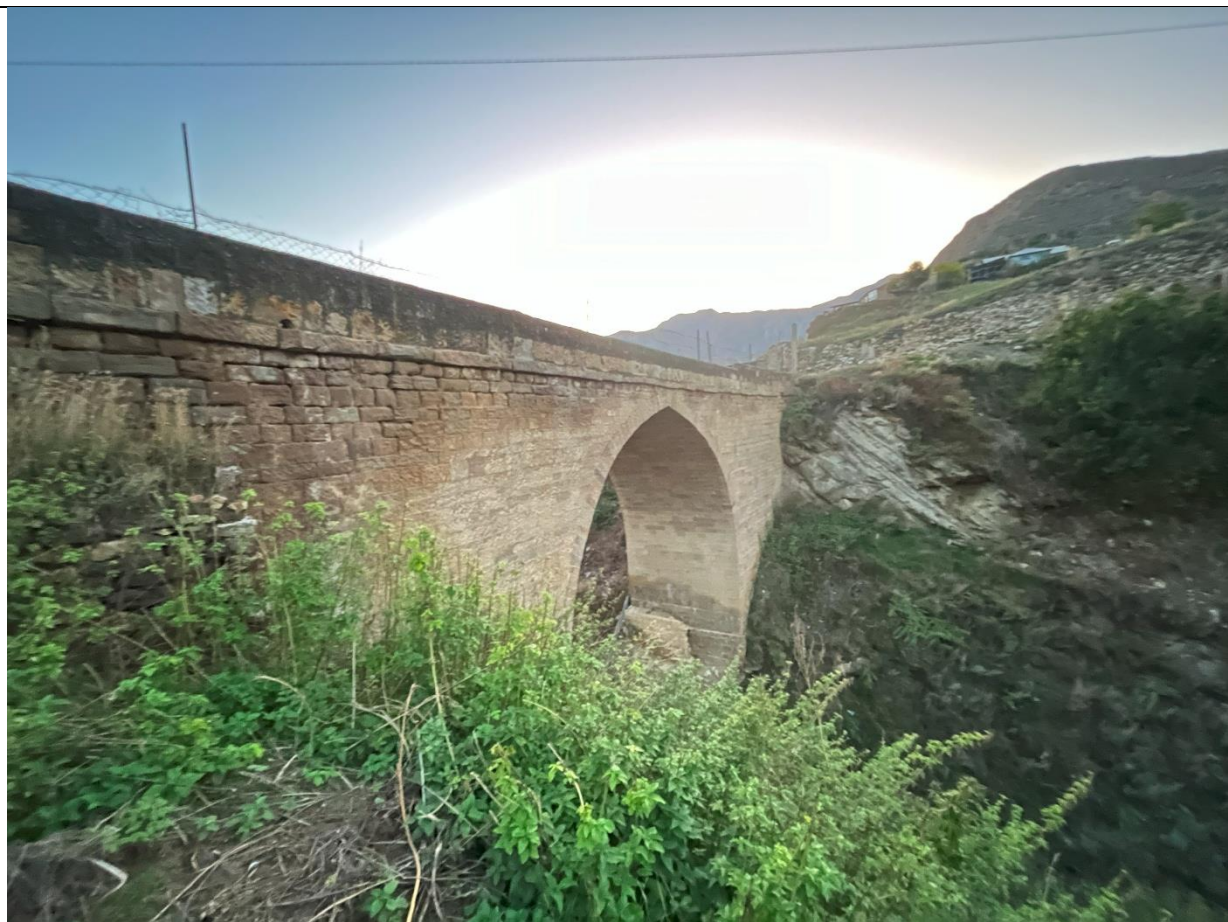
Фото 5. Юго-западная сторона каменного моста. Вид с СЗ
