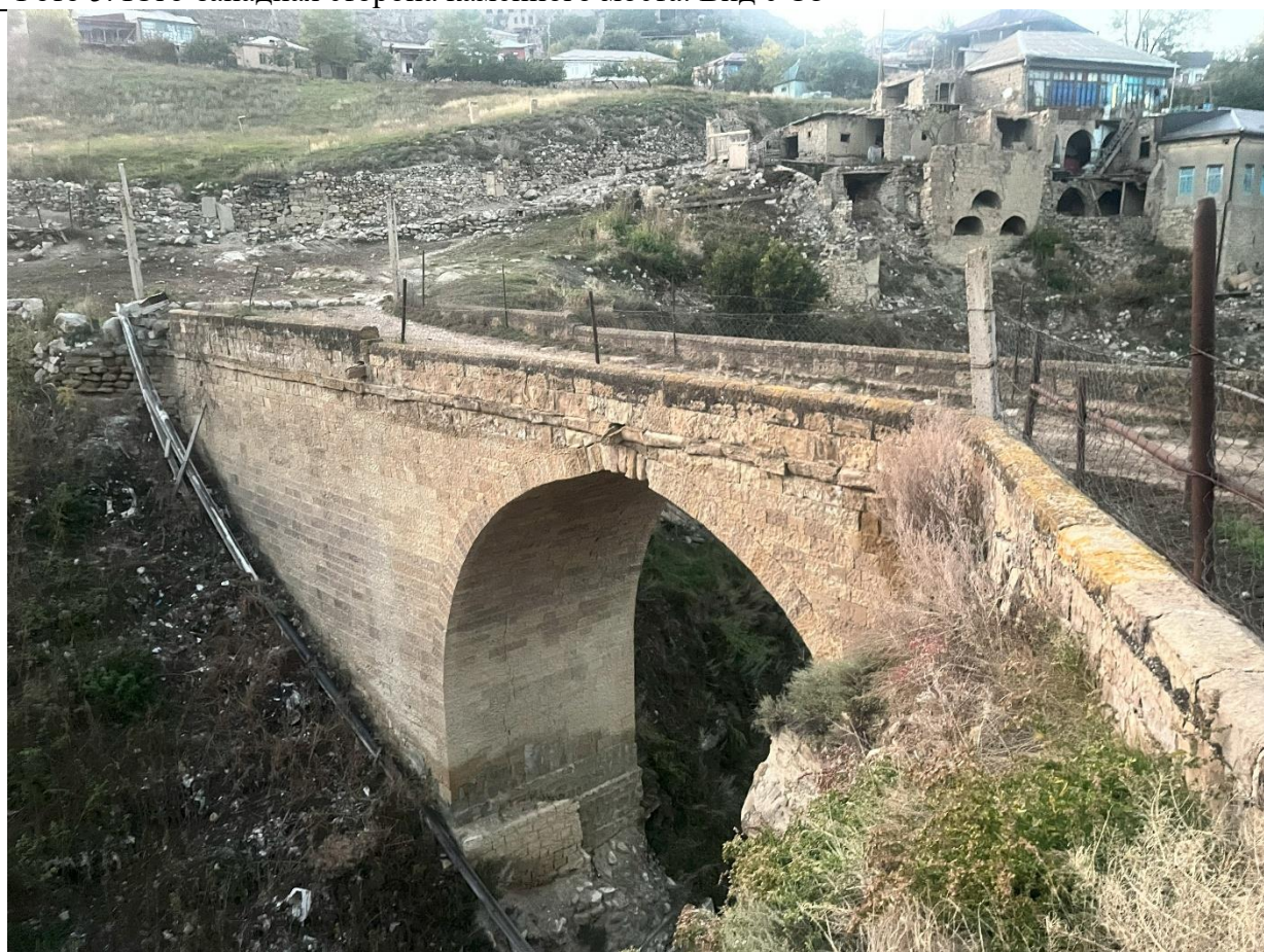
Фото 6. Северо-восточная сторона каменного моста. Вид с востока
