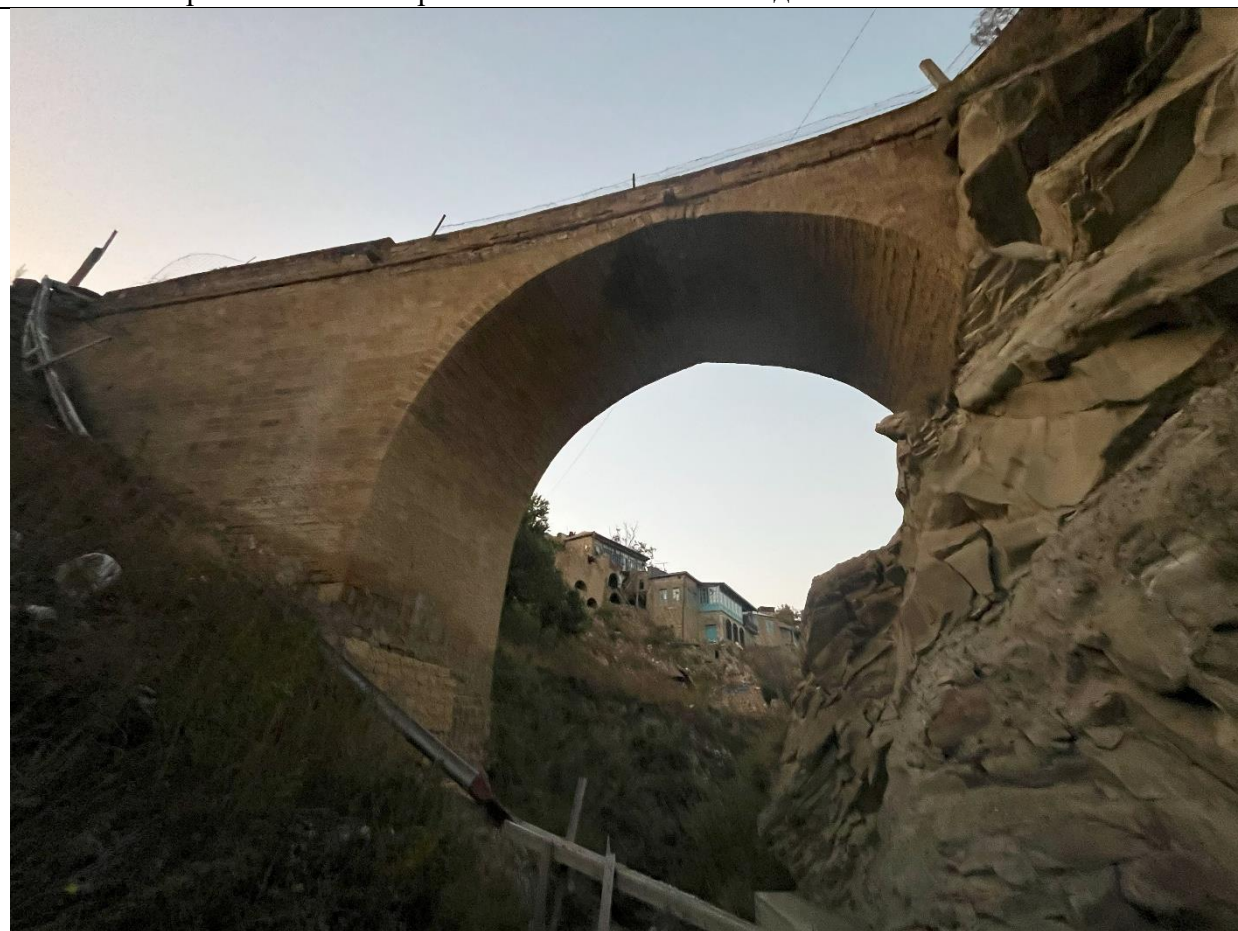
Фото 4. Северо-восточная сторона каменного моста. Вид с востока
