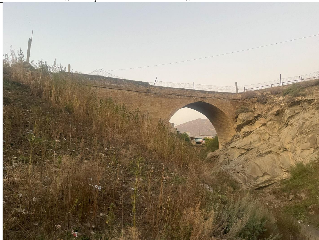
Фото 2. Северо-восточная сторона каменного моста. Вид с востока
