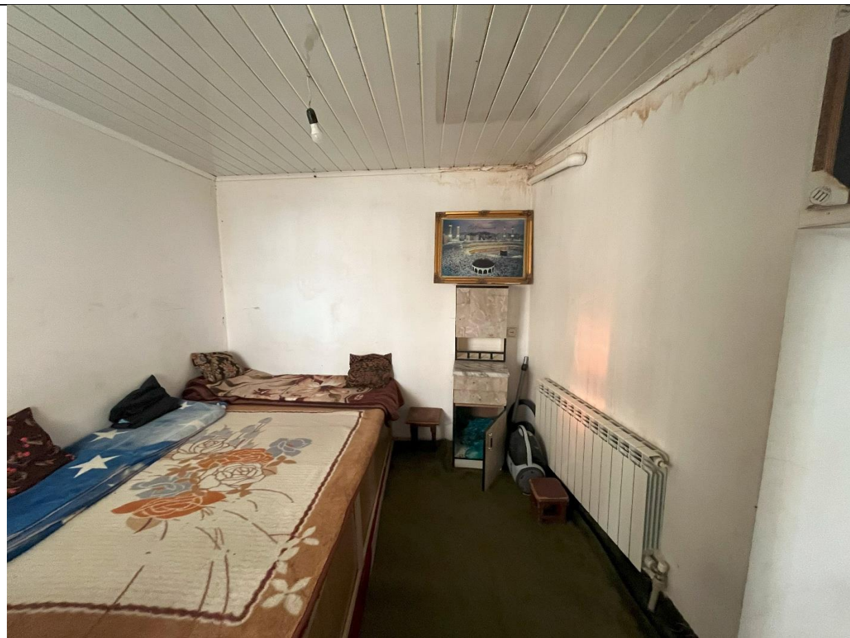
Фото 5. Помещение в северо-западной части мечети
