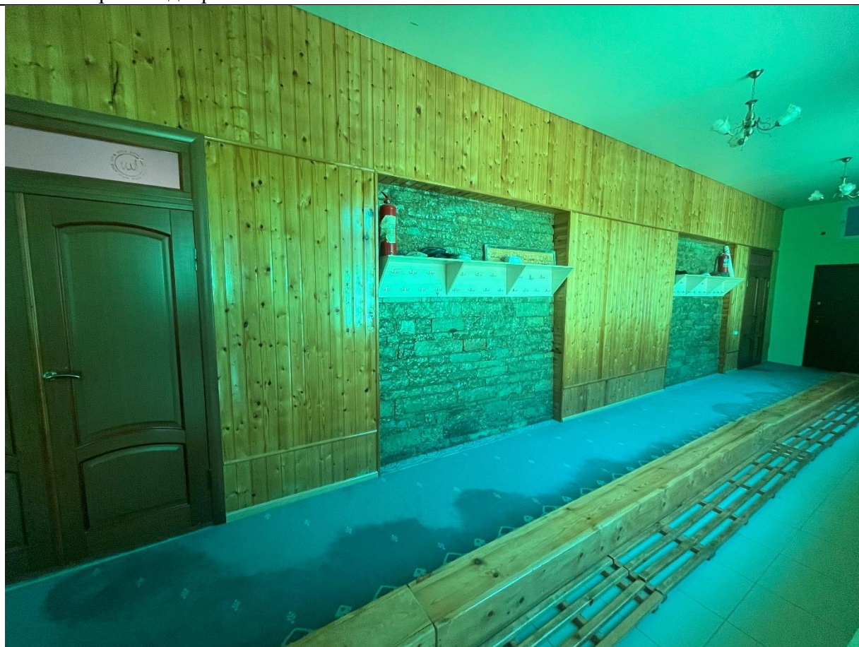
Фото 7. Помещение пристройки к мечети с севера. Вид на западную часть северной стены мечети
