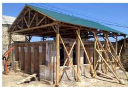
Рис. 27. Колонный павильон над землянкой Петра I в процессе реставрационных работ и подготовки к раскопкам. Установлена временная кровля. Июль 2014 г.
