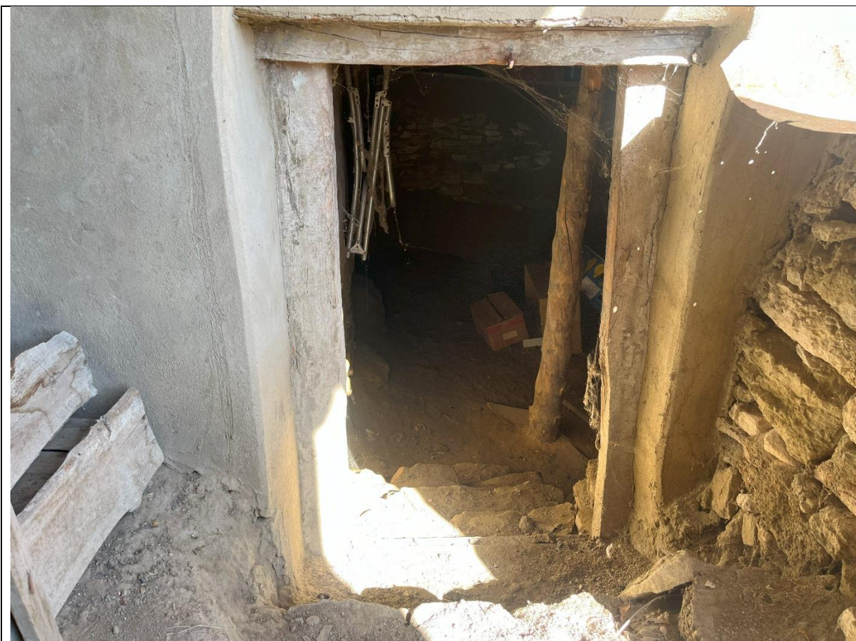
Фото 9. Вход в подвальное помещение дома
