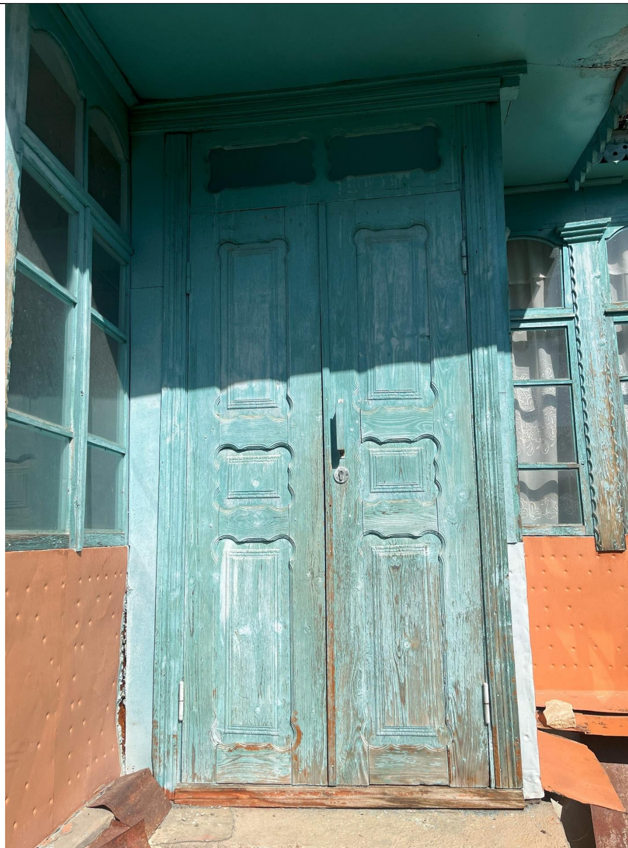
Фото 4. Вход в юго-западной стене дома
