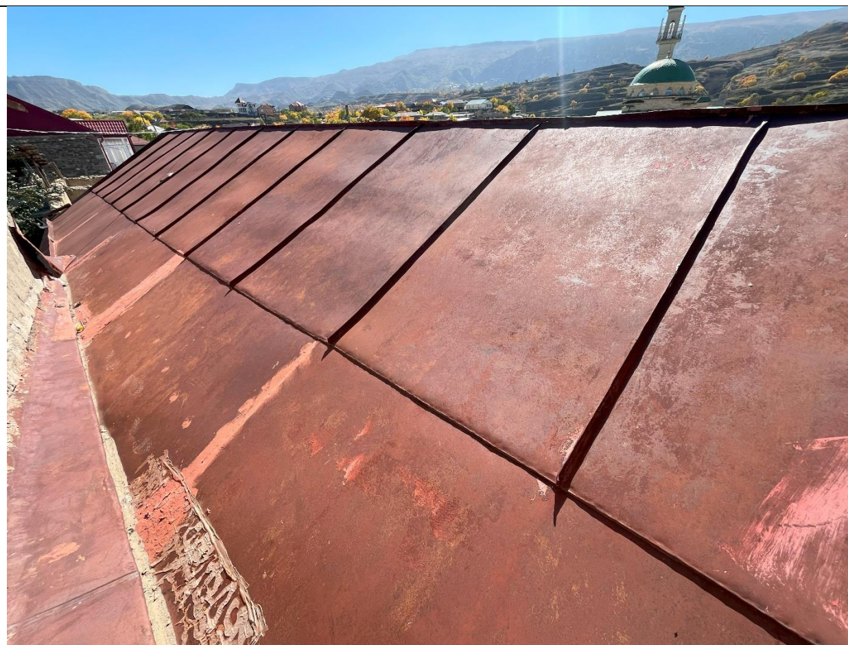
Фото 11. Вид на северо-восточную часть крыши дома
