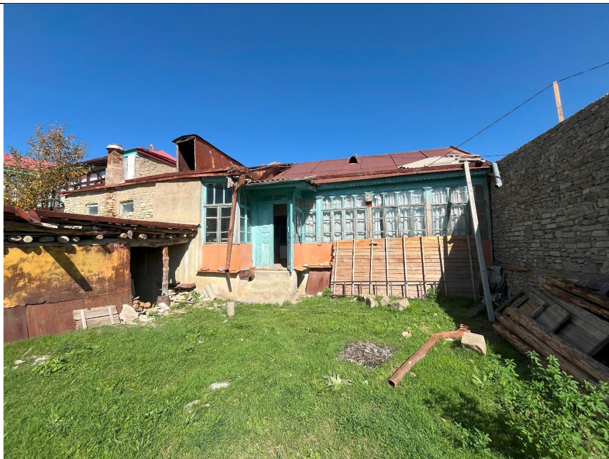
Фото 2. Вид на юго-западную стену дома
