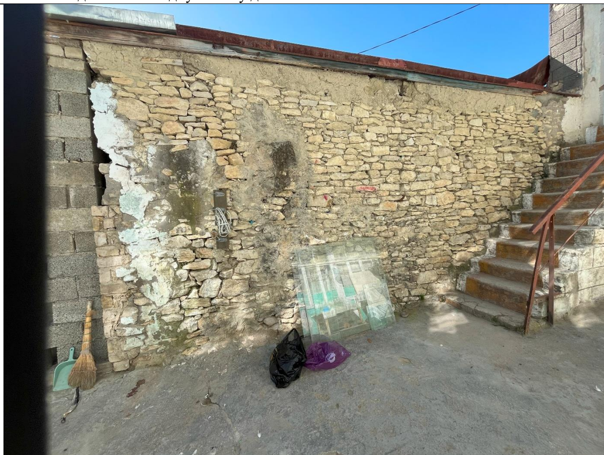
Фото 3. Вид на северо-восточную стену дома
