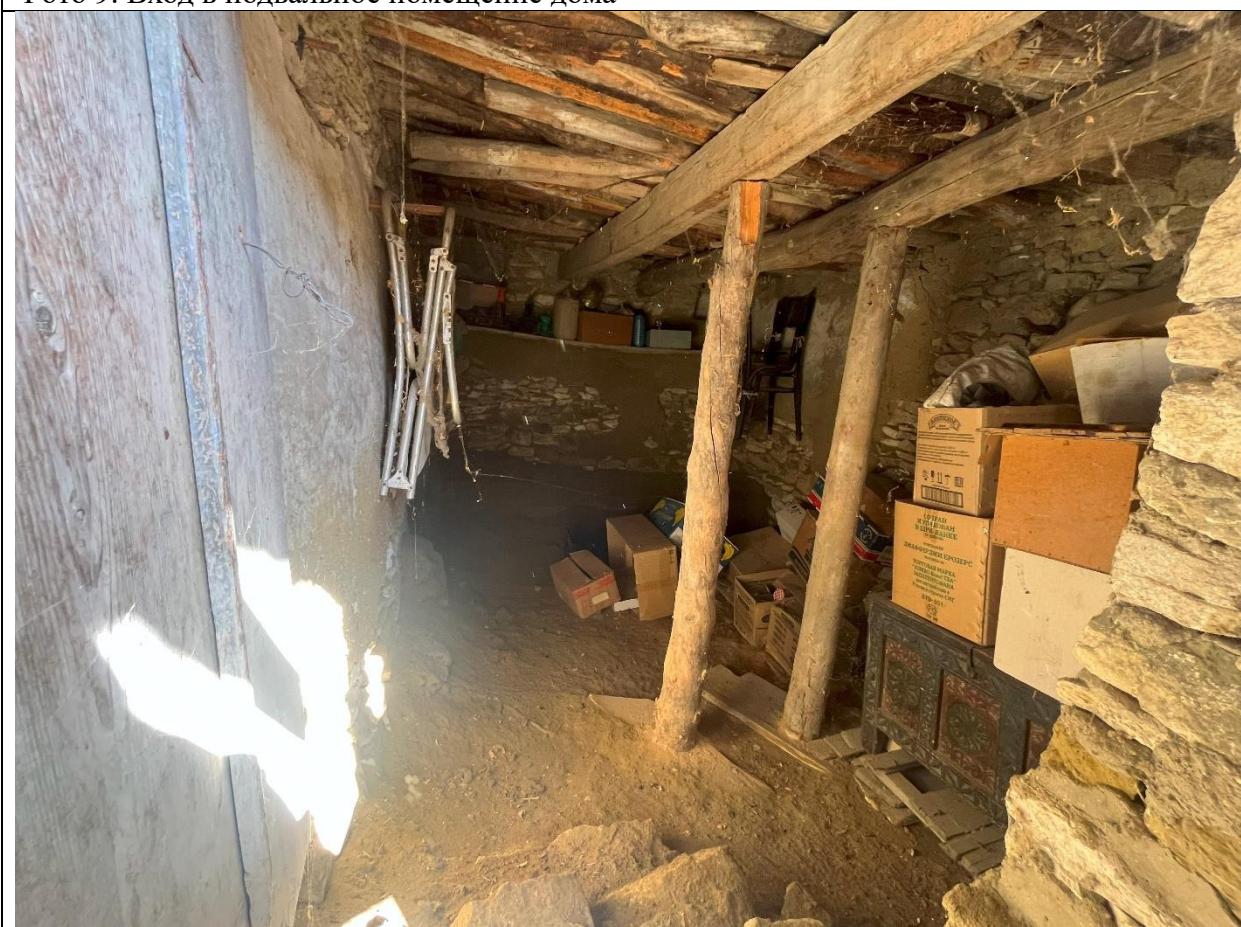
Фото 10. Помещение подвальное дома
