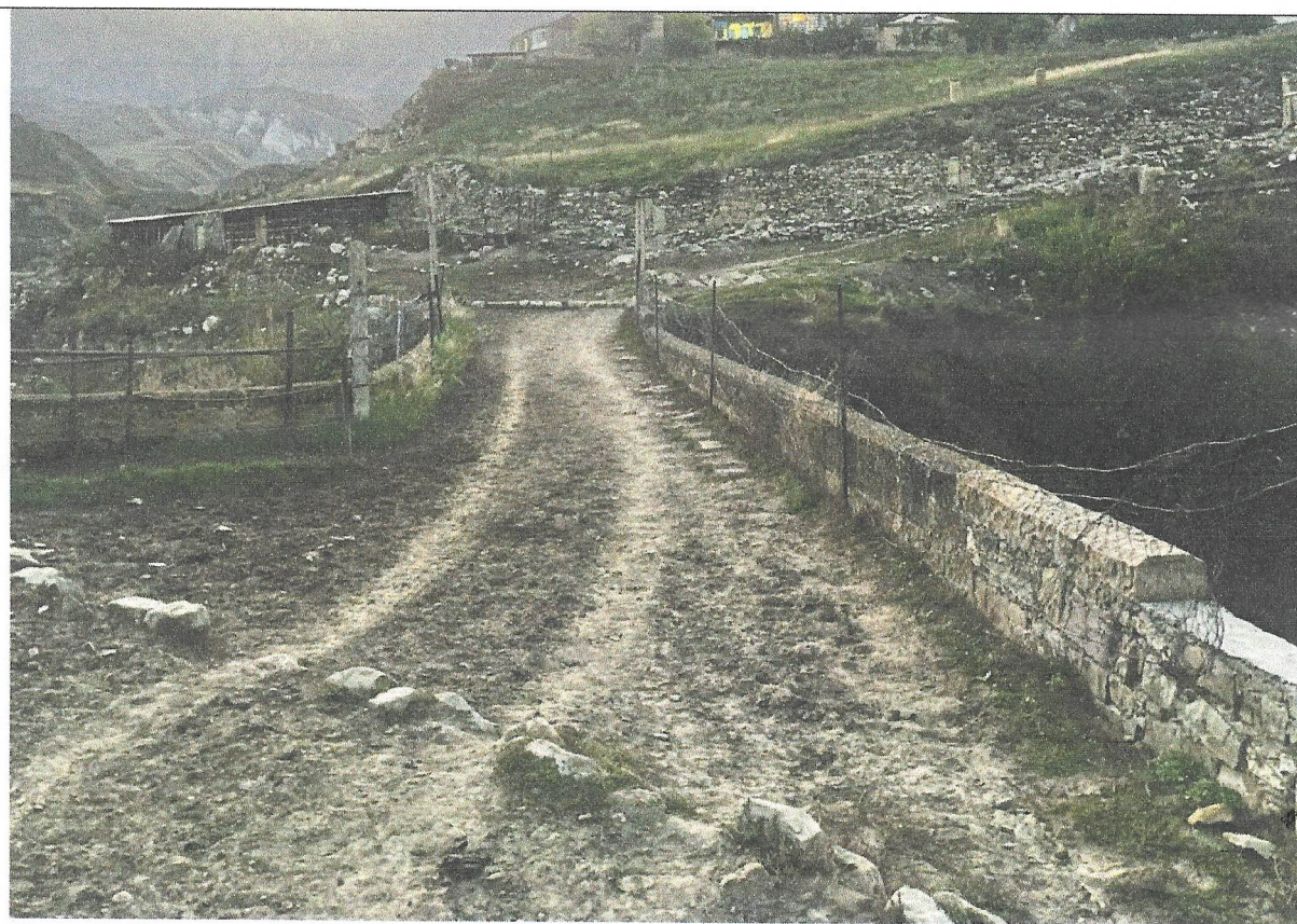
Фото 7. Проход через каменный мост. Вид с ЮВ
