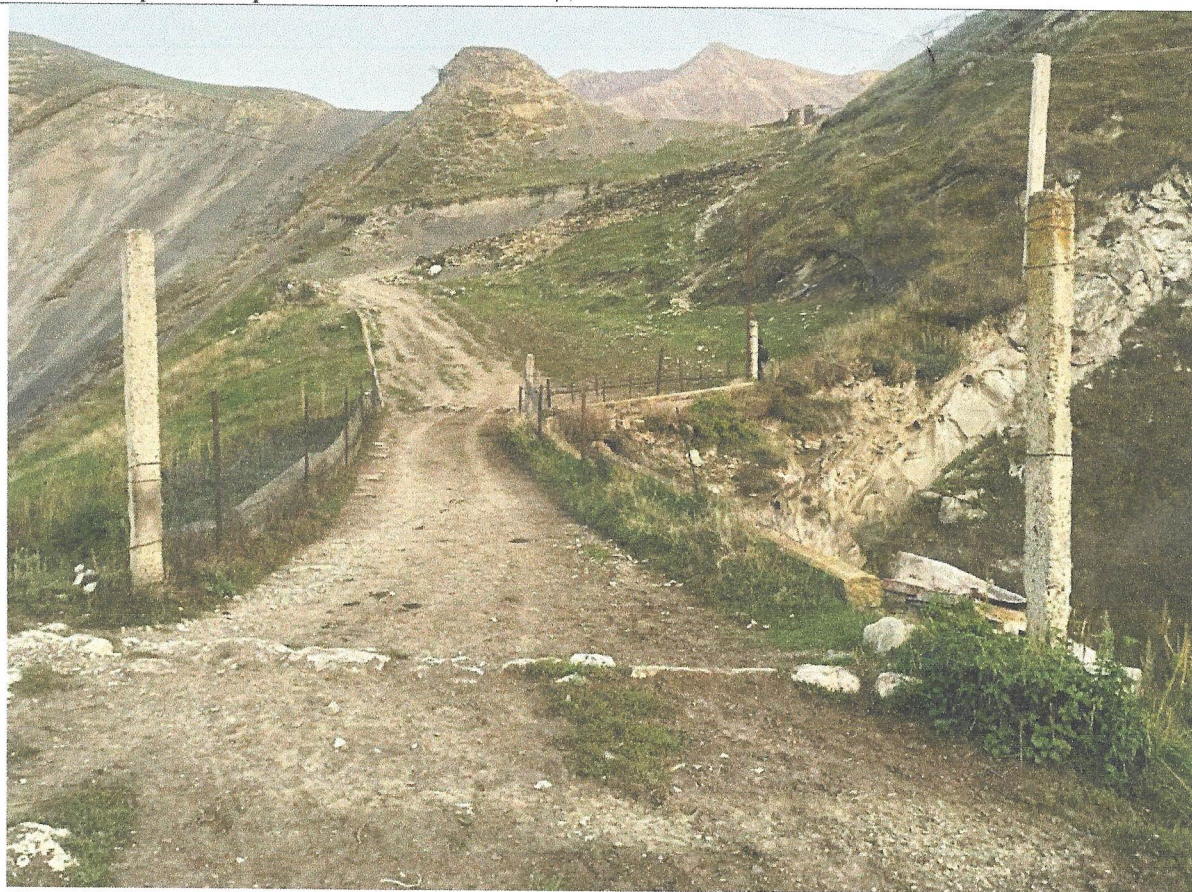
Фото 7. Проход через каменный мост. Вид с СЗ
