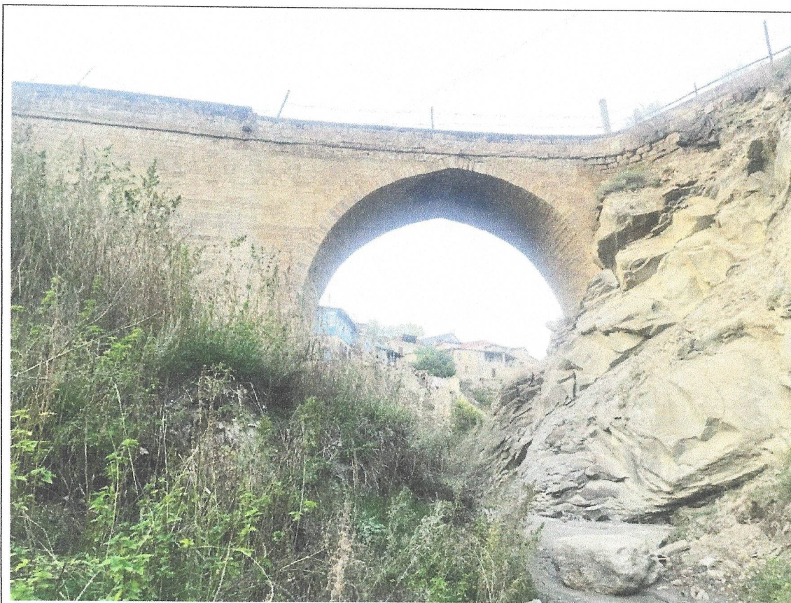
Фото 3. Северо-восточная сторона каменного моста. Вид с СВ
