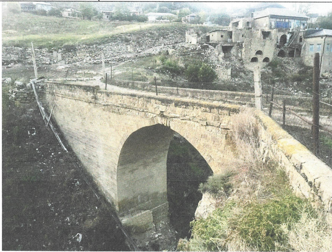
Фото 6. Северо-восточная сторона каменного моста. Вид с востока
