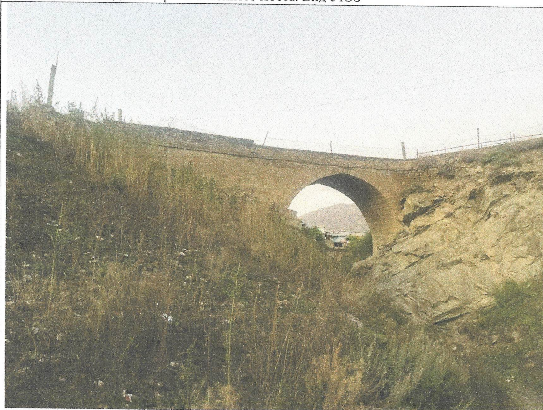
Фото 2. Северо-восточная сторона каменного моста. Вид с востока
