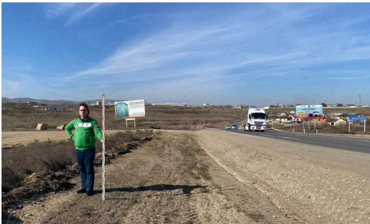
Рис.7. «Капитальный ремонт мостов через р Манас Озень на км 842+322 (правый, левый) автомобильной дороги Р-217 «Кавказ» автомобильная дорога М-4 «Дон» - Владикавказ - Грозный - Махачкала - граница с Азербайджанской Республикой, Республика Дагестан» в Карабудахкентском районе Республики Дагестан. Рельеф местности и характер растительности участка обследования. Точка фотофиксации 1, вид с Ю.
