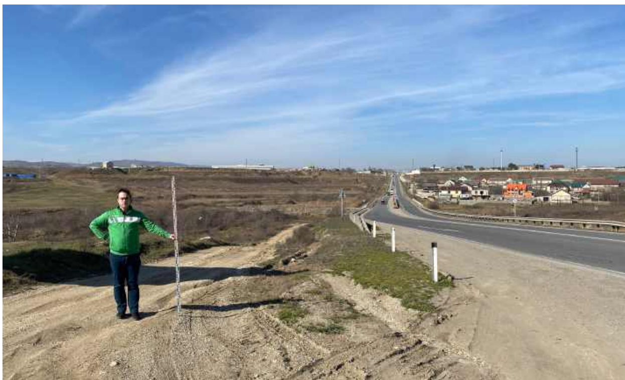
Рис.8. «Капитальный ремонт мостов через р Манас Озень на км 842+322 (правый, левый) автомобильной дороги Р-217 «Кавказ» автомобильная дорога М-4 «Дон» - Владикавказ - Грозный - Махачкала - граница с Азербайджанской Республикой, Республика Дагестан» в Карабудахкентском районе Республики Дагестан. Рельеф местности и характер растительности участка обследования. Точка фотофиксации 2, вид с Ю.
