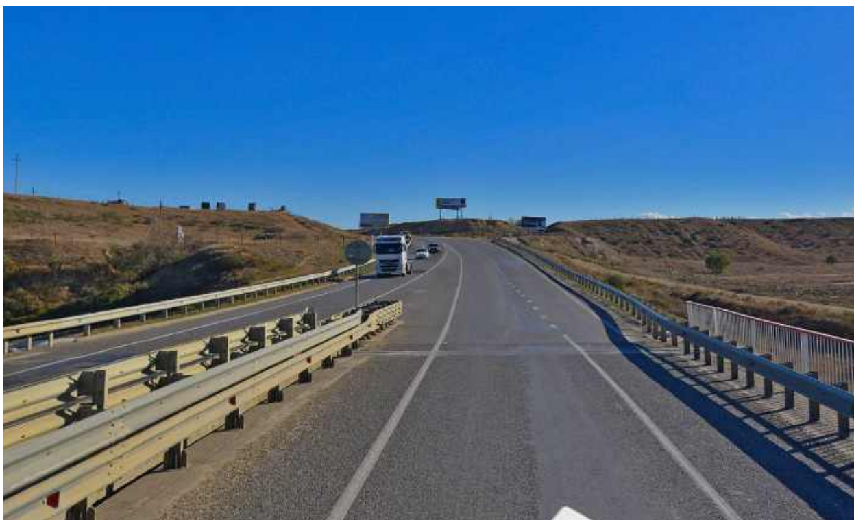
Рис.10. «Капитальный ремонт мостов через р Манас Озень на км 842+322 (правый, левый) автомобильной дороги Р-217 «Кавказ» автомобильная дорога М-4 «Дон» - Владикавказ - Грозный - Махачкала - граница с Азербайджанской Республикой, Республика Дагестан» в Карабудахкентском районе Республики Дагестан. Рельеф местности и характер растительности участка обследования. Точка фотофиксации 4, вид с С.
