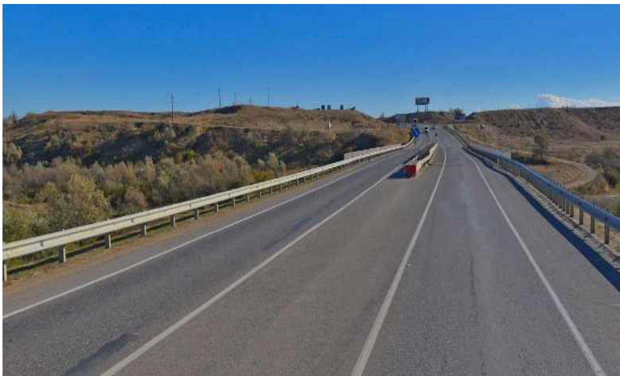
Рис.9. «Капитальный ремонт мостов через р Манас Озень на км 842+322 (правый, левый) автомобильной дороги Р-217 «Кавказ» автомобильная дорога М-4 «Дон» - Владикавказ - Грозный - Махачкала - граница с Азербайджанской Республикой, Республика Дагестан» в Карабудахкентском районе Республики Дагестан. Рельеф местности и характер растительности участка обследования. Точка фотофиксации 3, вид с С.
